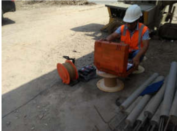
Foto N° 07: Equipo utilizado en el Sondeo eléctrico Vertical para nuevo pozo proyectado
