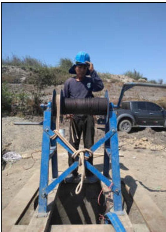
Figura 13. Perforación de antepozo Elaboración: Los autores
