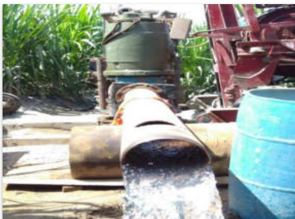
Foto N° 06: Prueba de bombeo del pozo SEV-22
