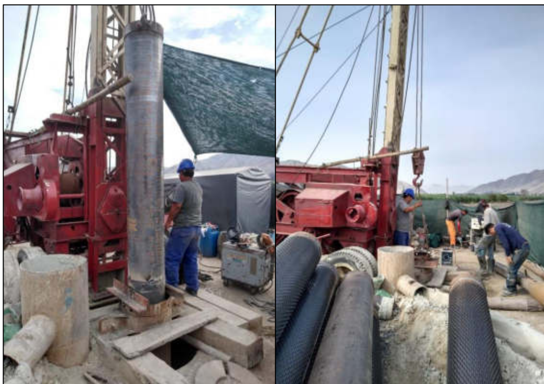
Figura 17. Realización del entubado del pozo
