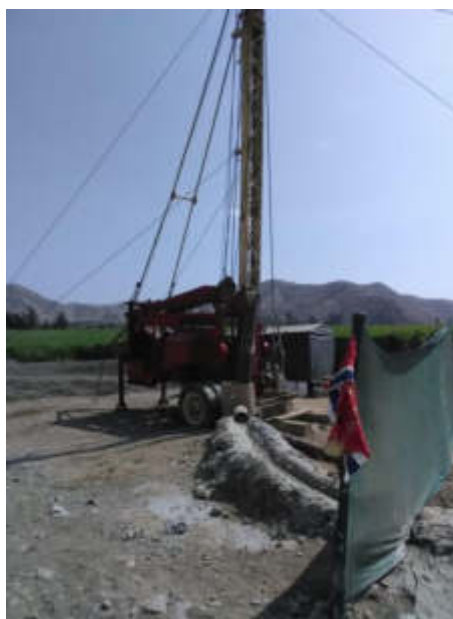
Figura 14. Perforación de pozo SEV - 22 Elaboración: Los autores
