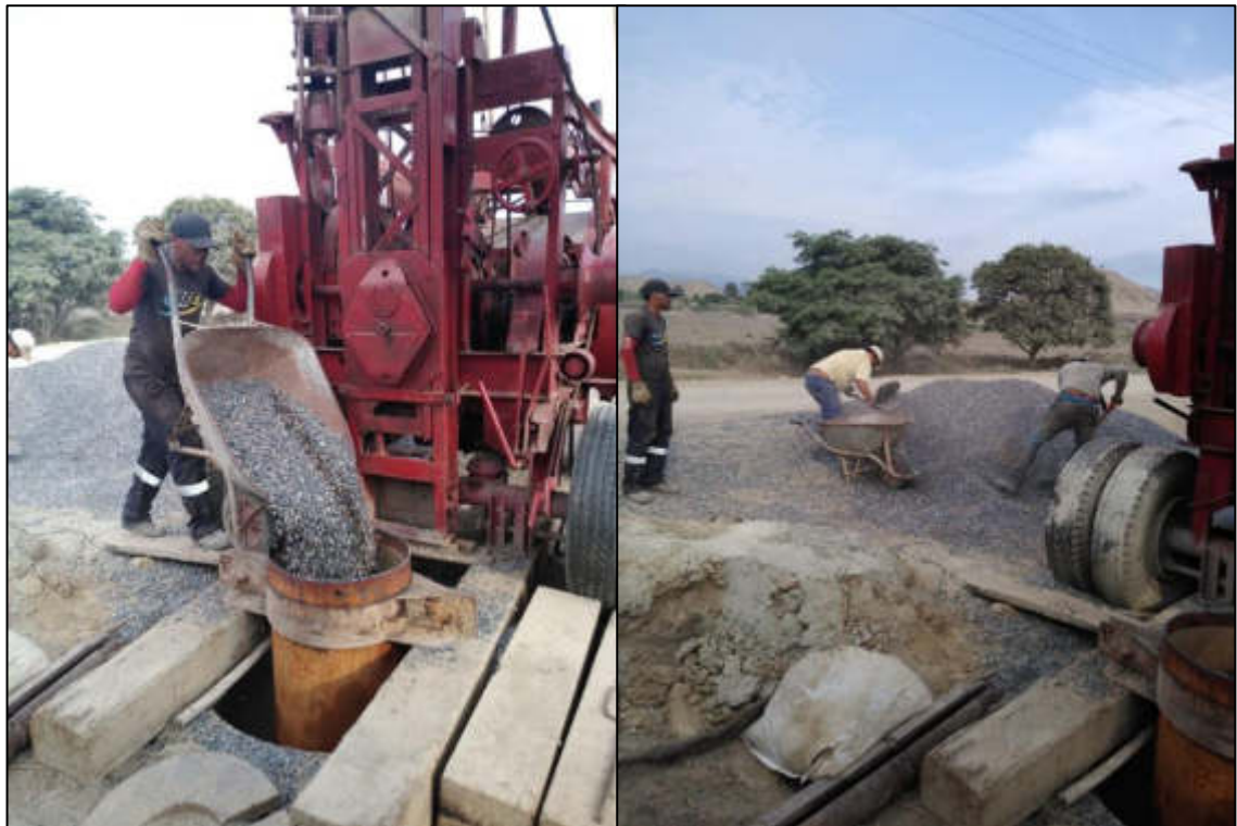
Figura 18. Colocación de pre filtro Elaboración: Los autores
