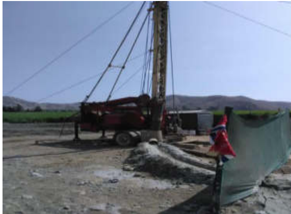
Foto N° 09: Maquina de perforación del pozo SEV-22
