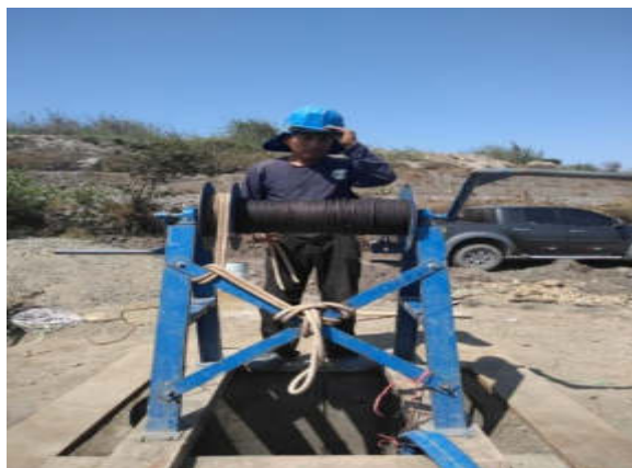
Foto N° 08: Perforación del pozo SEV-22
