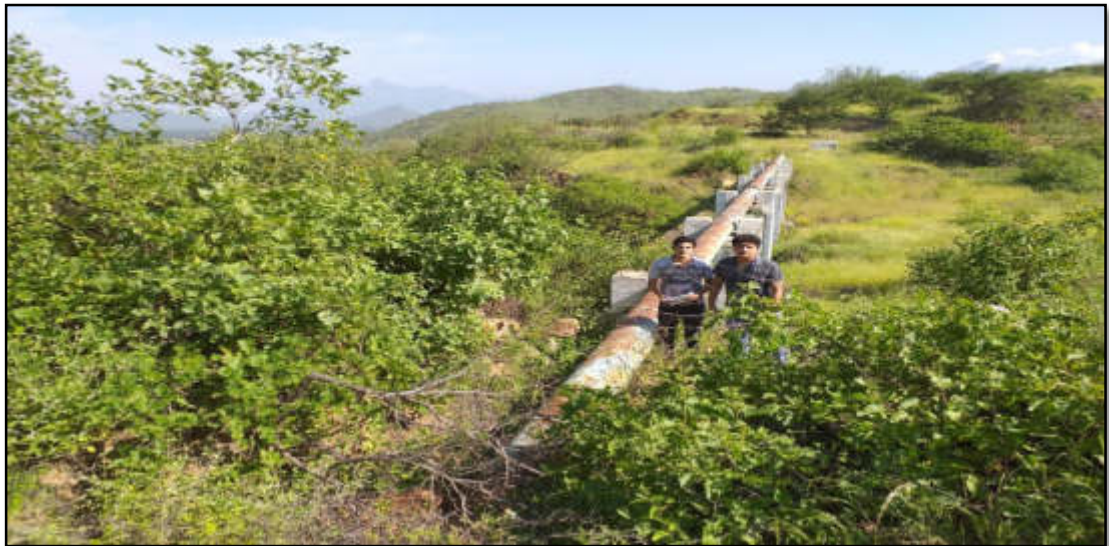
FOTOGRAFÍA N° 08: Identificación del pase aéreo y su estado de conservación para evaluación con respecto a la línea de conducción.
