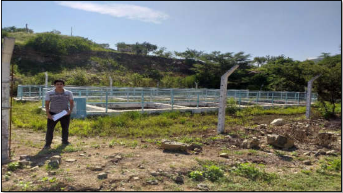
FOTOGRAFÍA N° 09: Se visitó el desarenador ubicado después de la captación de agua del sistema.
