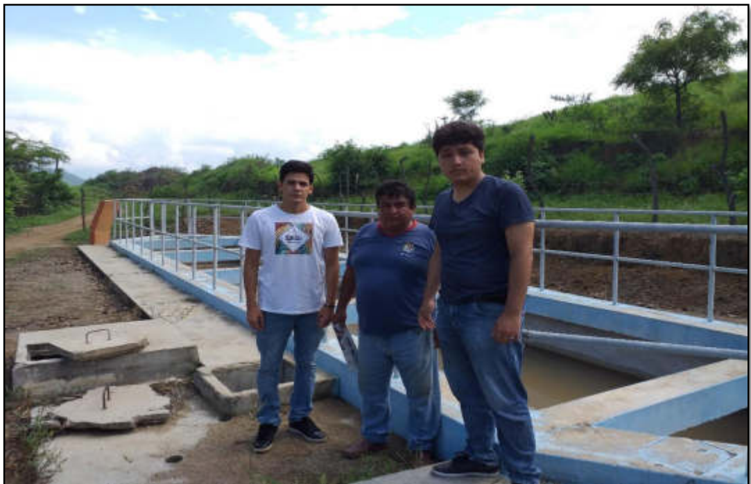
FOTOGRAFÍA N° 06: Visita del componente estructural desarenador correspondiente a la Planta de Tratamiento de Agua Potable, con el jefe responsable de la operación y mantenimiento, señor Miguel Montaña Montalvo.
