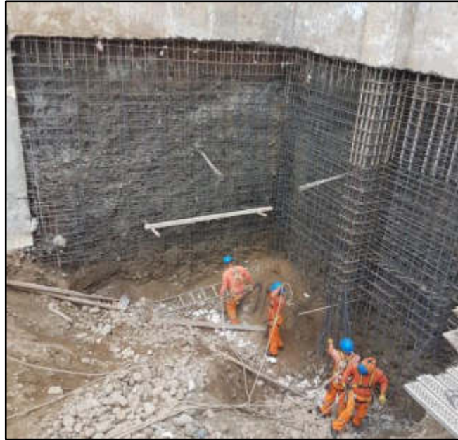
Figura 6. Armado de muro Fuente: Elaborado por los autores
