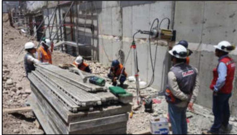
Figura 9. Tensado de cables Fuente: Elaborado por los autores
