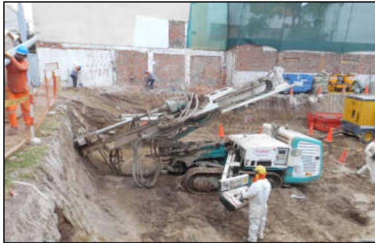
Figura 5. Perforación de anclajes Fuente: Elaborado por los autores
