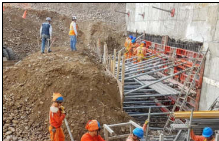
Figura 7. Encofrado de Muro Fuente: Elaborado por los autores
