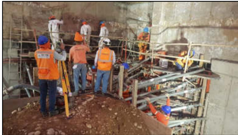
Figura 8. Vaciado de muro anclado Fuente: Elaborado por los autores
