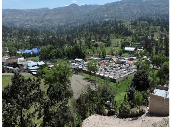
Foto n° 60: Vista de la ciudad de Ninabamba. Santa Cruz.
