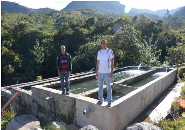
Foto n° 133: Instalaciones del Criadero de truchas. Querocoto. Chota.
