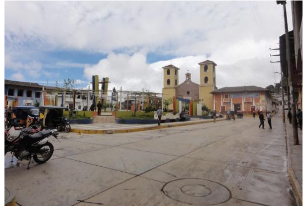
Foto n° 04: Plaza de Armas de Huambos.
