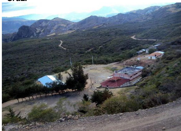
Foto n° 52: Complejo Turístico Chancaybaños en construcción. Santa Cruz.
