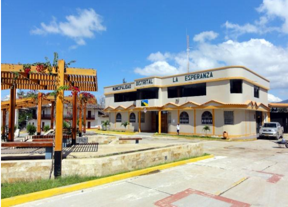
Foto n° 57: Edificio Sede de la Municipalidad Distrital de La Esperanza. Santa Cruz.
