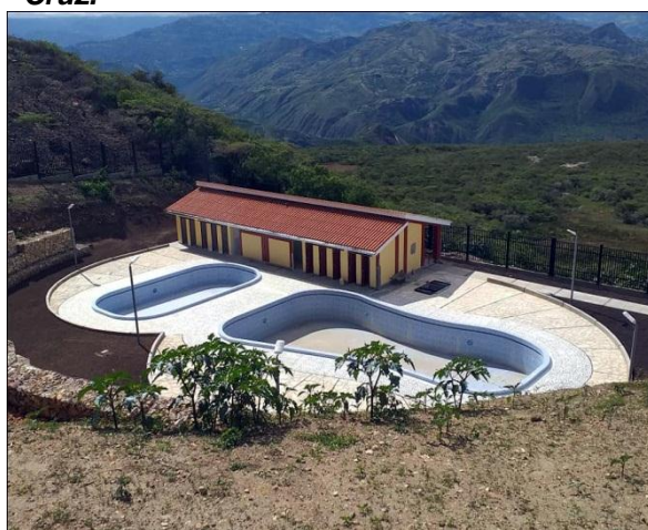
Foto n° 54: Complejo Turístico Chancaybaños en construcción. Santa Cruz.
