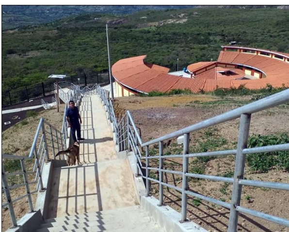
Foto n° 53: Complejo Turístico Chancaybaños en construcción. Santa Cruz.
