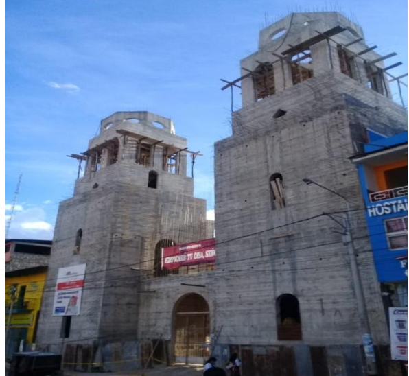
Foto n° 04: Catedral de Chota en construcción.
