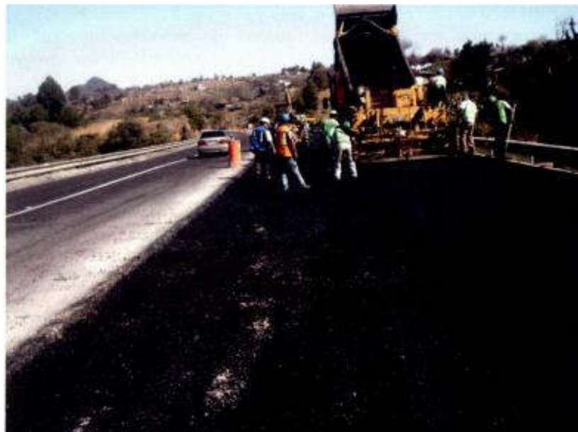
Figura 5. Fresado de carpeta asfáltica.
