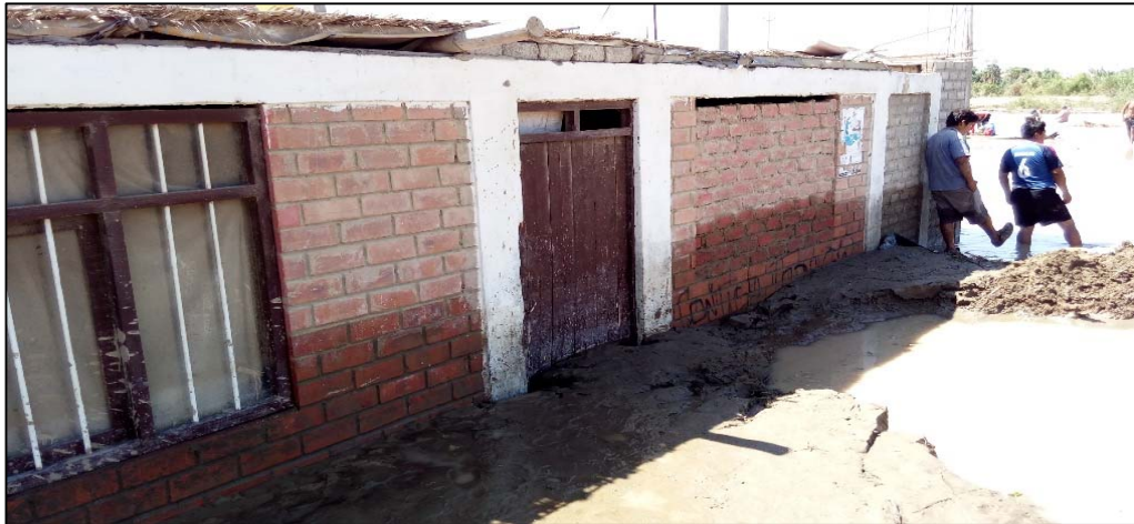
Figura 4. Viviendas afectadas por inundaciones.
