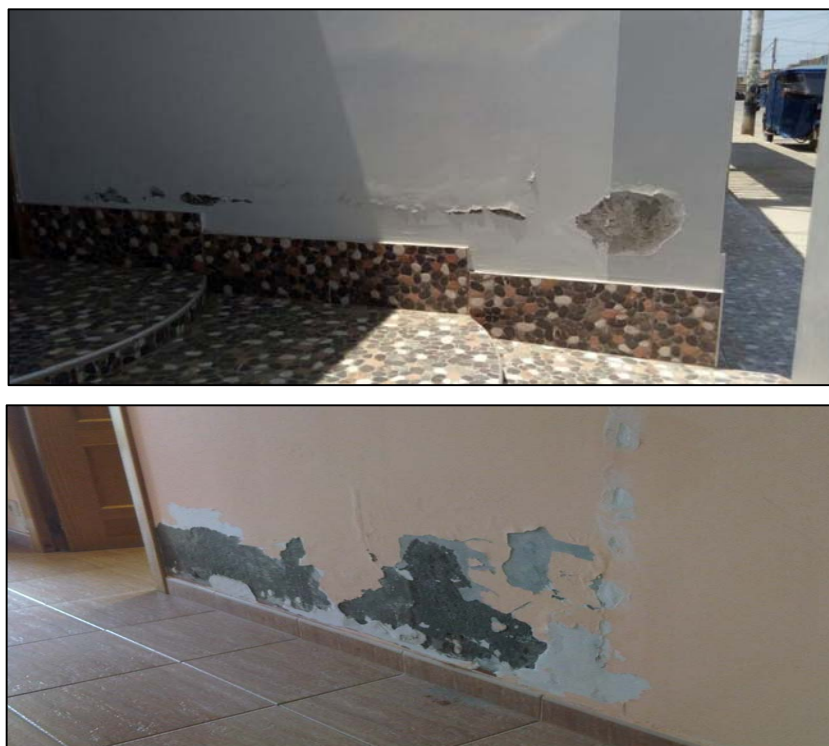
Figura 9. Efectos después de la reparación
