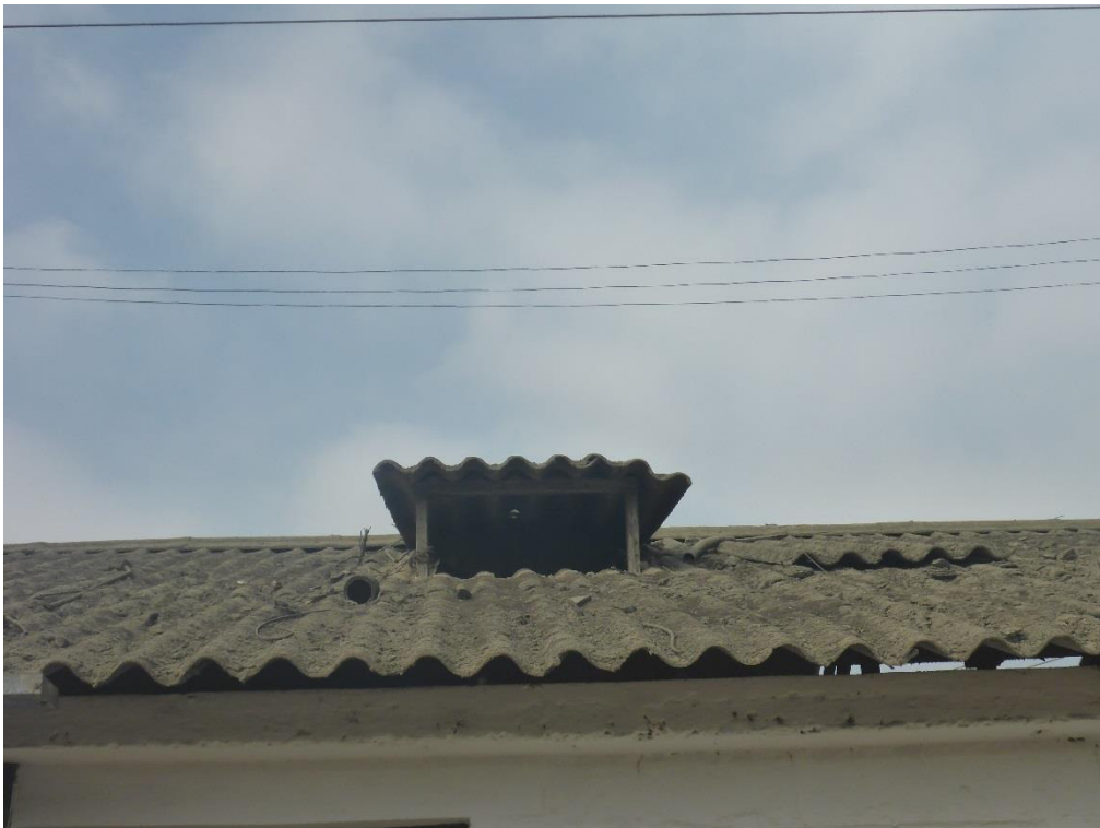
Foto N.º 8 Aberturas en el techo para tener ventilación
