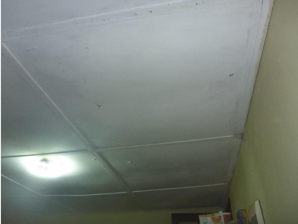
Foto N°21 Las habitaciones cuentan con baldosas para ser protegido del techo asbesto.
