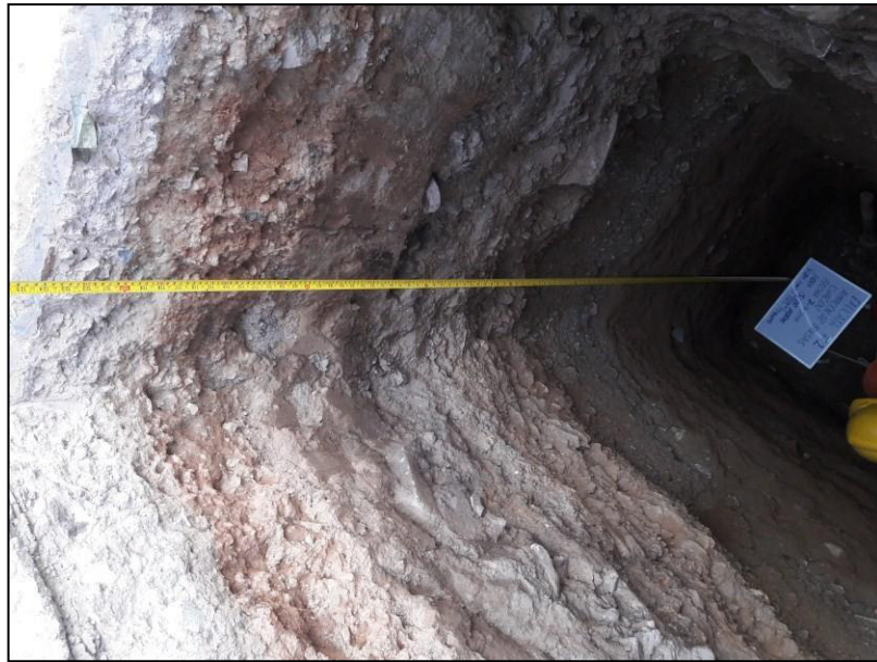
EXCAVACION DE CALICATA C-2, DESCRIPCION VISUAL Y MANUAL ASTM D 2487
