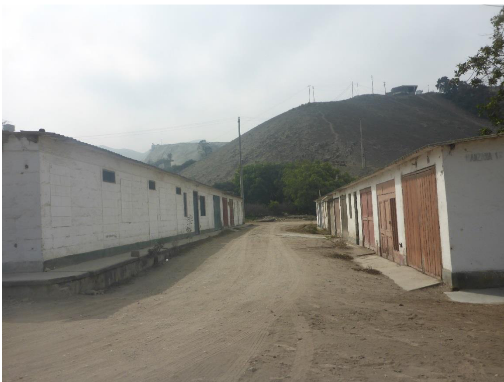
Foto N.º2 Módulos antiguos con tamaño de ventanas mínimas de ventilación
