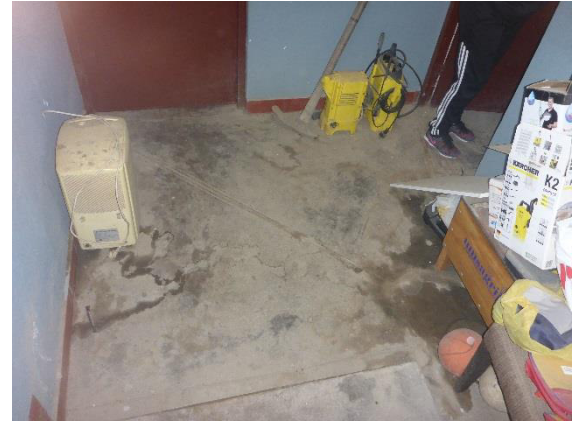
Figura N ° 2 El acabado de las viviendas es de falso piso.
