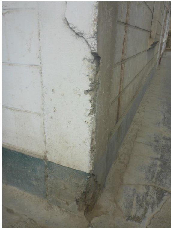
Foto N°12 Columnas deterioradas
