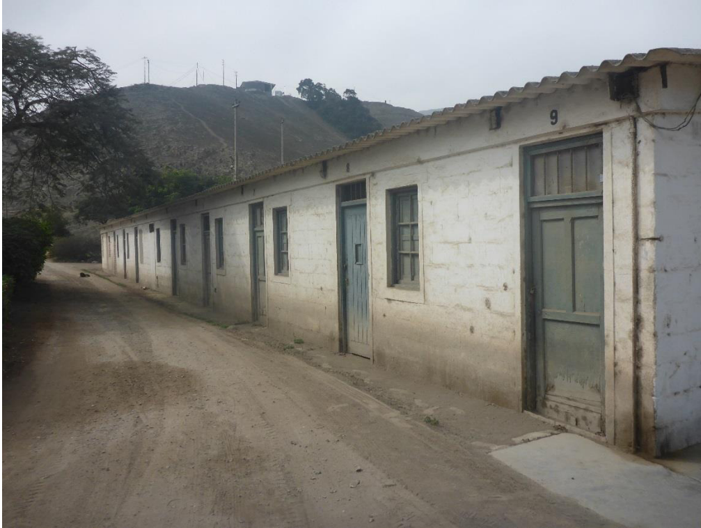
Foto N.º3 Enumeración actual de módulos sin vereda con puertas podridas de madera
