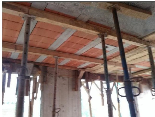
Figura 23. Apuntalamiento de viguetas Elaboración: los autores
