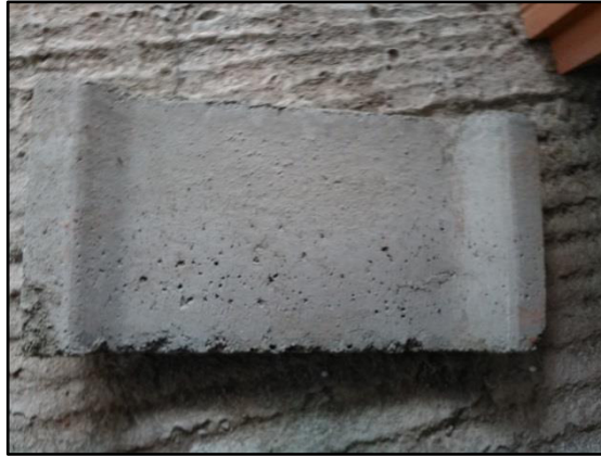
Figura 11. Bandeja sanitaria prefabricada Elaboración: los autores
