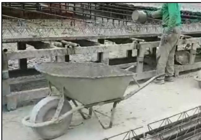
Figura 17. Vaciado de concreto para vigueta Elaboración: los autores
