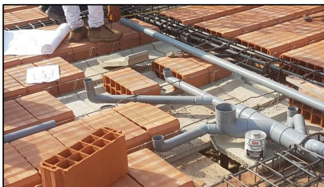
Figura 25. Instalación de bandeja sanitaria Elaboración: los autores
