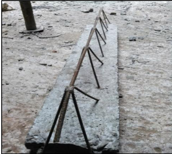
Figura 8. Vigueta prefabricada de alma abierta. Elaboración: los autores
