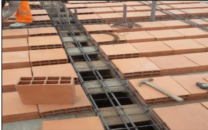
Figura 4. Sistema de Losa Convencional Elaboración: los autores
