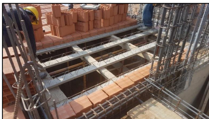
Figura 22. Montaje y alineación de viguetas Elaboración: los autores
