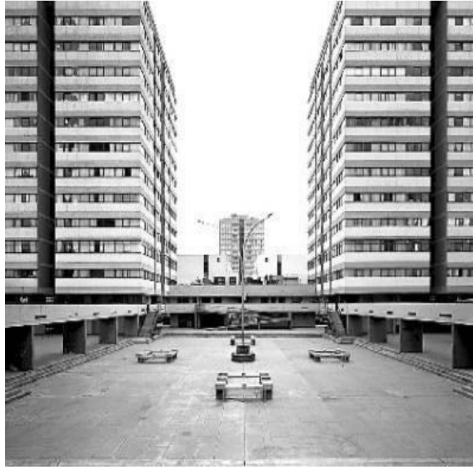
Figura 3. Proyecto de Vivienda Torres de San Fuente: Evolución de los sistemas de construcción
