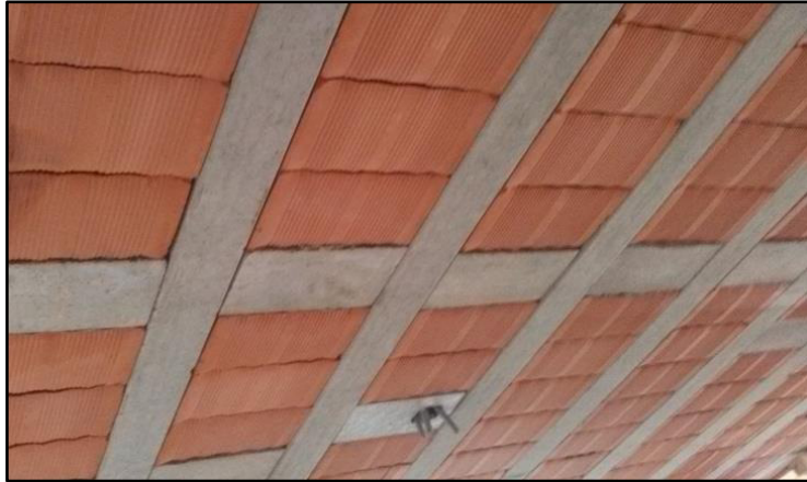
Figura 26. Bandejas estructurales para viguetas transversales Elaboración: los autores
