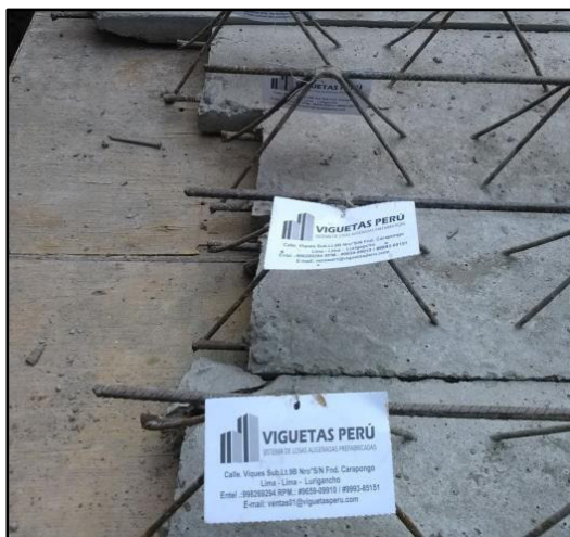
Figura 18. Marcado de Vigueta Elaboración: los autores
