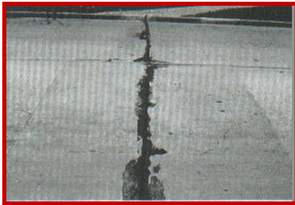
Figura 72: Sello de junta - severidad baja
