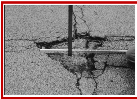
Figura 39: Huecos - severidad media
