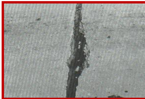
Figura 73: Sello de junta - severidad media
