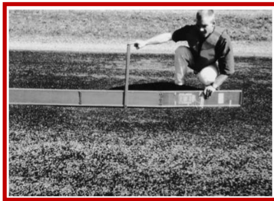
Figura 19: Depresión - severidad baja
