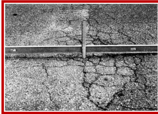
Figura 21: Depresión - severidad alta
