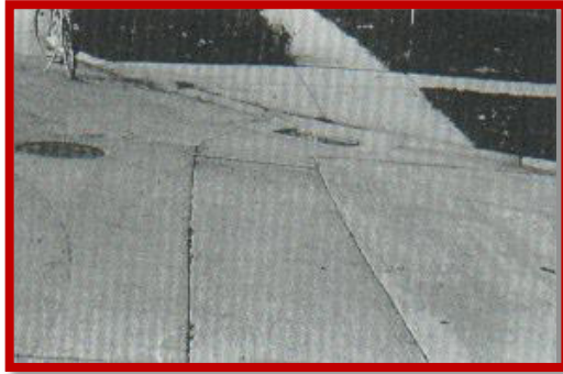
Figura 81: Parche grande - severidad baja
