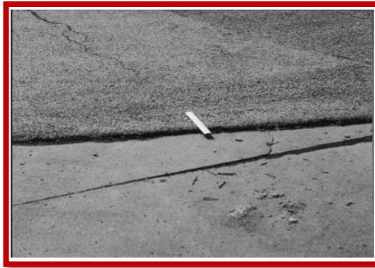
Figura 48: Desplazamiento - severidad media
