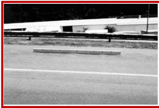
Figura 17: Corrugación - severidad media
