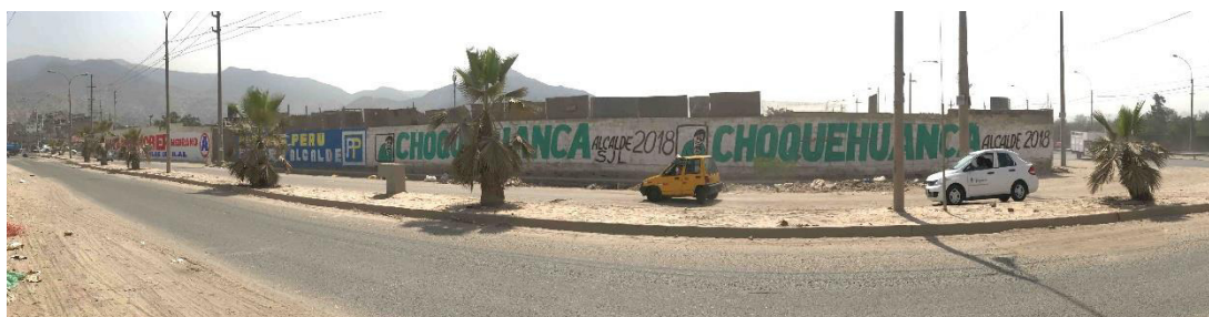
Figura 54: Fotografía de fachada desde la Calle 2
