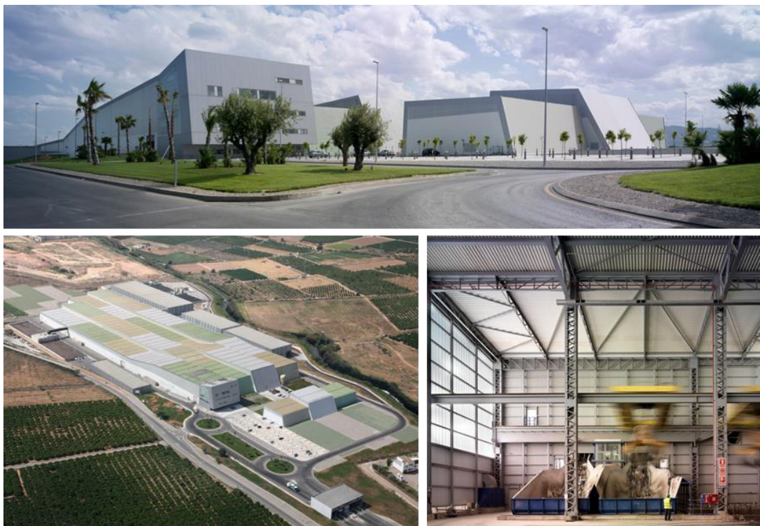
Figura 27: Imágenes de la planta de tratamiento de residuos Los Hornillos
