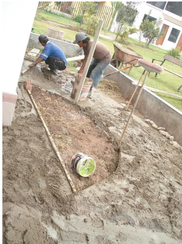
FIGURA 31. DESARROLLO DE OBRAS CIVILES SIN 5 S
