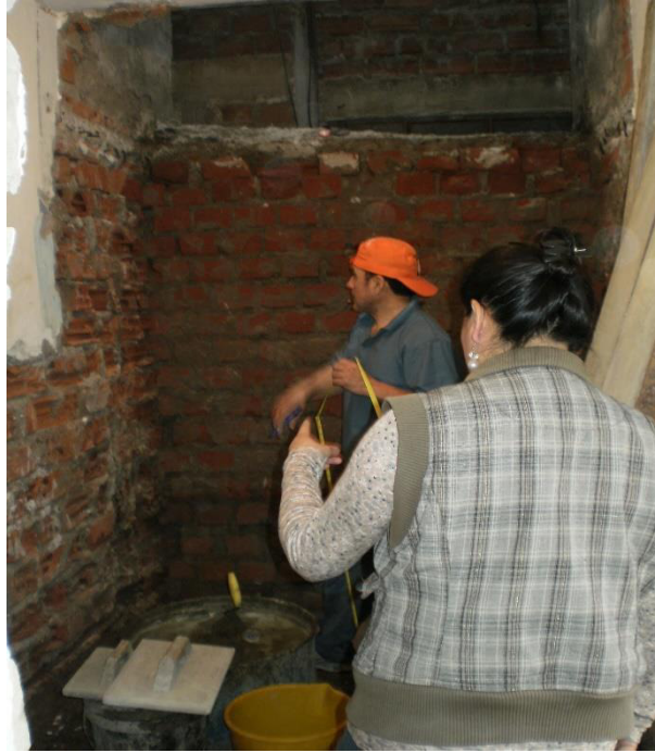
FIGURA 26. SUPERVISIÓN DE OBRA DE ARQUITECTOS LUEGO DEL METRAJE
