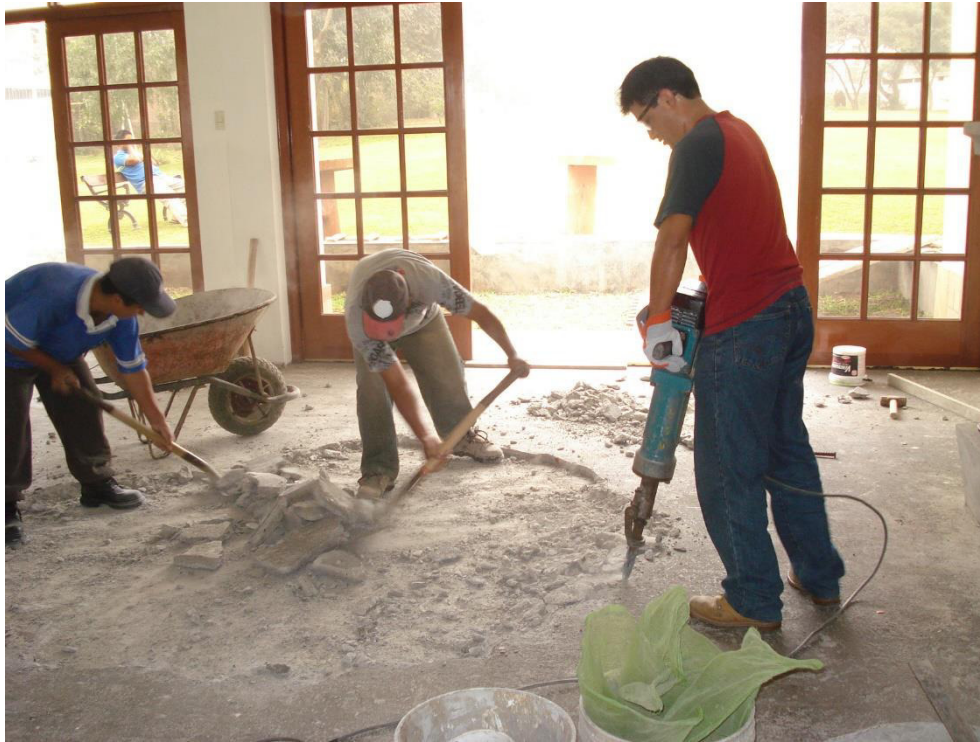
FIGURA 30. CONSTRUCCIÓN DE OBRAS CIVILES
