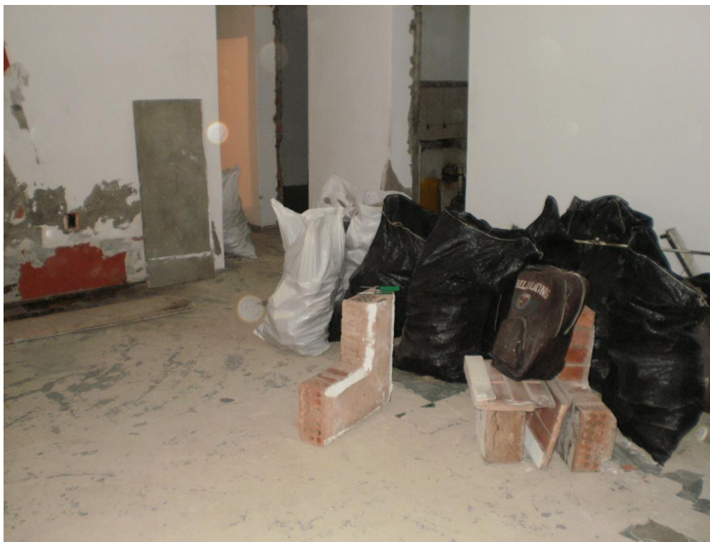
FIGURA 23. VISTA DE LA REMODELACIÓN CON LA ELIMINACIÓN DE DESMONTE
