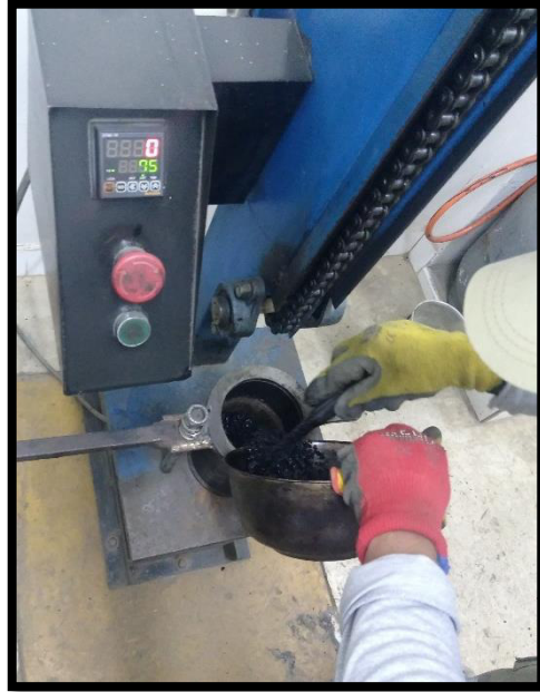
Figura 39: Mezcla de agregados en molde Marshall
