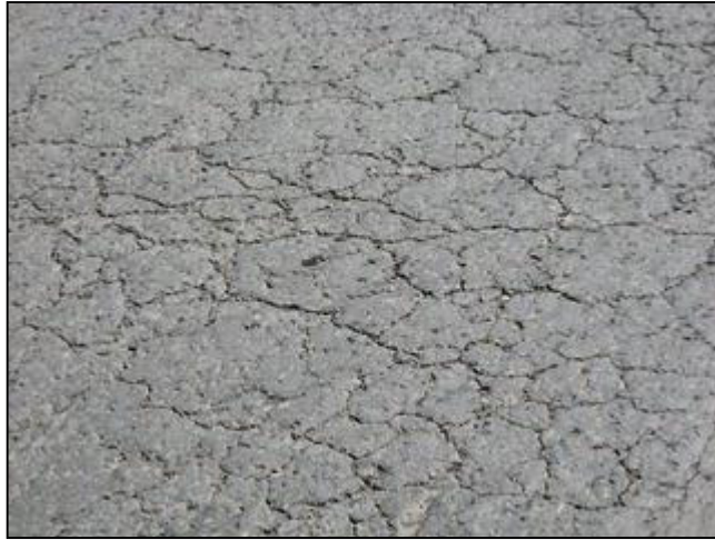
Figura 3. Piel de cocodrilo (Fuente: Elaboración Propia)
