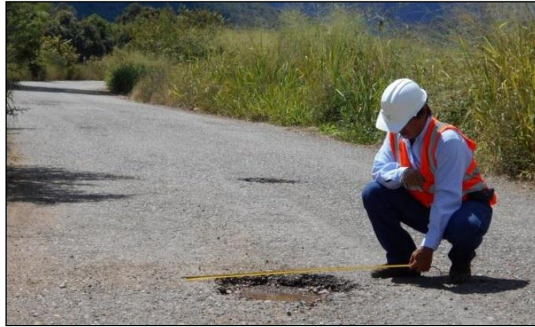
Figura 22. Inspección de Huecos (Fuente: Elaboración Propia)
