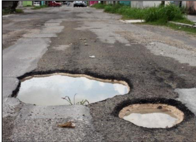
Figura 16. Baches en el Pavimento (Fuente: Elaboración Propia)
