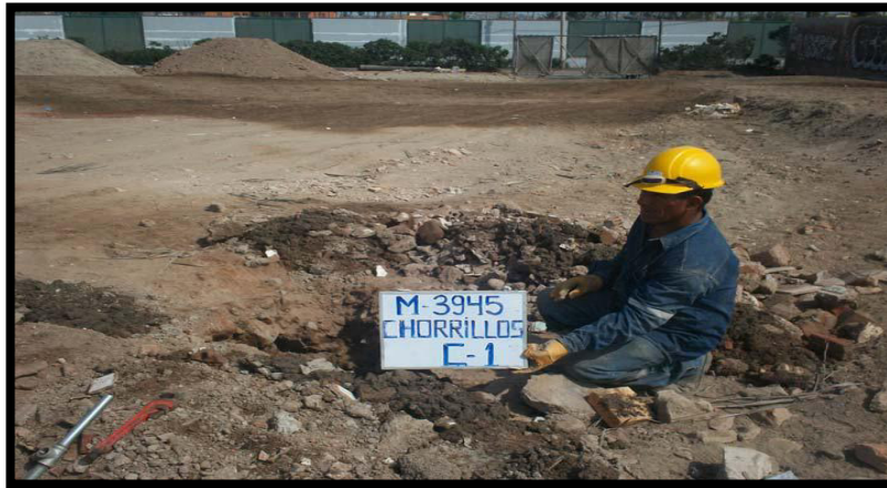
Figura 15: excavación de calicata C-1
