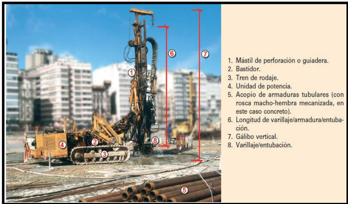
Figura 8: Equipo de perforación de micropilotes
