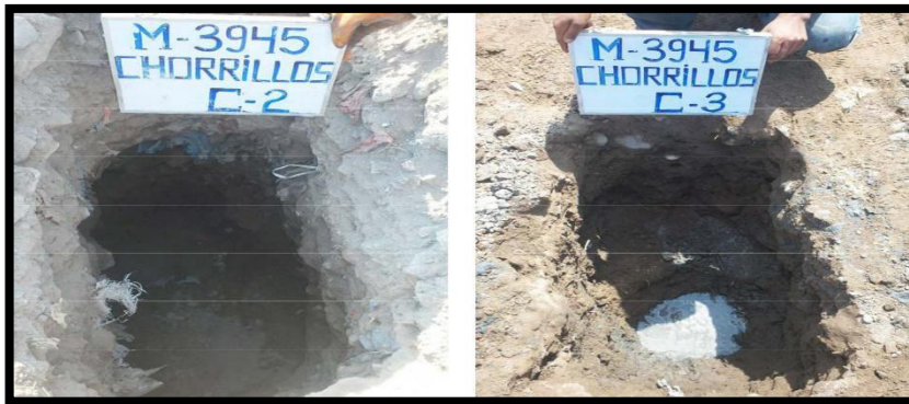
Figura 16: excavación de calicata C-2 y C-3
