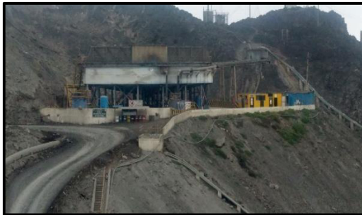
Figura 27. Cancha de Relave N°4
