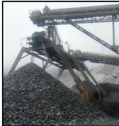
Figura 14. Chancadora Primaria Sandvik – Almacenamiento Chancado Grueso
