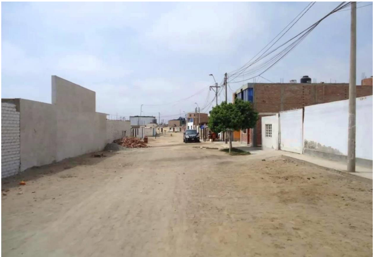
Figura 95. Calle interna distrito de Punta Hermosa. Balneario Por: Google Maps, 2017
