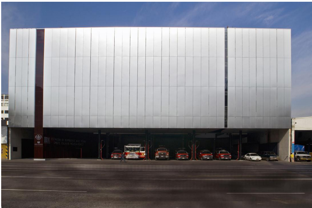
Figura 34 Estación de Bomberos Ave Fénix. Fachada desde la Av. Insurgentes Por: Archdaily Perú, 2009
