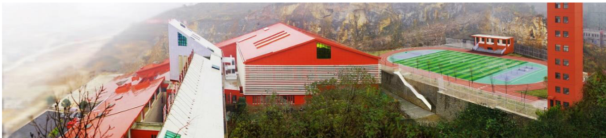
Figura 44. Estación de Bomberos de Guizhou. Fotografía lateral del complejo Por: Archdaily Perú, 2017
