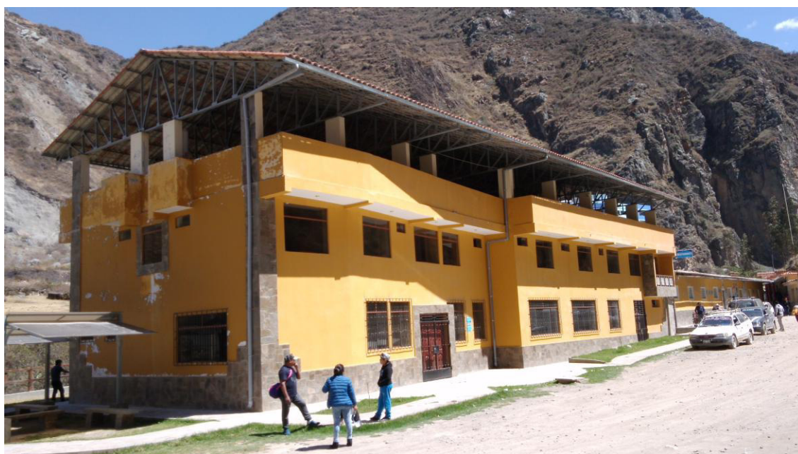
Ingreso a los Baños de La Collpa
