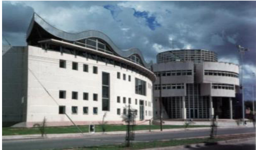
Figura N°8: Fachada principal del CPC Ruta 20 Fuente: Miguel Ángel Roca Architecture
