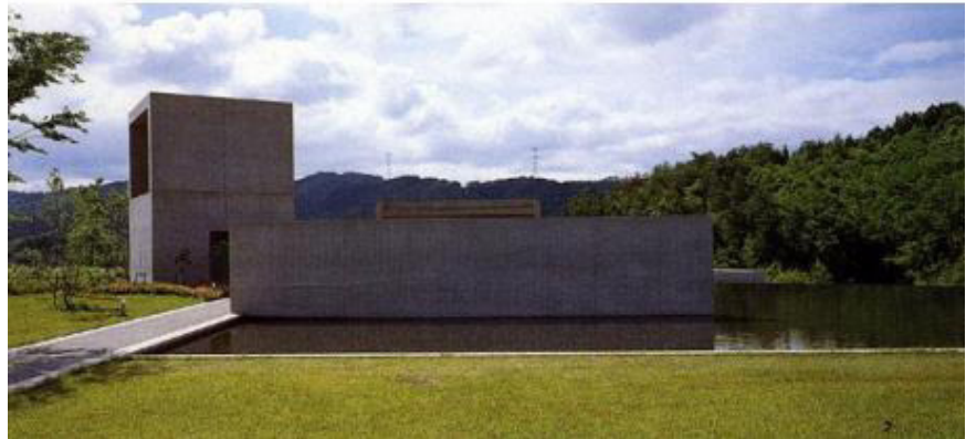
Figura N°10: Vista Lateral del Centro Comunitario de Ayabe Fuente: Architecture Pinterest
