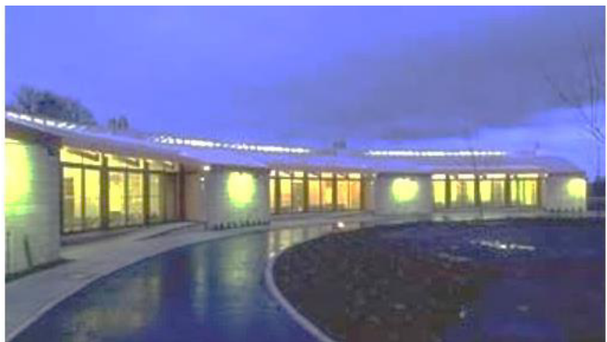
Figura N°5: Centro Comunitario de Forth Valley Fuente: ArchDaily
