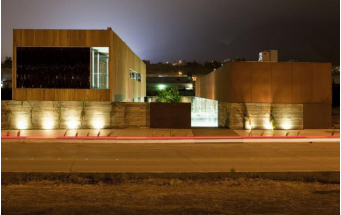
Figura 8 Fachada principal de la Escuela Por Culinary art school (2014)
