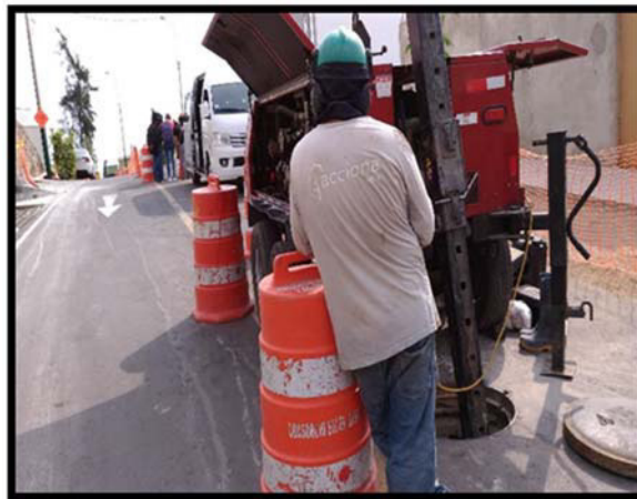
Figura 31: HammerHead ubicado sobre el buzón
