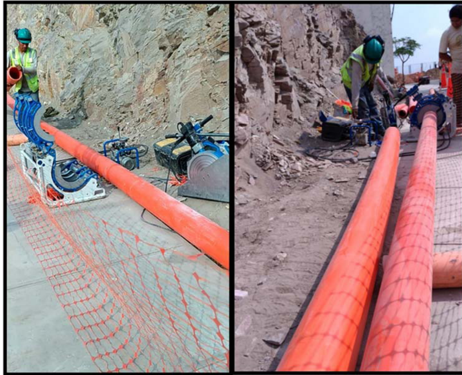
Figura 34: Muestra el proceso de Termofusión de dos tuberías de HDPE de 8”
