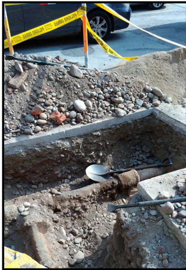
Figura 23. Inicio de las actividades, excavación de la ventana para el ingreso de la unidad hidráulica
