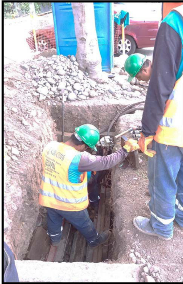
Figura 19. Unidad Hidráulica ya instalada en el punto inicial del cambio de tubería
