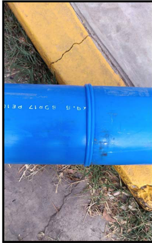
Figura 18. Tubería HDPE de 6" fusionada
