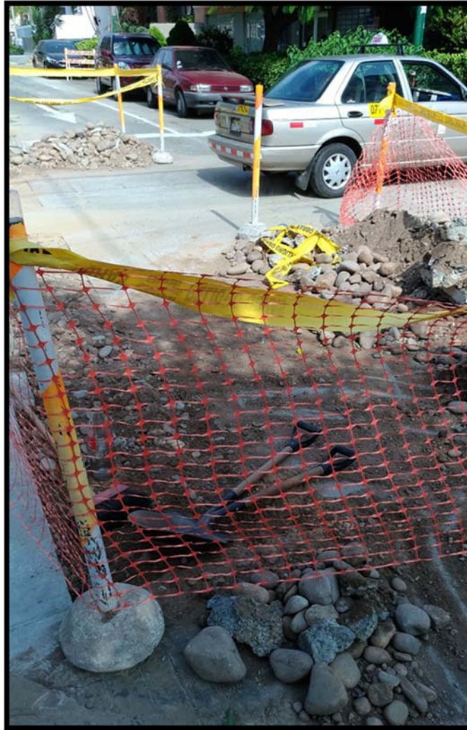
Figura 16. Trabajos en zona señalizada, no interfiere con el tránsito
