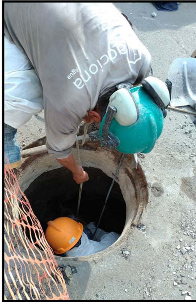
Figura 32: Obrero preparando el buzón para la llegada del cabezal de rotura
