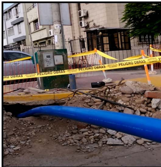
Figura 21. Ingreso de nueva tubería de 6" producto del rompimiento de la existente
