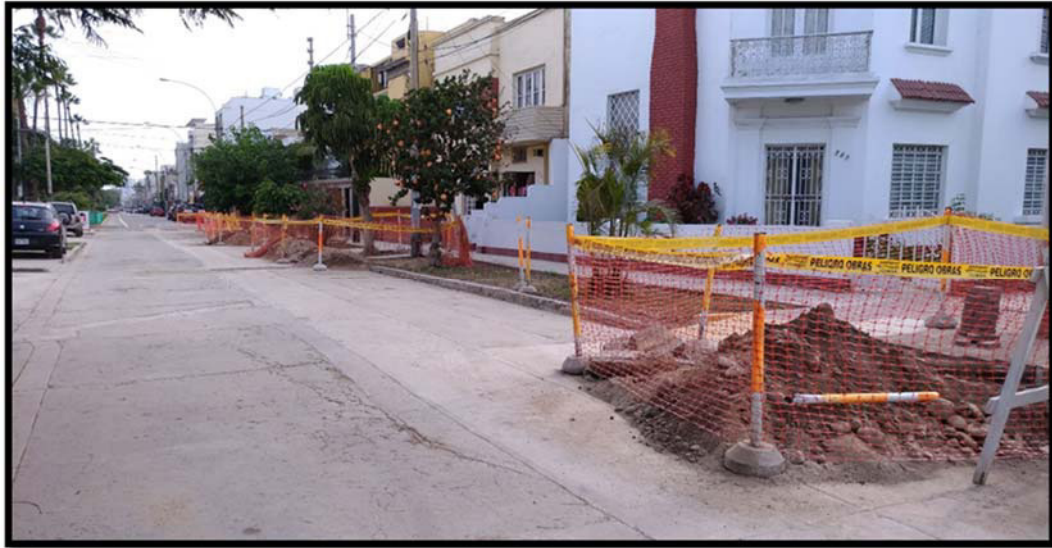
Figura 22. Los trabajos realizados no interrumpen la circulación de carros ni peatones
