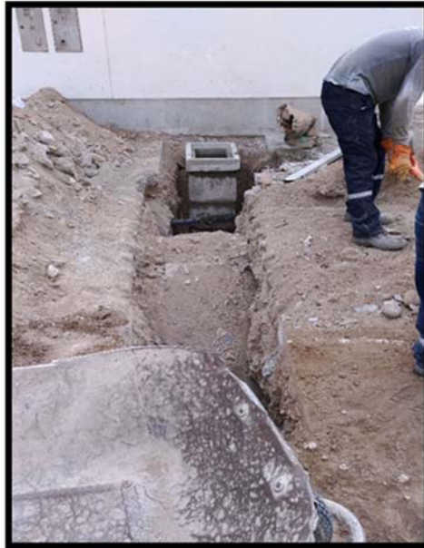
Figura 35: La imagen muestra la culminación de los trabajos con el cierre de zanja de las conexiones domiciliarias
