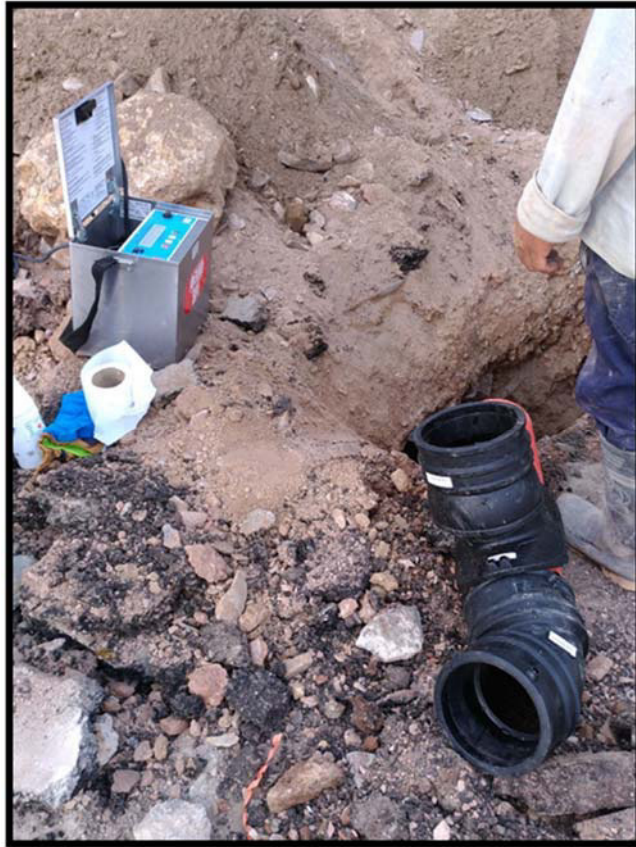
Figura 33: Muestra la unidad de electro soldado y la cachimba lista para ser electro soldada
