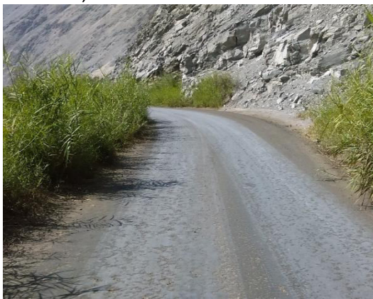
Foto N° 15 Km 12+600 Se aprecia el buen estado de la superficie de rodadura de la vía en ese sector.
