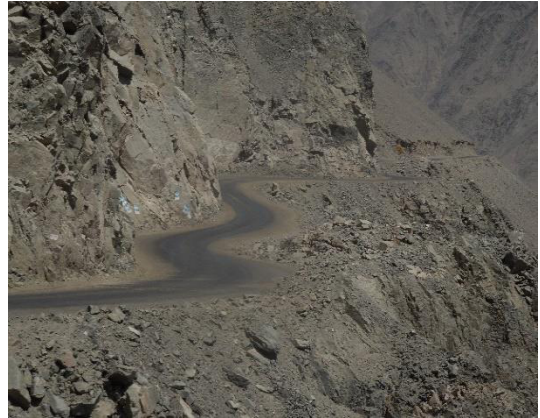
Foto N° 20 Km 25+000 Se aprecia una vista panorámica de la carretera en ese sector.
