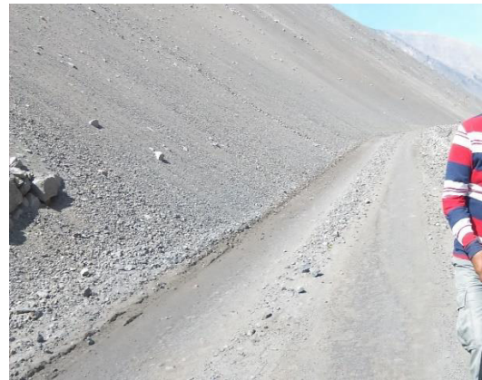
Foto N° 36 Km 32+000 Se aprecia el estado de la superficie de rodadura por la caída de piedras en ese sector.
