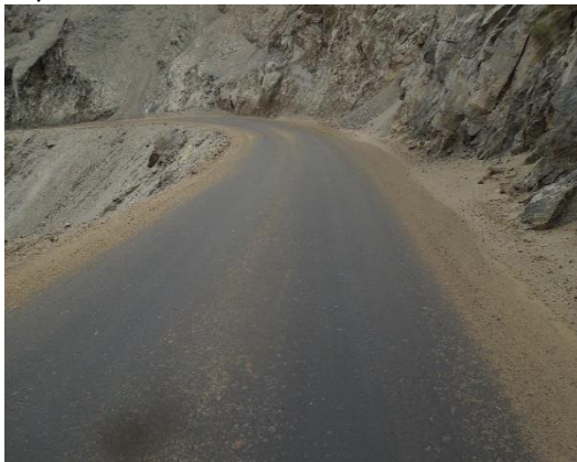
Foto N° 35 Km 34+600. Se aprecia el estado bueno de la superficie de rodadura en ese sector.
