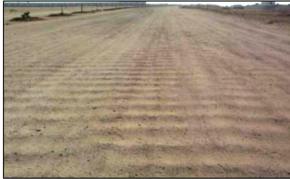
Figura 13: Ejemplo de encalaminado
