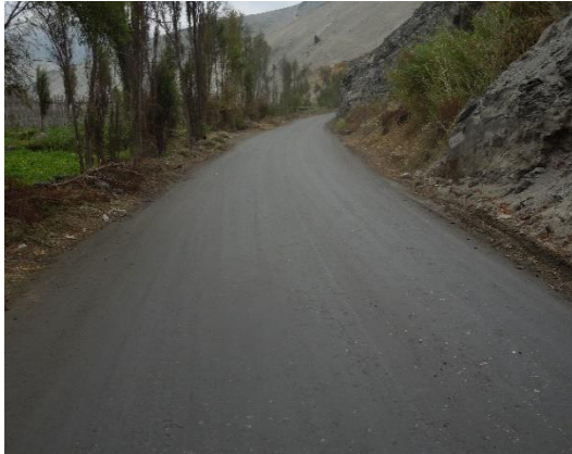
Foto N° 07 Km 09+700. Se aprecia el buen estado de la superficie de rodadura en ese sector.
