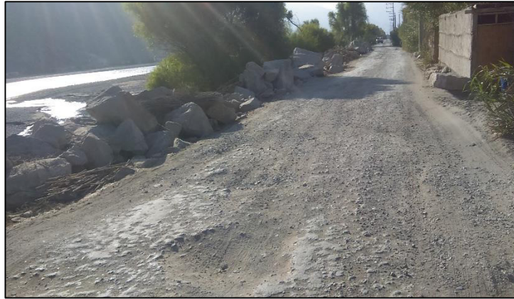
Figura 53: Tramo afectado por trabajos de enrocado
