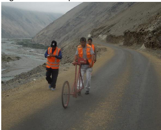
Foto N° 41 Km 34+000 Se aprecia los trabajos de medición de la rugosidad de la superficie de rodadura.
