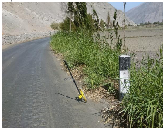
Foto N° 10 Km 10+000 Se puede apreciar el buen estado de la superficie de rodadura de la vía en ese sector.
