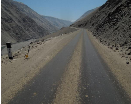
Foto N° 25 Km 28+000 Se puede observar el buen estado de la superficie de rodadura en ese sector.
