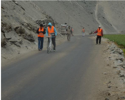
Foto N° 37 Km 12+000 Se puede observar los trabajos de medición de la rugosidad de la superficie de rodadura.
