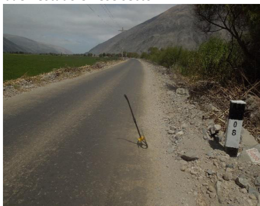
Foto N° 05 Km 08+000. Se aprecia la condición de la superficie de rodadura en buen estado.
