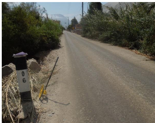
Foto N° 03 Km 06+000 Se aprecia la superficie de rodadura en buen estado en ese sector.
