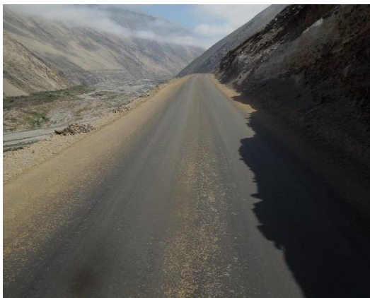
Foto N° 33 Km 33+500 Se puede observar el estado bueno de la superficie de rodadura en ese sector.
