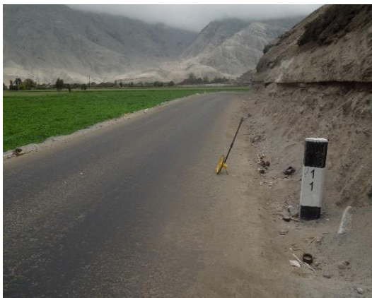
Foto N° 09 Km 11+000. Se aprecia la condición buena de la superficie de rodadura en ese sector.
