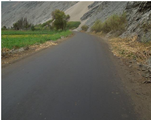
Foto N° 11 Km 12+800. Se aprecia la condición buena de la superficie de rodadura en ese sector.
