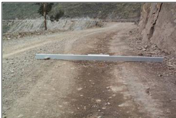
Figura 19: Ejemplo de ahuellamiento
