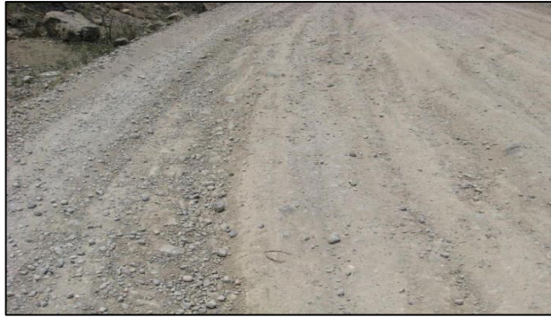
Figura 21: Ejemplo de agregado suelto
