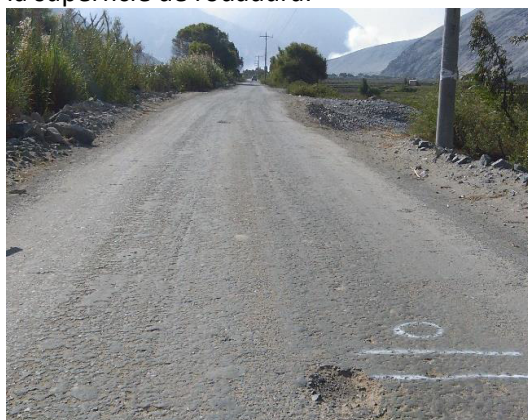
Foto N° 05 Km 07+000 Se puede apreciar la condición de la superficie de rodadura, en buen estado.
