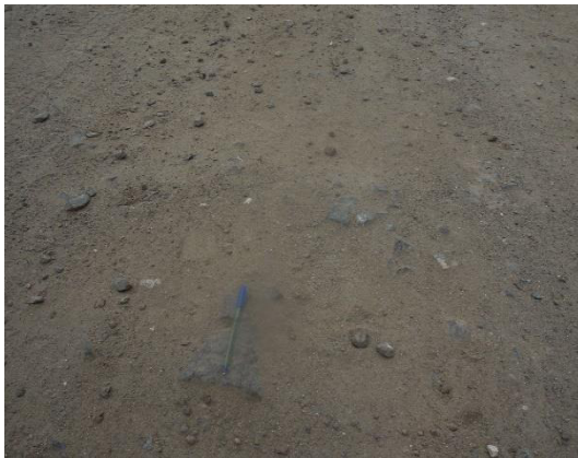
Foto N° 17 Km 14+650 Se aprecia el tamaño de las gravas en la superficie de rodadura (grava muy grande).
