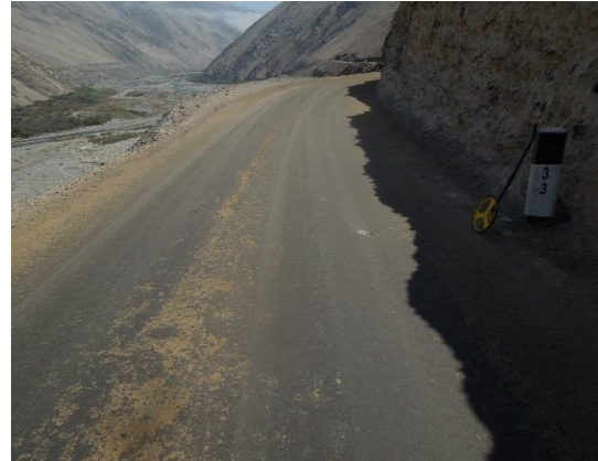
Foto N° 32 Km 33+000 Se aprecia el buen estado de la superficie de rodadura en ese sector de la vía.
