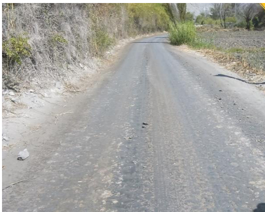
Foto N° 17 Km 13+200 Se observa sector con superficie de rodadura en buen estado.
