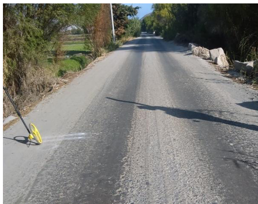
Foto N° 01 Km 05+000 Se puede observar el estado bueno de la superficie de rodadura en ese sector.
