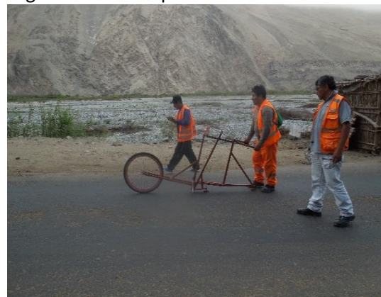
Foto N° 42 Km 35+000. Se aprecia los trabajos de medición de la rugosidad de la superficie de rodadura.
