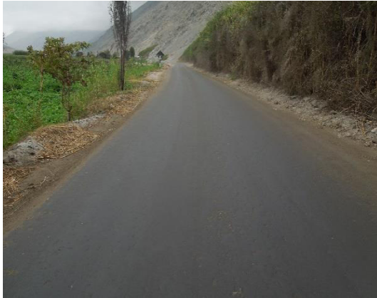
Foto N° 13 Km 13+500. Se aprecia el buen estado de la plataforma en ese sector.
