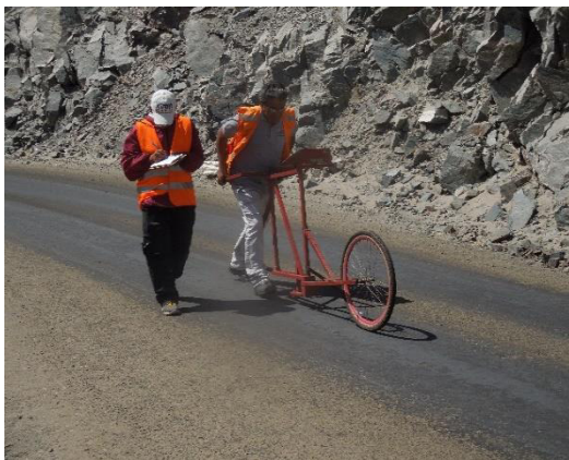
Foto N° 39 Km 24+000. Se aprecia los trabajos de medición de la rugosidad de la superficie de rodadura.
