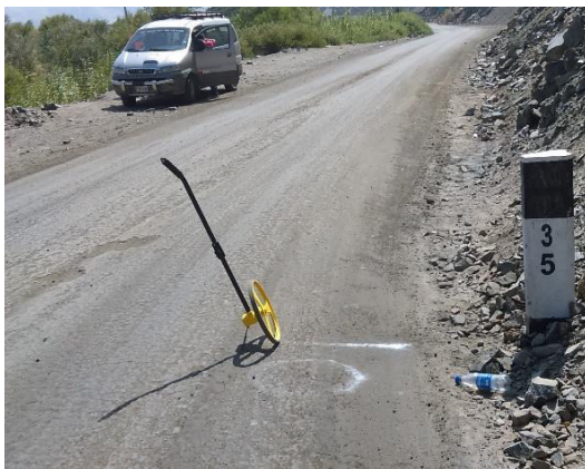
Foto N° 41 Km 35+000 Se muestra las condiciones de la superficie de rodadura en buen estado en ese sector.
