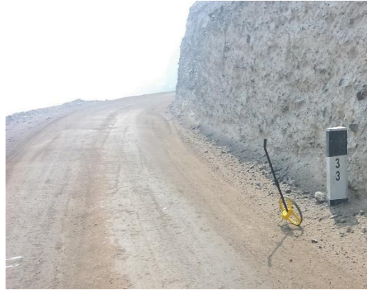
Foto N° 38 Km 33+000 Se aprecia el buen estado de la superficie de rodadura en ese sector.
