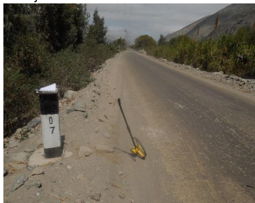
Foto N° 04 Km 07+000 Se aprecia la condición de la superficie de rodadura en buen estado.
