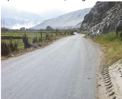
Foto N° 09 Km 09+600 Se observa la condición de la superficie de rodadura, en buen estado.
