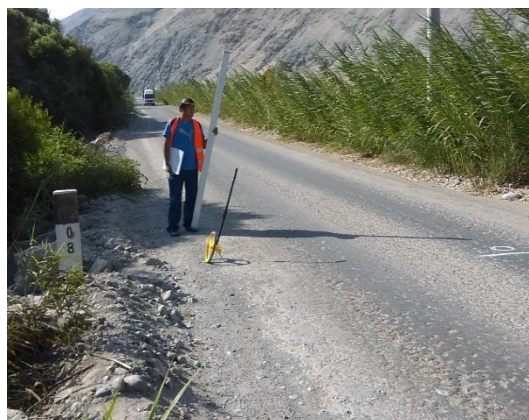
Foto N° 06 Km 08+000 Se aprecia la condición de la superficie de rodadura, en buen estado.
