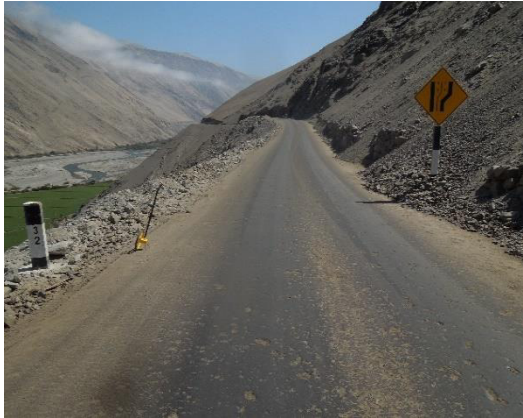
Foto N° 31 Km 32+000 Se aprecia el buen estado de la superficie de rodadura en ese sector.
