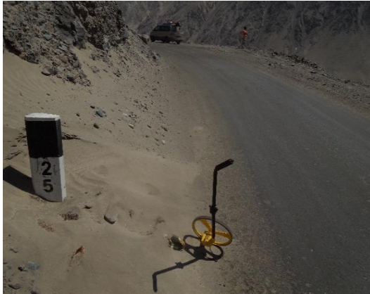
Foto N° 19 Km 25+000 Se puede observar las condiciones y estado de la superficie de rodadura en ese sector.
