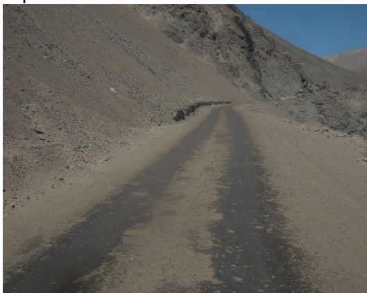
Foto N° 27 Km 29+300 Se aprecia parte de la vía con arenamiento en ese sector.
