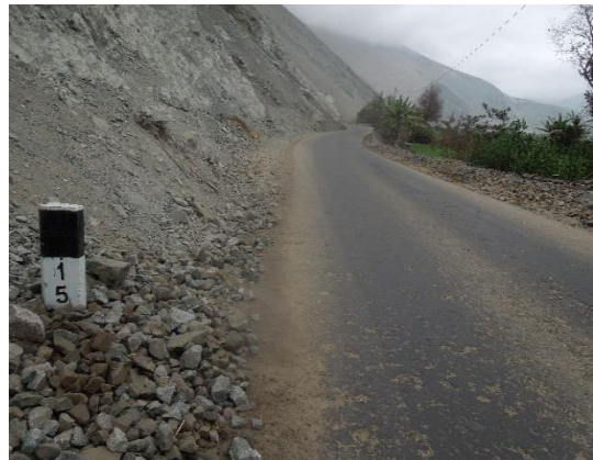
Foto N° 18 Km 15+000 Se aprecia el buen estado de la superficie de rodadura en ese sector.
