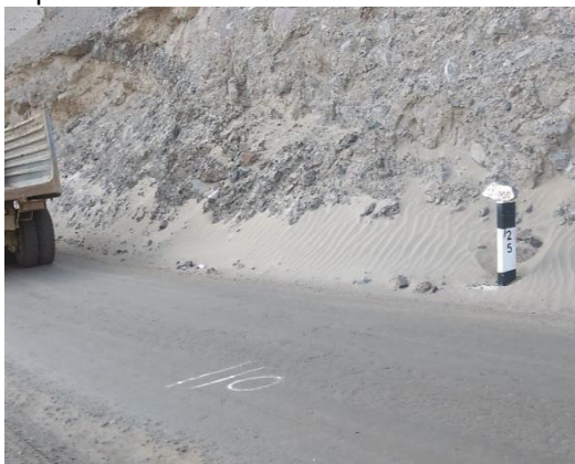
Foto N° 21 Km 25+000 Se puede observar las condiciones de la plataforma en ese sector, buen estado.
