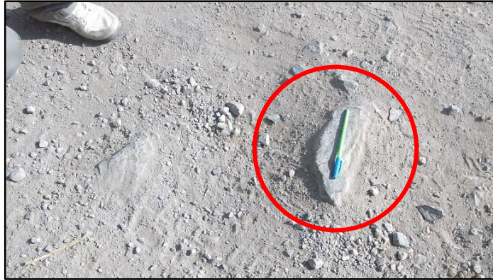
Figura 57: Roca incrustada en la vía
