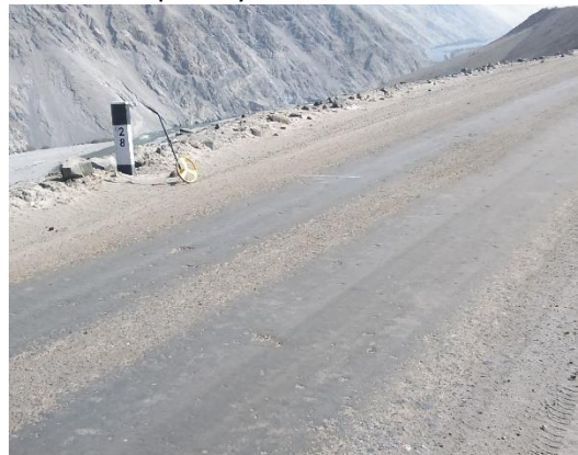
Foto N° 28 Km 28+000 Se observa el buen estado de la superficie de rodadura en ese sector.
