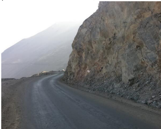
Foto N° 23 Km 25+600 Se aprecia el buen estado de la plataforma en ese sector.
