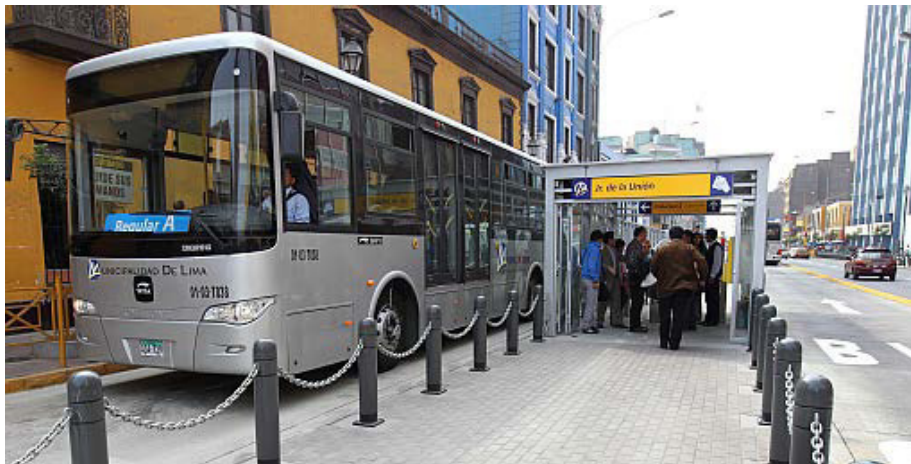
Figura 11. Estación jirón de la Unión del Metropolitano.
