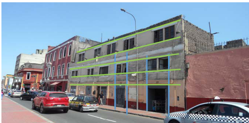
Figura 33. Edificio en jirón Azángaro.
