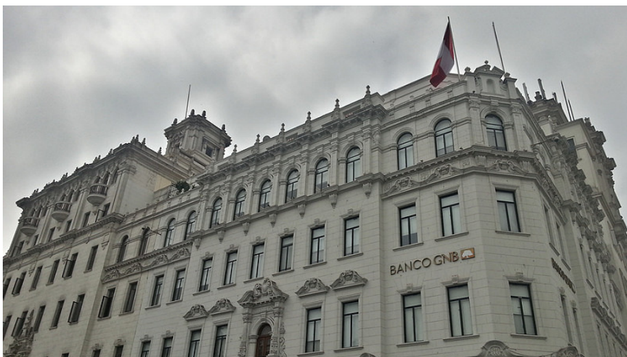
Figura 44. Banco GNB ex Edificio Cerro de Pasco Copper.
