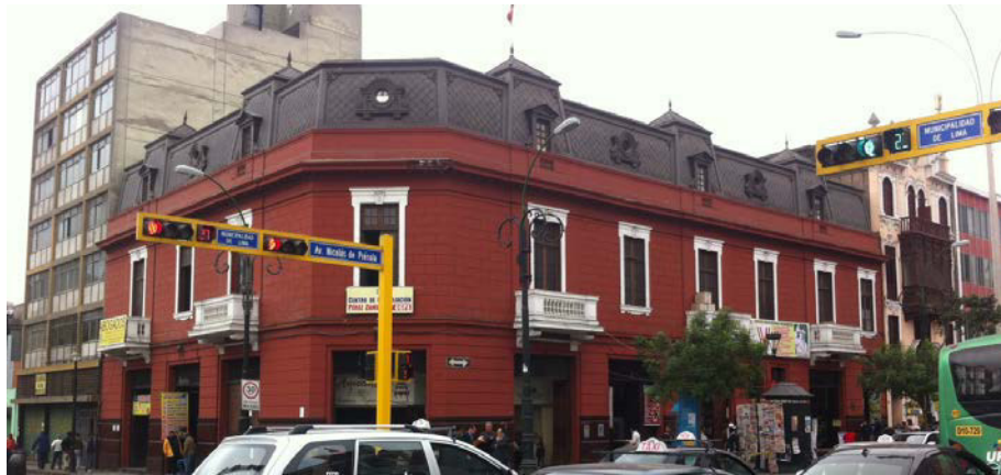
Figura 30. Edificio en Av. Nicolás de Piérola – Jr. Azángaro. Elaboración: el autor, 2015.
