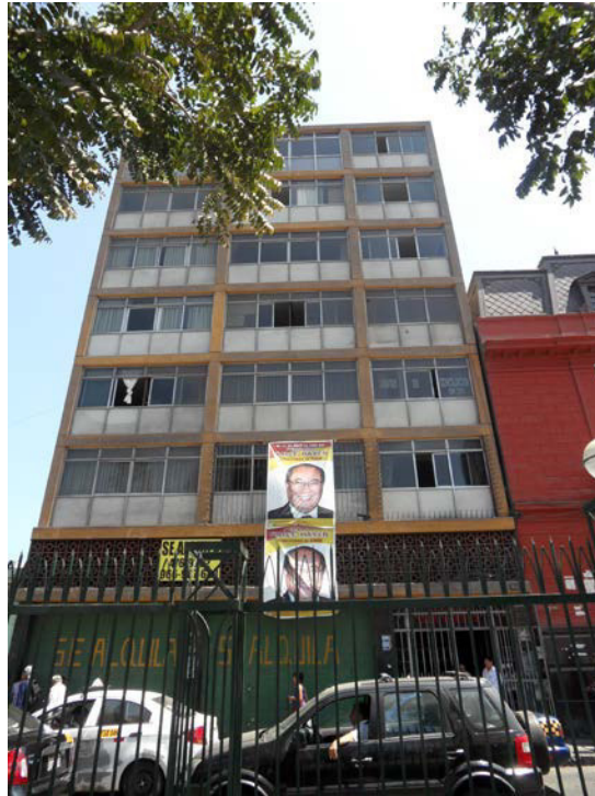
Figura 58. Edificio San Marcos.
