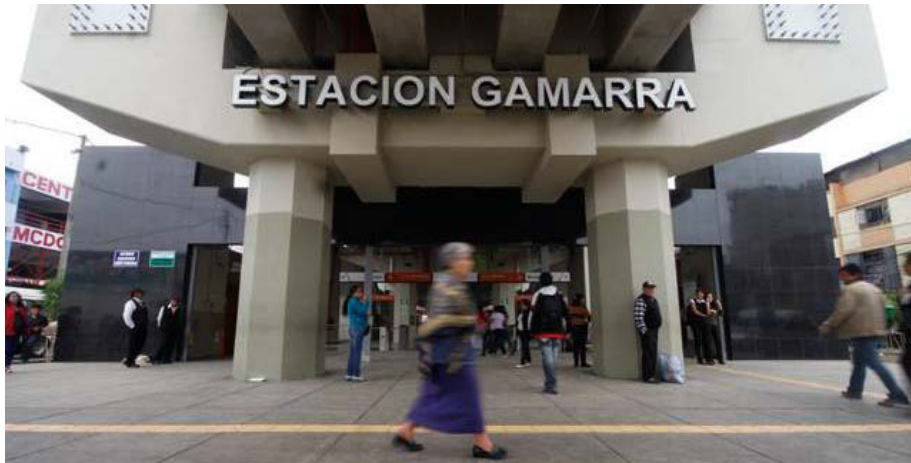
Figura 12. Estación Gamarra. Fuente: Constructora Anir, s.f.
