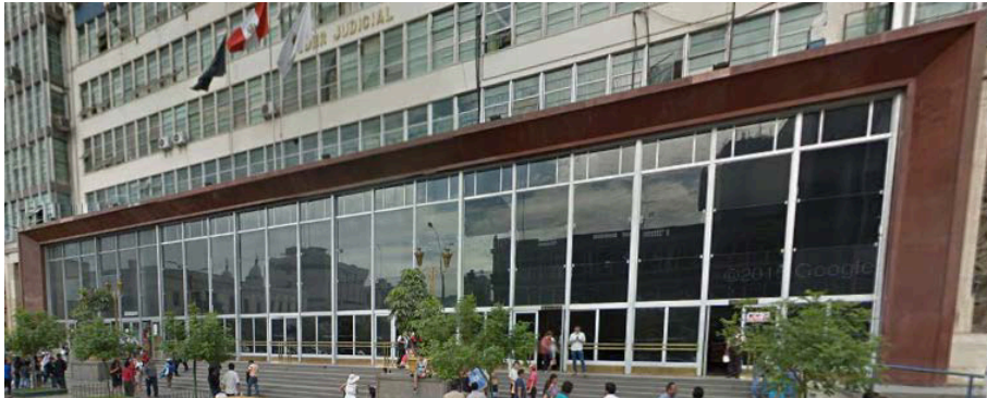
Figura 74. Edificio Fiscalía de la Nación.
