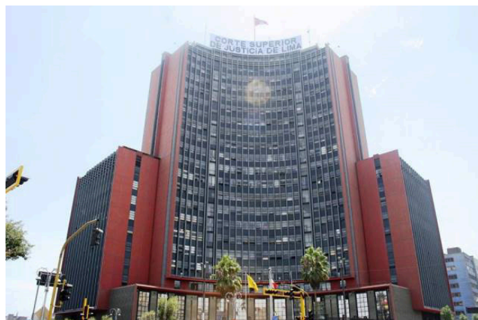
Figura 36. Edificio del ex Ministerio de Educación. 2016
