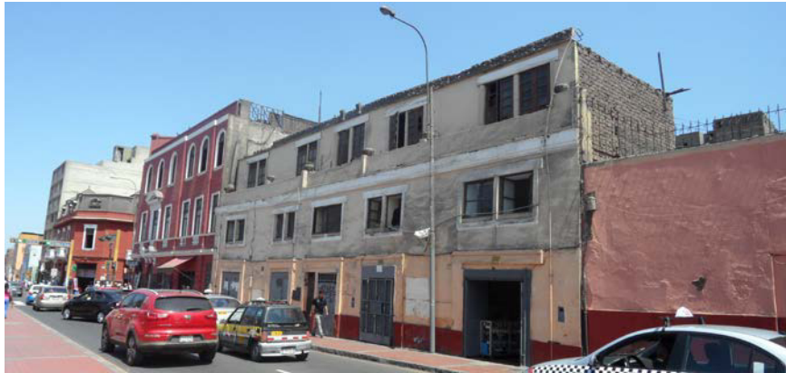
Figura 32. Edificio en jirón Azángaro.
