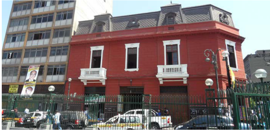
Figura 56. Edificio Jr. Azángaro – Av. Nicolás de Piérola, 2015. Elaboración: el autor, 2015-2016.
