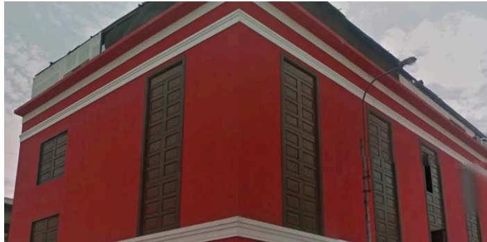
Figura 67. Edificio Jr. Azángaro – Jr. Apurímac.
