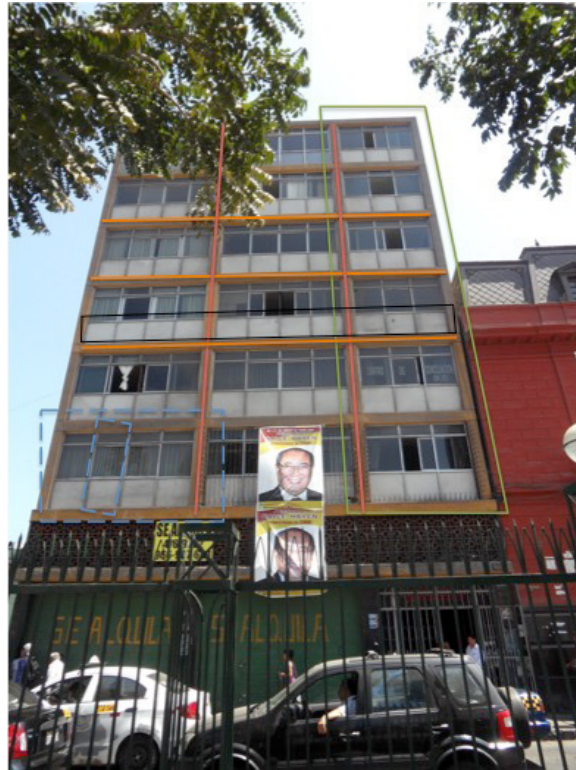
Figura 59. Edificio San Marcos.
