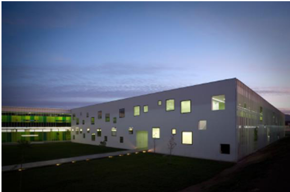
Figura 21: Detalle de fachada Fuente: Marcelo Cáceres
