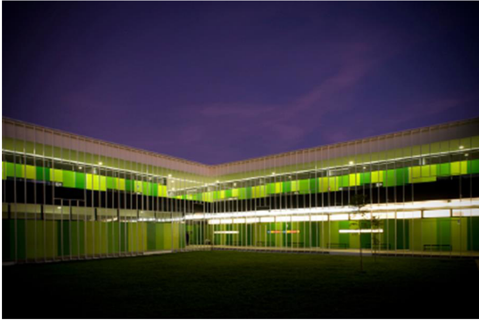
Figura 20: Detalle de fachada Fuente: Marcelo Cáceres
