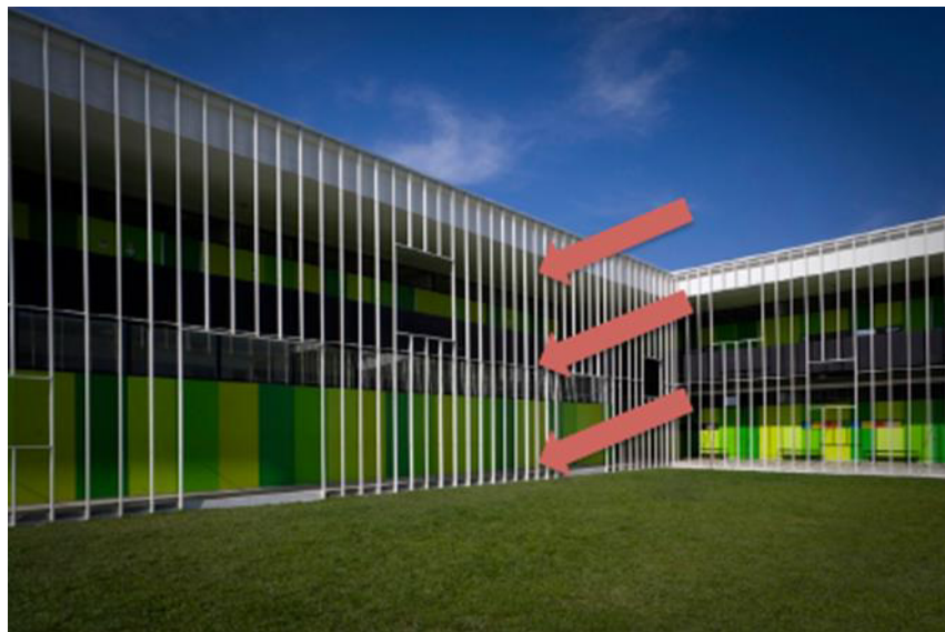
Figura 19: Detalle de fachada
