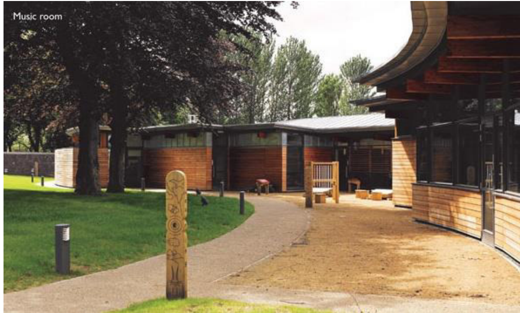
Figura 28: Vista de la sala de música.
