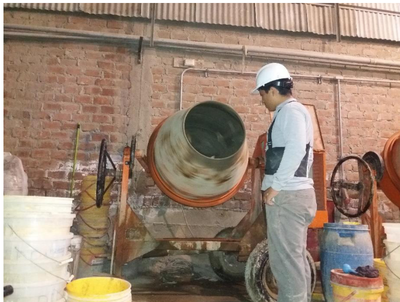
Figura 66. Supervisión del mezclado del concreto en el trompo Elaboración: los autores
