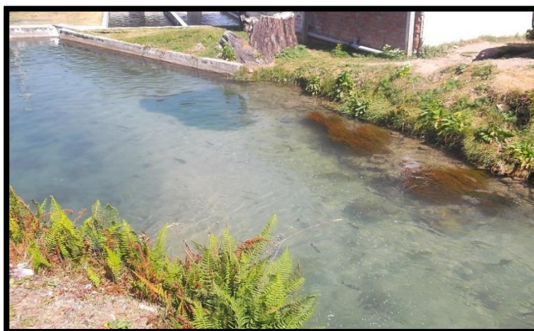
Figura 18. Estanques abandonados y en mal estado. Fuente: Base de la observación.
