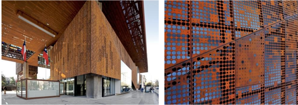
Figura N° 10: Detalle del revestimiento del Centro Cultural Gabriela Mistral
