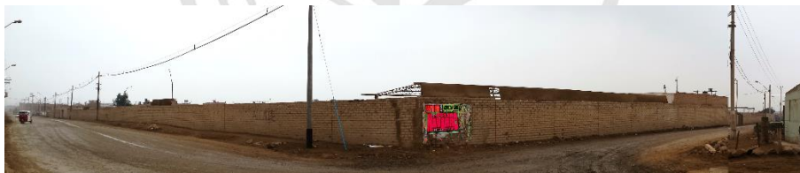
Figura N°32. Punto de toma N°7, esquina de la Av. Martín Olaya con jr. El Olivo.
