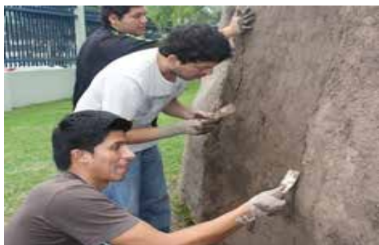
Figura 14. Recubrimiento exterior
