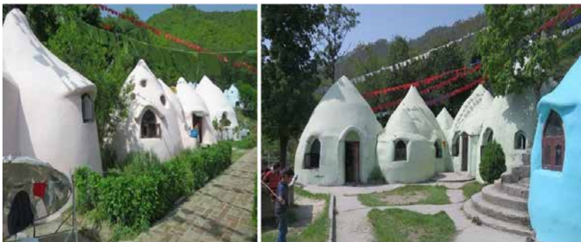
Figura 6. Fotografías Post Terremoto de los domos en superadobe de “Pegasus Children’s Project”
