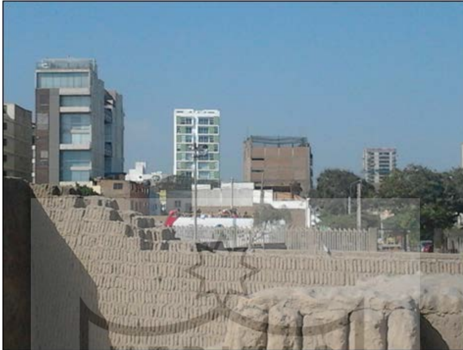
Figura N°9 La técnica antisísmica del librero característica principal de la cultura Lima. (Fuente: Propia).
