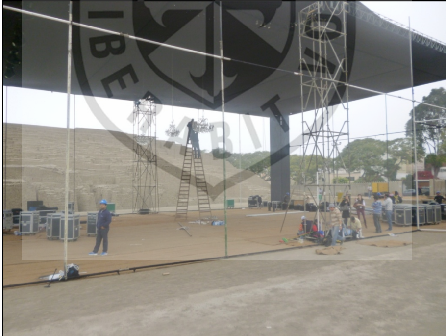
Figura N°40 Armado de los andamios para un espectáculo musical (Fuente: Propia).
