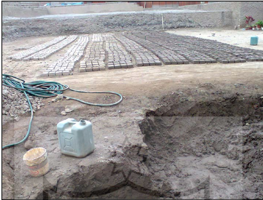
Figura N°24 Elaboración de adobitos para la restauración (Fuente: Propia).
