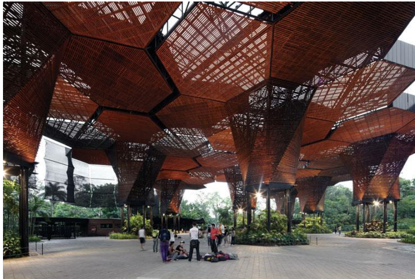
Figura N° 1: Orquideorama, espacio intermedio bajo cubierta. Fuente: http://www.planarquitectura.com
