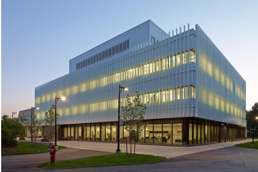
Figura N° 5: Centro de innovación UTM – vista peatonal. Fuente: http://www.archdaily.pe
