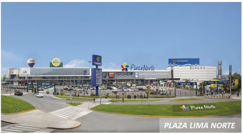
Figura N°03 Gran Terminal Terrestre Plaza Norte Fuente: Google Maps - Elaboración: La autora.
