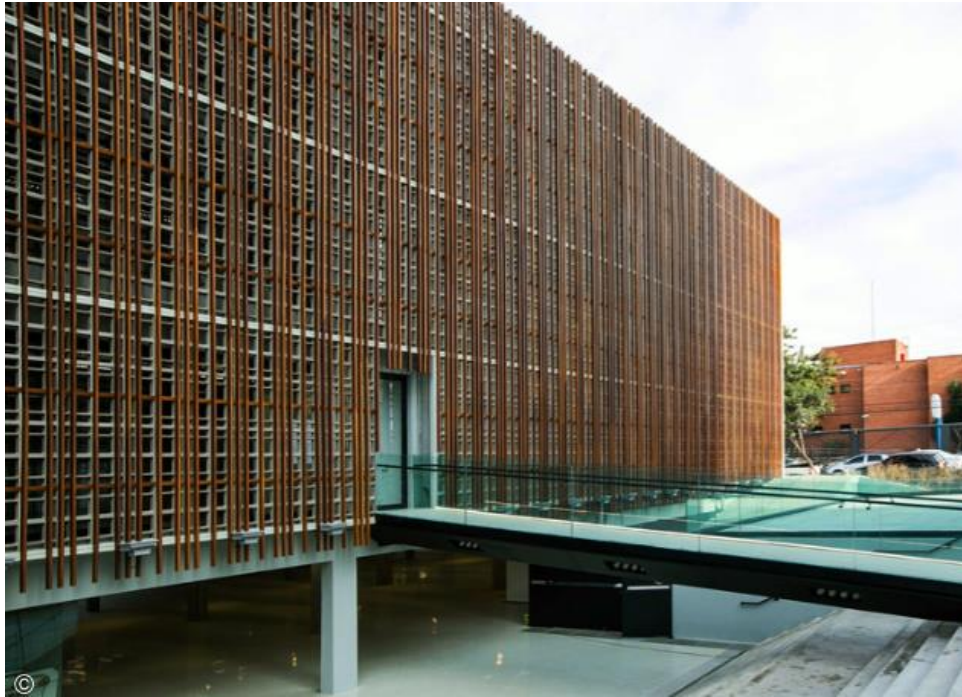
Figura 2: Concreto y enrejado tallado del marco de madera del Centro cultural brasileño de São Paulo Arquitectura
