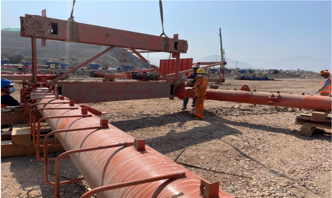
Figura 204. Instalación de soportes de esquina.
