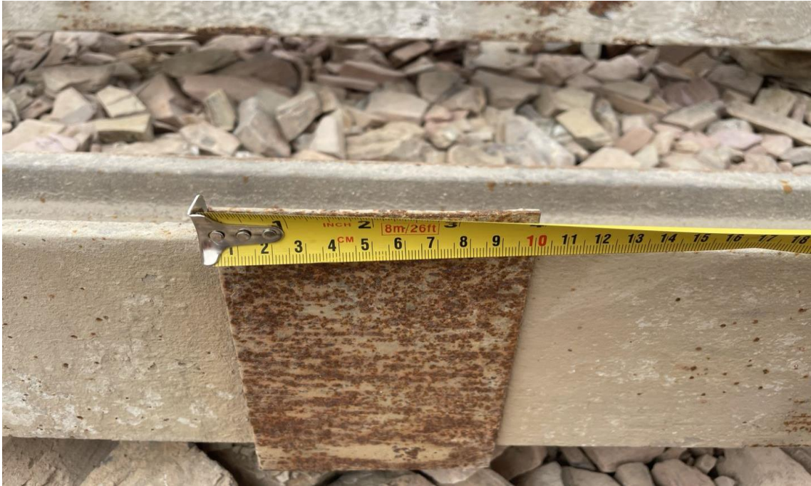
Figura 114. Corrección del nivel de la vía.
