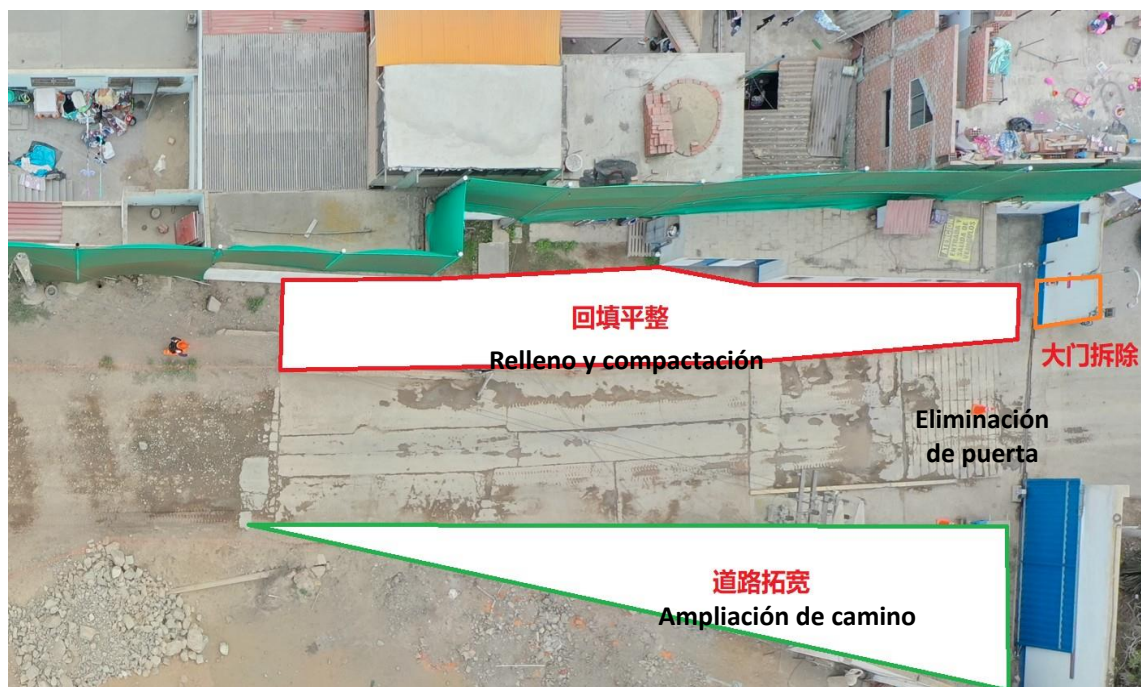
Figura 14. Ampliación de puerta
