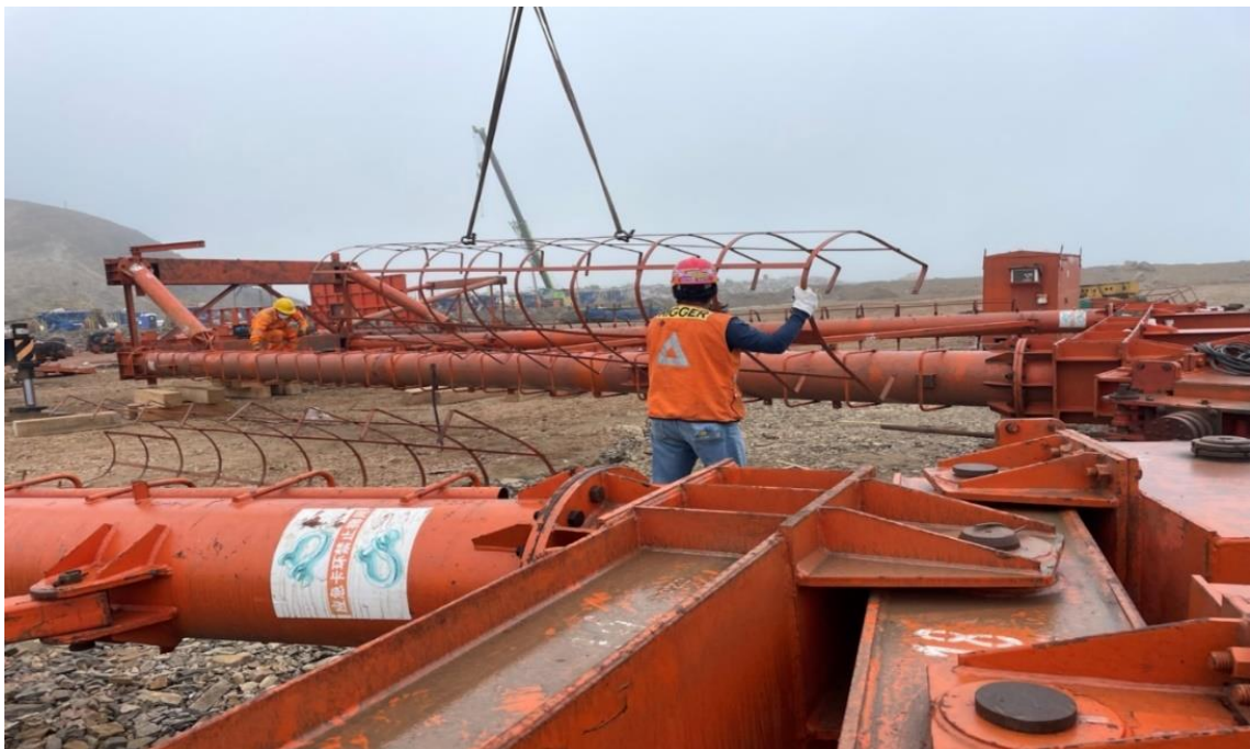
Figura 225. Instalación de la protección de los estabilizadores.
