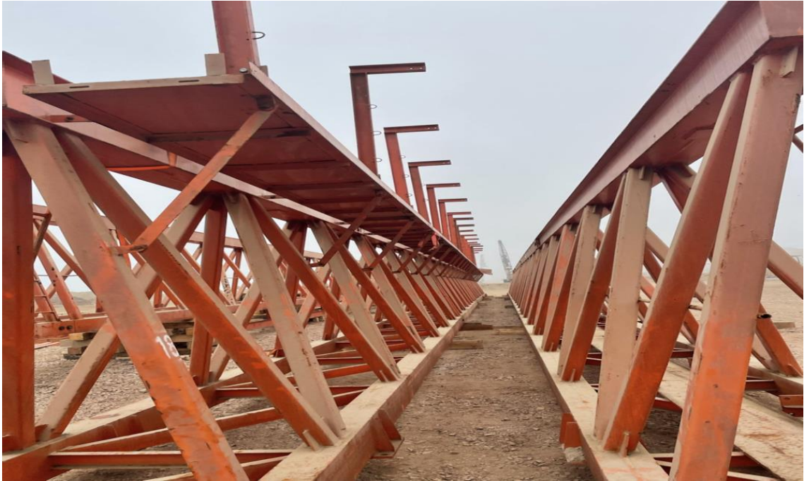
Figura 245. Instalación de los marcos en L.
