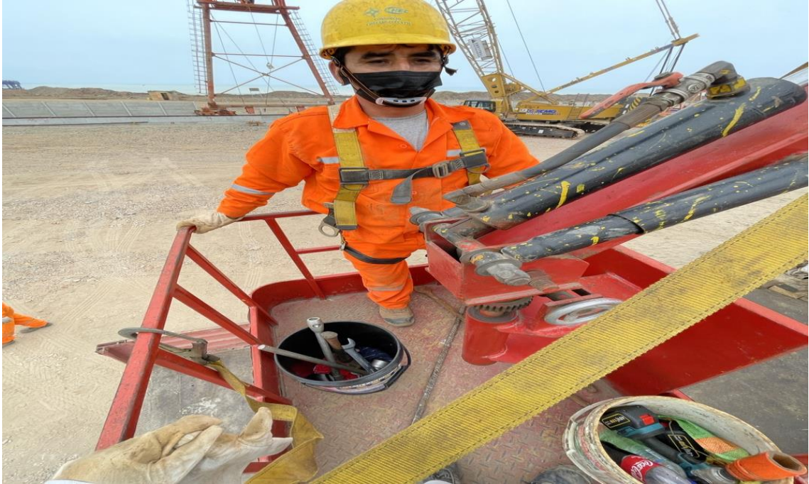
Figura 355. Instalación de los pernos estabilizadores rígidos.
