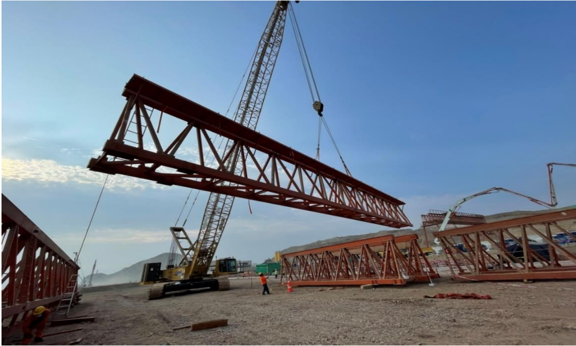
Figura 218. Viga principal hacia atrás.
