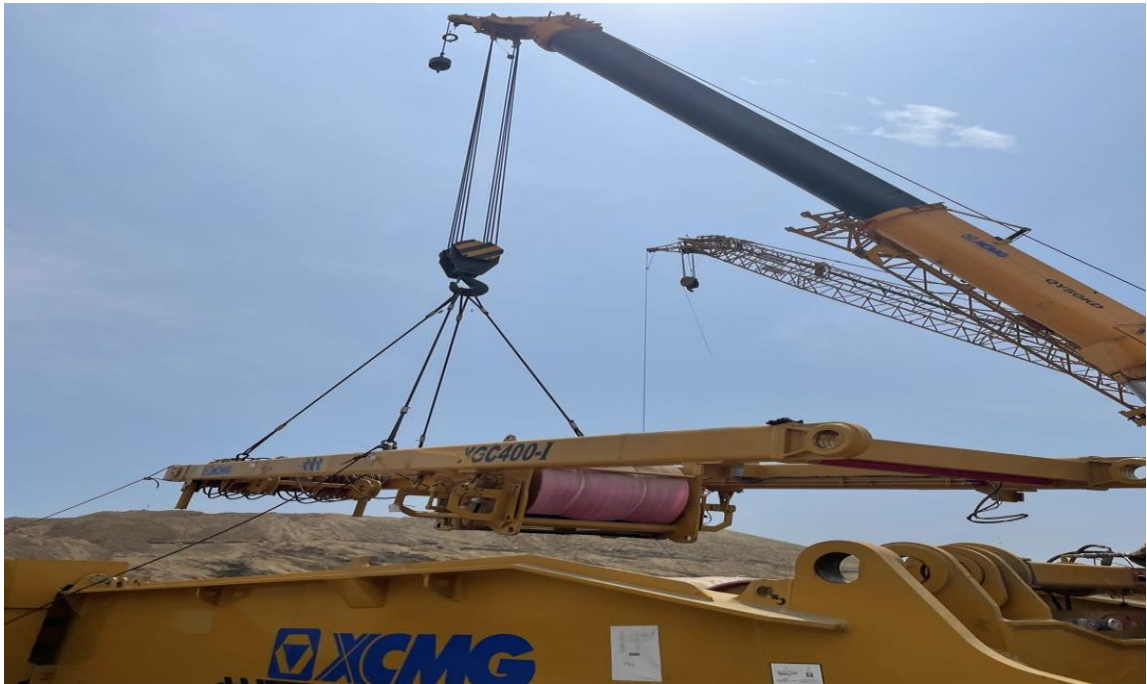
Figura 54. Instalación de la segunda Grúa sobre orugas de 400t 4.
