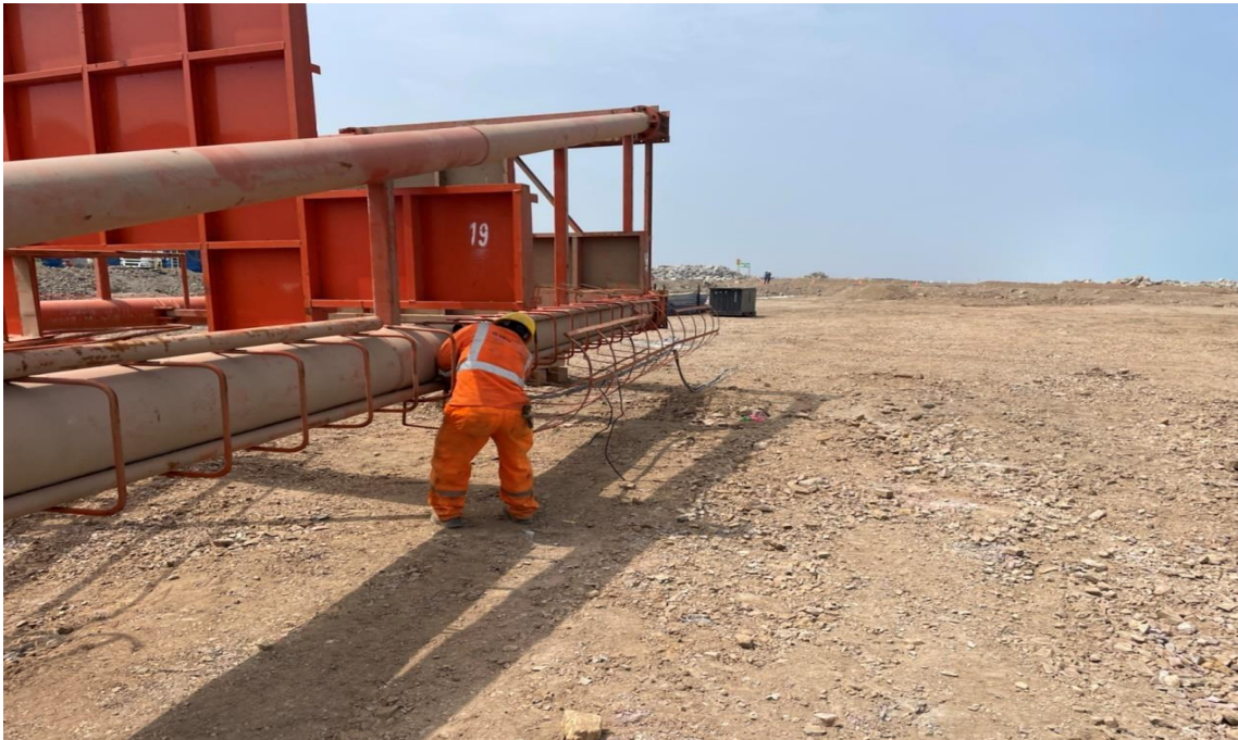
Figura 273. Ejecución de los cables desocupados.
