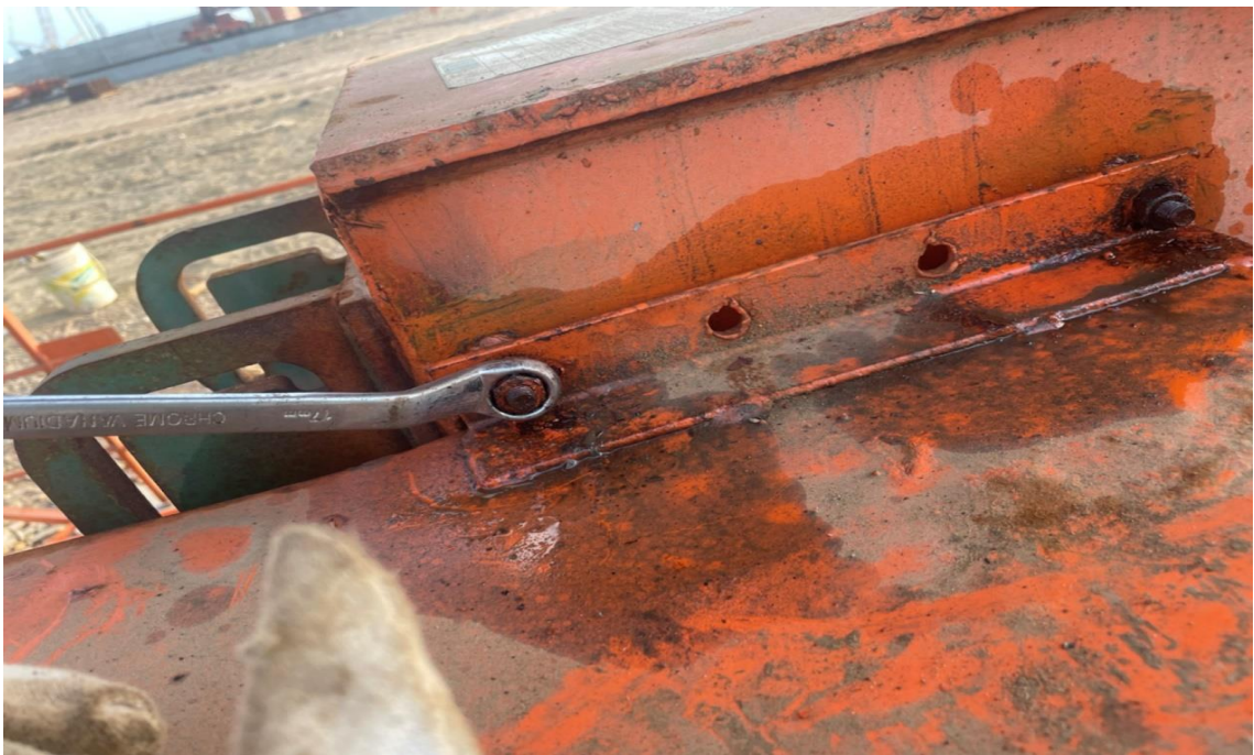
Figura 337. Extracción del deflector.
