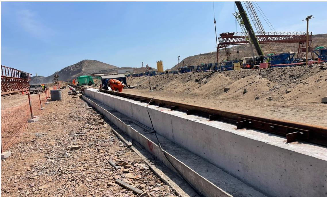
Figura 288. Soldadura de los rieles.
