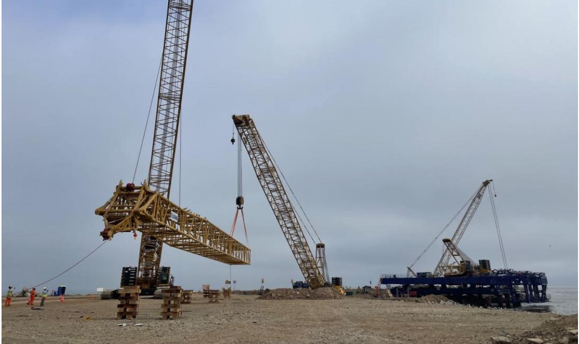
Figura 91. Levantamiento el bastidor de la pluma.
