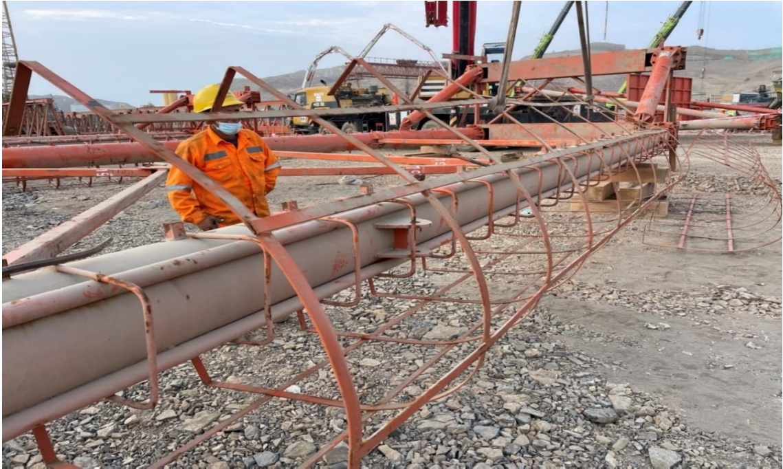
Figura 219. Instalación de la baranda con voladizo.
