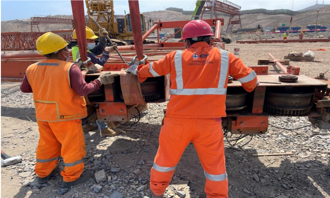
Figura 172. Instalación del grupo de mecanismo del carro.
