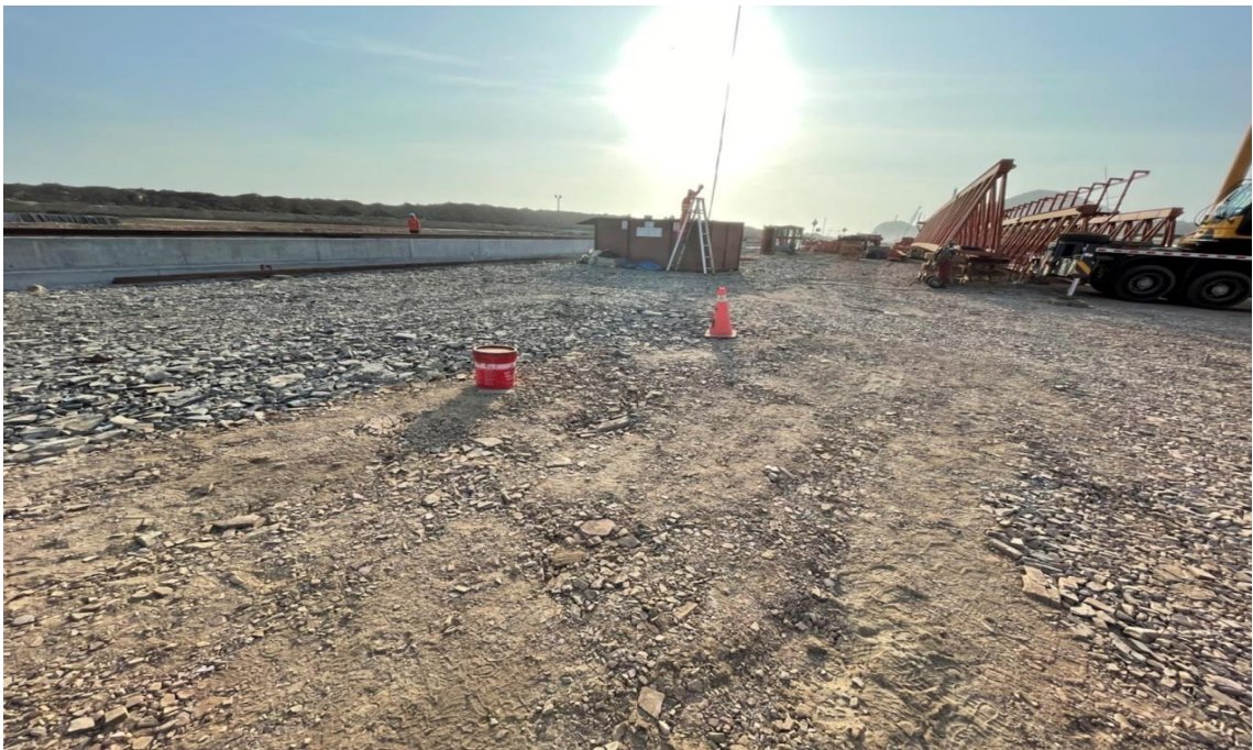
Figura 279. Espacio para la grúa.
