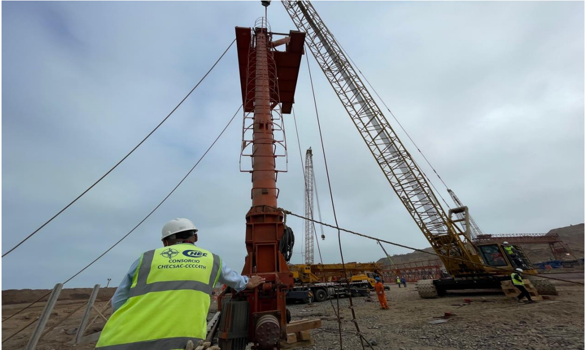
Figura 298. Instalación de estabilizadores flexibles.
