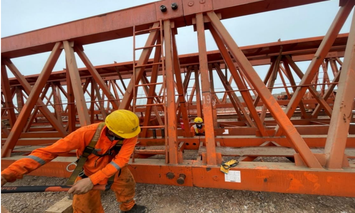
Figura 230. Instalación de la viga principal.
