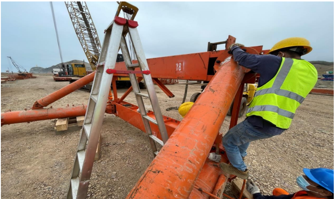
Figura 171. Instalación del soporte de esquina 02.
