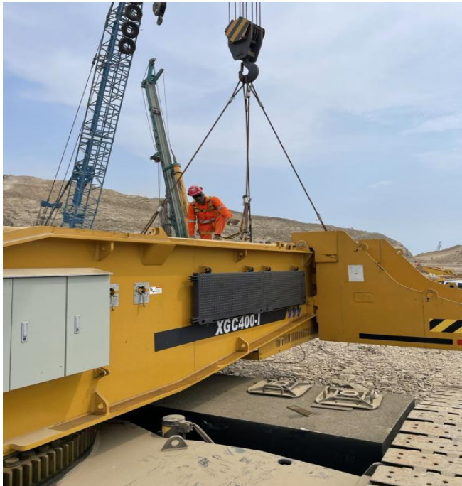
Figura 47. Instalación de grúas sobre orugas de 400 t 6.
