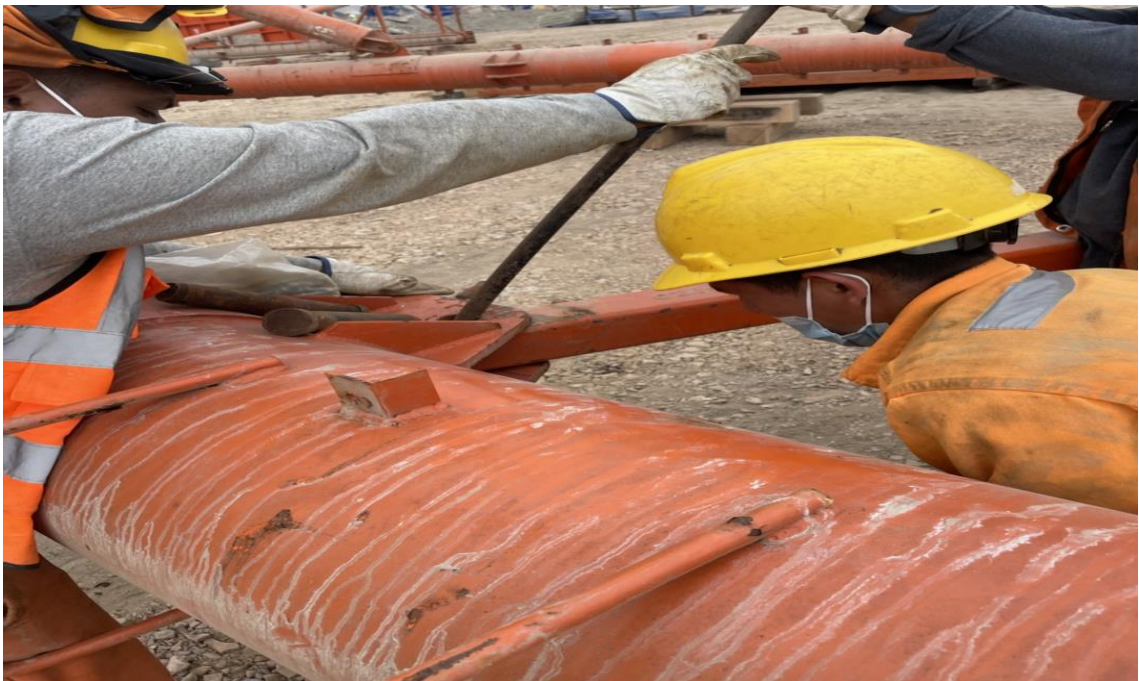
Figura 210. Incorporación del pasador de la barra de dirección.
