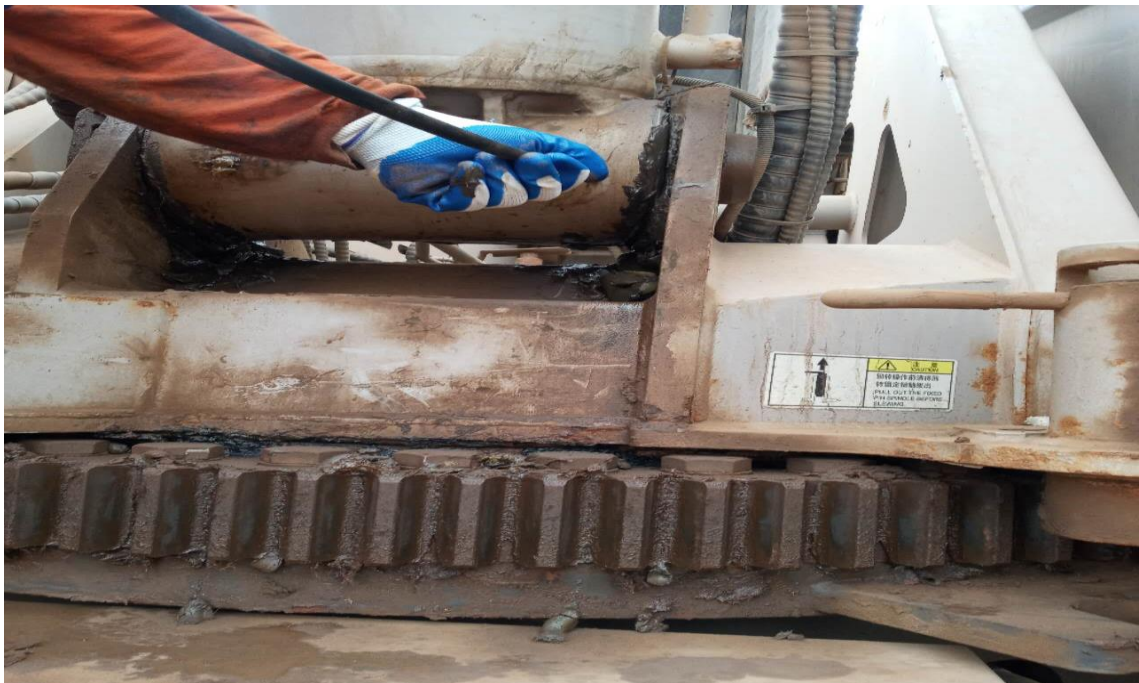
Figura 376. Aplicación de grasa al cuerpo y boom de la grúa 01.
