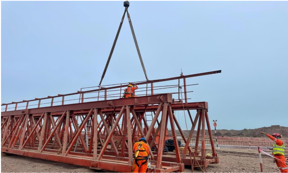
Figura 268. Instalación de la grúa y barandilla.
