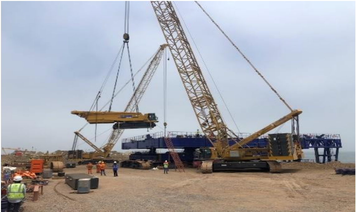
Figura 84. Cambios de puntos de elevación 2.
