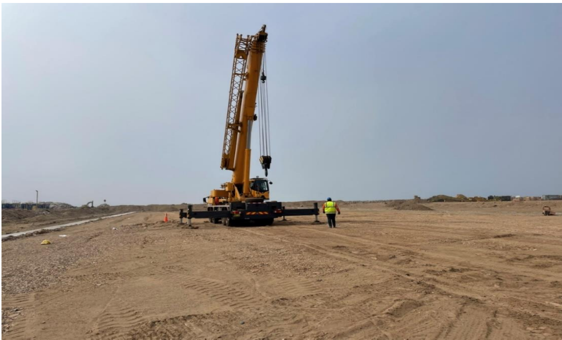
Figura 153. Uso de camión grúa de 50 t.
