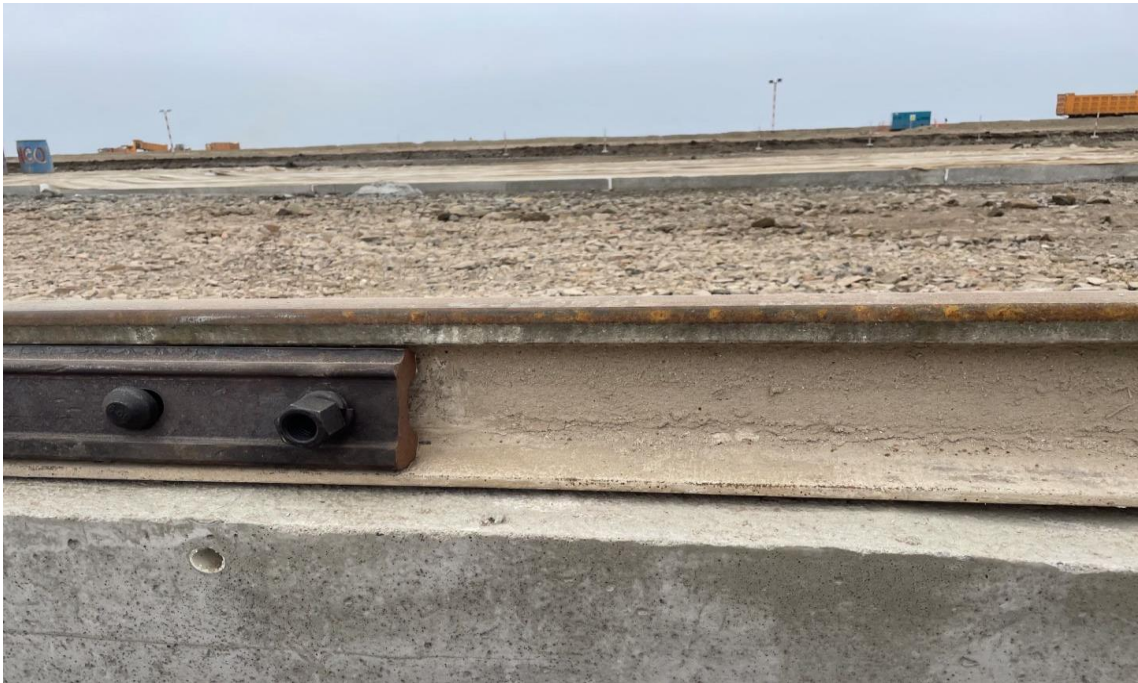
Figura 112. Instalación de eclipsa.
