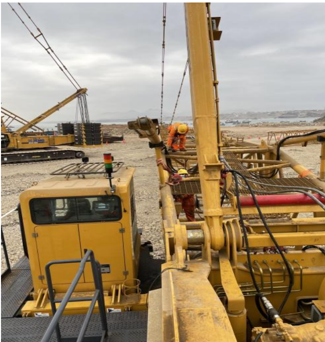
Figura 62. Instalación del anillo elástico anti-enganche 4.
