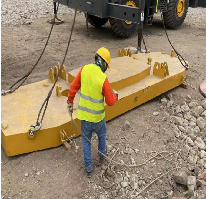
Figura 23. Instalación de contrapeso B
