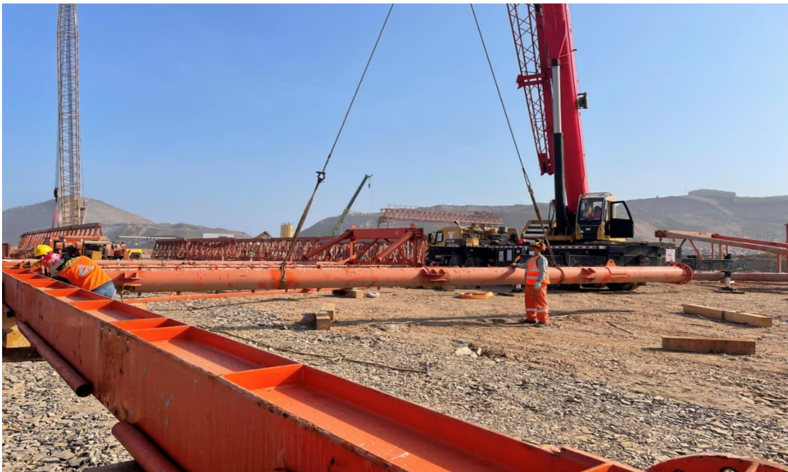
Figura 201. Instalación de los estabilizadores blandos.
