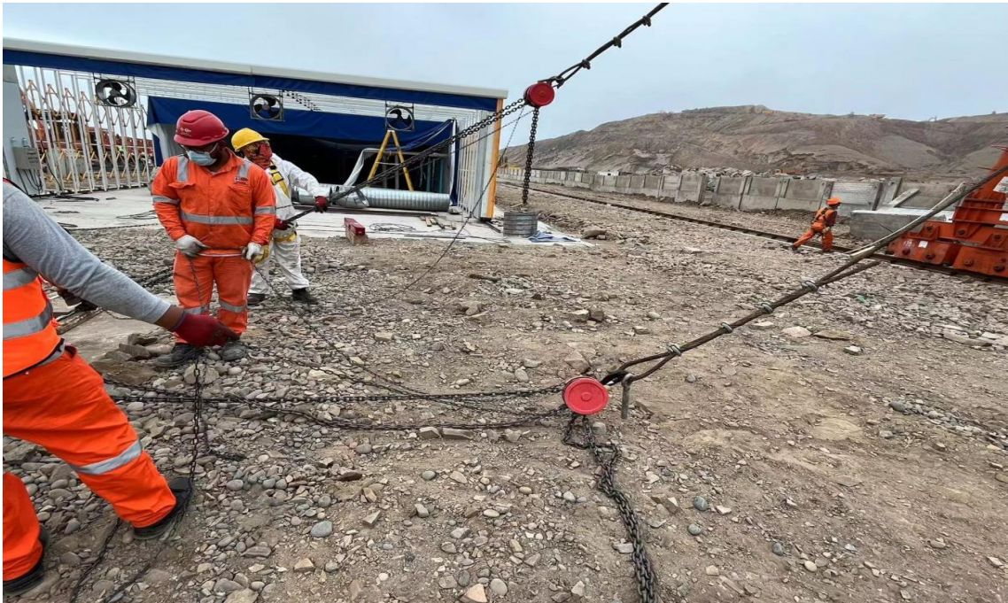
Figura 150. Área de montaje.
