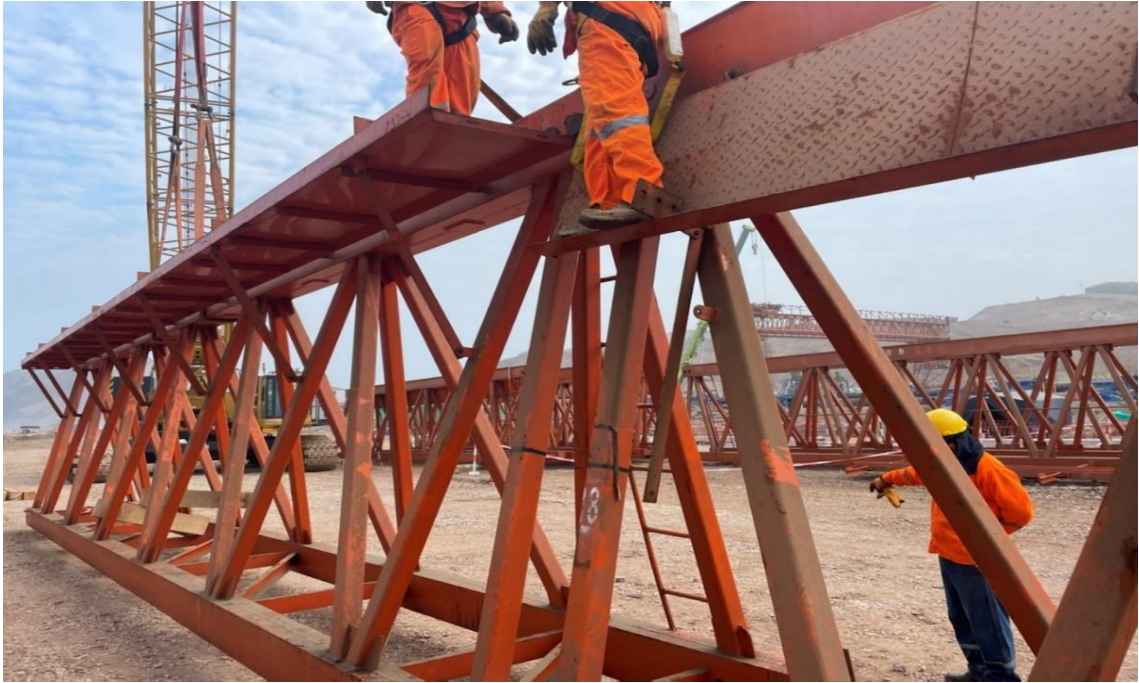
Figura 214. Instalación de la viga principal.
