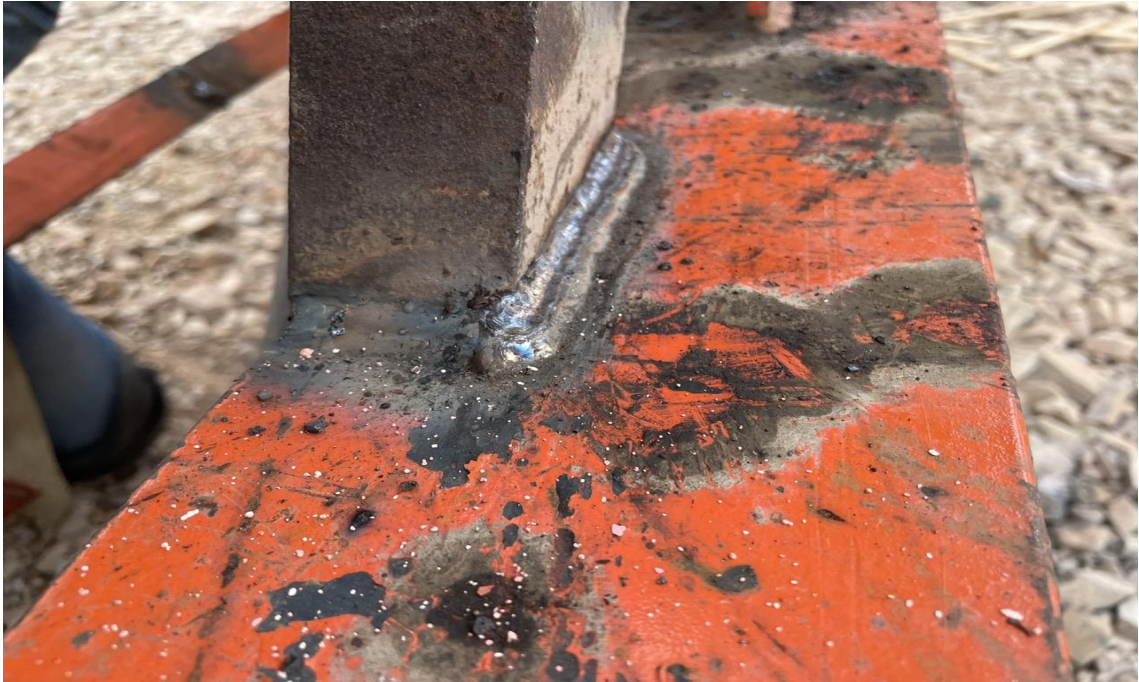
Figura 321. Soldadura de placa de tracción 02.
