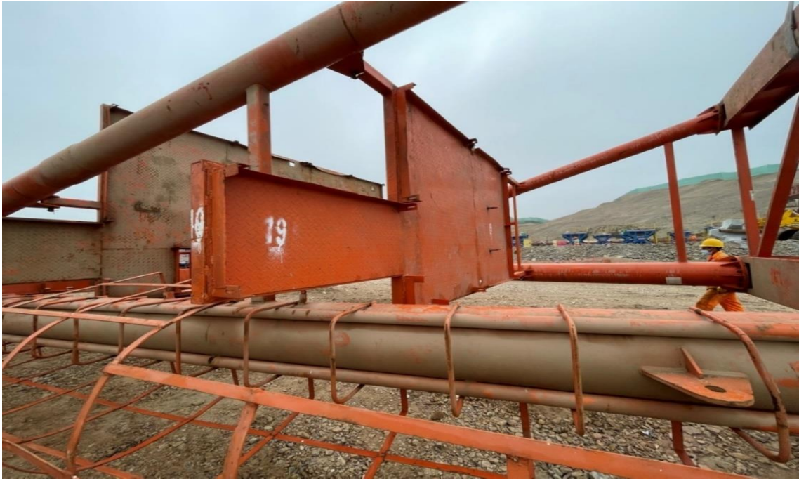
Figura 231. Instalación de la plataforma de mantenimiento del polipasto eléctrico.
