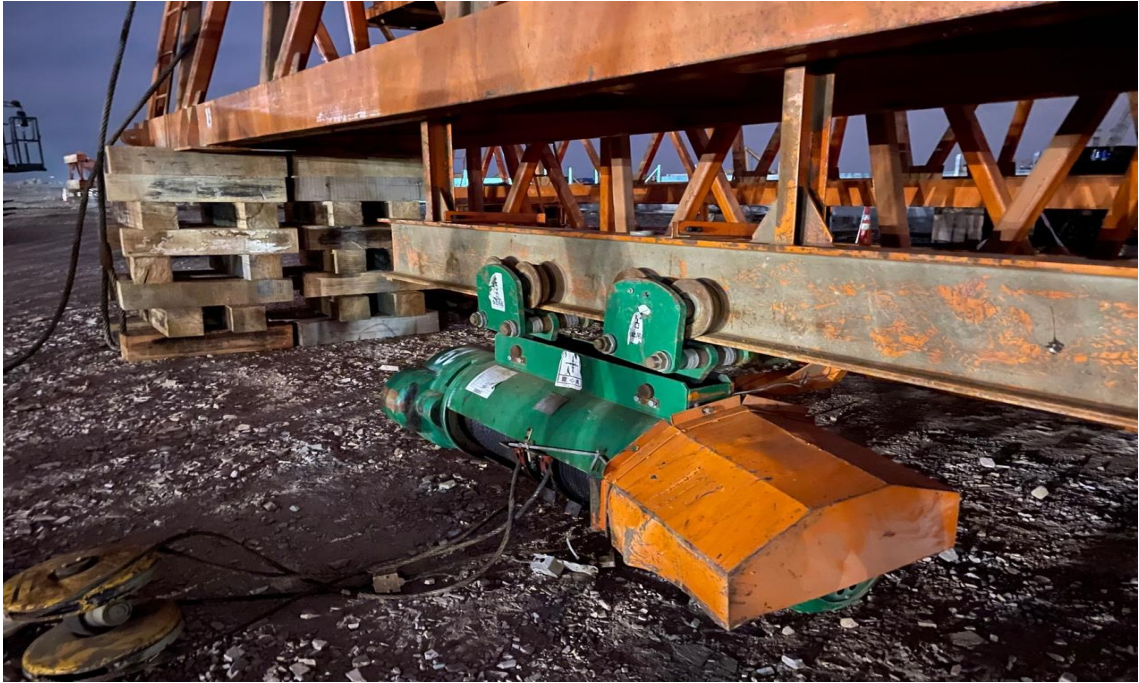
Figura 295. Montaje del polipasto eléctrico.
