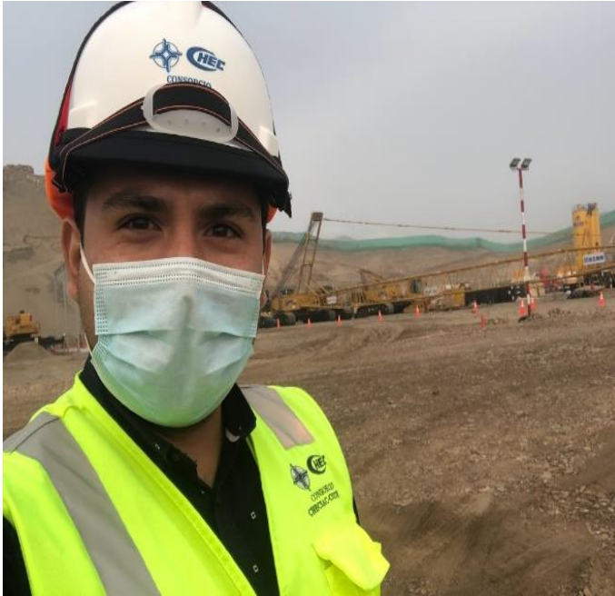
Figura 39. Instalación de la segunda grúa sobre orugas de 320 t C.
