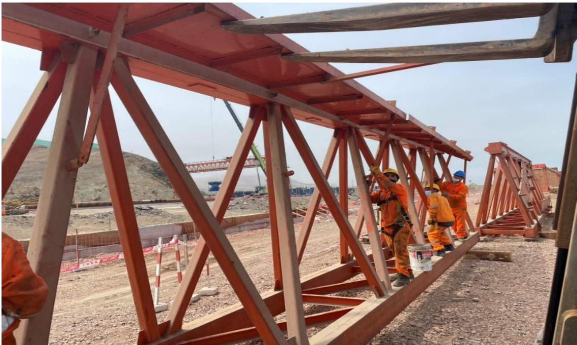
Figura 232. Corrección de la losa de la plataforma de la cuarta grúa pórtico.
