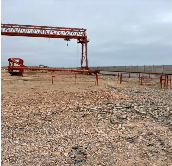
Figura 339. Instalación de barandas.
