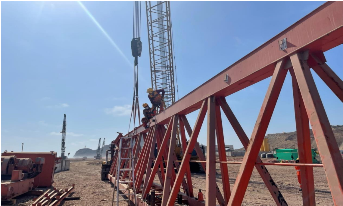
Figura 191. Instalación de la sección intermedia.
