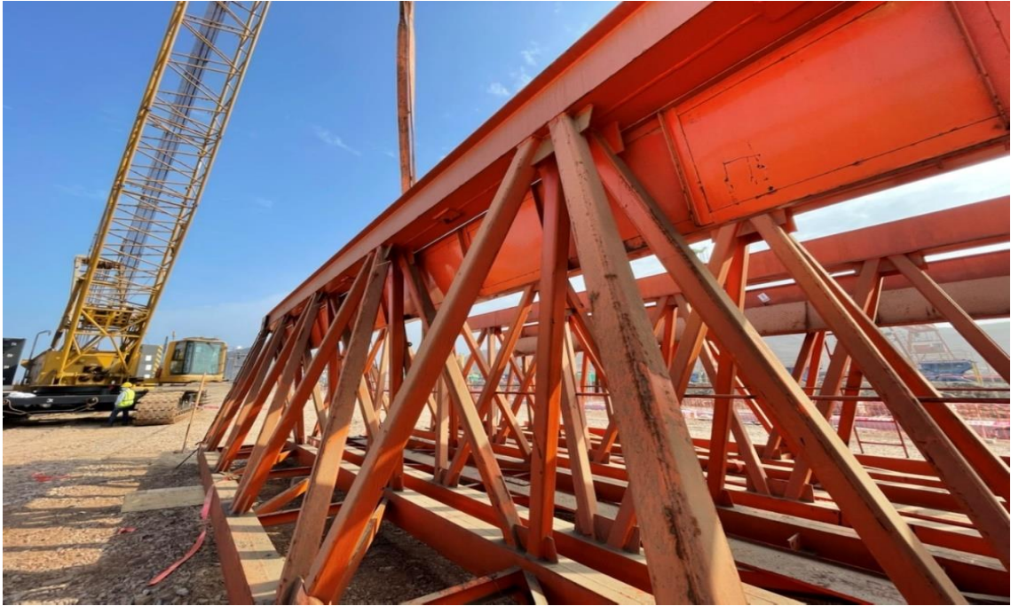
Figura 216. Instalación de la plataforma.
