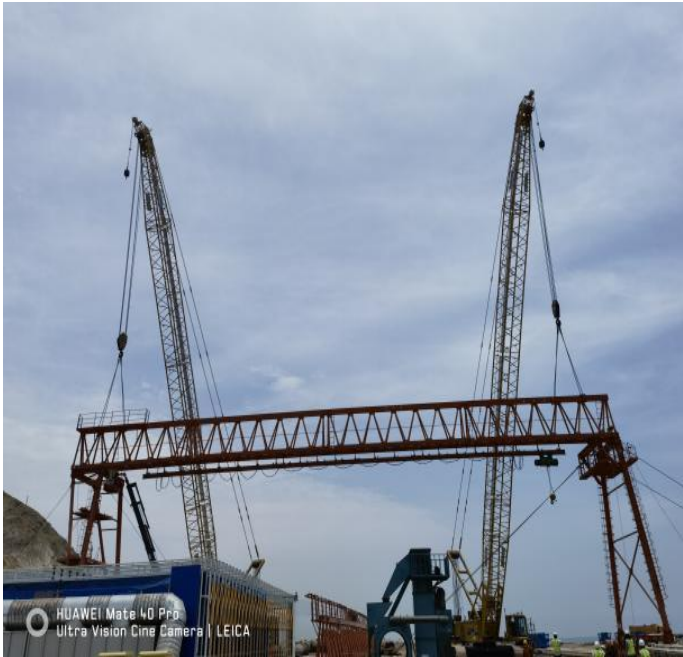
Figura 148. Elevación de viga principal 01.
