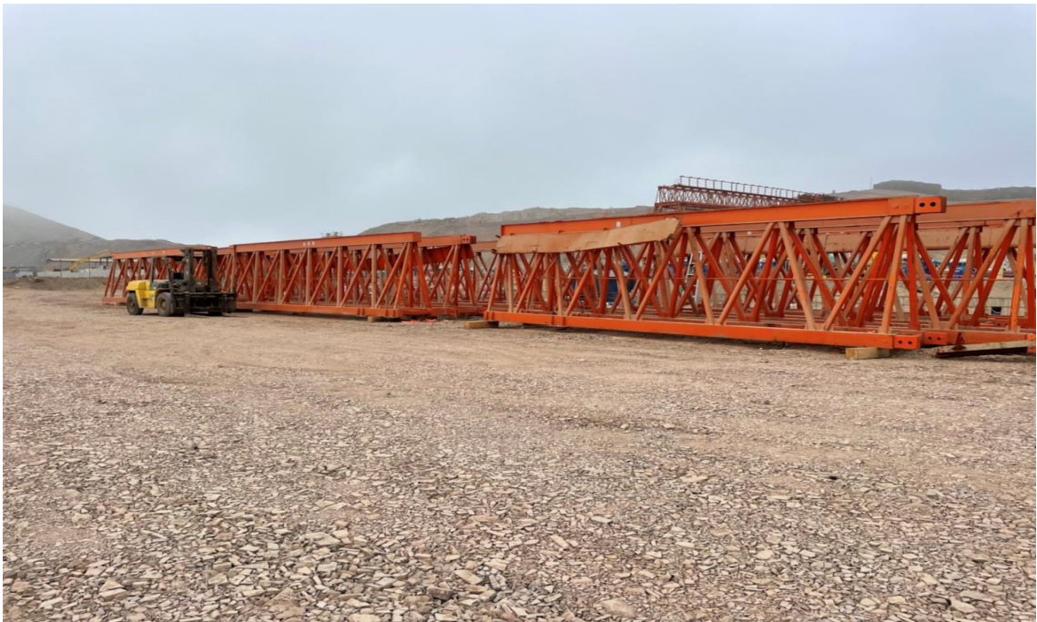
Figura 160. Traslado de vigas principales y otros equipos 02.
