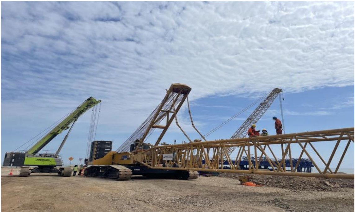
Figura 77. Grúa de 400 Tn 2.
