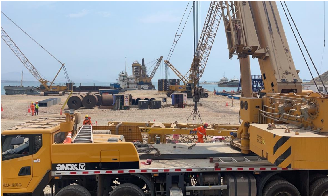
Figura 52. Instalación de la segunda Grúa sobre orugas de 400t 2.
