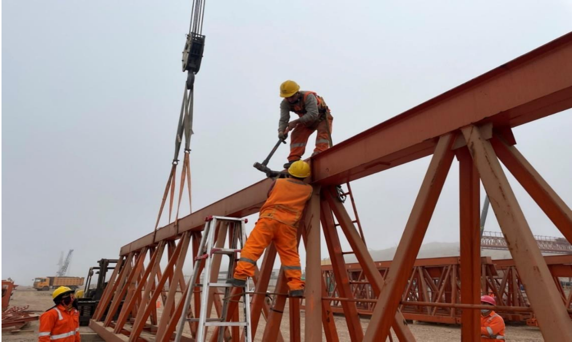
Figura 190. Instalación de la viga no conductora.
