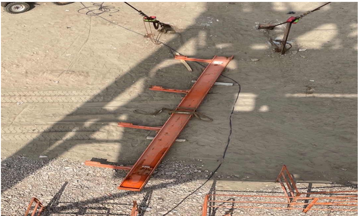
Figura 319. Instalación de vía de polipasto eléctrico.
