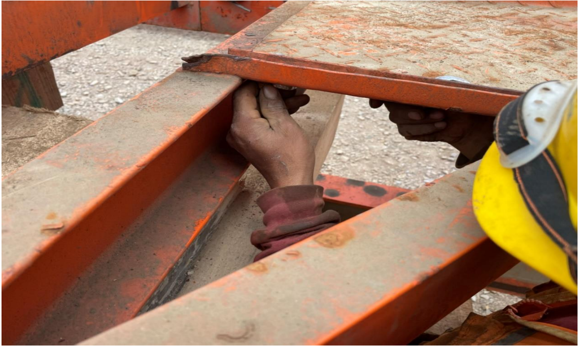
Figura 257. Instalación de la placa de la plataforma.
