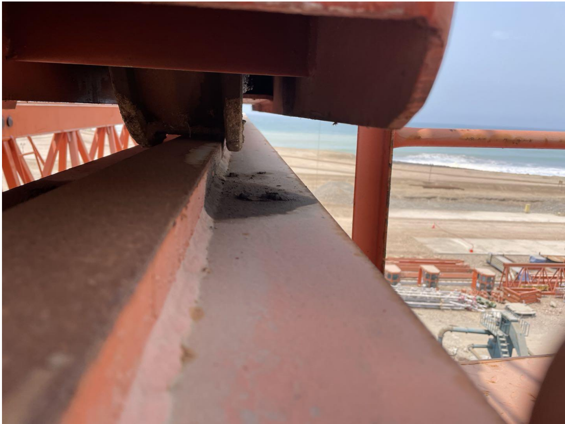
Figura 135. Instalación de grúa.
