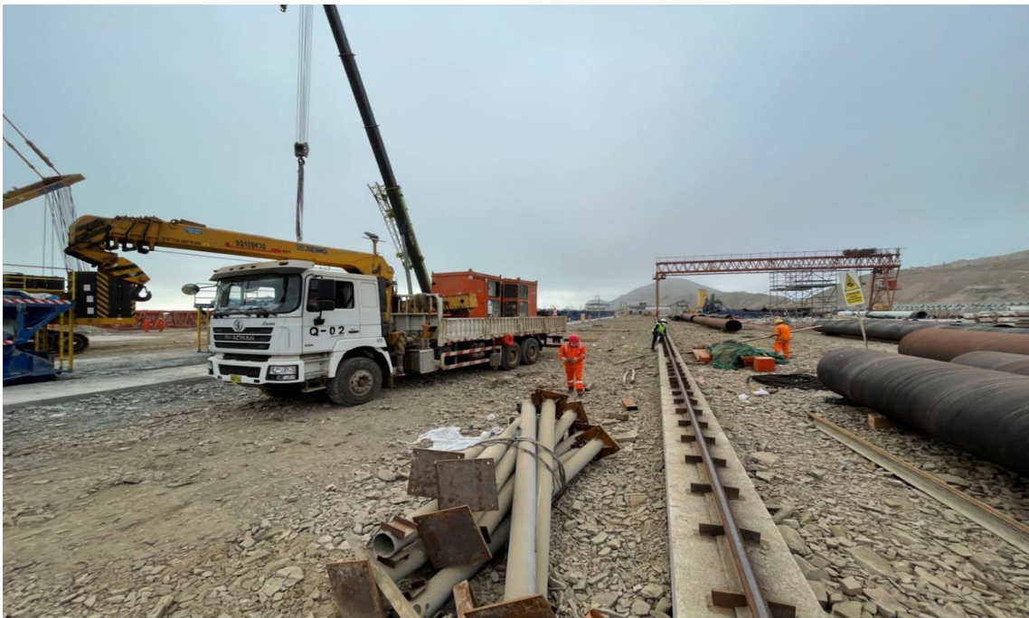
Figura 155. Uso de camión grúa de 10 t (Q-02).
