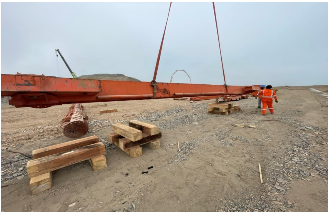
Figura 163. Viga de equilibrio y estabilizadores 02.
