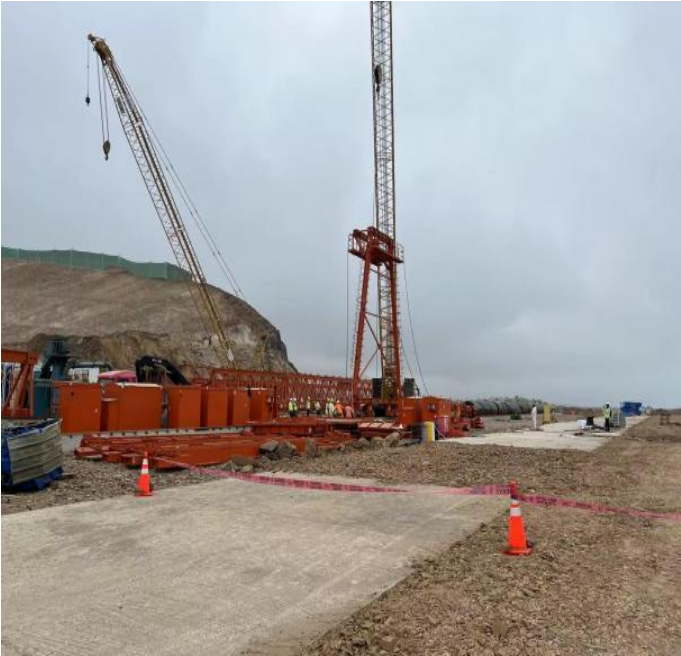
Figura 145. Elevación de estabilizadores 02.
