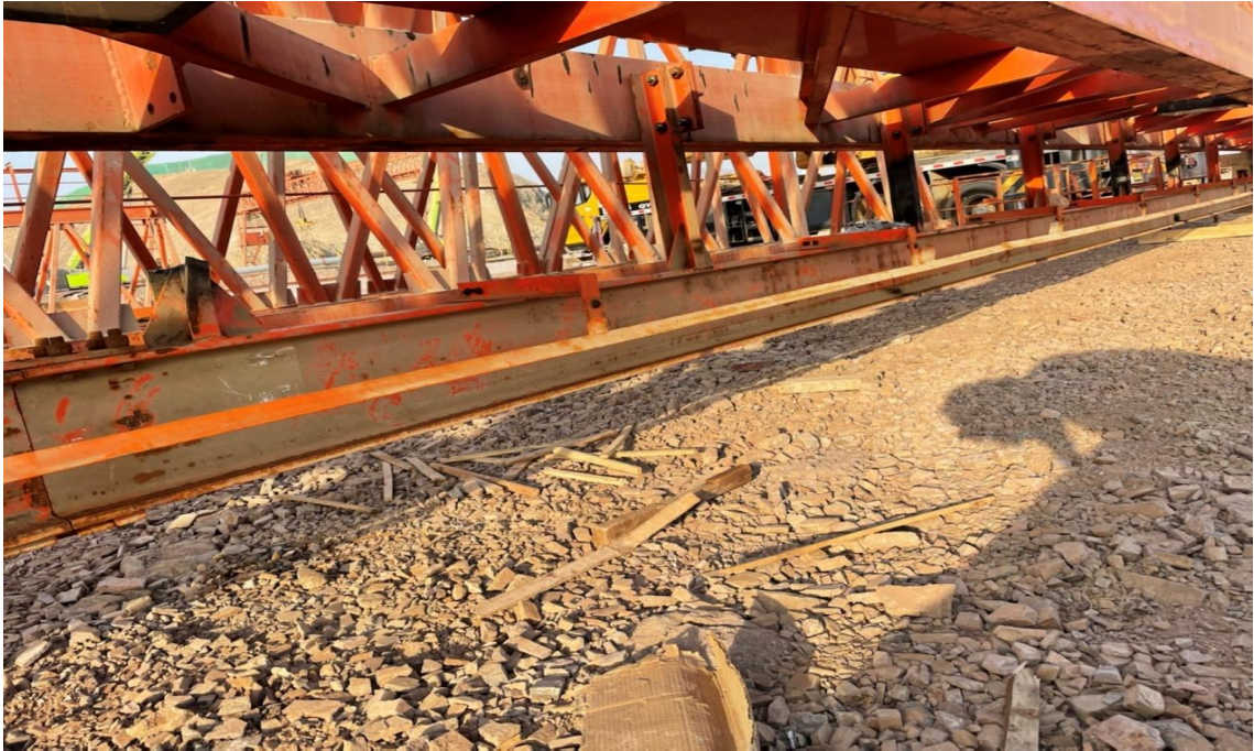
Figura 281. Instalación de la pista del polipasto eléctrico.
