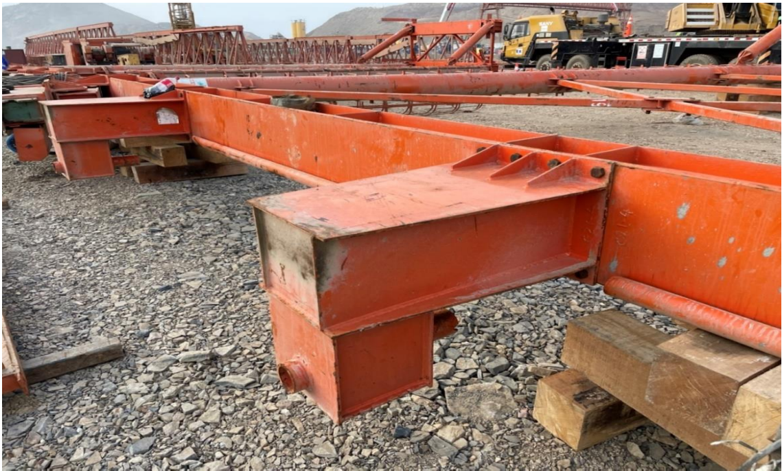
Figura 220. Instalación de anclajes.
