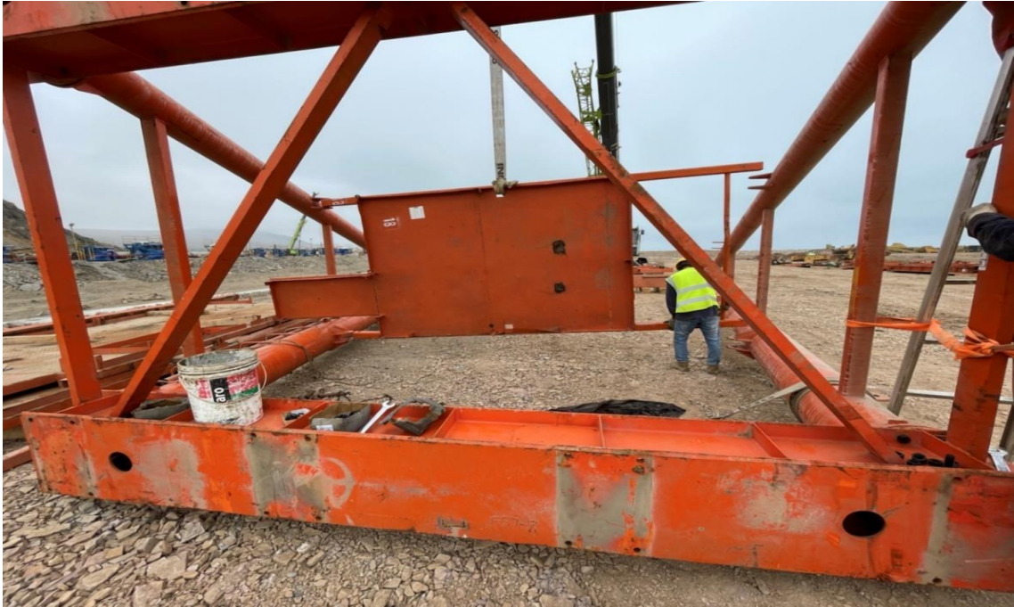
Figura 178. Instalación de la plataforma de mantenimiento de polipastos eléctricos.
