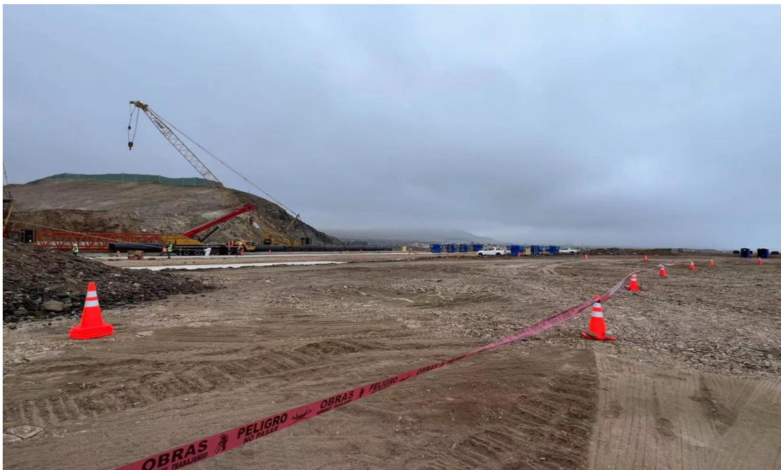
Figura 142. Estado de construcción del proceso de izaje principal.
