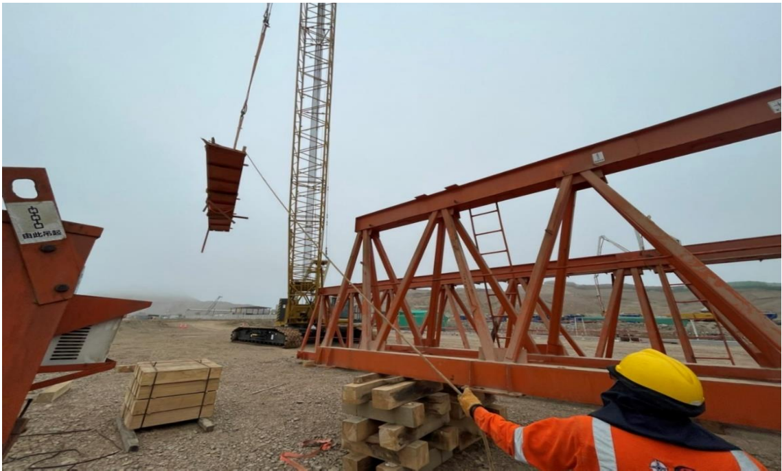
Figura 227. Instalación de la plataforma de la grúa.
