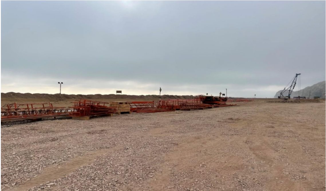
Figura 159. Traslado de vigas principales y otros equipos 01.
