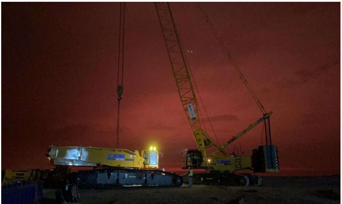
Figura 41. Instalación de grúas sobre orugas de 400 t B.
