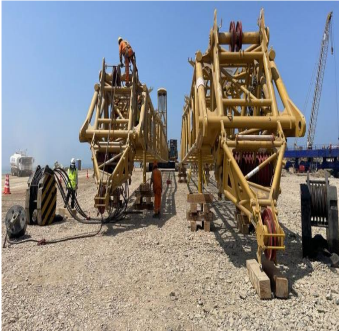
Figura 80. Grúa de 400 Tn 4.
