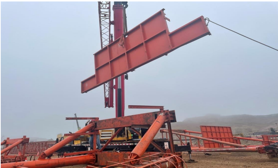
Figura 229. Plataforma de la viga principal.
