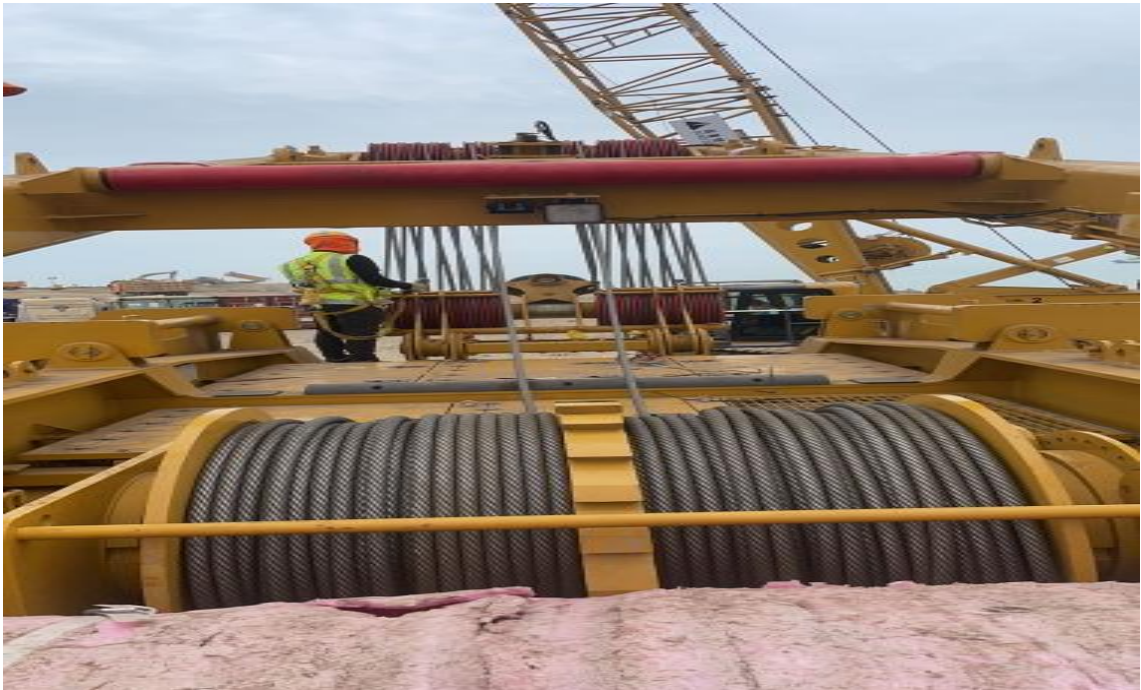
Figura 45. Instalación de grúas sobre orugas de 400 t 4.
