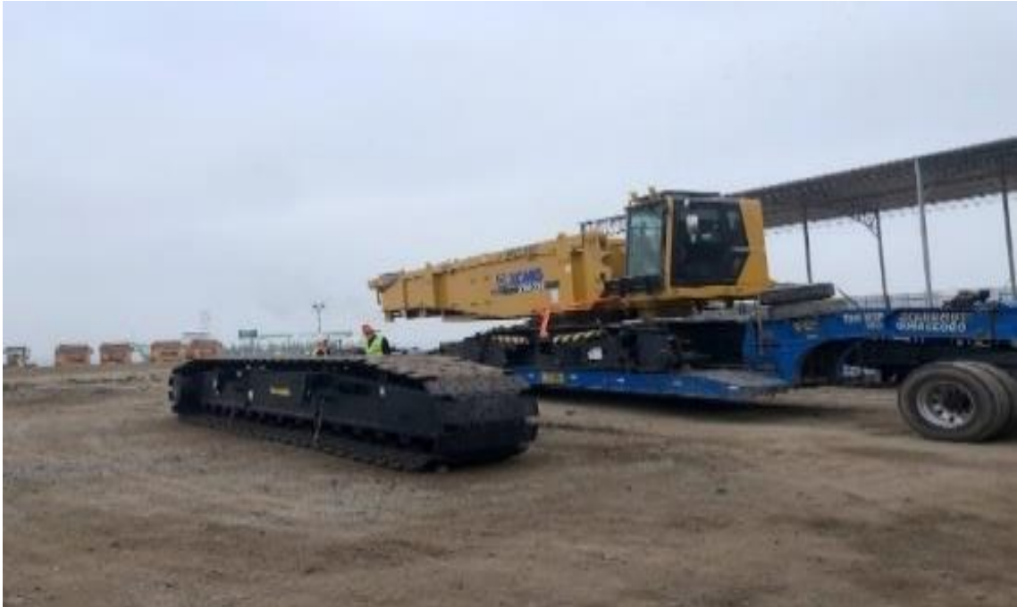
Figura 35. Instalación de la primera grúa sobre orugas de 320 t 4.
