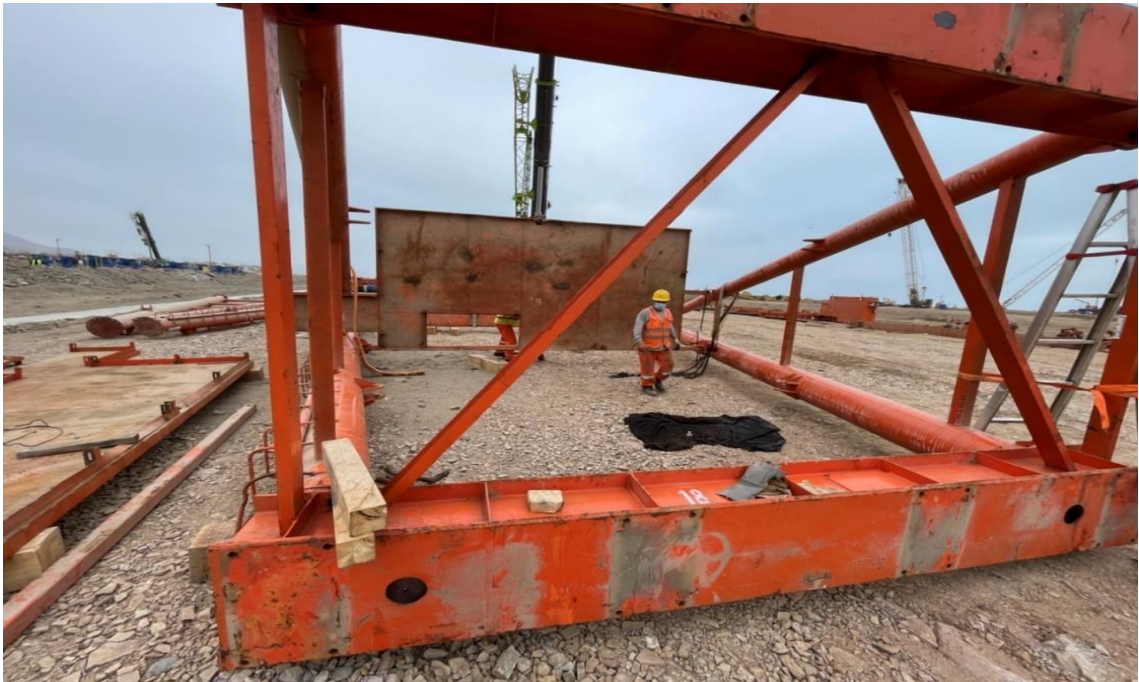
Figura 180. Instalación de la plataforma operativa.
