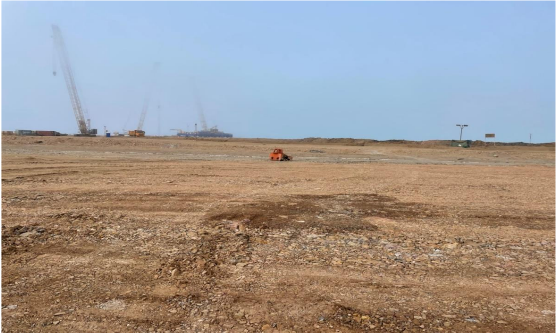
Figura 156. Estado del sitio 01.
