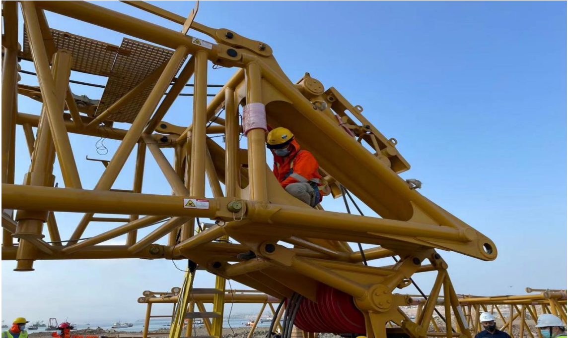
Figura 27. Instalación de los brazos.
