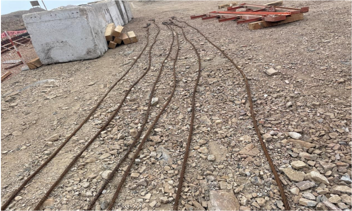
Figura 266. Cable de viento.
