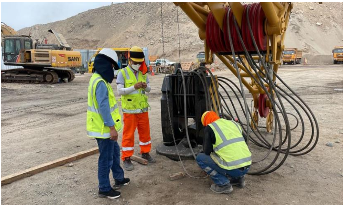
Figura 38. Instalación de la segunda grúa sobre orugas de 320 t B.
