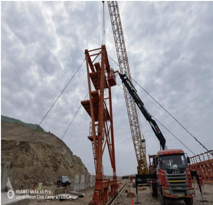
Figura 147. Elevación de estabilizadores 04.
