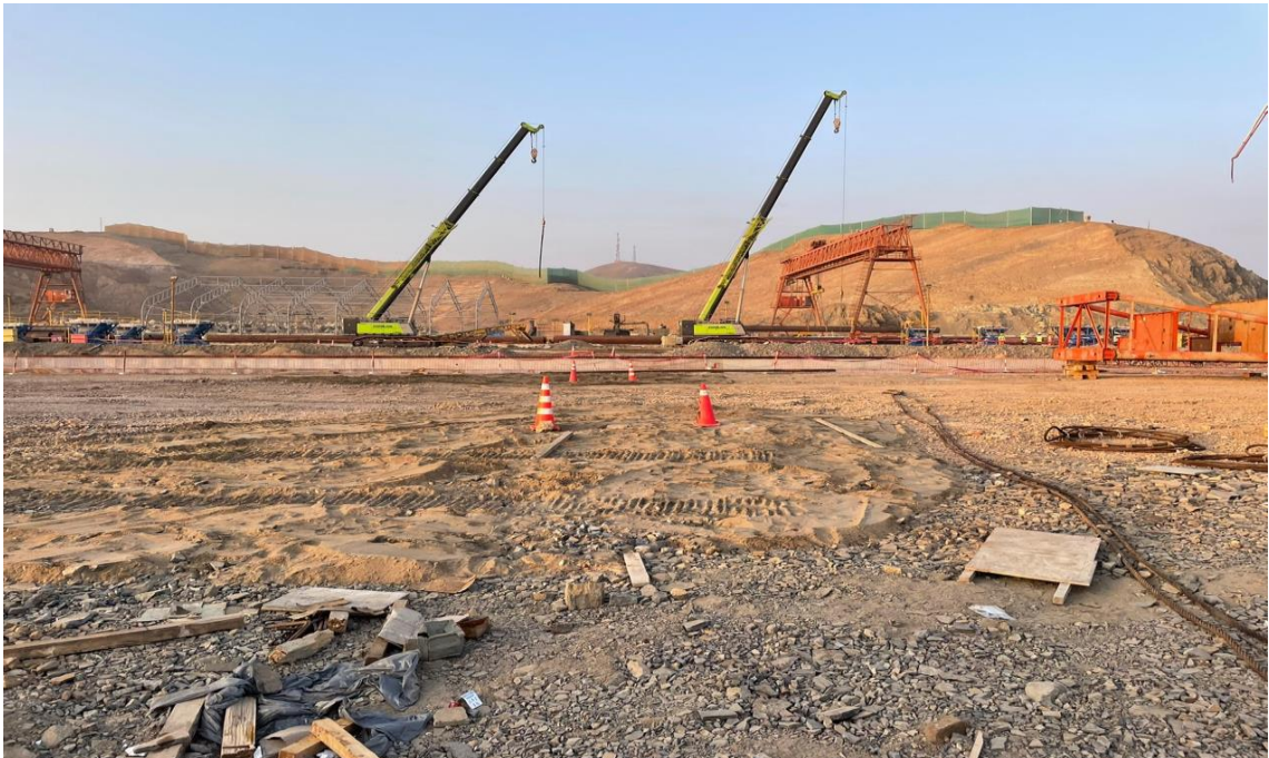
Figura 287. Entierro y señalización de bloques.
