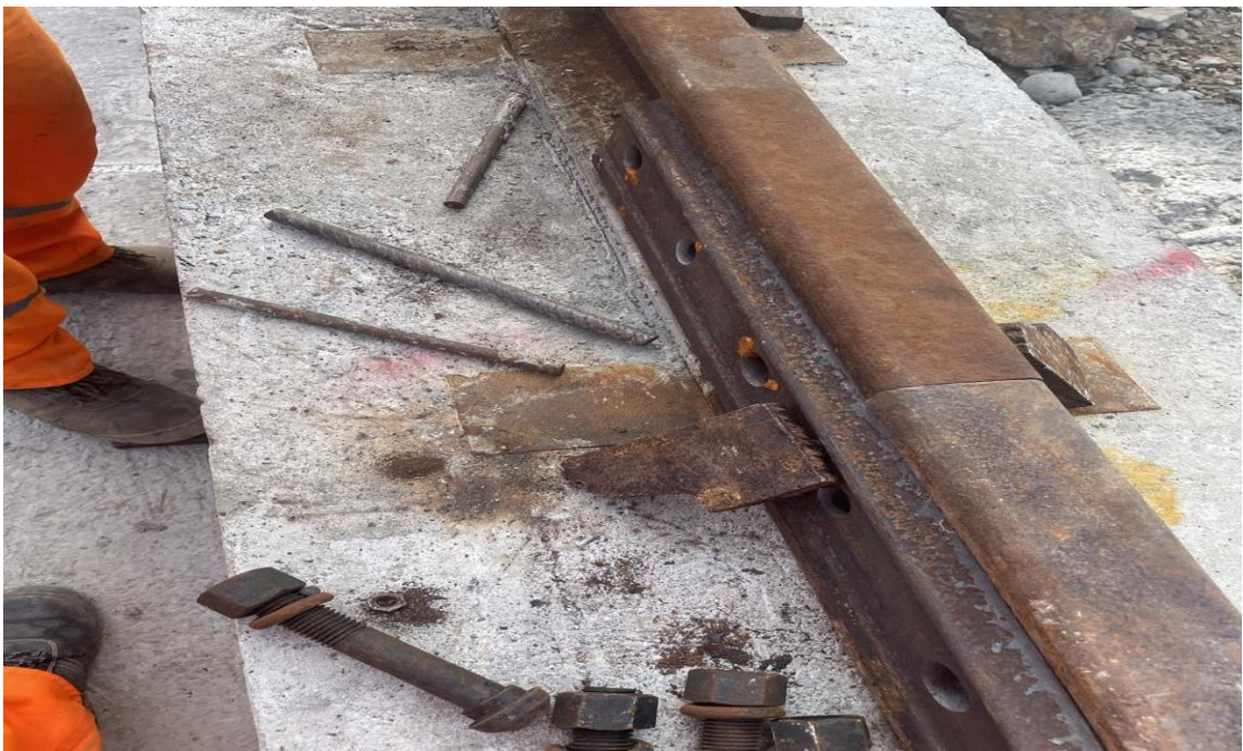
Figura 325. Instalación de pernos en rieles.
