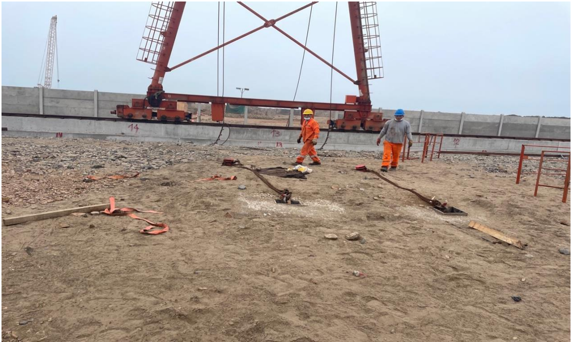
Figura 324. Cable de viento.
