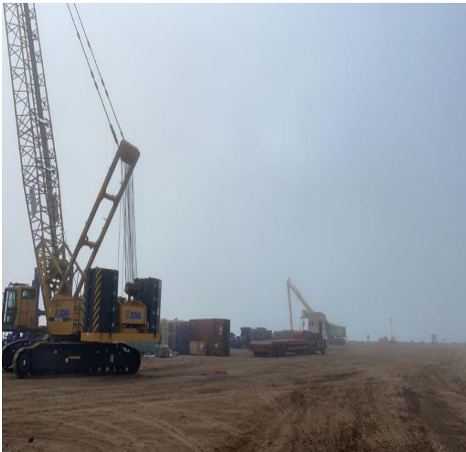
Figura 66. Desmontaje, transporte e instalación de la grúa celosía de 150 t 3.
