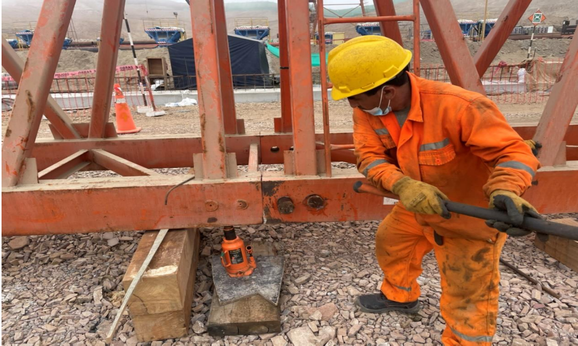
Figura 247. Uso de carretilla elevadora y gata hidráulica.
