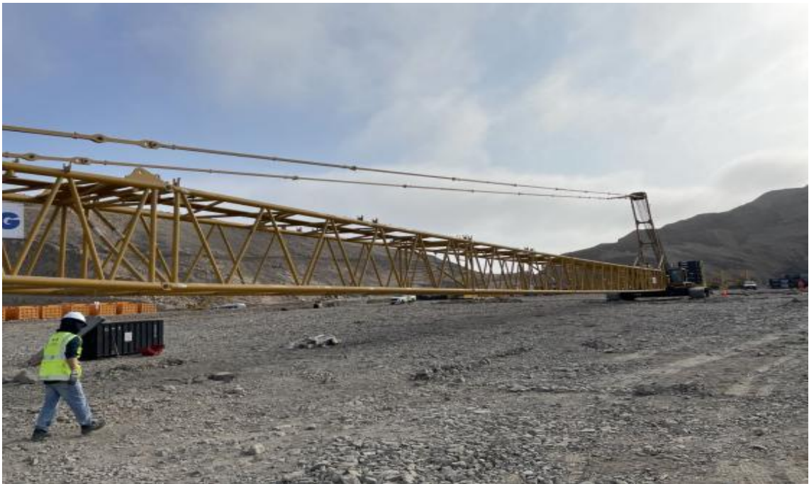
Figura 32. Instalación de la primera grúa sobre orugas de 320 t 2.
