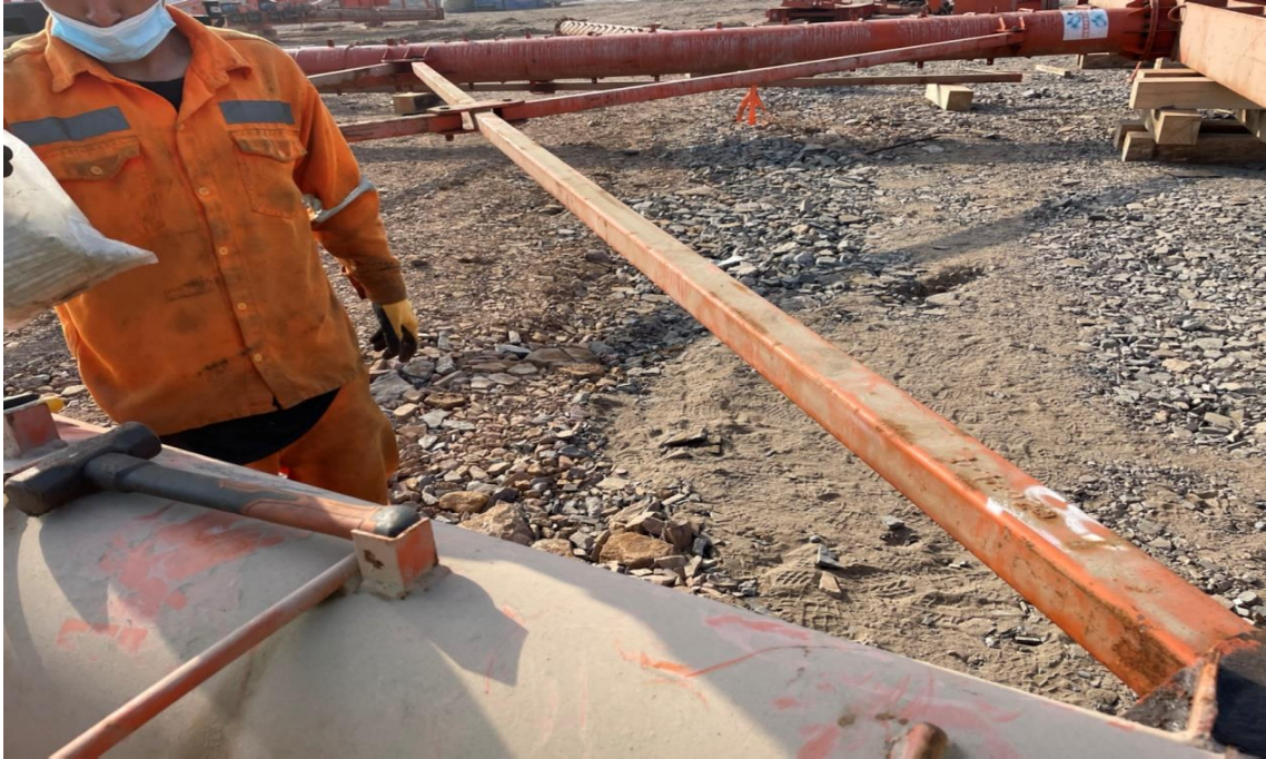
Figura 200. Instalación de los estabilizadores flexibles.
