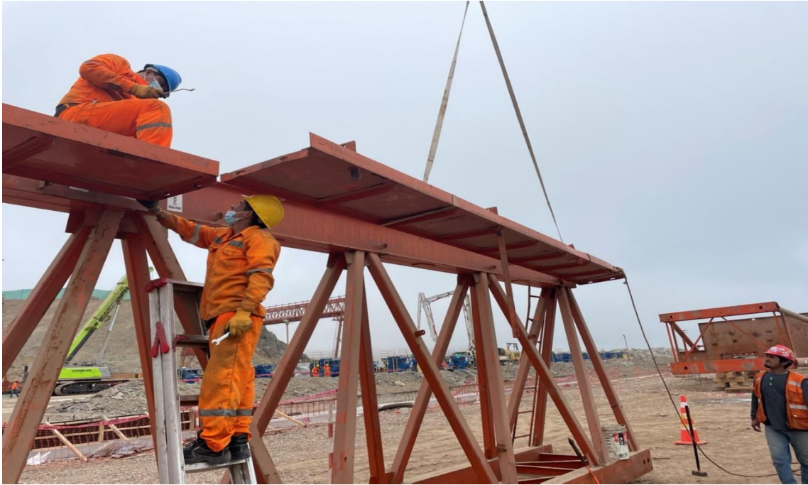
Figura 242. Instalación de tableros de tarima.
