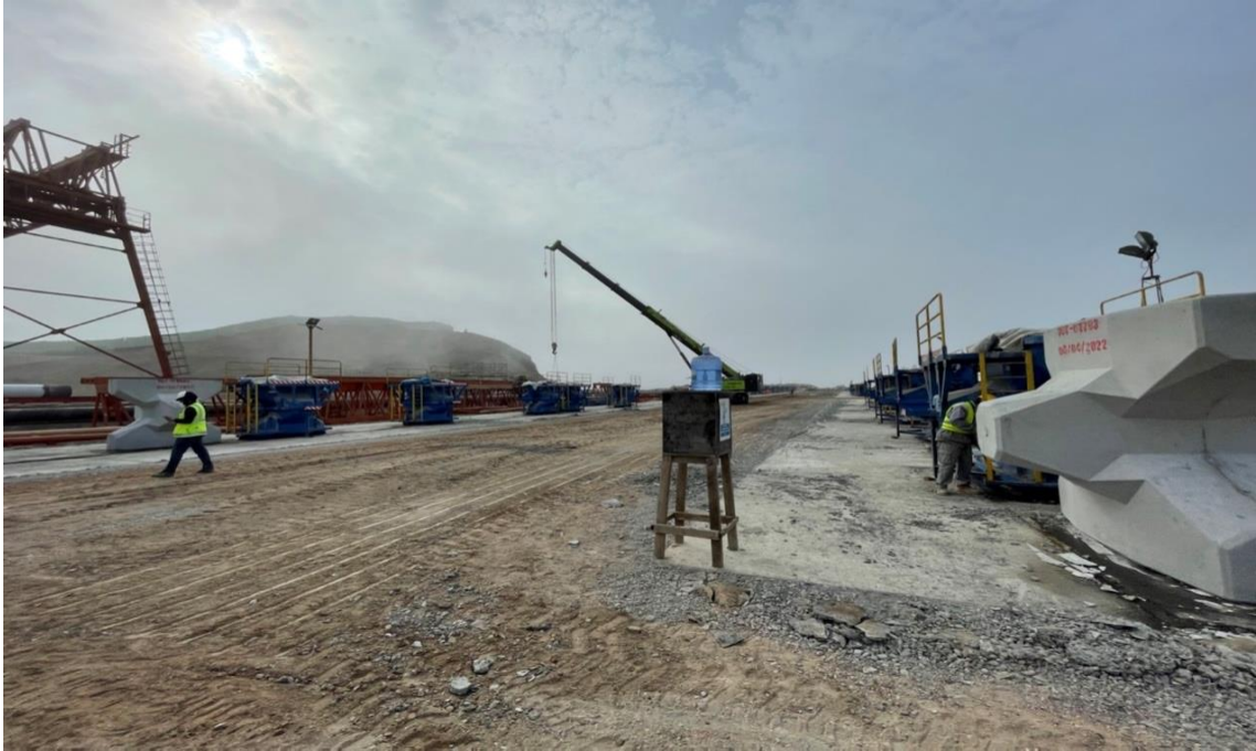
Figura 151. Uso de grúa de 60 t con brazo telescópico.
