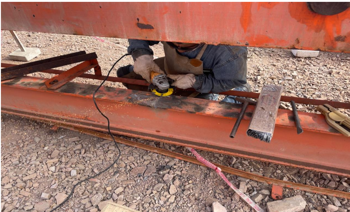
Figura 327. Soldadura de placas 02.
