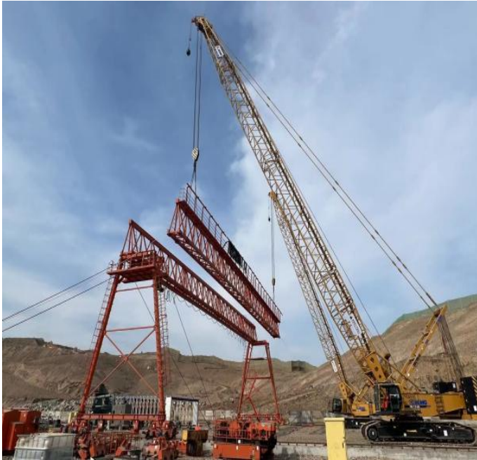
Figura 149. Elevación de viga principal 02.
