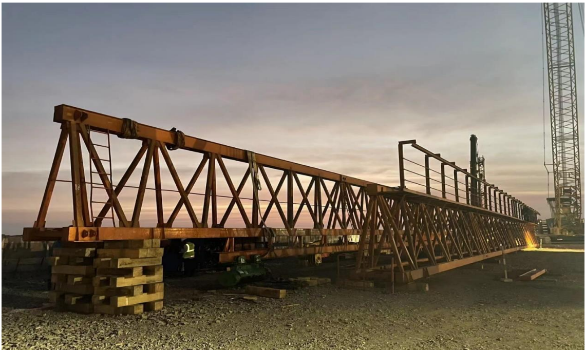
Figura 347. Instalación de polipasto eléctrico.
