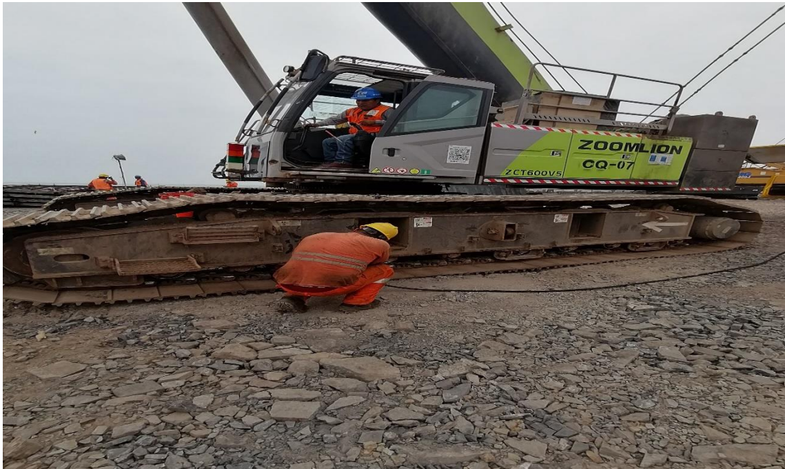
Figura 381. Corte con oxígeno de partes dañadas de la cadena.
