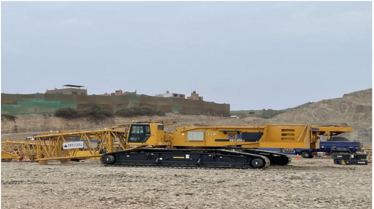
Figura 53. Instalación de la segunda Grúa sobre orugas de 400t 3.
