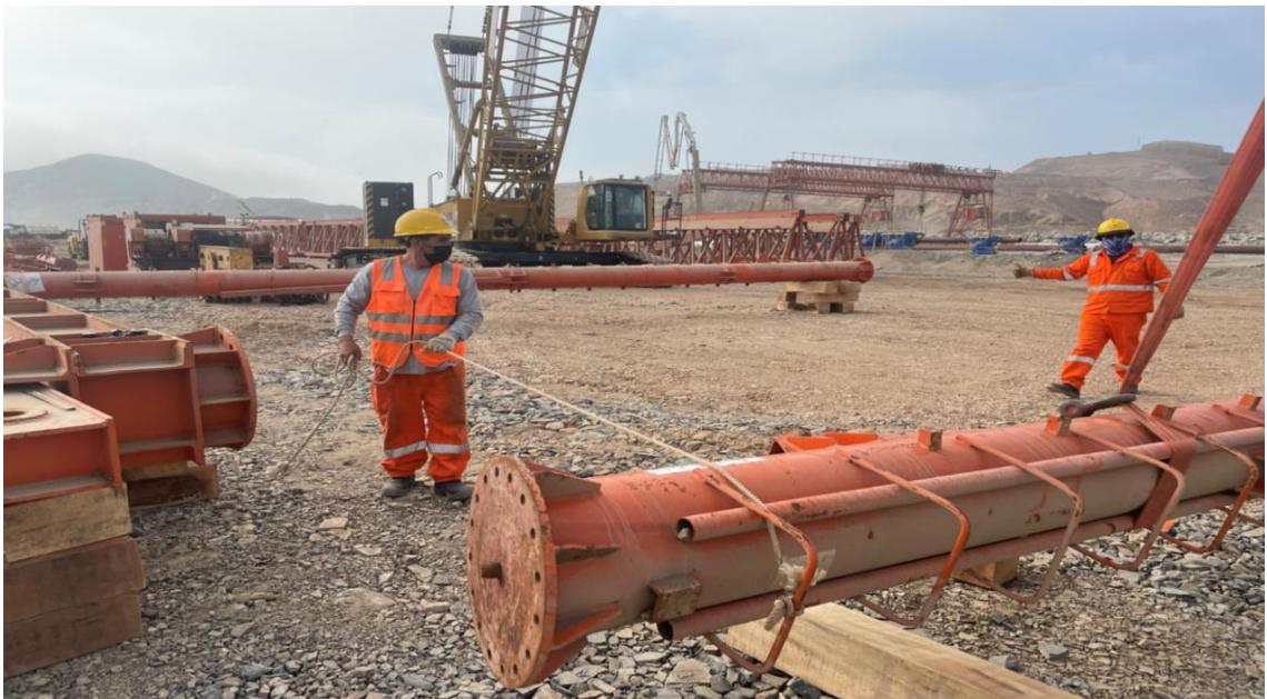
Figura 165. Estabilizadores conectados a vigas igualadoras.
