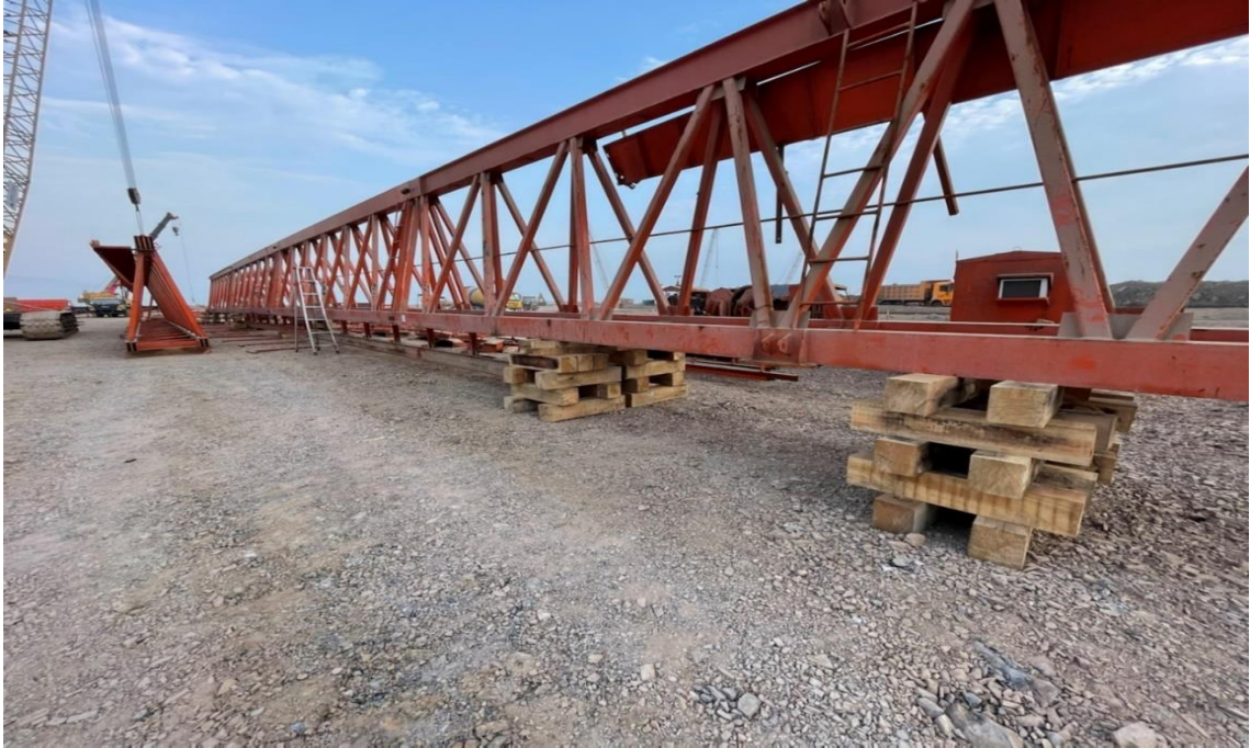
Figura 223. Durmientes en la viga principal.
