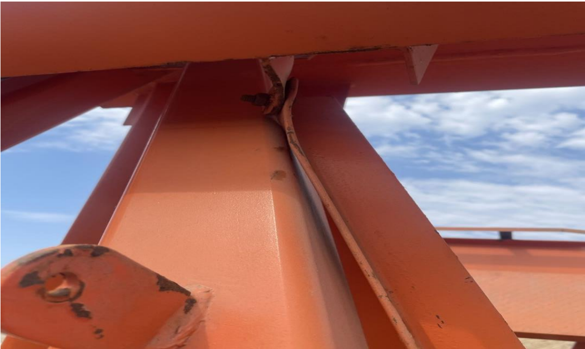
Figura 123. Proceso de ensamble de las patas plegables flexibles 02.
