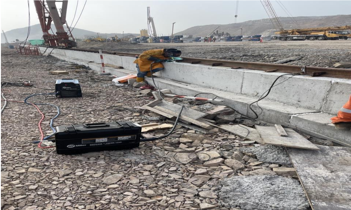
Figura 326. Soldadura de placas 01.
