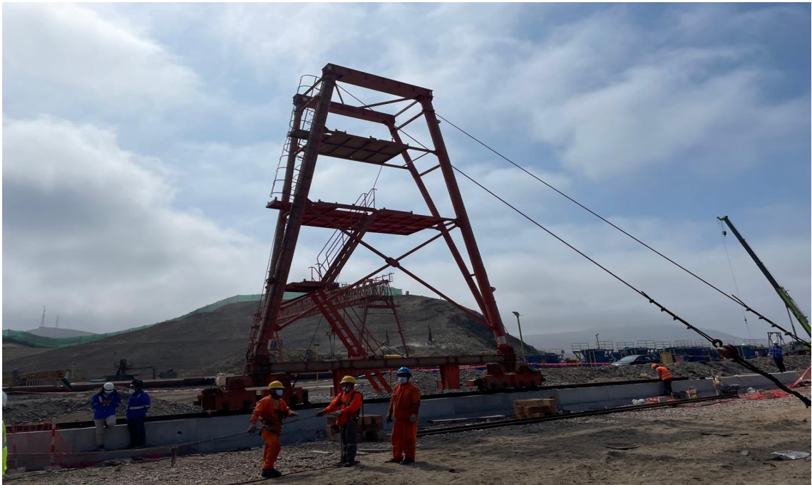
Figura 301. Montaje de estabilizador rígido.
