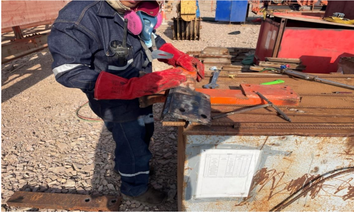
Figura 315. Fabricación de la placa de tracción.
