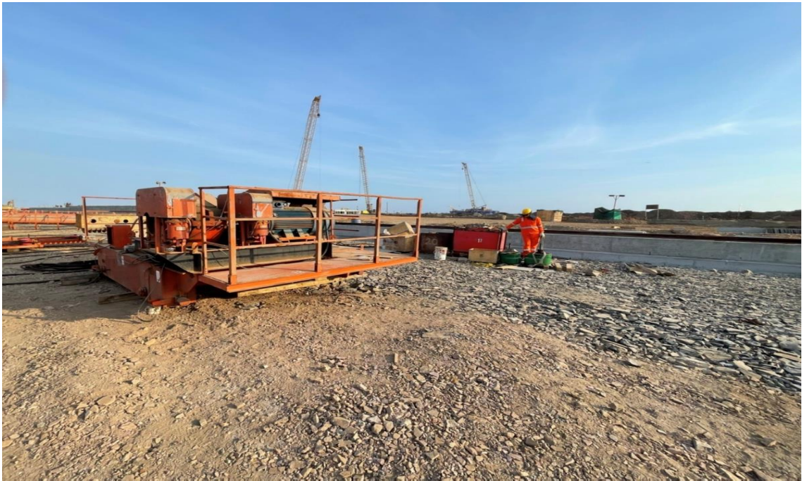
Figura 278. Instalación de la plataforma de la grúa y la barandilla.
