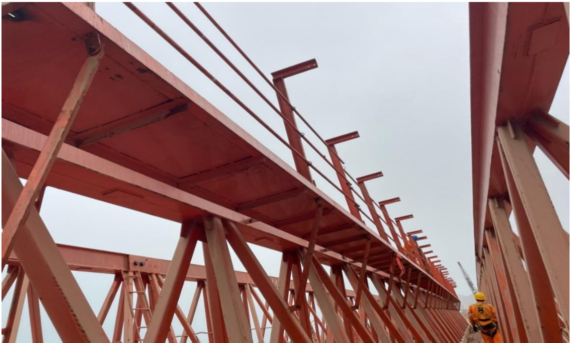
Figura 246. Instalación de barandillas de seguridad.
