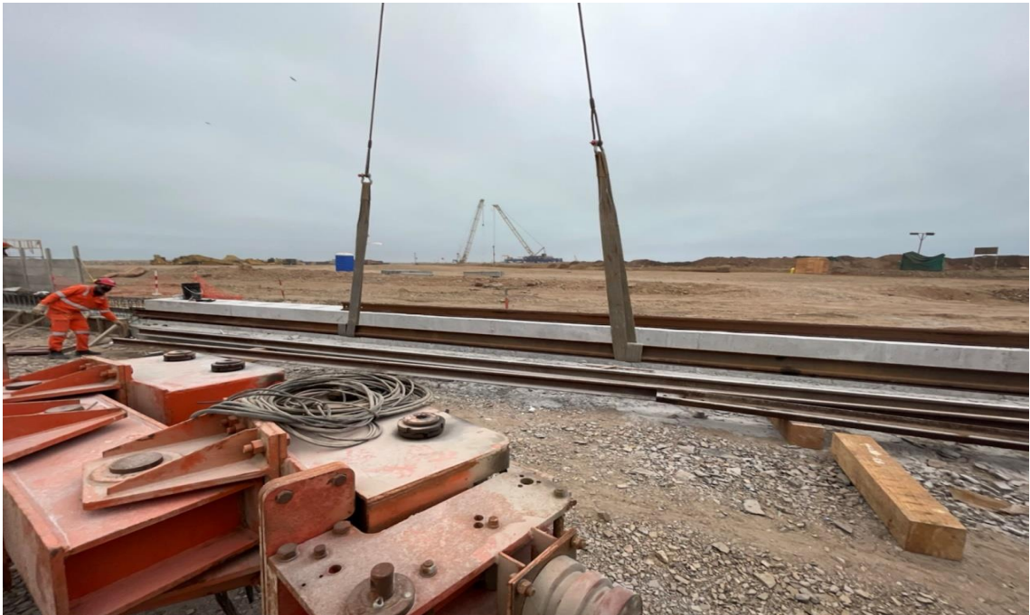
Figura 258. Elevación de vía completada.
