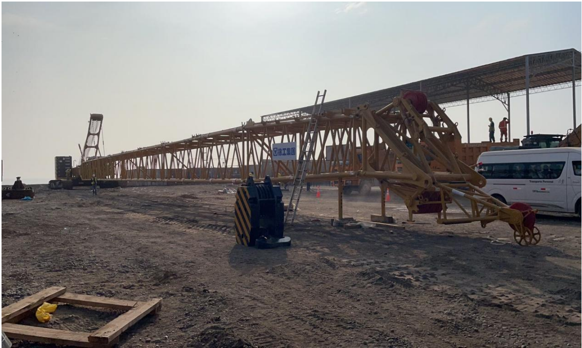
Figura 37. Instalación de la segunda grúa sobre orugas de 320 t A.
