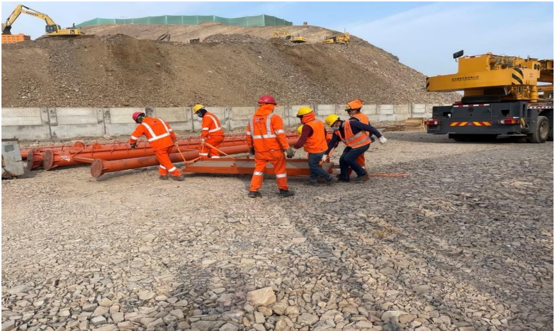
Figura 130. Traslado de partes estructurales de la viga principal.
