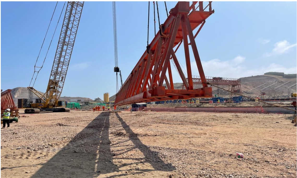
Figura 303. Izado de la primera viga principal 01.
