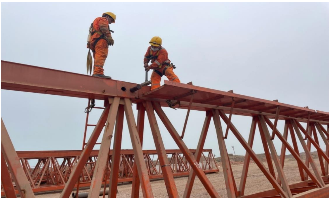
Figura 244. Aseguramiento con pasadores.
