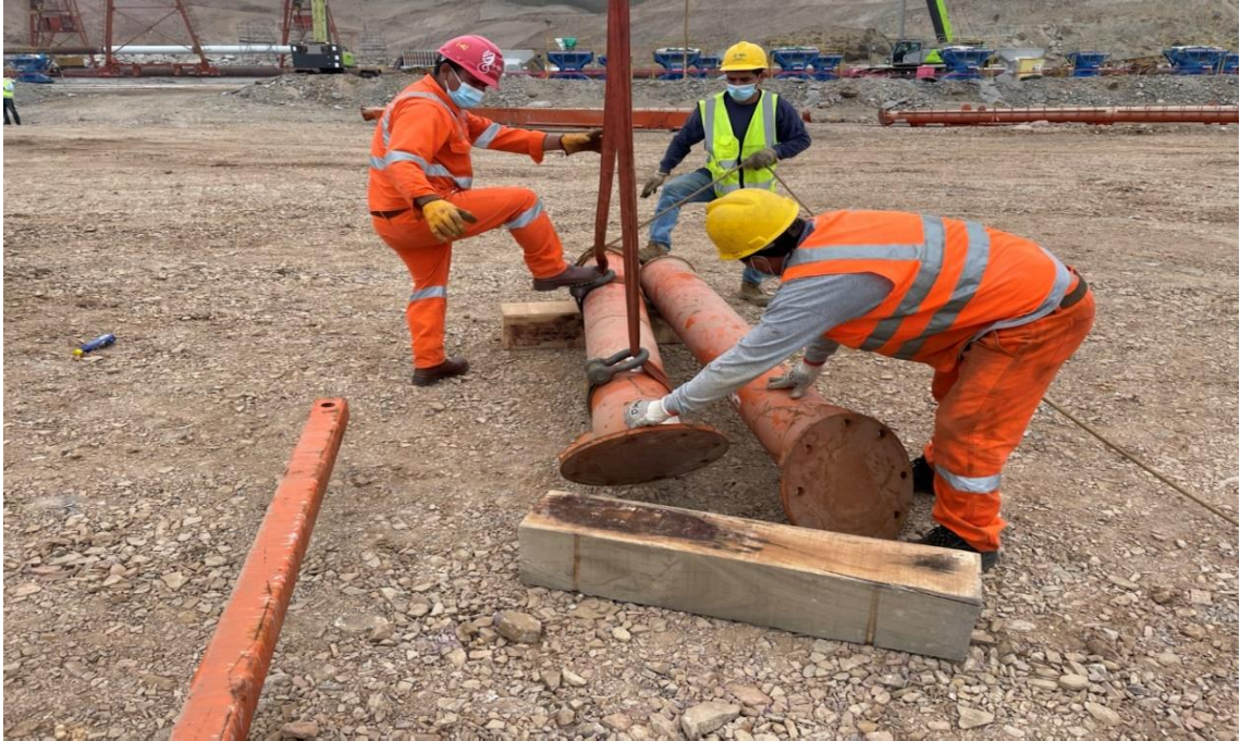
Figura 170. Instalación del soporte de esquina 01.
