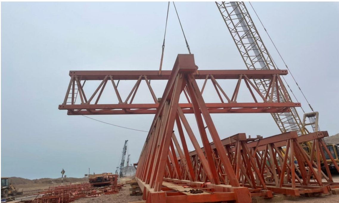
Figura 237. Izamiento de la viga principal.
