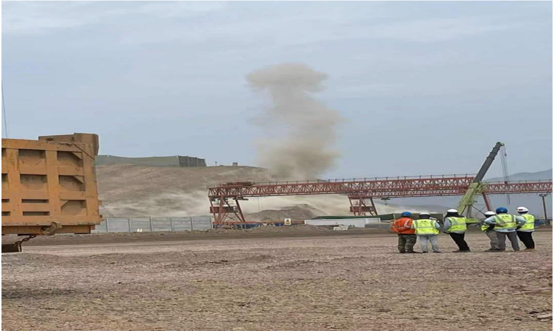
Figura 126. Voladuras en campo.
