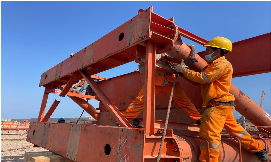
Figura 296. Cable de viento colgante 01.
