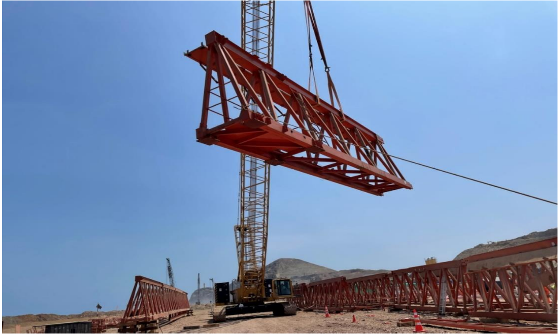
Figura 207. Izaje del cuerpo de la grúa.
