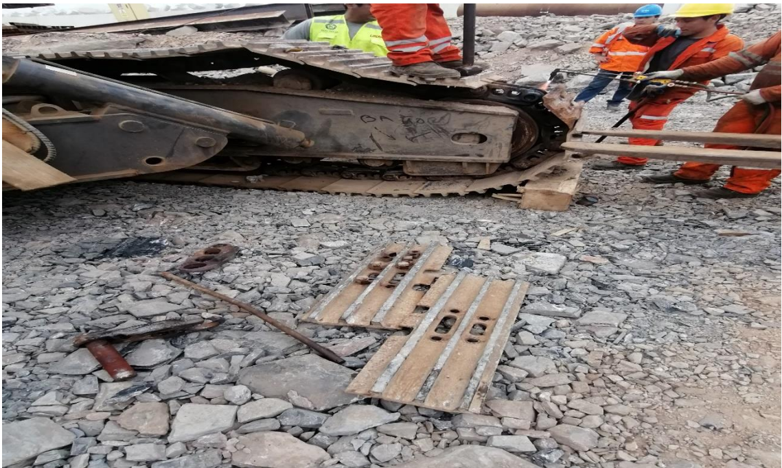
Figura 380. Ruptura de cadena de grúa sobre orugas.
