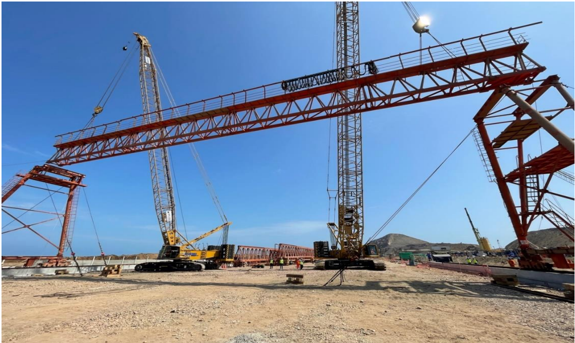
Figura 304. Izado de la primera viga principal 02.
