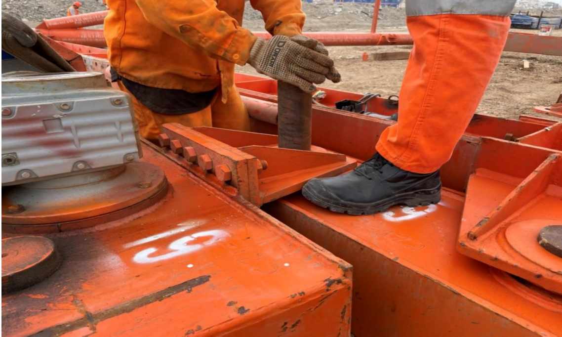
Figura 186. Instalación del mecanismo de desplazamiento 01.
