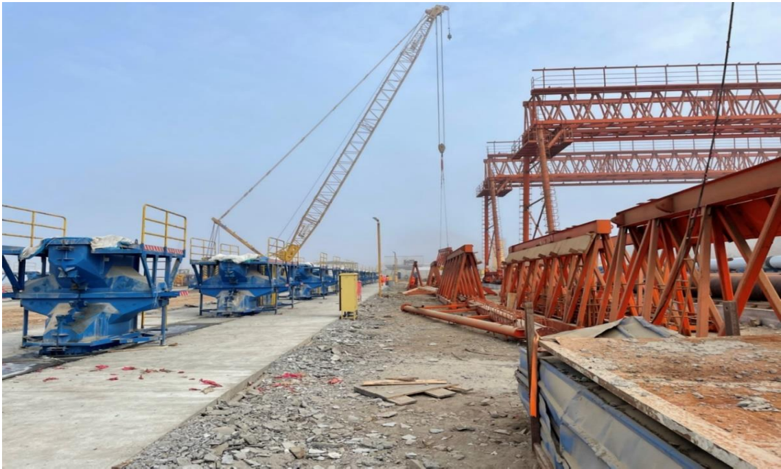
Figura 152. Uso de grúa sobre orugas de 150 t.
