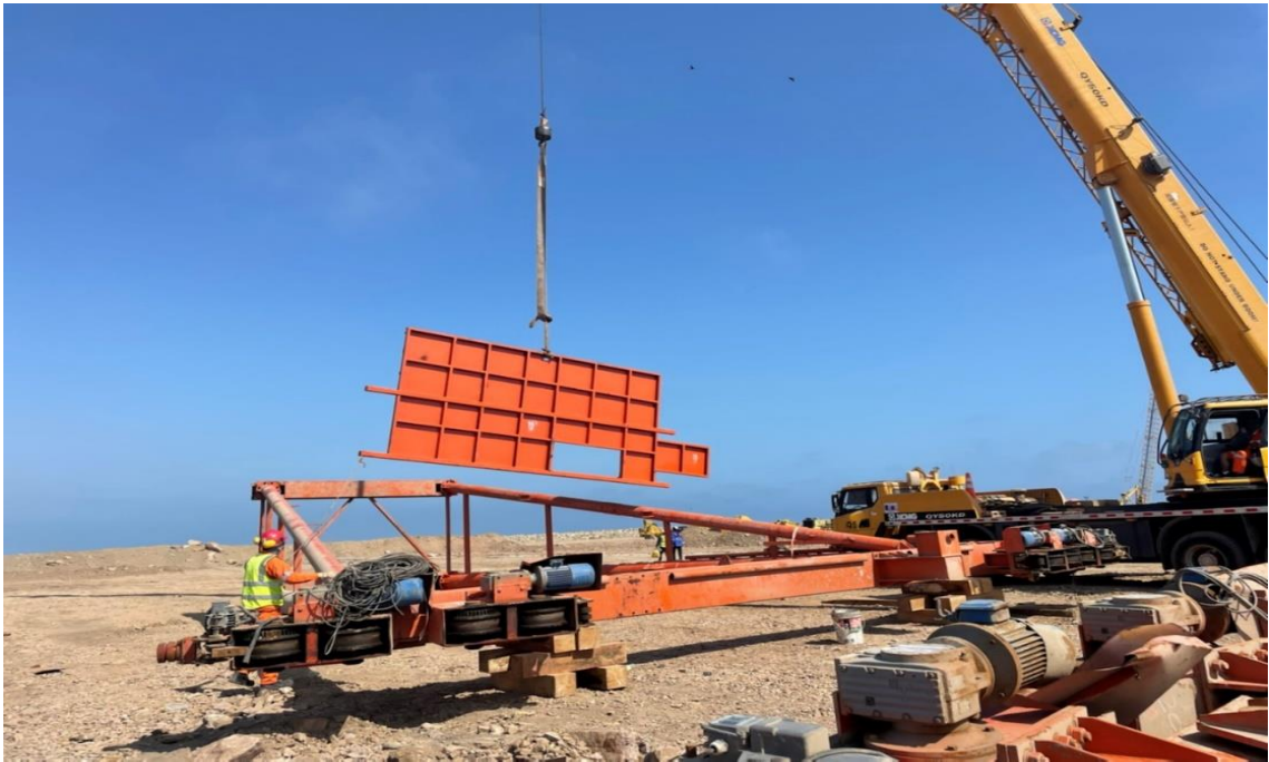
Figura 188. Instalación de la plataforma operativa.
