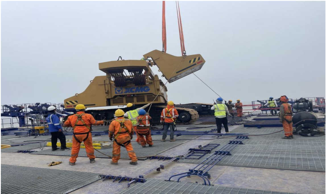
Figura 89. Estación de la sección inferior de la pluma, contrapeso y el mástil.
