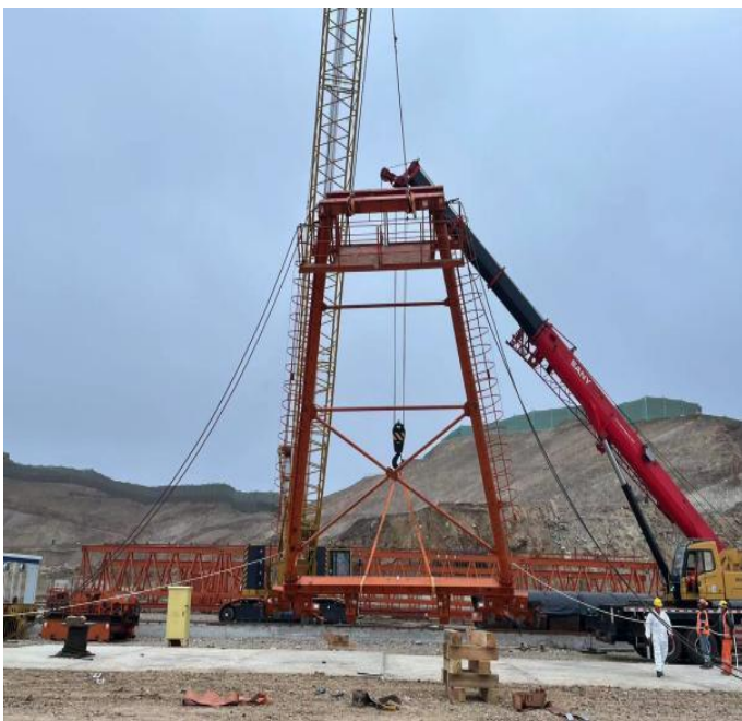
Figura 144. Elevación de estabilizadores 01.
