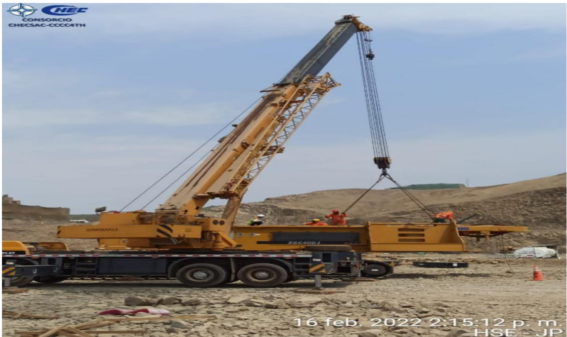
Figura 55. Instalación de la segunda Grúa sobre orugas de 400t 5.
