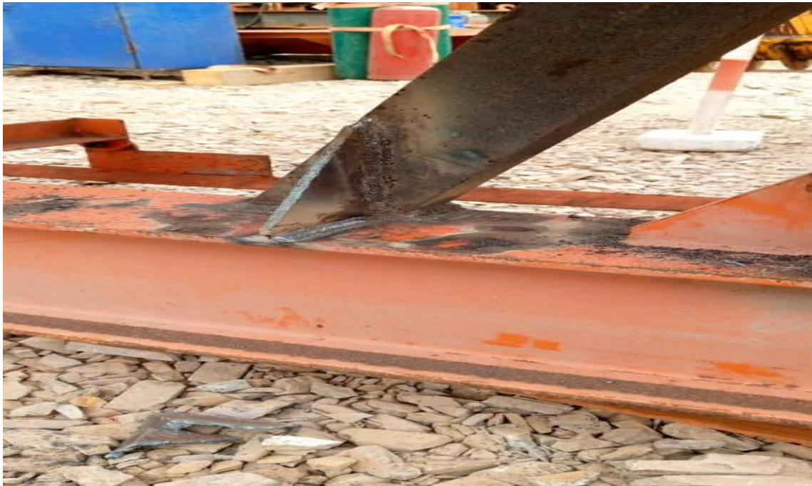
Figura 320. Soldadura de placa de tracción 01.
