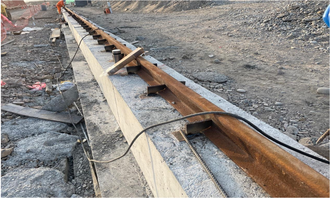
Figura 291. Instalación de la segunda placa de presión.
