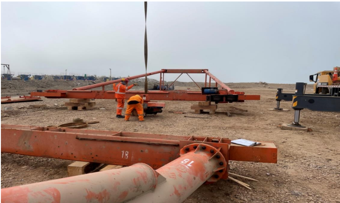
Figura 187. Instalación del mecanismo de desplazamiento 02.
