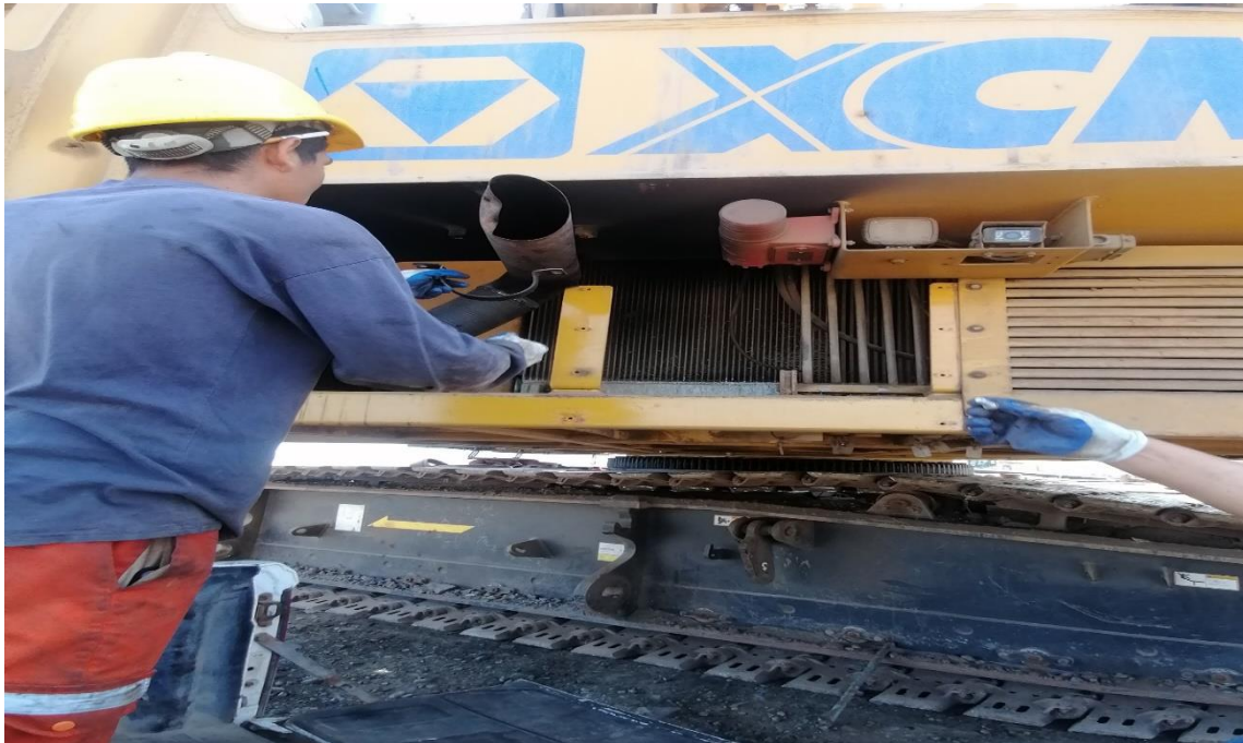
Figura 373. Instalación de los seguros.
