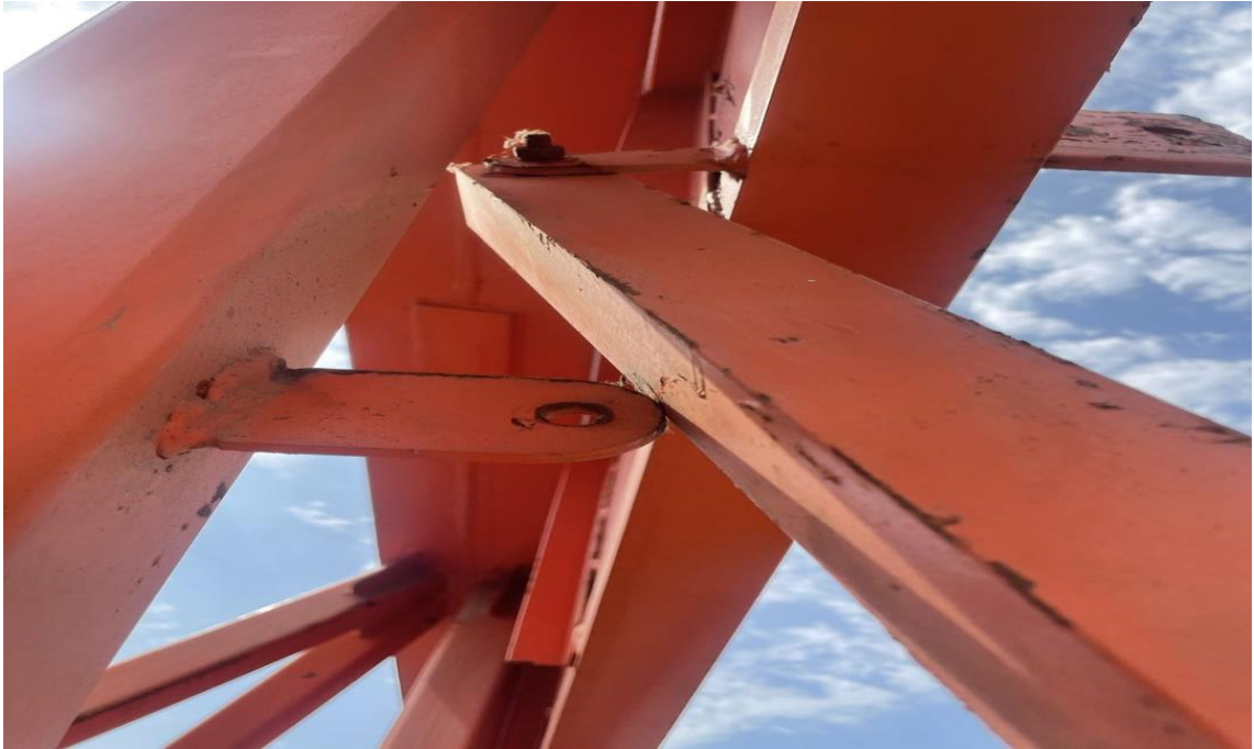
Figura 124. Proceso de ensamble de las patas plegables flexibles 03.
