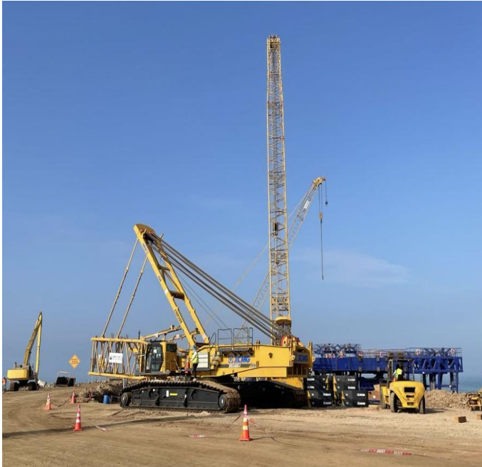
Figura 79. Grúa de 400 Tn 4.
