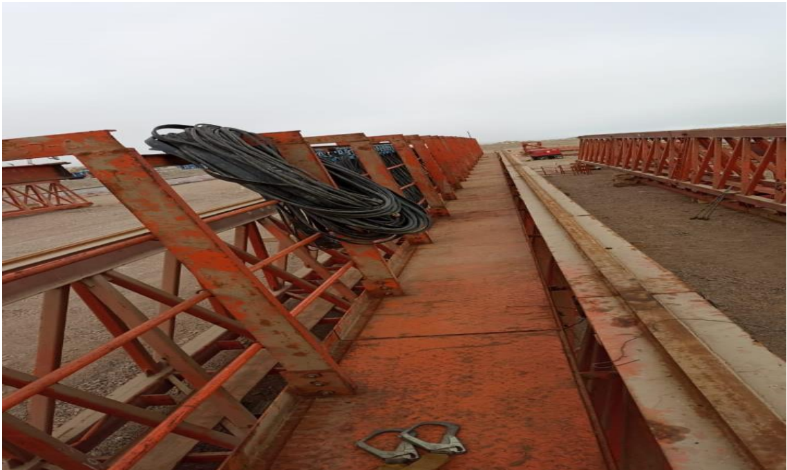
Figura 265. Instalación del cable de grúa.
