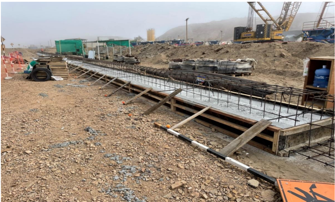
Figura 157. Estado del sitio 02.
