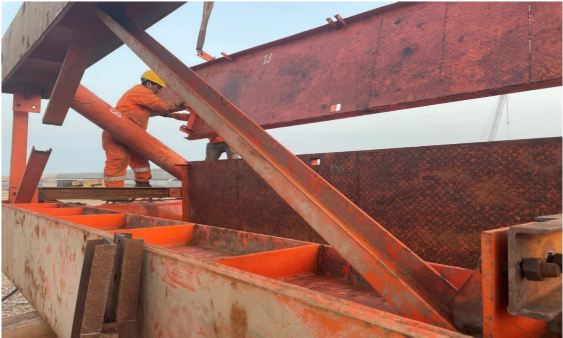
Figura 336. Instalación de plataforma.
