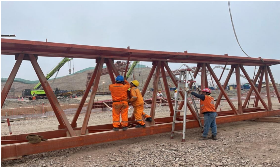
Figura 234. Instalación del tablero de la plataforma.
