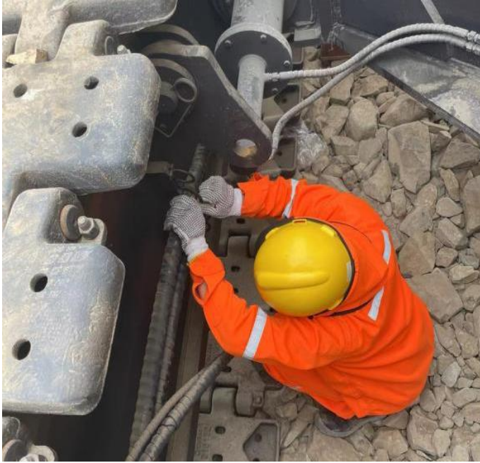
Figura 19. Anclado de la pista e instalación de la tubería de aceite 01.
