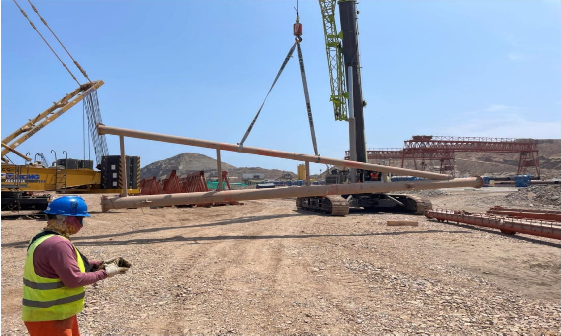
Figura 174. Movimiento del brazo estabilizador rígido.
