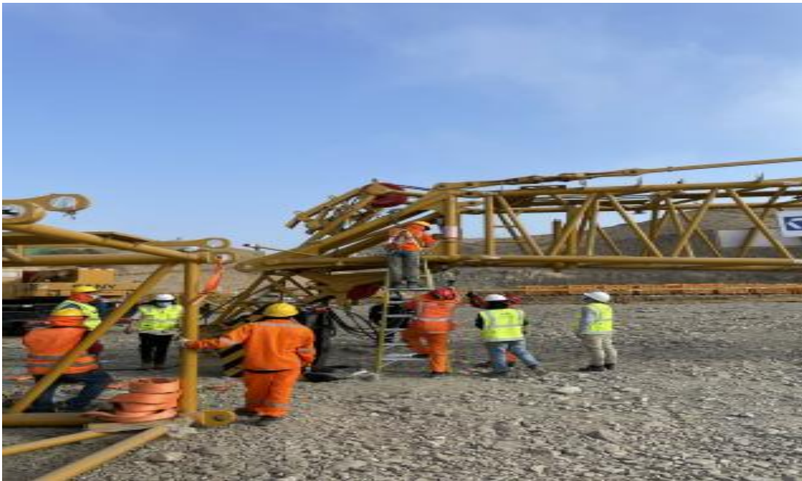
Figura 34. Instalación de la primera grúa sobre orugas de 320 t 3.
