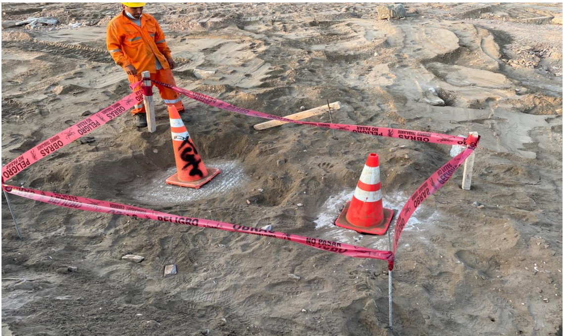
Figura 285. Señalización de los puntos de anclaje.
