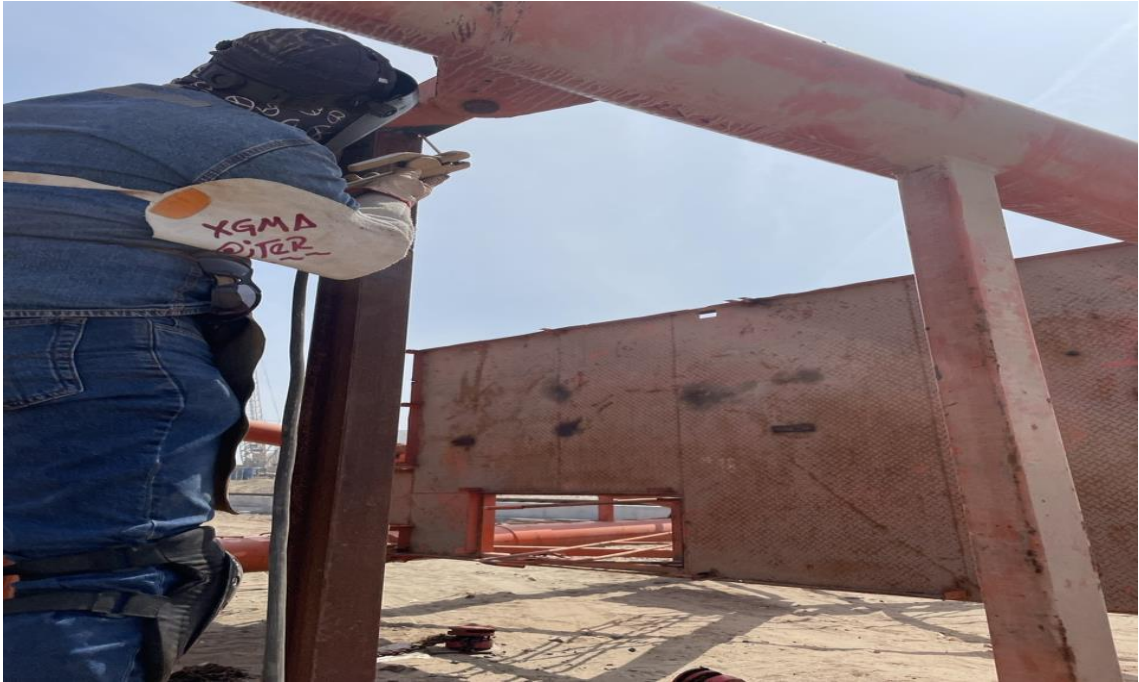
Figura 342. Soldadura de estabilizadores 01.
