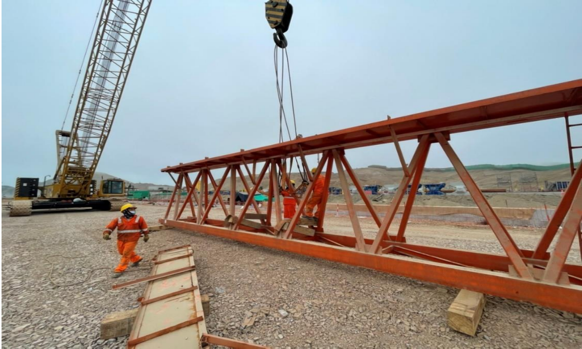
Figura 238. Instalación del tablero de la plataforma.
