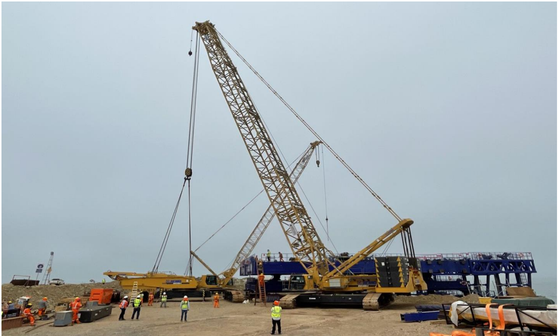
Figura 81. Grúa de 400 Tn 5.
