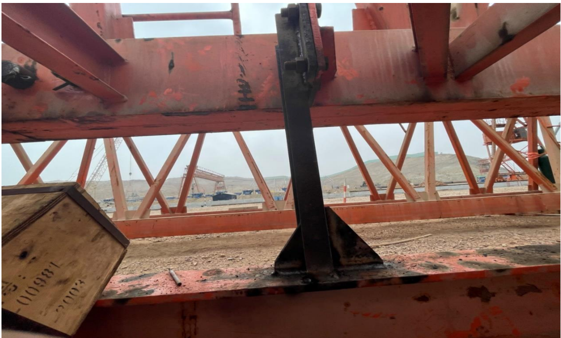
Figura 330. Soldadura de placa de tracción 02.
