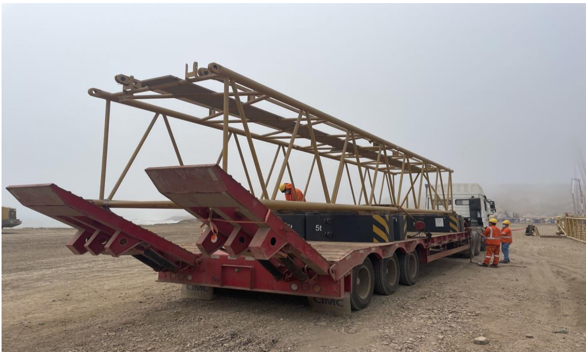
Figura 65. Desmontaje, transporte e instalación de la grúa celosía de 150 t 2.
