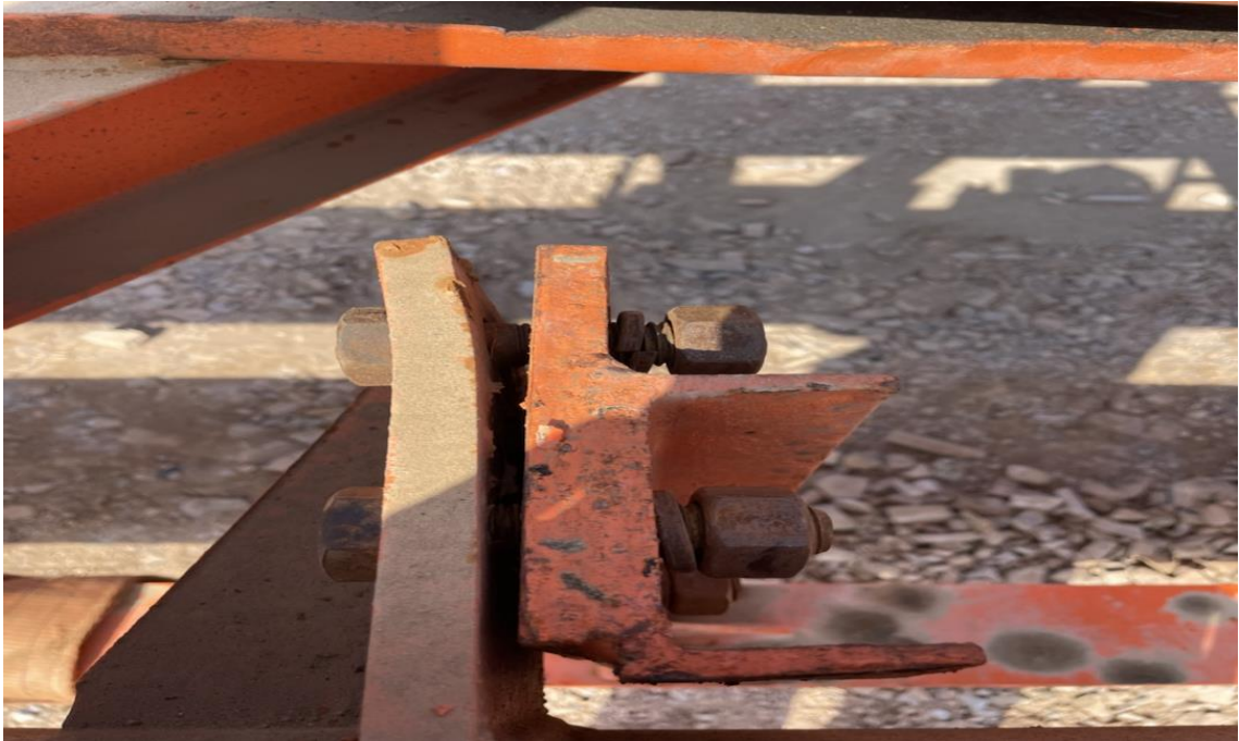
Figura 198. Deformación.
