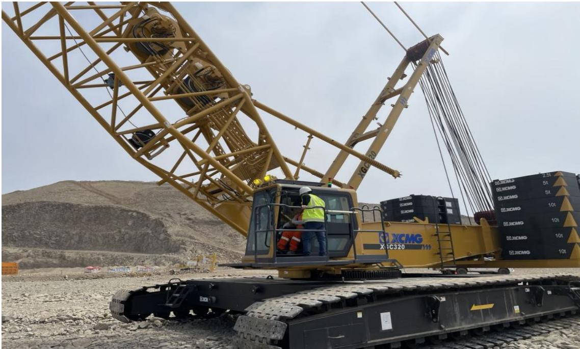
Figura 33. Instalación de la primera grúa sobre orugas de 320 t 2.
