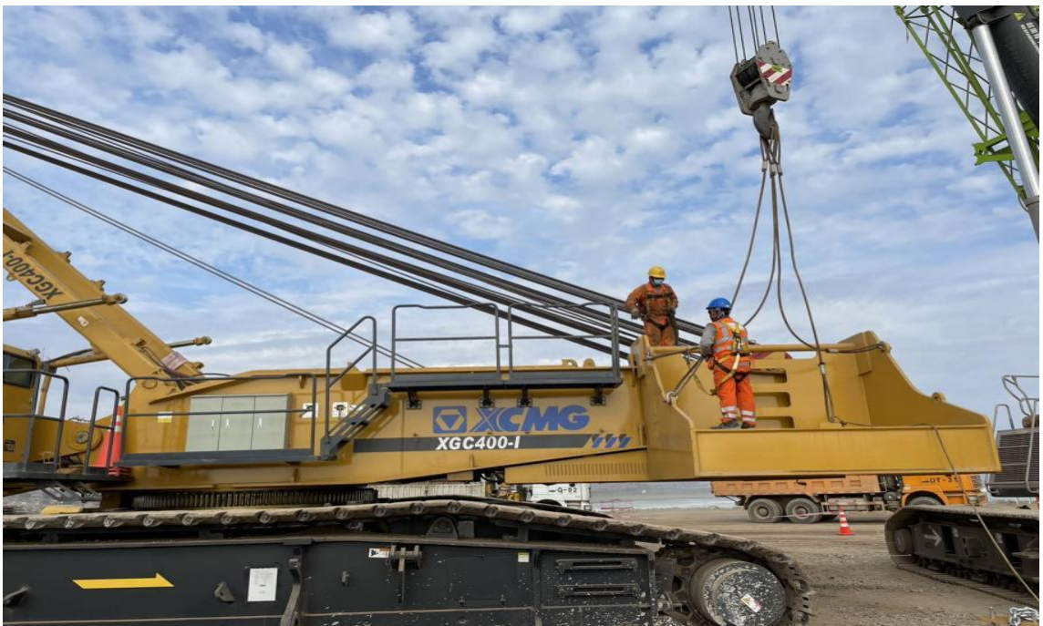
Figura 78. Grúa de 400 Tn 3.
