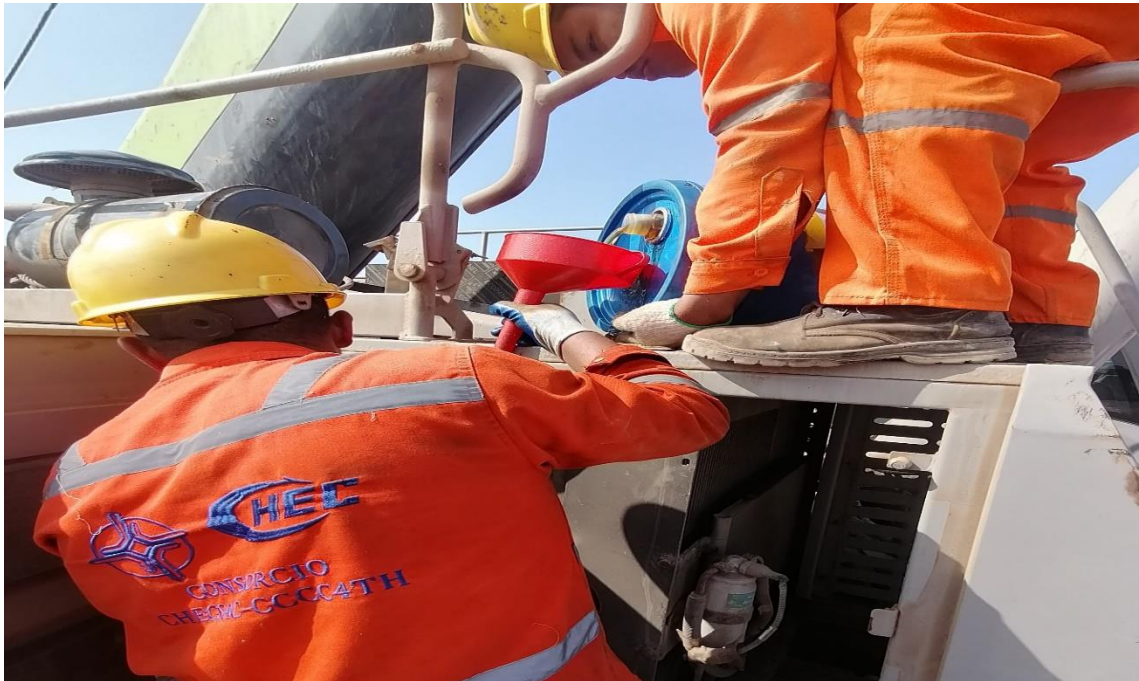
Figura 371. Cambio de aceites en el sistema mecánico de la grúa telescópica.
