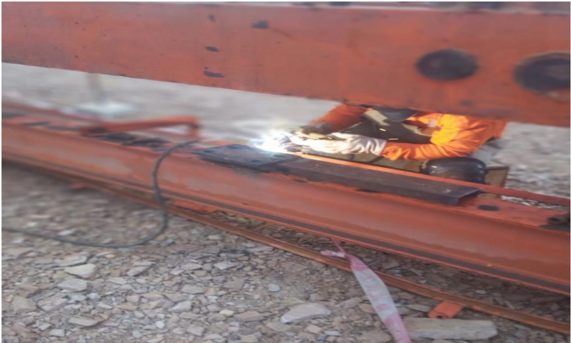
Figura 329. Soldadura de placa de tracción 01.
