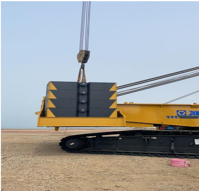
Figura 46. Instalación de grúas sobre orugas de 400 t 5
