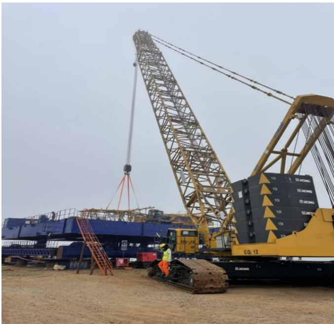
Figura 90. Estación de la sección inferior de la pluma, contrapeso y el mástil vertical 3.
