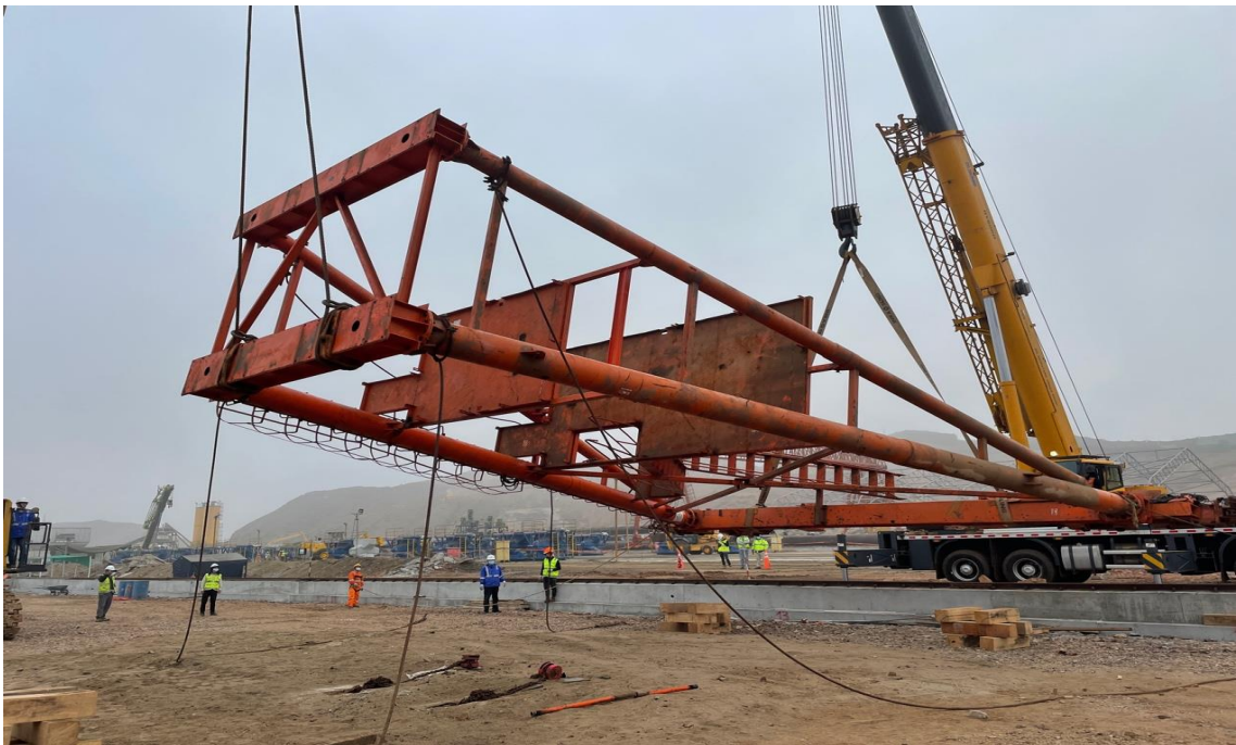
Figura 348. Elevación de estabilizador.
