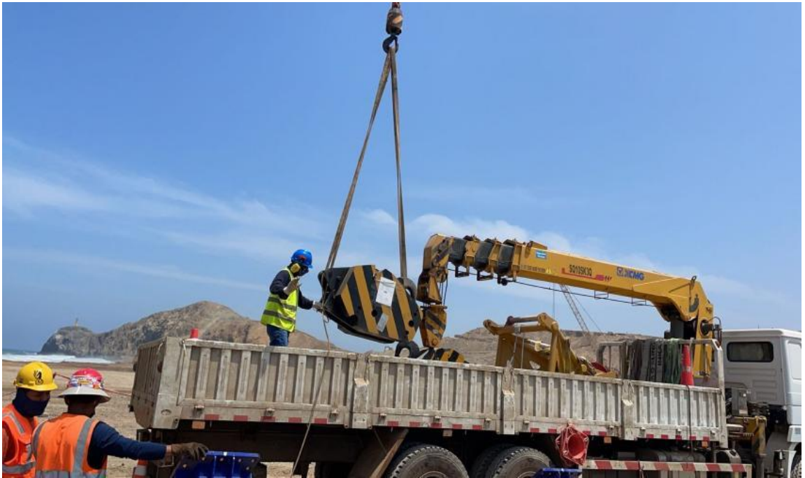
Figura 51. Instalación de la segunda Grúa sobre orugas de 400t.
