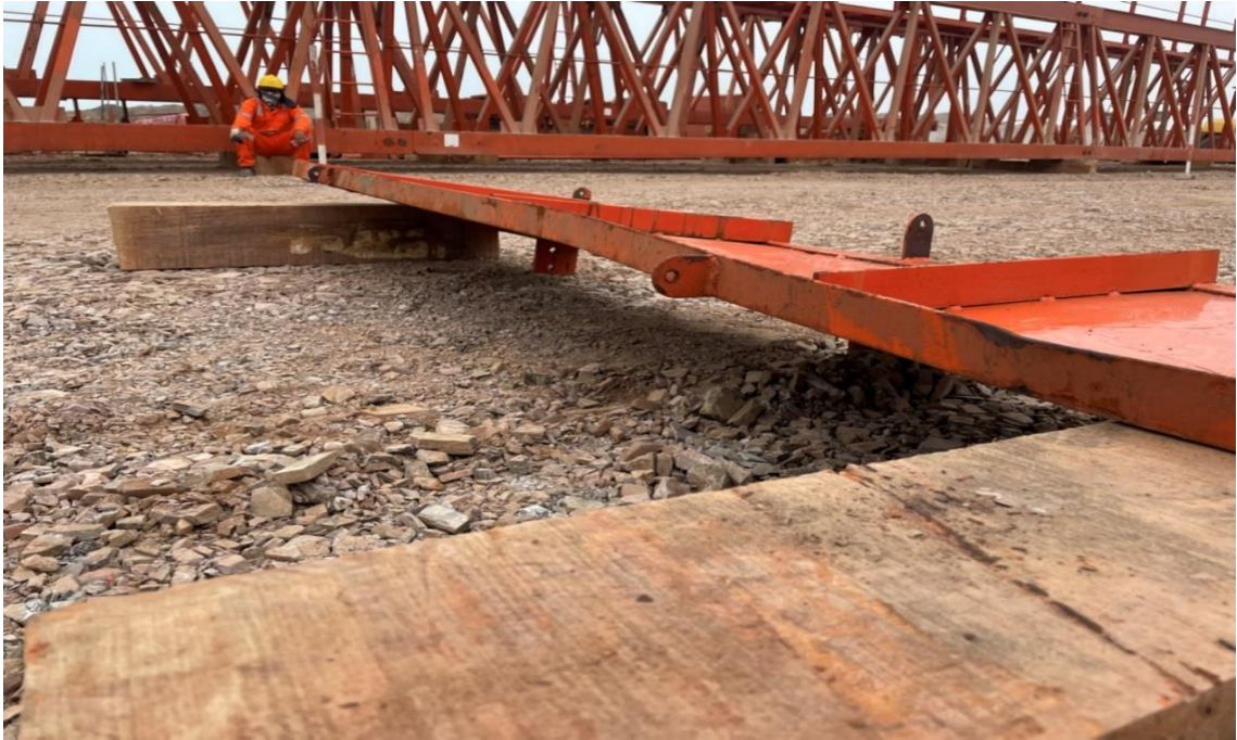
Figura 250. Corrección del tablero de la Plataforma.
