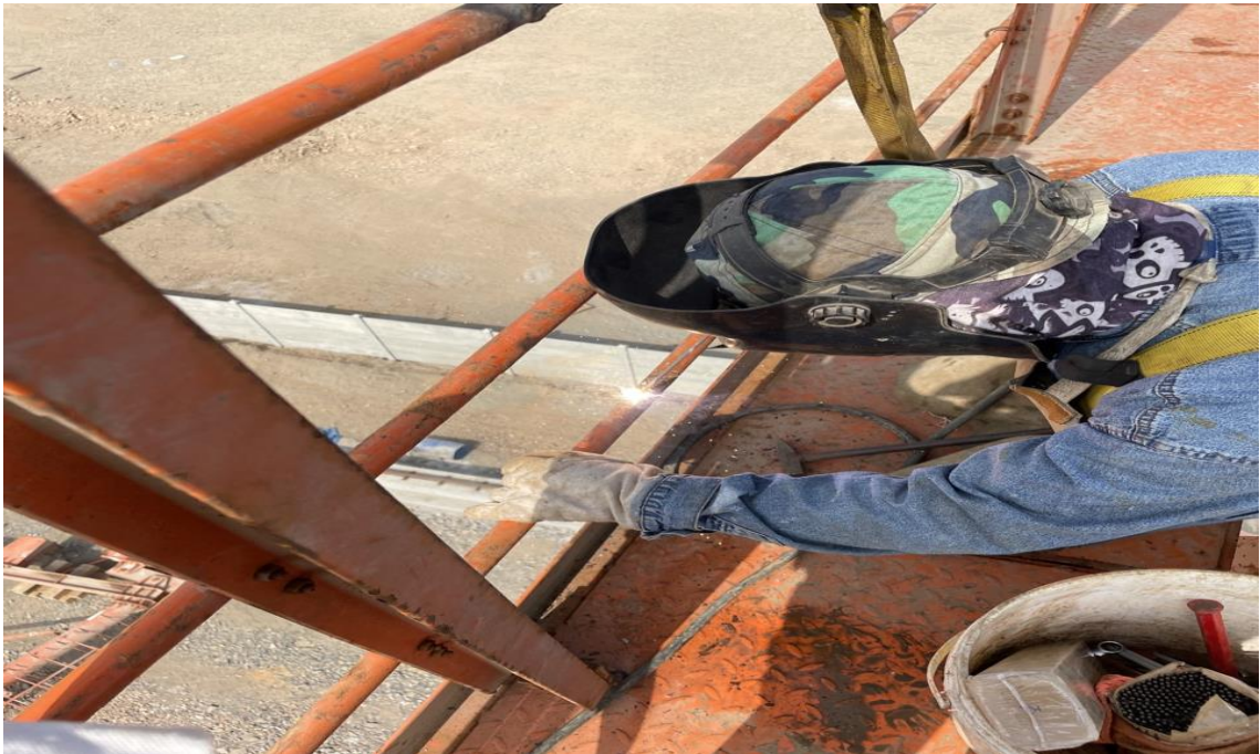
Figura 317. Soldadura de barandas.
