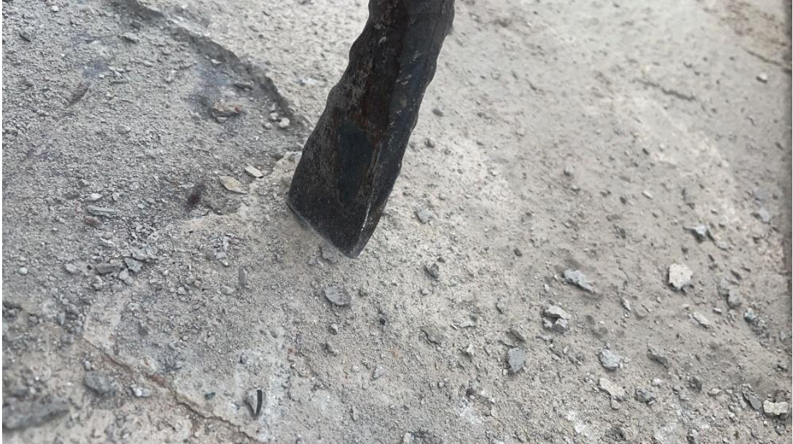
Figura 117. Limpieza de concreto.
