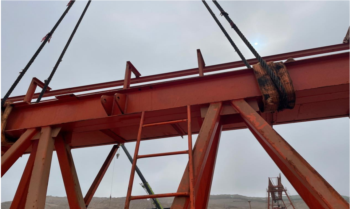
Figura 353. Estabilización de las estructuras.
