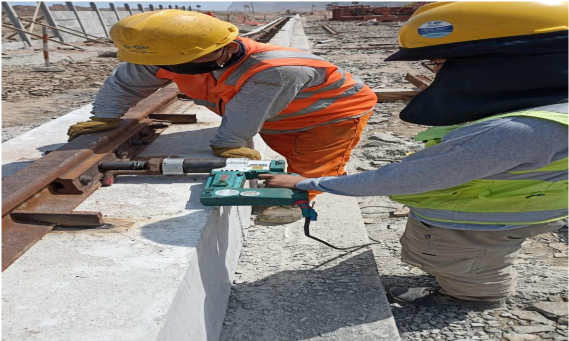
Figura 289- Torsión de los pernos en los rieles.
