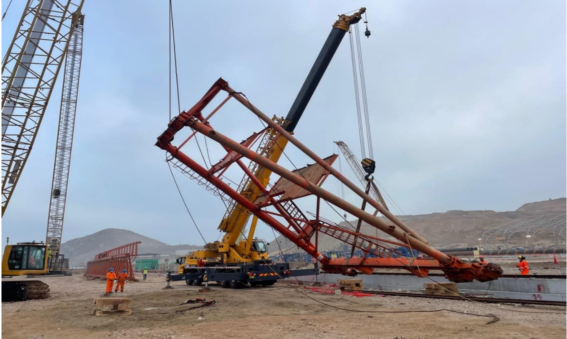
Figura 300. Elevación de estabilizadores rígidos.
