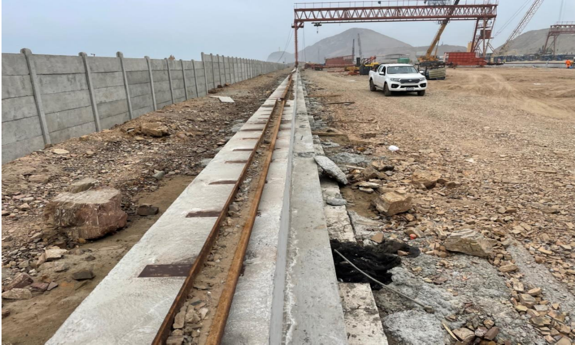
Figura 331. Colocación de pista.
