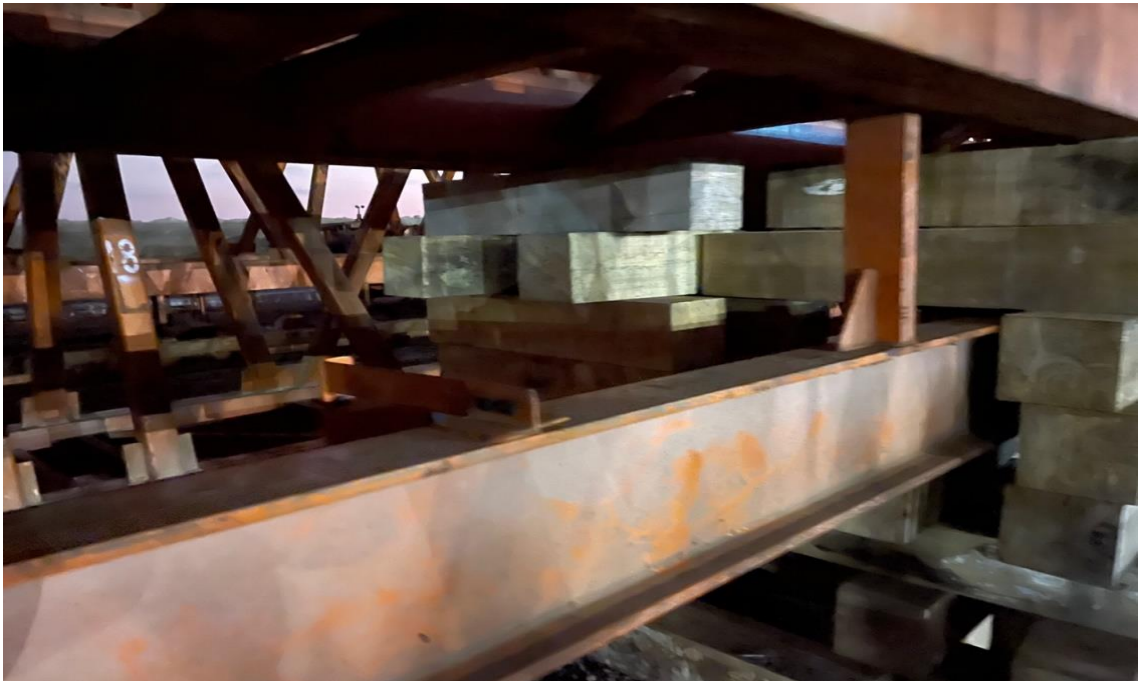
Figura 292. Medidas de protección para la viga.
