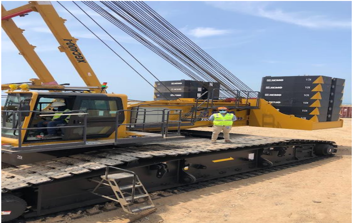
Figura 56. Instalación de la segunda Grúa sobre orugas de 400t 6.
