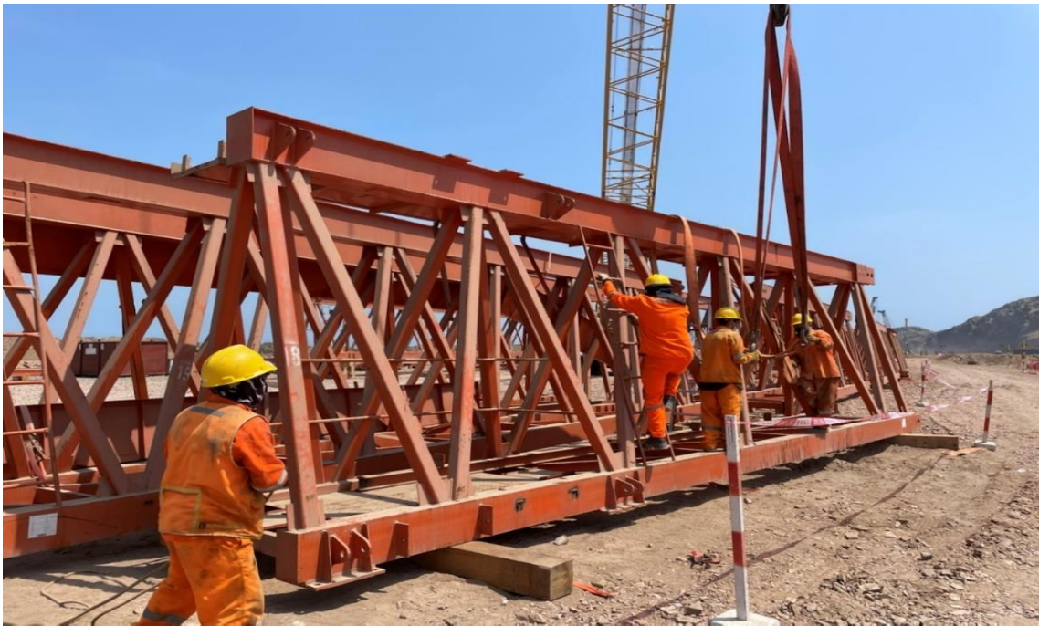
Figura 206. Empalme de la segunda viga.
