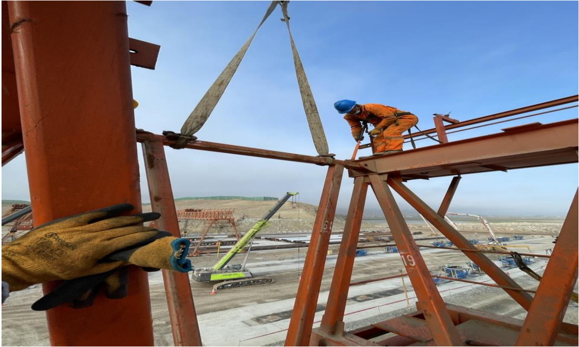
Figura 308. Instalación conexión cruzada.
