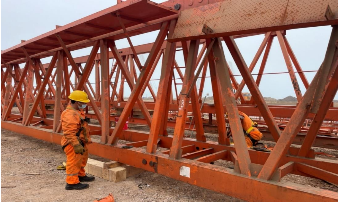
Figura 226. Instalación de la viga y plataforma.
