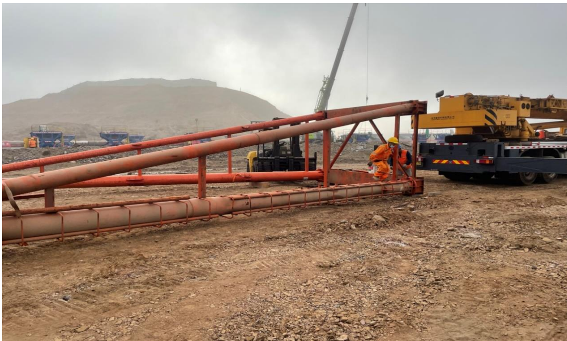
Figura 181. Instalación de las patas rígidas.
