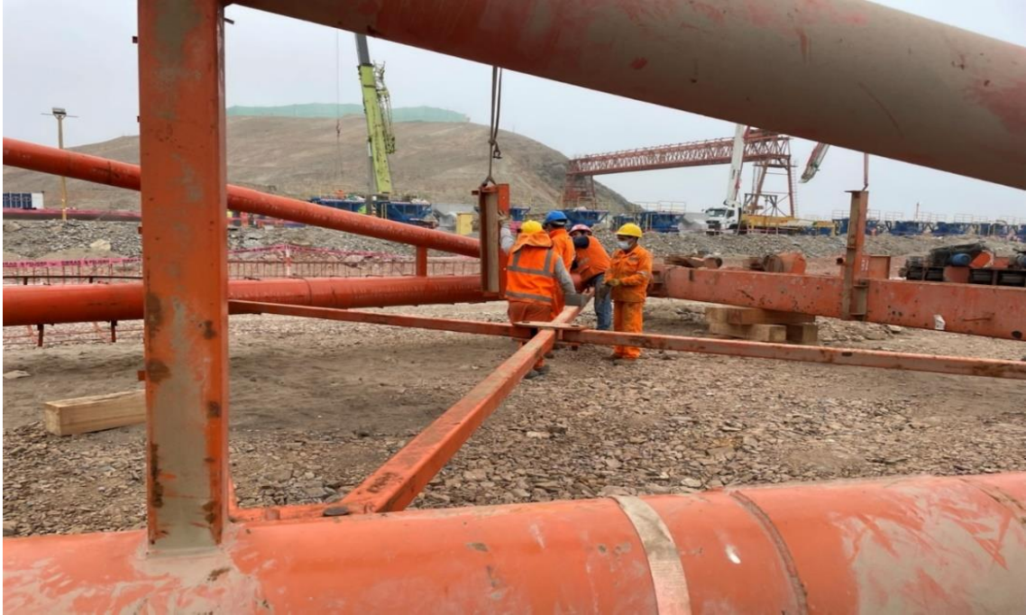
Figura 236. Instalación de la plataforma de transferencia.
