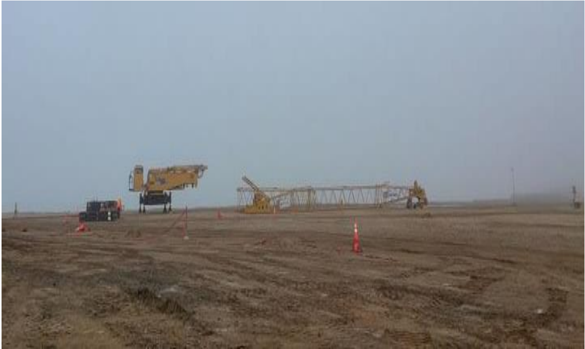
Figura 64. Desmontaje, transporte e instalación de la grúa celosía de 150 t 1.
