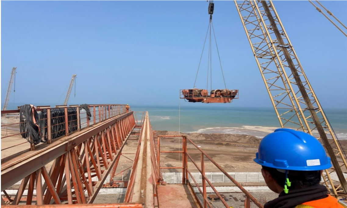
Figura 332. Elevación de carrete.
