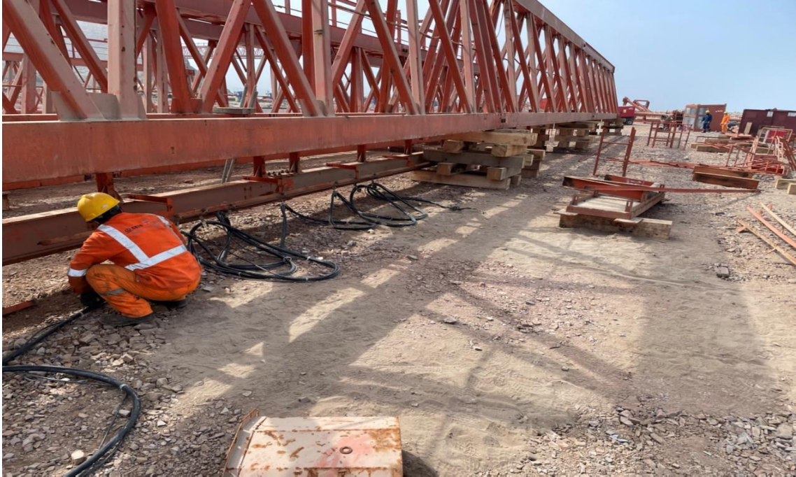
Figura 283. Instalación del cable del carro.
