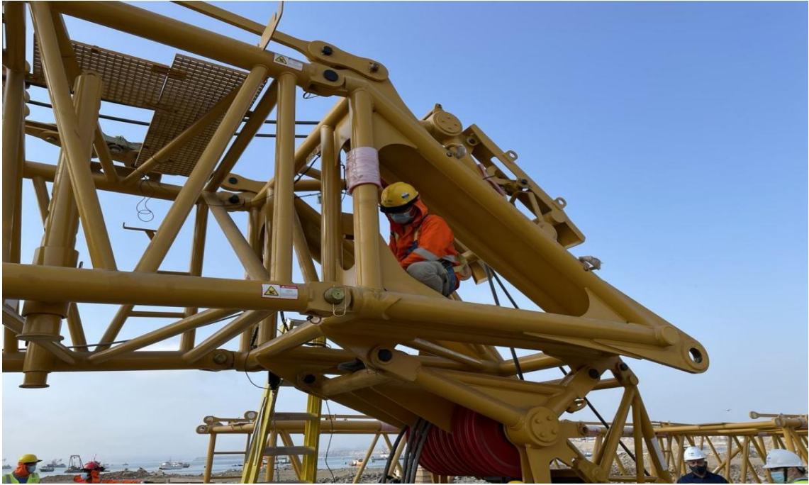
Figura 31. Instalación de la primera grúa sobre orugas de 320 t 1.
