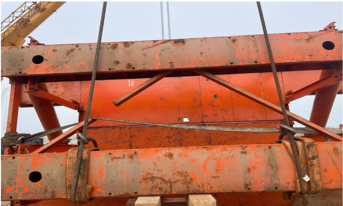
Figura 350. Protección de estabilizadores flexibles.
