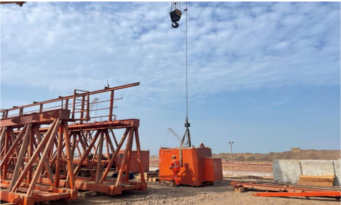
Figura 271. Gabinete de control eléctrico.
