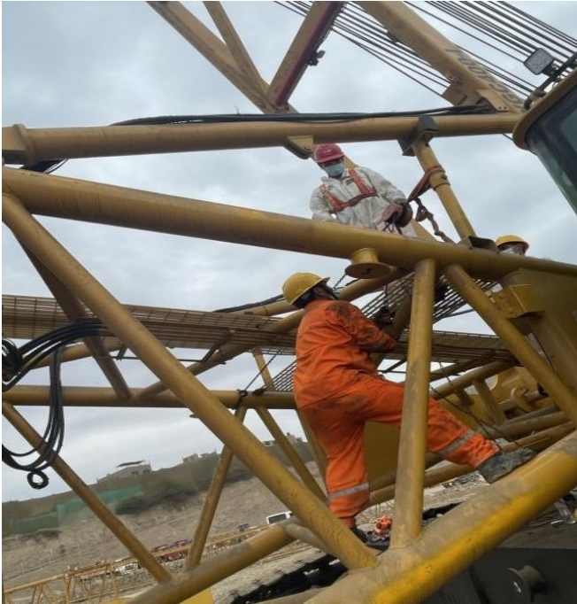
Figura 61. Instalación del anillo elástico anti-enganche 3.
