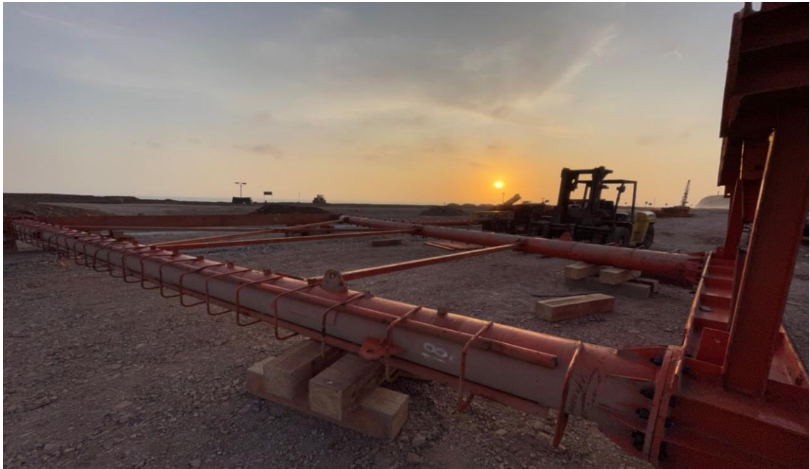
Figura 169. Posición de tableros de soporte.
