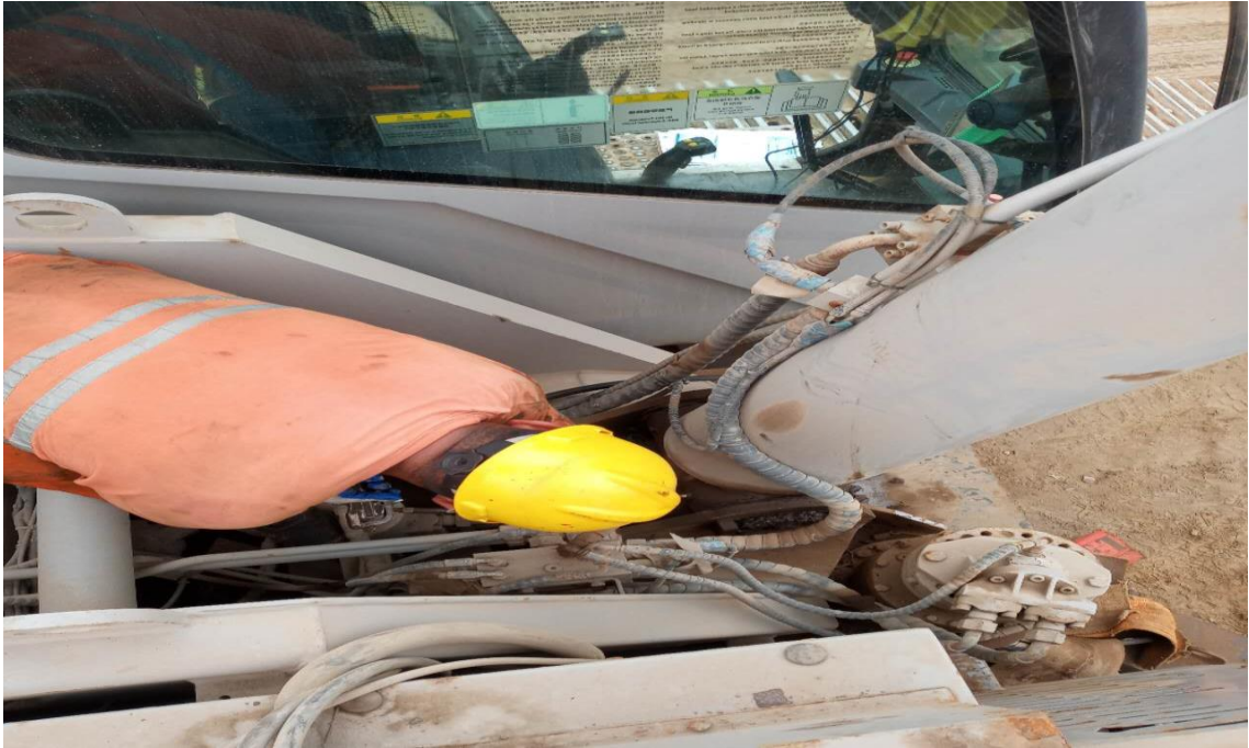
Figura 377. Aplicación de grasa al cuerpo y boom de la grúa 02.
