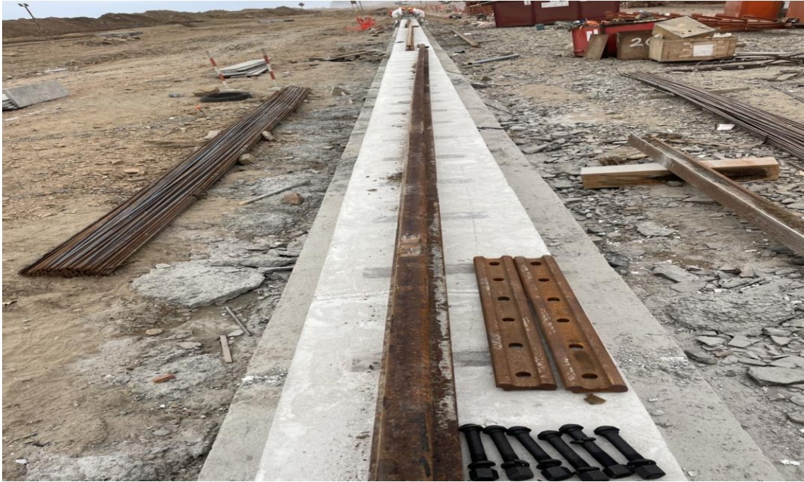
Figura 259. Eliminación de óxido.
