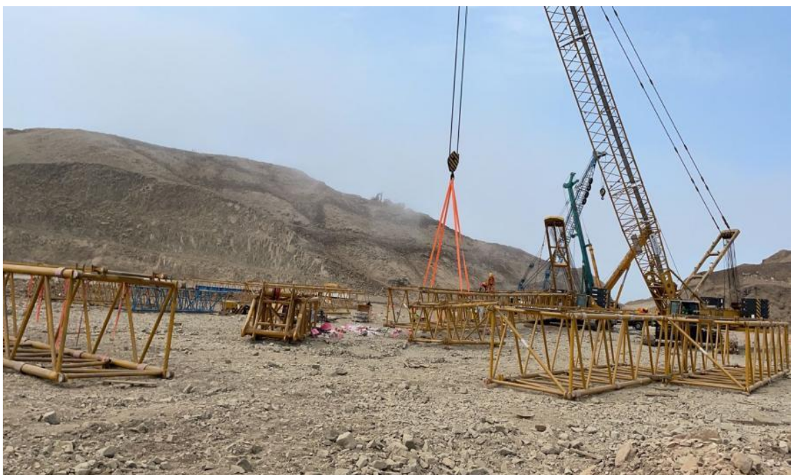
Figura 57. Montaje de diferentes partes de la grúa.
