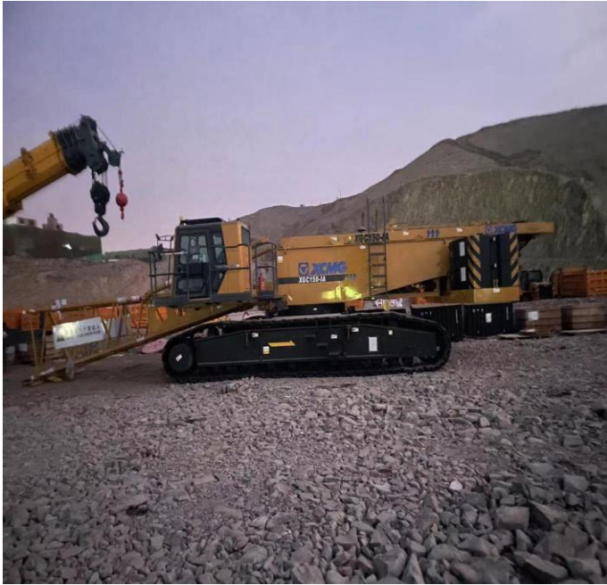
Figura 26. Instalación del brazo de la grúa.
