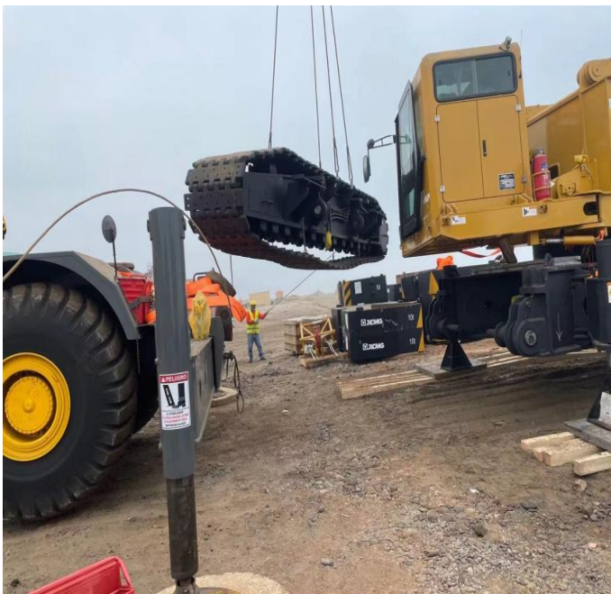
Figura 42. Instalación de grúas sobre orugas de 400 t 3.
