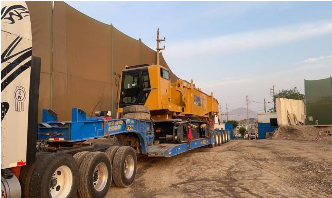
Figura 40. Instalación de grúas sobre orugas de 400 t A.
