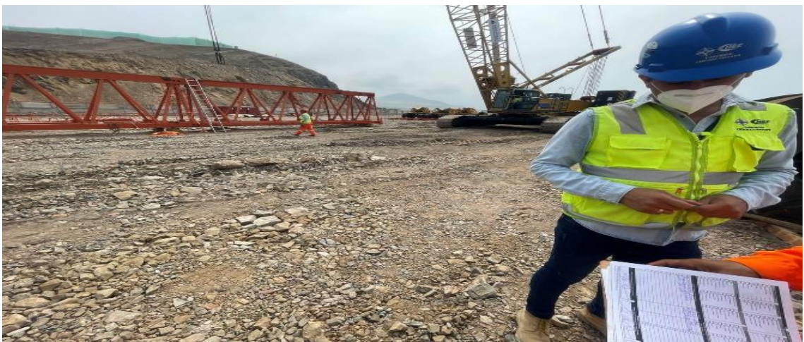
Figura 127. Ingeniero HSE, cumpliendo los requisitos de instalación.
