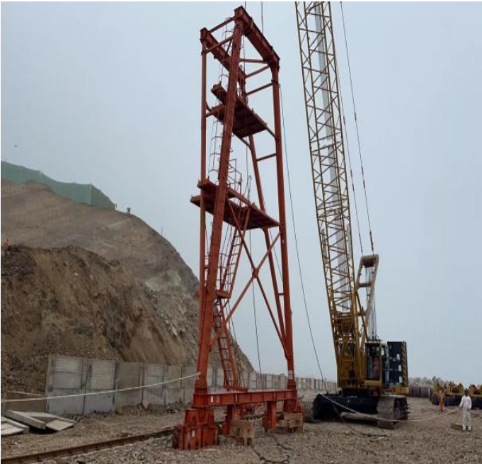
Figura 146. Elevación de estabilizadores 03.
