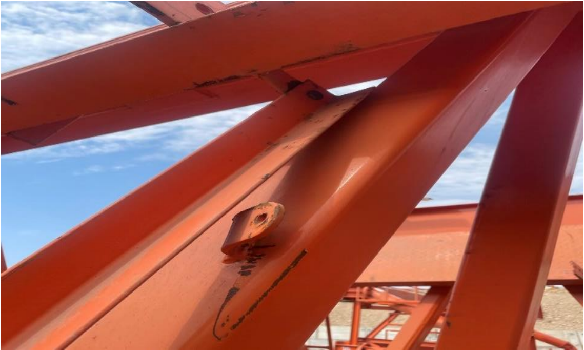
Figura 122. Proceso de ensamble de las patas plegables flexibles 01.
