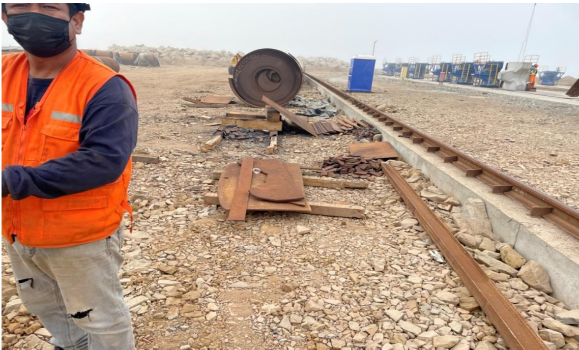
Figura 185. Organización de estructuras para el montaje.
