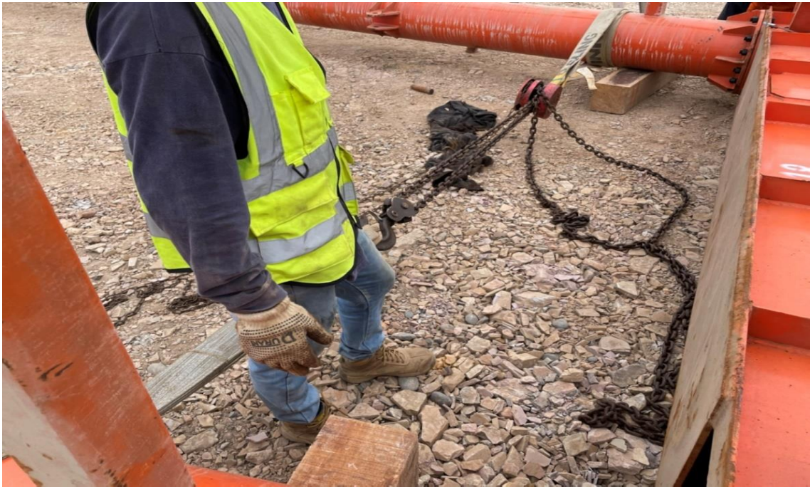
Figura 176. Corrección de estructura dañada.
