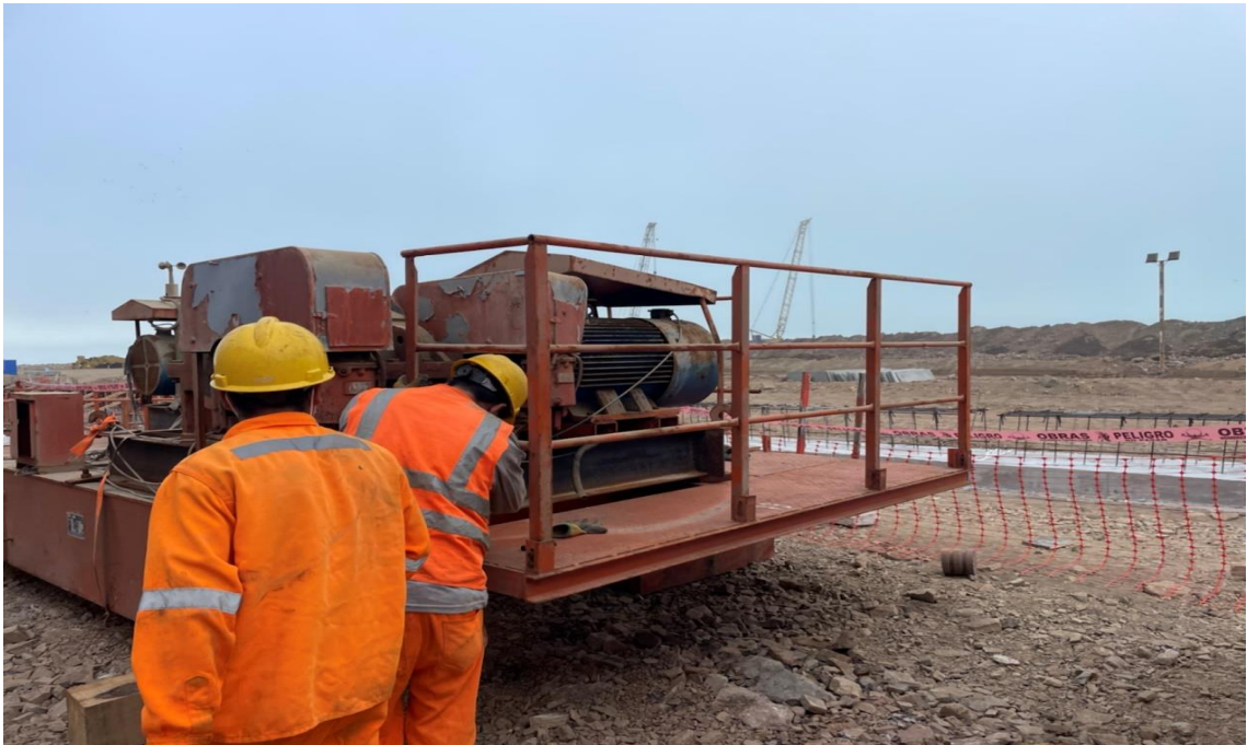
Figura 267. Instalación de la barandilla.
