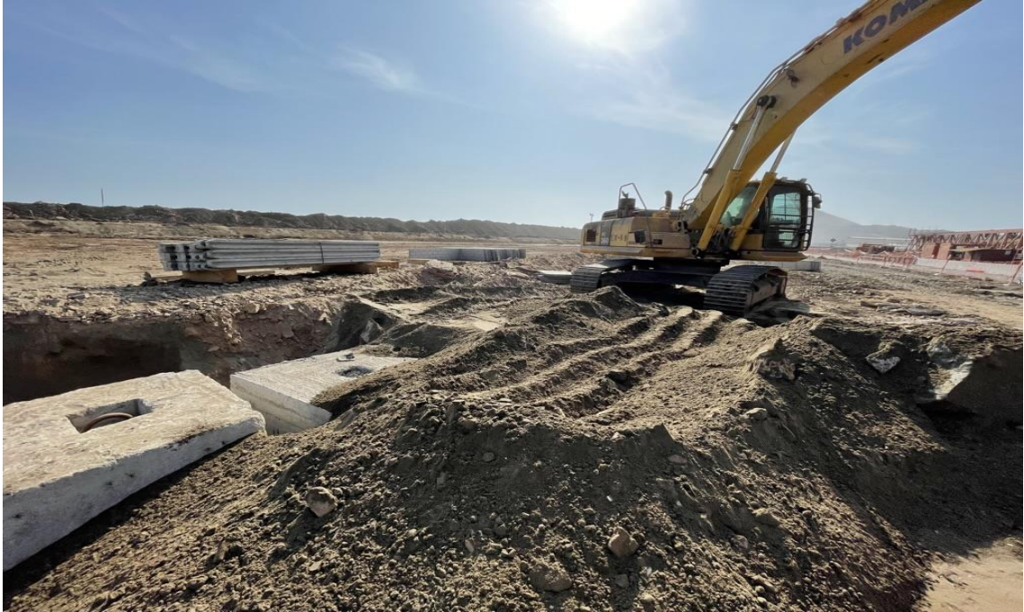
Figura 284. Entierro de los bloques de concreto.
