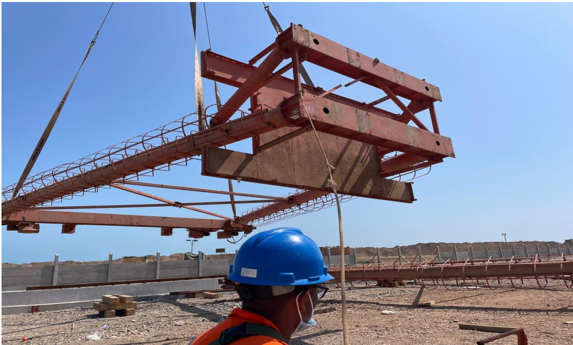
Figura 294. Traslado de estabilizadores.
