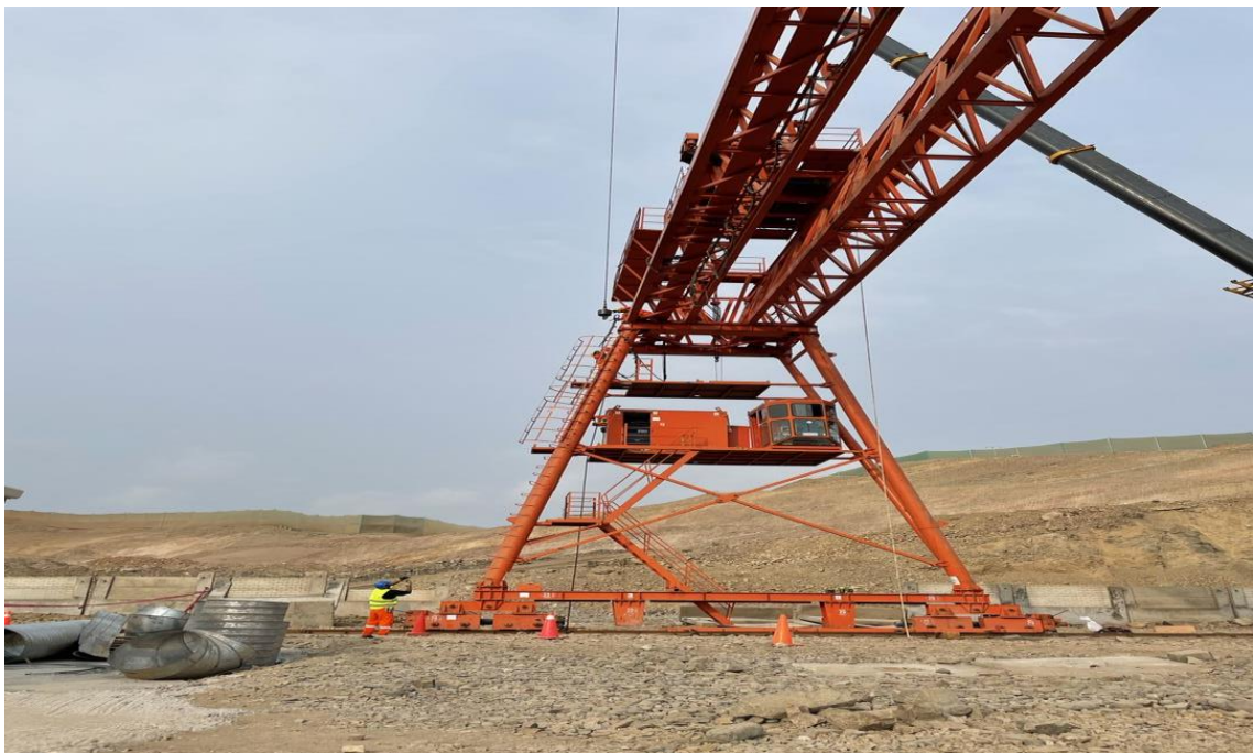
Figura 134. Elevación de la viga principal.
