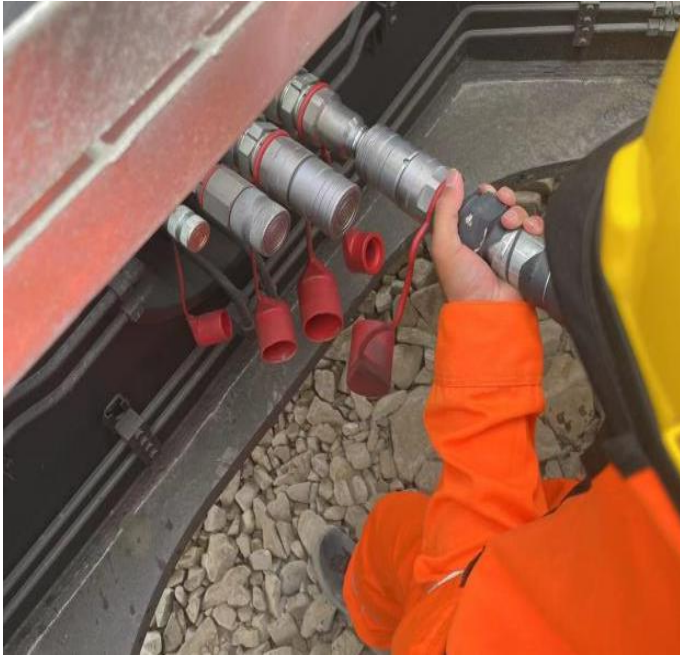
Figura 20. Anclado de la pista e instalación de la tubería de aceite 02.
