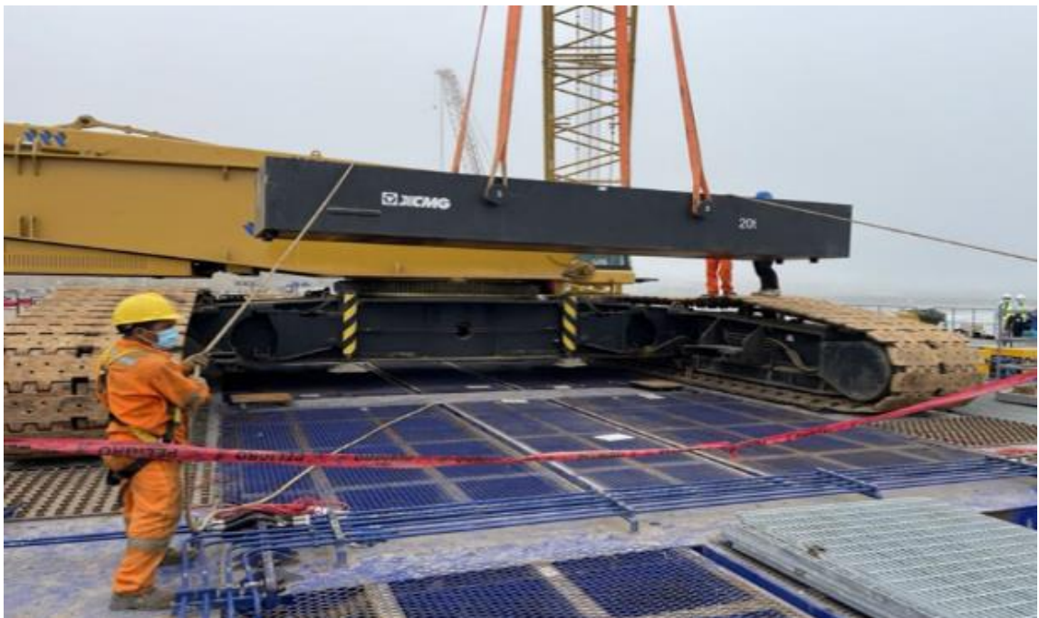
Figura 88. Estación de la sección inferior de la pluma, contrapeso y el mástil vertical.
