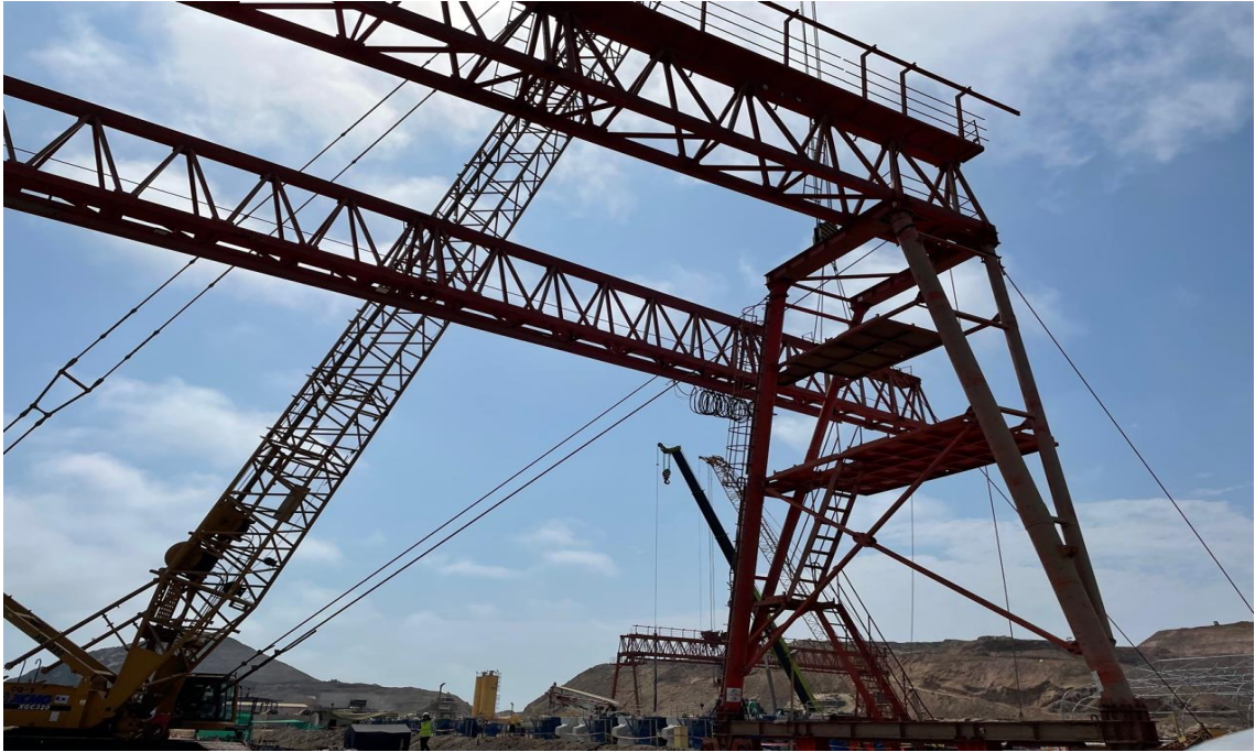
Figura 306. Segunda viga principal.
