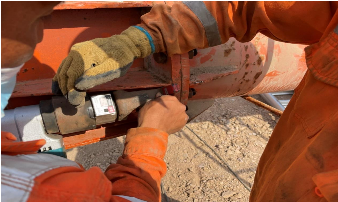
Figura 274. Torque de estabilizador flexible.
