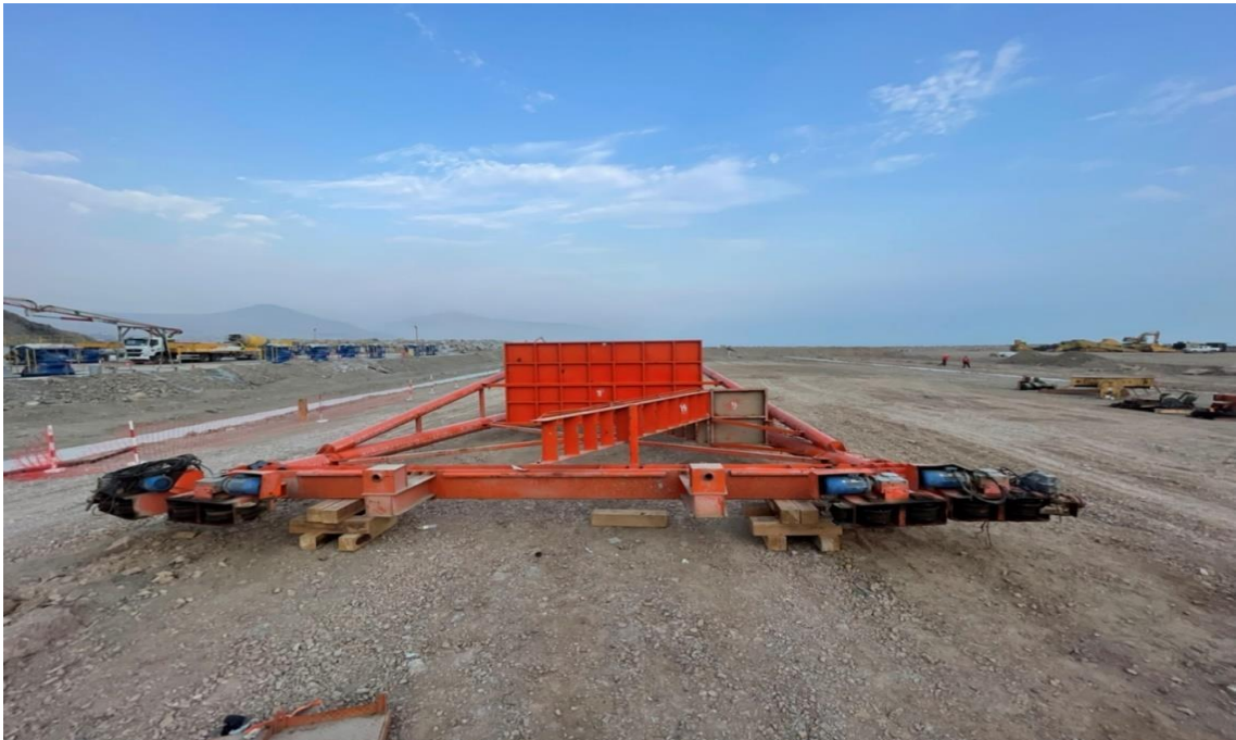
Figura 222. Instalación de la escalera.
