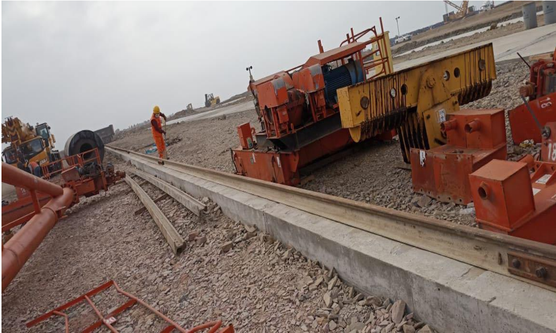
Figura 113. Corrección de pista a estado vertical.
