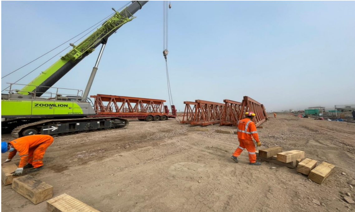
Figura 161. Traslado de vigas principales y otros equipos 03.
