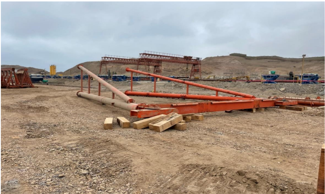
Figura 175. Empalme de estructura.
