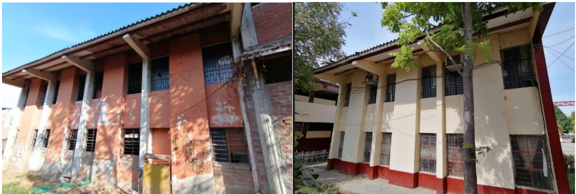
Figura 208. Calidad del sistema resistente de muros del pabellón II y VII.
