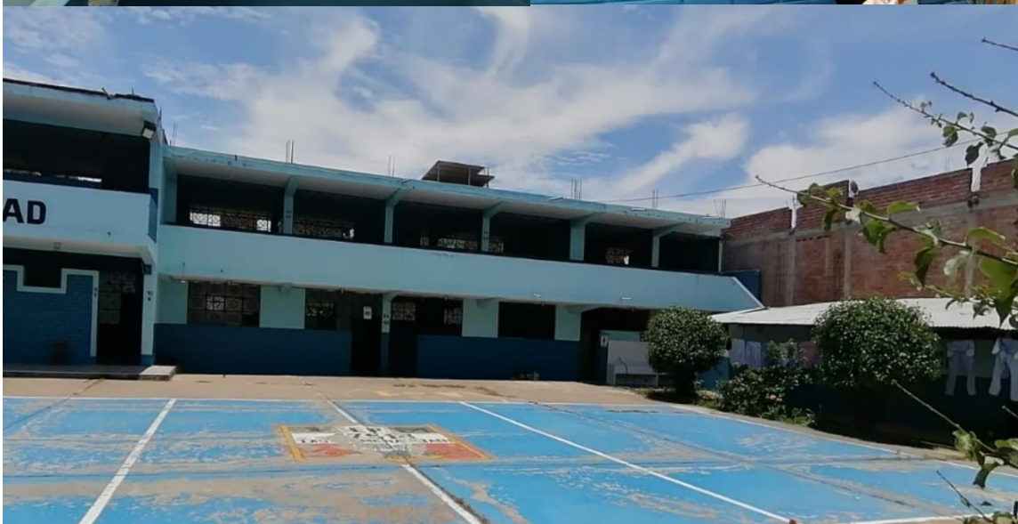
Figura 212. Tipo de cubierta del pabellón II.
