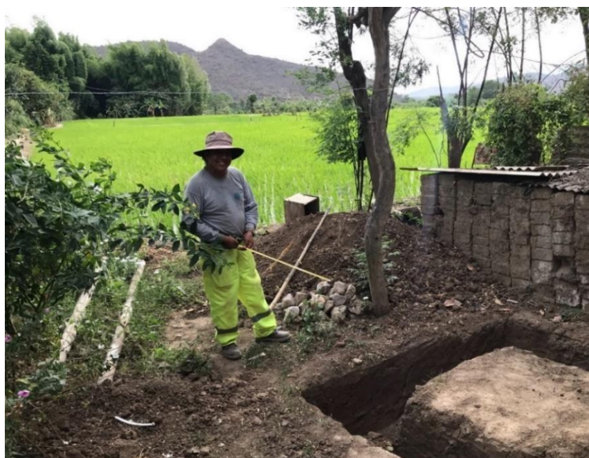
Figura 8: Poblador de Espinal construyendo módulo con pozo ciego
