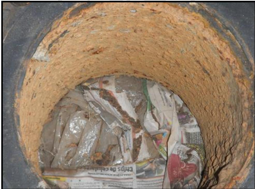
**Gráfico N° 15.** Tubería en estado de degradación.
