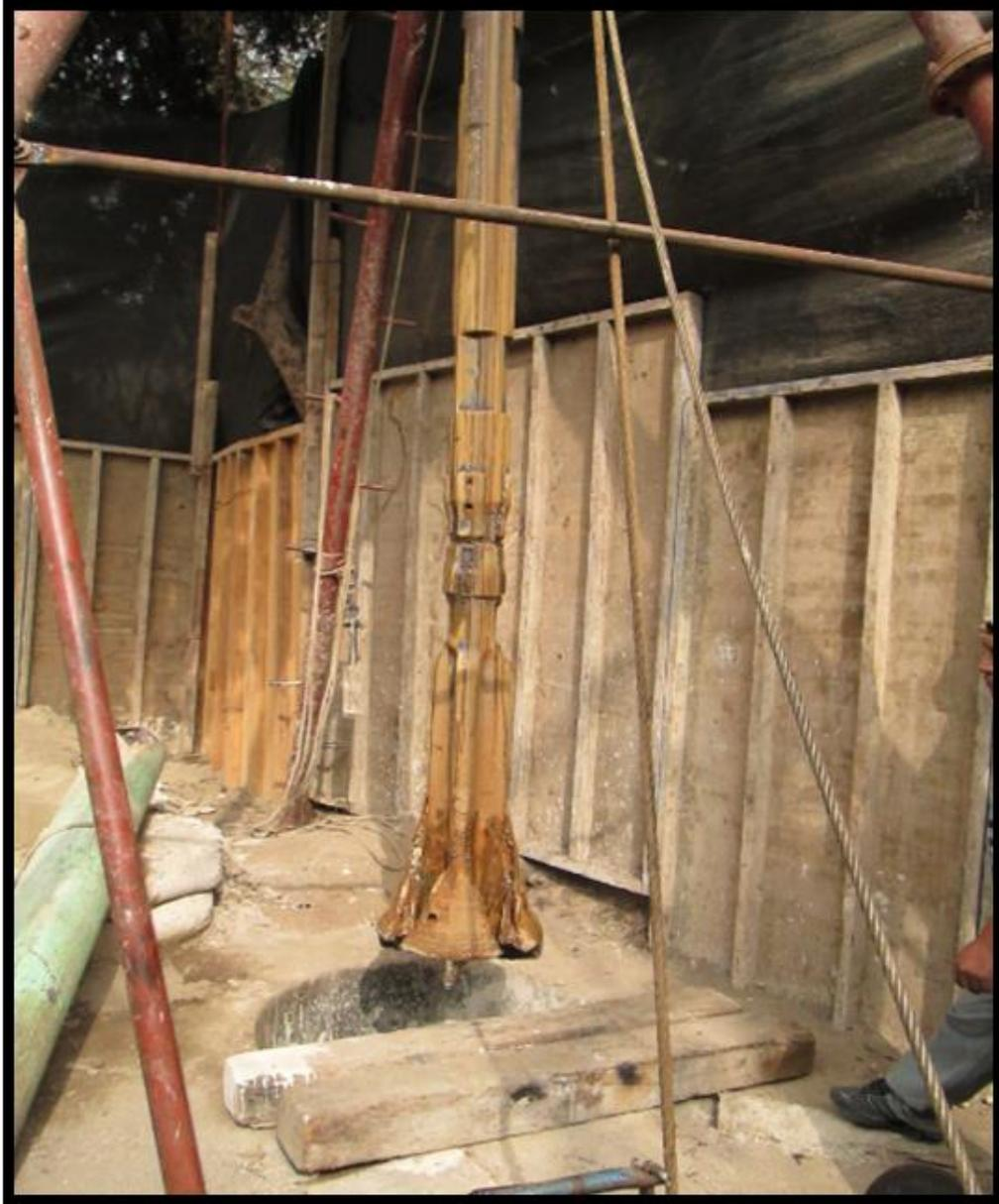
**Gráfico N° 10.** Herramienta de perforación para fracturar las rocas
