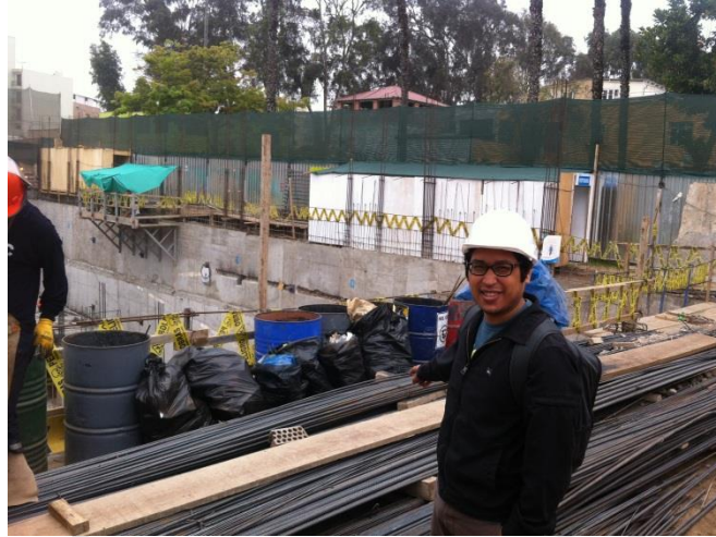
Figura N°13. Instalación de contenedores para residuos domiciliarios Elaboración: Los autores
