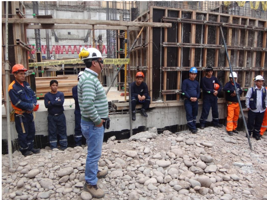
2°Visita: Inicio de charla diaria a cargo de Ingeniero de Seguridad.
