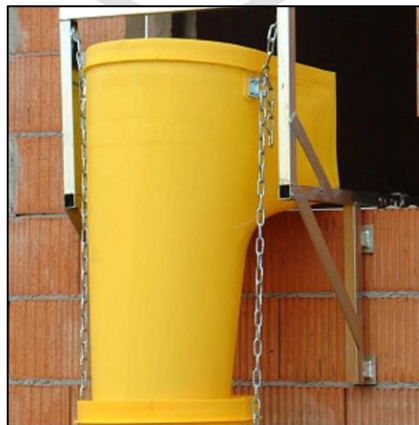
Figura N° 11.Ductos RCD instalado en obra
