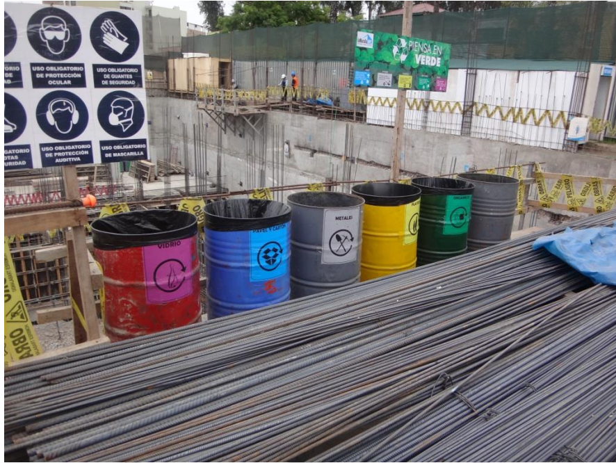
2°Visita: Contenedores debidamente pintados y señalizados.
