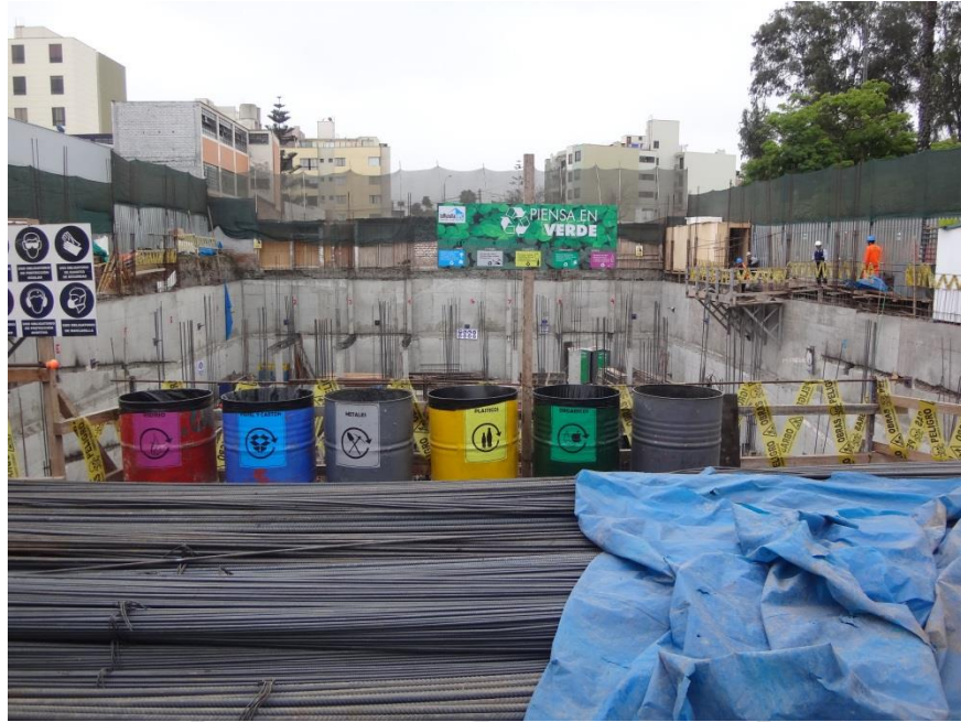
2°Visita: Orden de punto limpio. Punto de contenedores de residuos señalizado.
