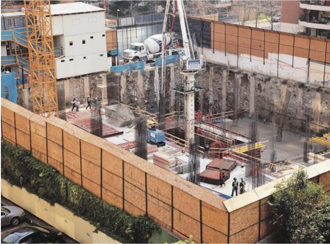
Figura N° 30. Cerco de obra
