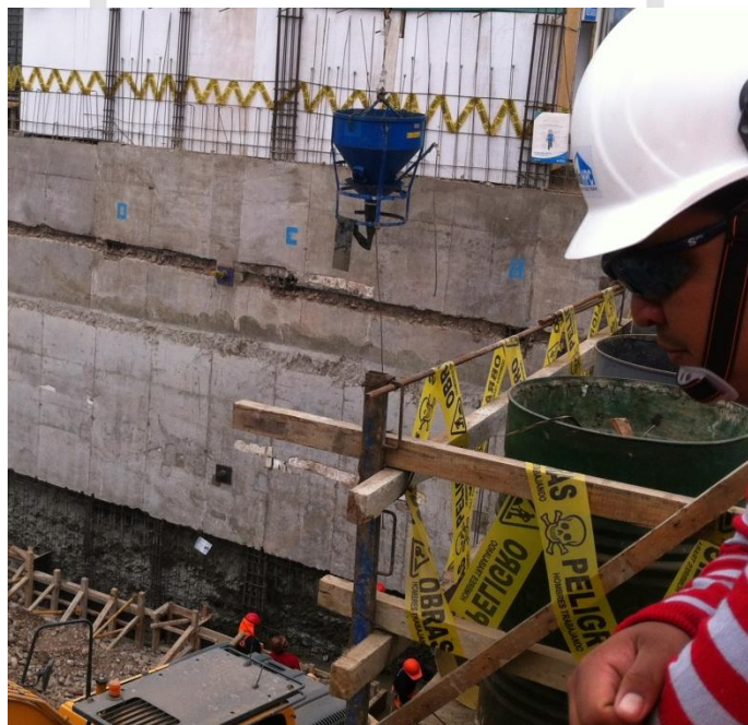
1°Visita: Balde de descarga de concreto para minimización de RCD.
