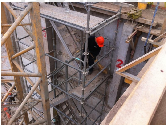
1°Visita: Limpieza perenne en obra.
