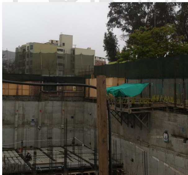
1°Visita: Punto especializado para trabajo de acero en segundo nivel.
