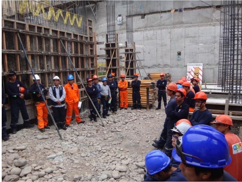
2°Visita: Vista general de trabajadores en charla diaria.
