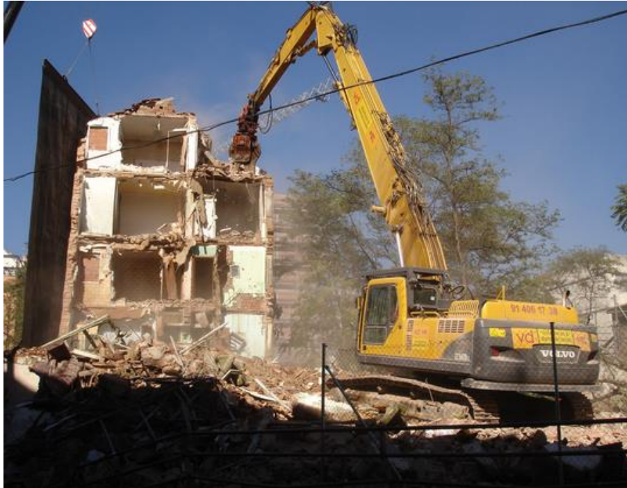
Figura N° 35. Demolición de edificación Urbana
