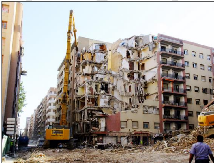
Figura N° 7. Demolición Vivienda multifamiliar – Av. Juan Carlos I. – España - 2011
