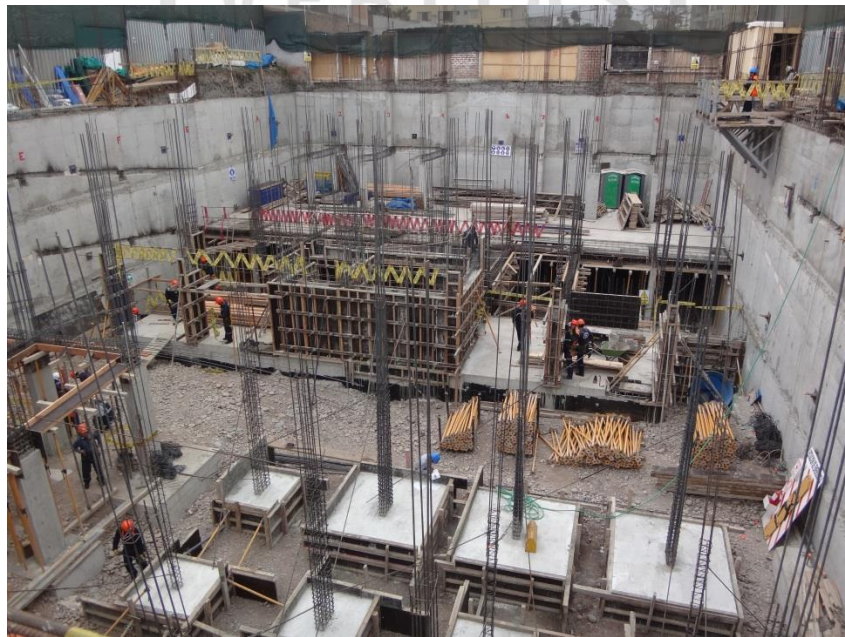
2°Visita: Avance de cimentación de obra, orden y limpieza general.
