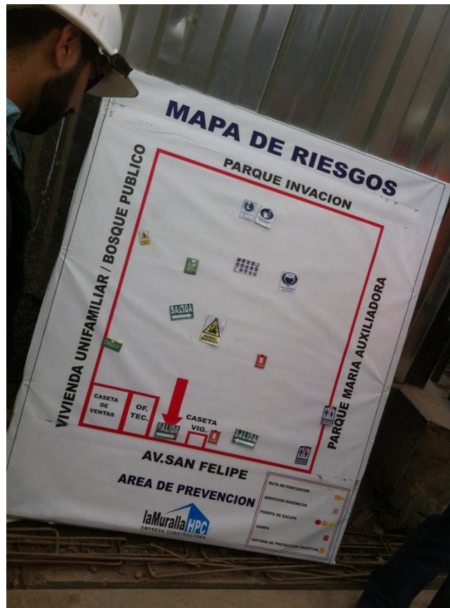
1°Visita: Incorrecta colocación de Mapa de Riesgos didáctico.
