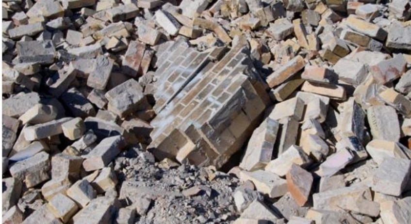
Figura N° 3. Residuos de construcción y demolición
