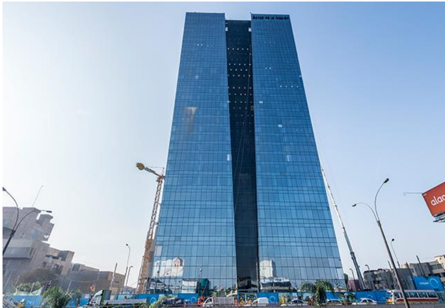
Figura 18. Nueva Sede del Banco de la Nación
