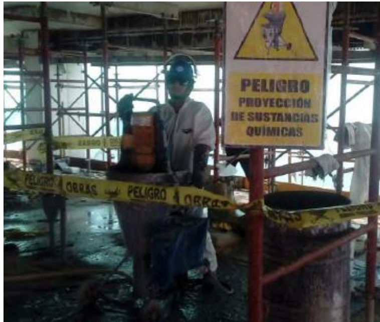
Figura 9. Equipo de inyección
