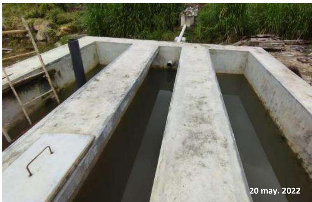
*Nota:* Esta figura muestra el tanque Imhoff lleno de agua hasta su máxima capacidad para la prueba de estaqueidad.
