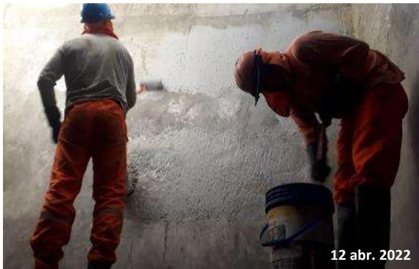
Nota: Esta figura muestra la aplicación de la primera capa con rodillo del Sikalastic - 1K.
