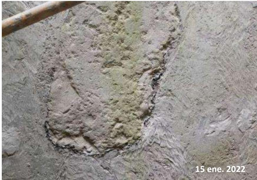
*Nota:* Esta figura muestra los resanes con mortero y brea ejecutados de forma deficiente.
