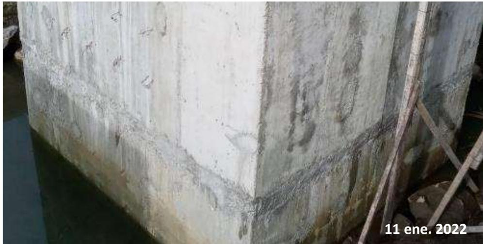
*Nota:* Esta figura exhibe las filtraciones encontradas en la parte inferior del tanque Imhoff.
