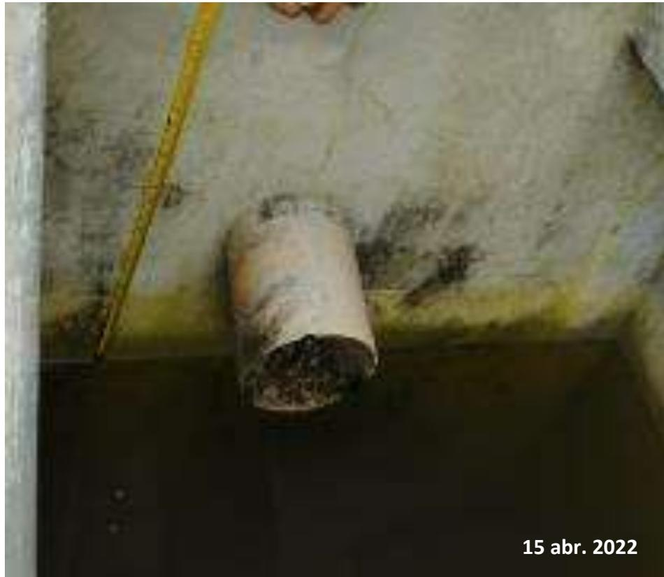
*Nota:* Esta figura muestra la tubería de ingreso de las aguas residuales hacia el tanque Imhoff.
