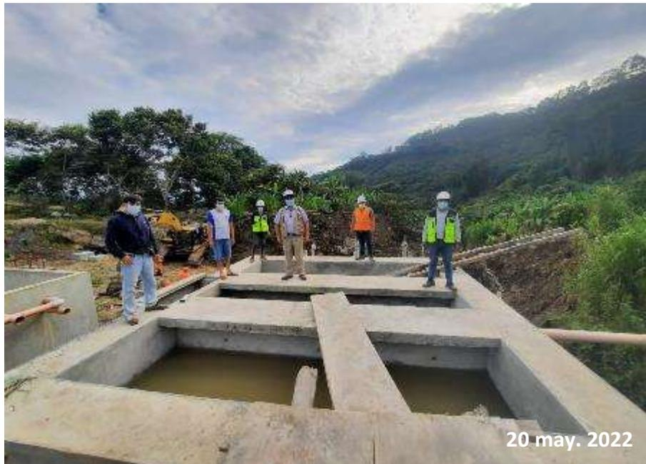
*Nota:* Se muestra la verificación de la prueba de estanqueidad en presencia de la supervisión y residente de obra donde se verificó mediante inspección ocular la no presencia de filtraciones.
