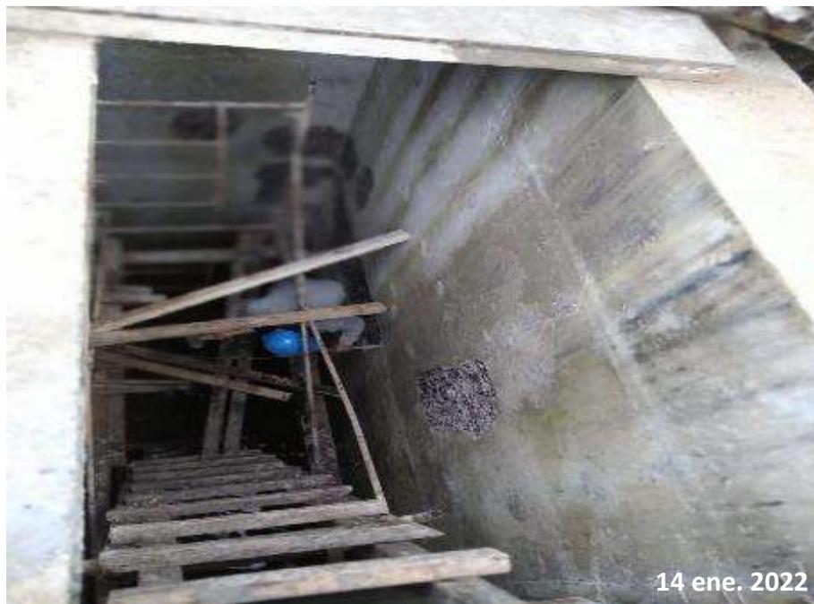
*Nota:* Esta figura muestra las irregularidades de los muros interiores después de la remoción del mortero con brea.
