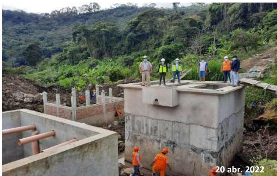
*Nota:* Prueba de estanqueidad en presencia de la supervisión y residente de obra, sin presencia de filtraciones.
