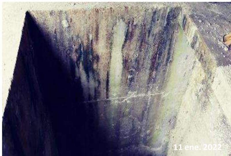
*Nota:* Se muestra el estado en el que se encontraba el tanque Imhoff, toda su superficie cubierta de moho.
