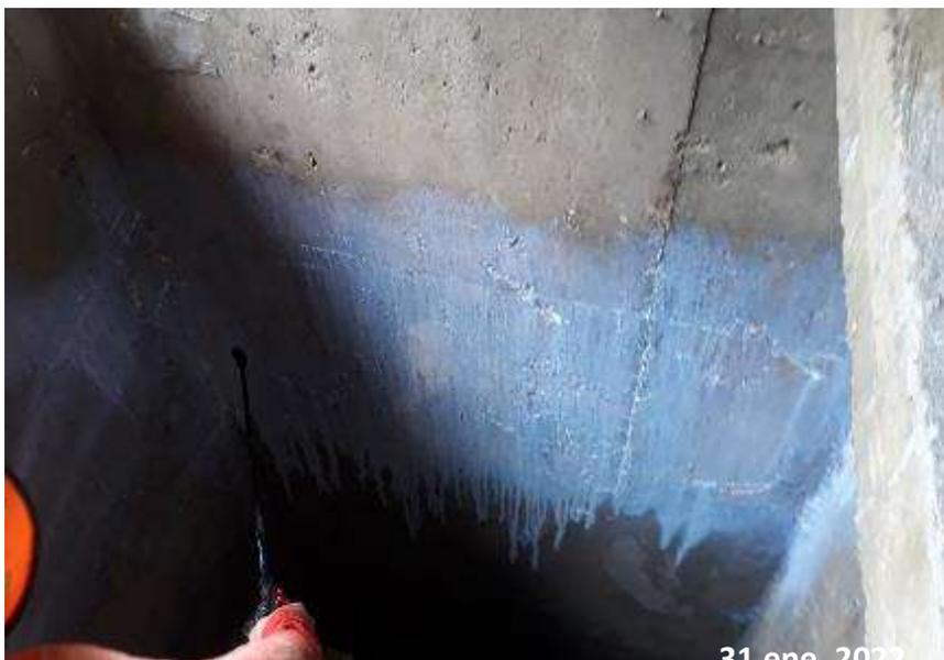
*Nota:* Esta figura muestra la aplicación de Chema Flex al interior de los muros del tanque Imhoff.
