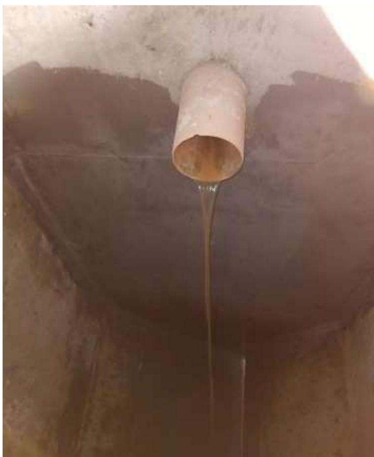
*Nota:* Esta figura muestra el llenado del tanque Imhoff para la realización de la primera prueba hidráulica.
