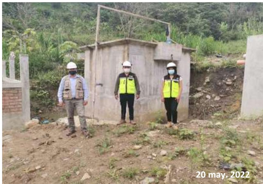
*Nota:* No se visualizan filtraciones en los muros del tanque Imhoff.
