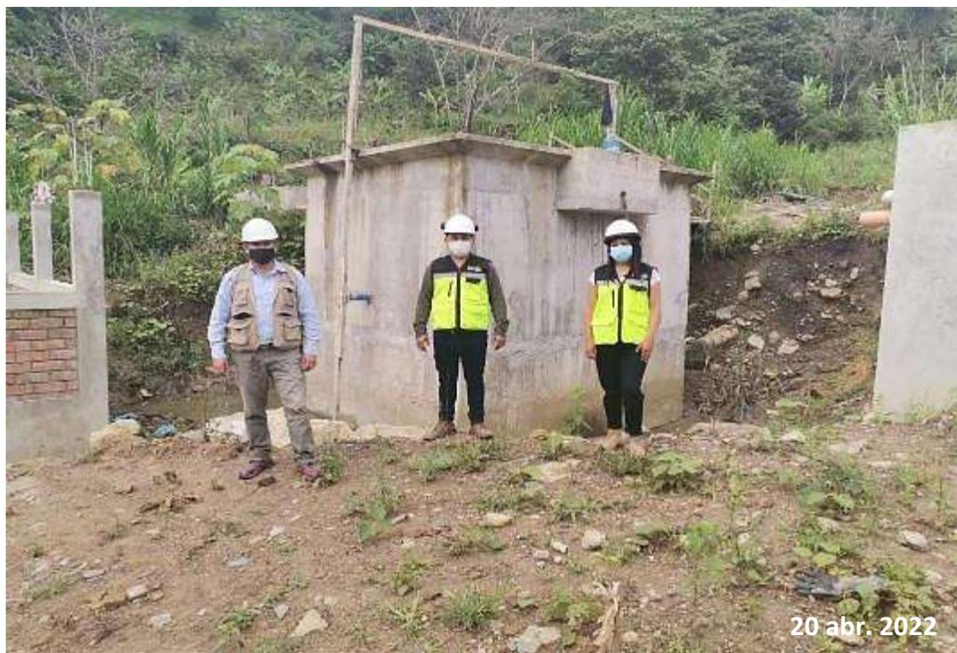
*Nota:* Esta figura presenta la verificación de la prueba de estanqueidad en presencia de la supervisión, residente de obra donde se verifico mediante una inspección ocular la no presencia de filtraciones de agua.
