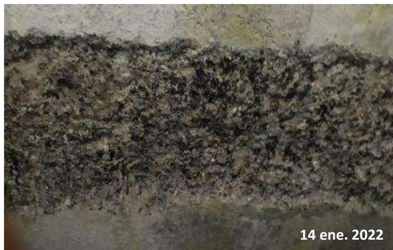
*Nota:* Esta figura muestra la remoción de la brea impregnada en los muros.
