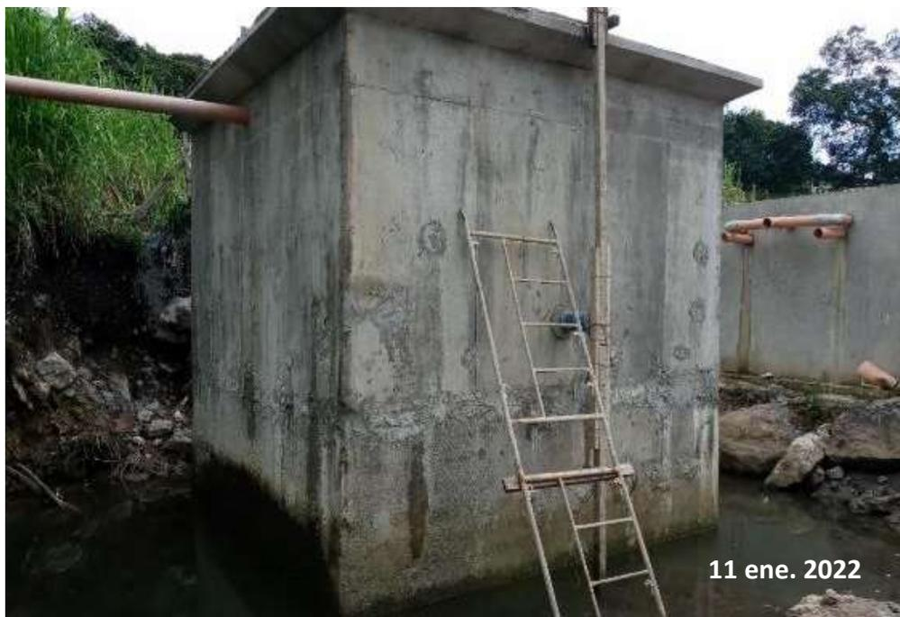
*Nota:* Esta figura exhibe las filtraciones en la parte inferior de los muros del tanque Imhoff donde se genera la mayor presión estática de agua.
