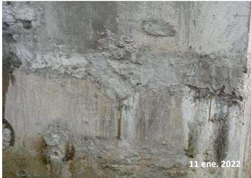
*Nota:* Esta figura muestra las filtraciones en la junta del water stop.
