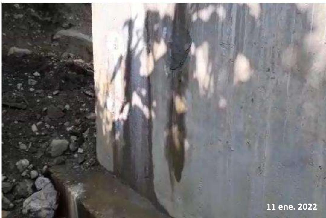
*Nota:* Esta figura exhibe las filtraciones que presentaba el tanque Imhoff en una de sus paredes.
