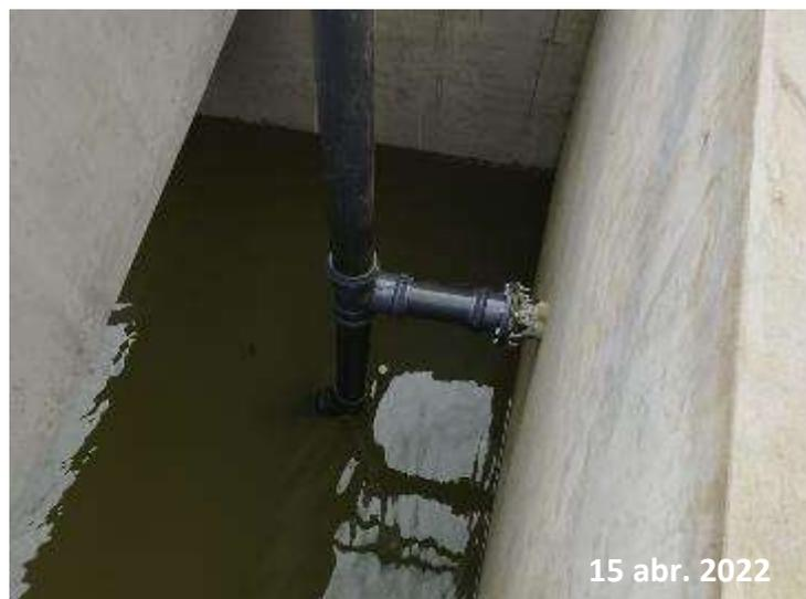
*Nota:* Se aprecia en la figura la cámara de digestión del tanque Imhoff.
