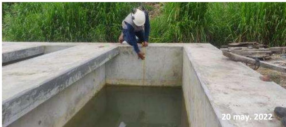
*Nota:* Esta figura muestra la medición del nivel de agua en la cámara de ventilación.
