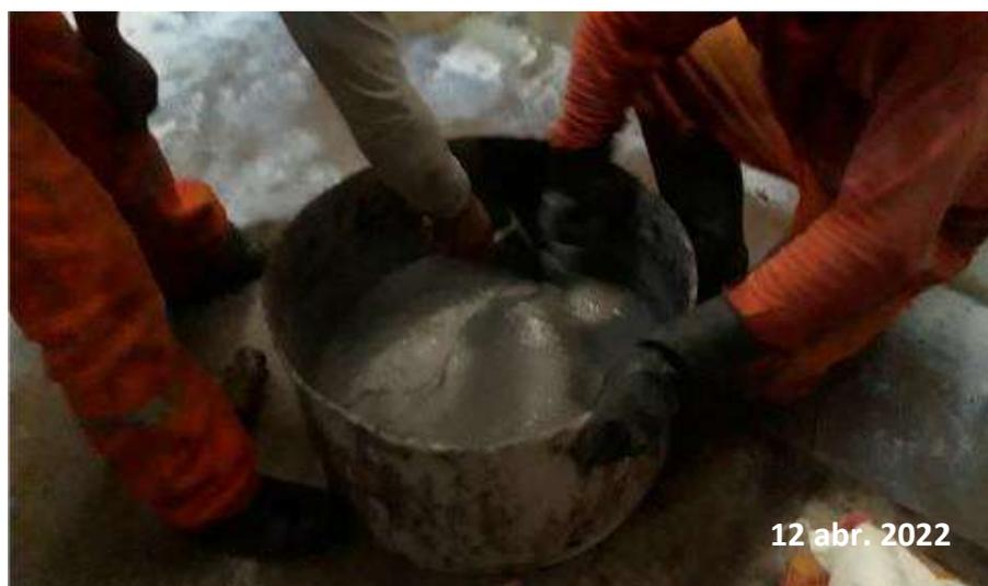
*Nota:* Esta figura muestra la preparación y proceso de mezclado del aditivo Sikalastic - 1K en obra.
