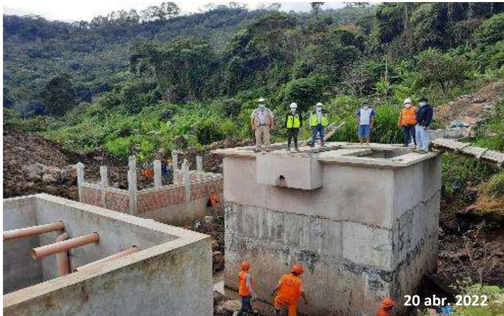
*Nota:* Esta figura muestra la primera prueba hidráulica en presencia de la supervisión, residente de obra y autoridades locales donde se realizó la inspección ocular.
