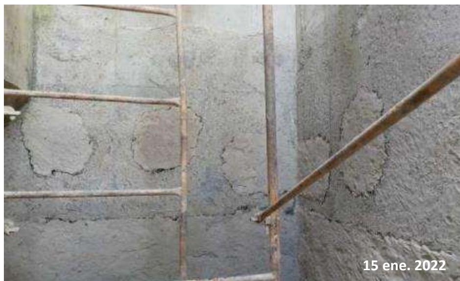
*Nota:* Esta figura muestra los resanes en las paredes internas del tanque.
