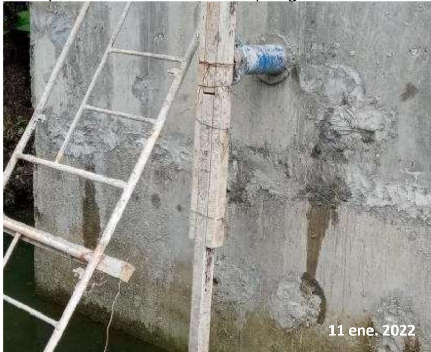
*Nota:* Esta figura exhibe filtraciones debajo de la válvula de expulsión del tanque hacia el lecho de secado.
