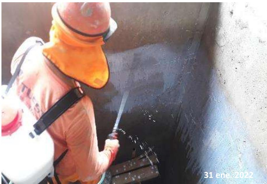
*Nota:* Esta figura muestra la aplicación del Chema Flex con mochila pulverizadora al interior de los muros del tanque Imhoff.
