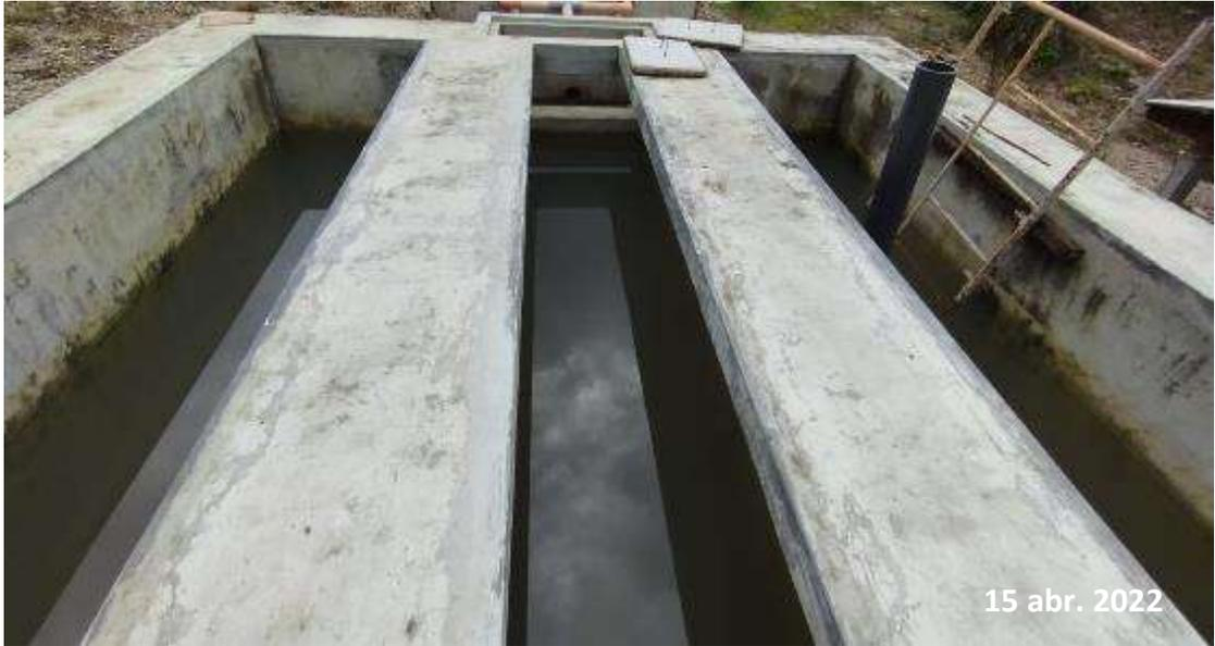
*Nota:* La figura muestra el tanque Imhoff donde se observa la cámara de sedimentación y la cámara de ventilación.
