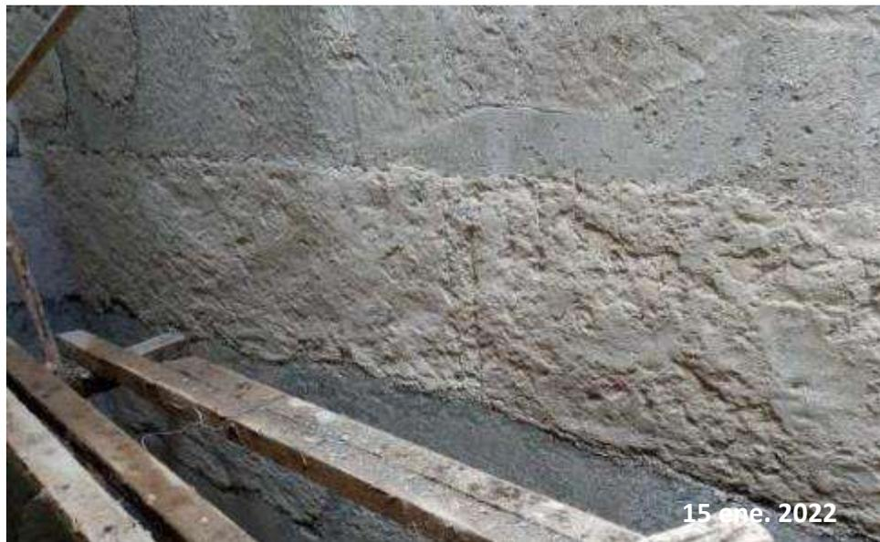
*Nota:* Esta figura muestra los resanes con mortero y brea al nivel del water stop ejecutados de forma deficiente.
