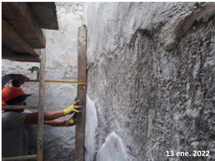
*Nota:* Se observa la medición de las irregularidades en el interior del tanque.
