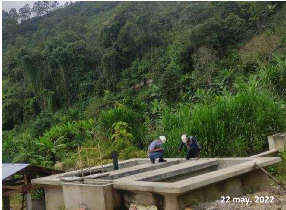
*Nota:* Se observa la medición del nivel de agua en la cámara de sedimentación.
