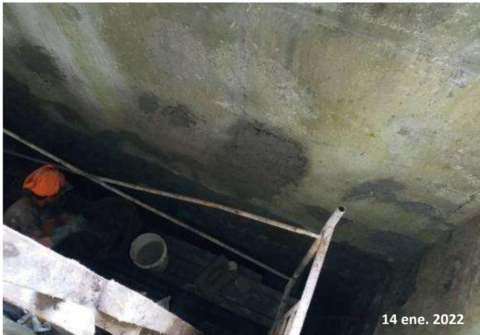
*Nota:* Esta figura muestra el enlucido del mortero con aditivo impermeabilizante en las partes irregulares de los muros del tanque Imhoff.
