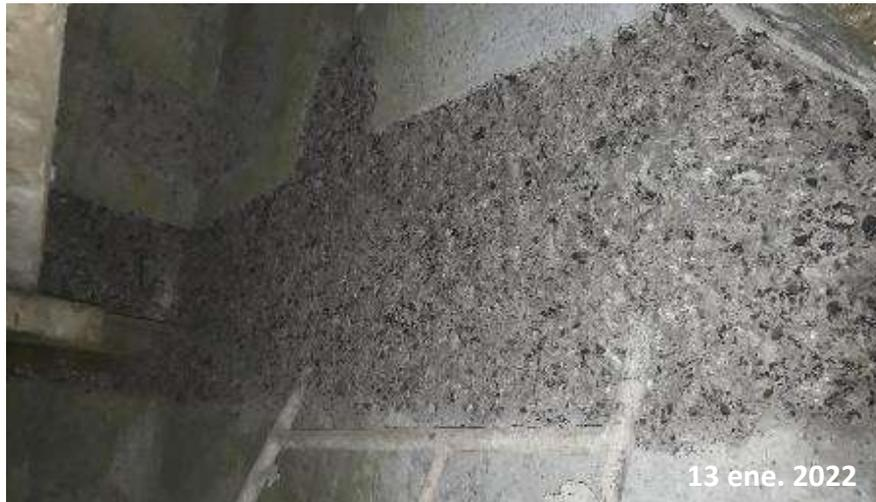
*Nota:* Esta figura muestra la pared del tanque Imhoff con mortero con brea.
