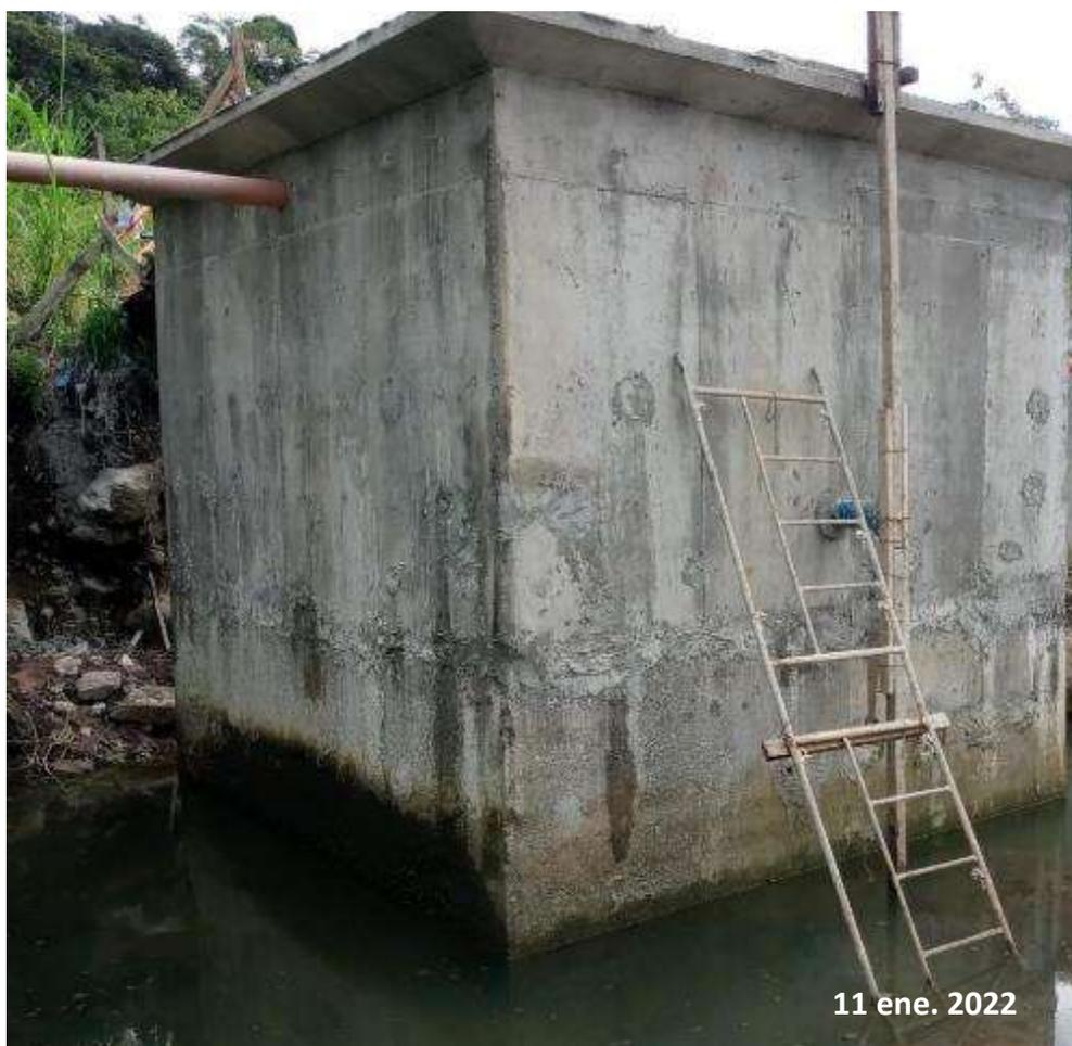
*Nota:* Esta figura muestra algunas filtraciones encontradas en la estructura del tanque Imhoff antes de la intervención.
