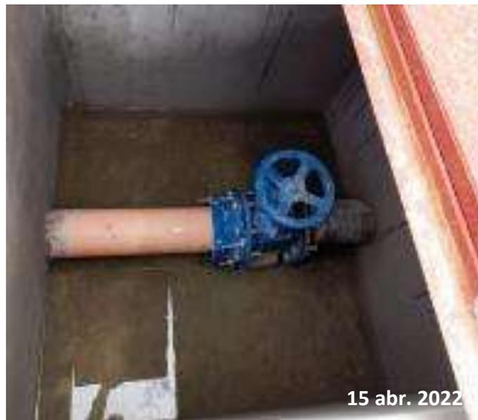
*Nota:* La figura muestra la válvula por donde se expulsarán los lodos hacia el lecho de secado.
