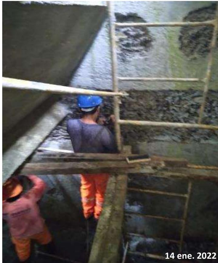
Nota: Esta figura muestra las irregularidades de los muros interiores después de la remoción del mortero con brea.
