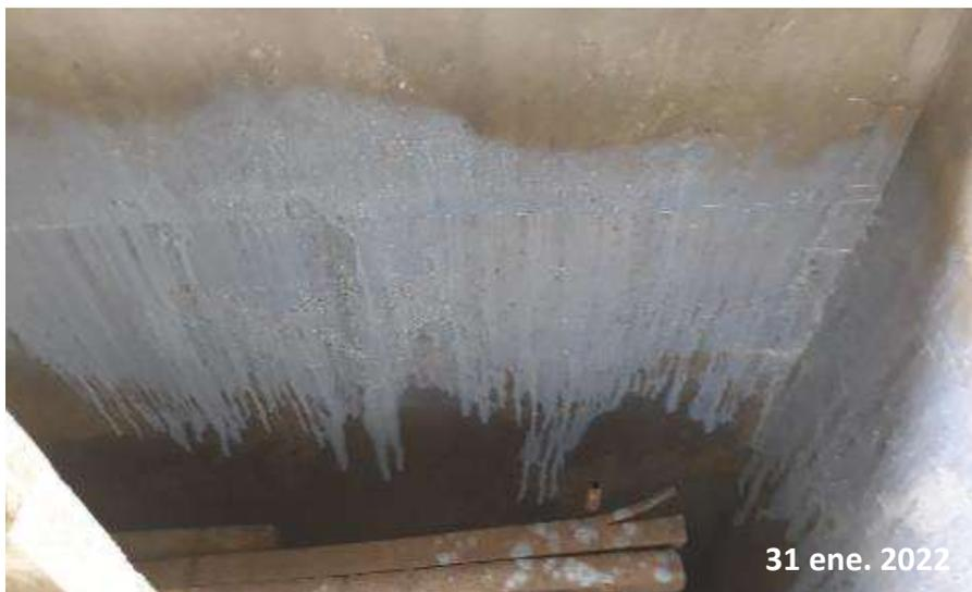
*Nota:* Esta figura muestra la aplicación del Chema Flex al interior de la estructura del tanque Imhoff.
