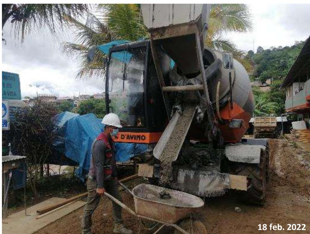
*Nota:* Esta figura muestra la elaboración de concreto en la hormigonera de 3.8 m<sup>3</sup> de capacidad marca Davino.
