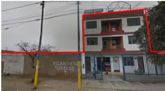
Avenida El Sol
