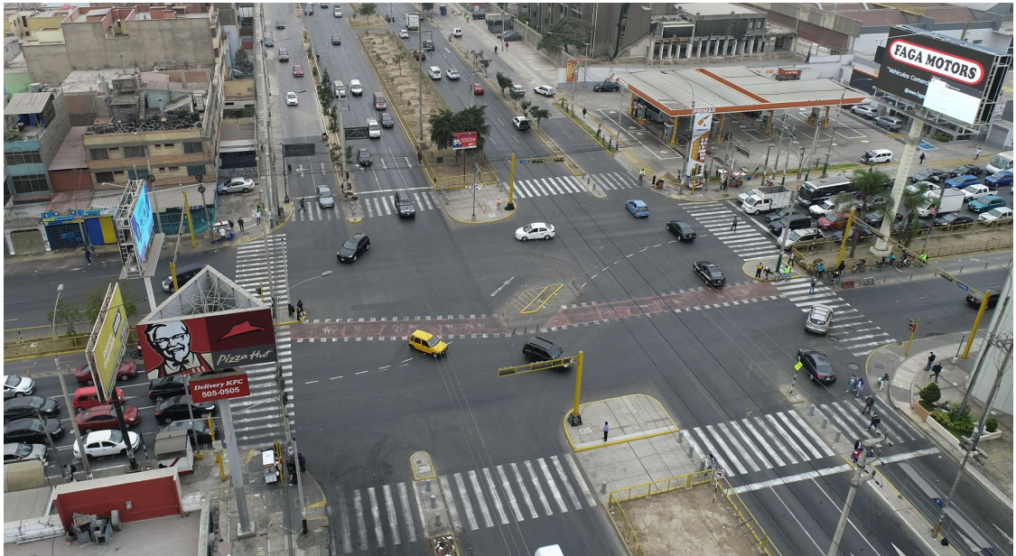
Figura 4. Mala señalización de los carriles de circulación y giro.
