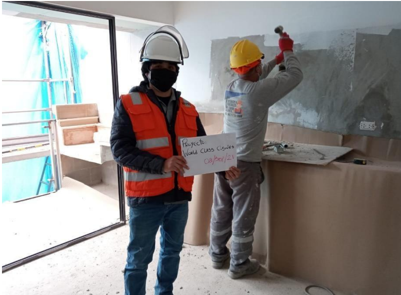
Figura 67: Trabajos en resanes de albañilería
