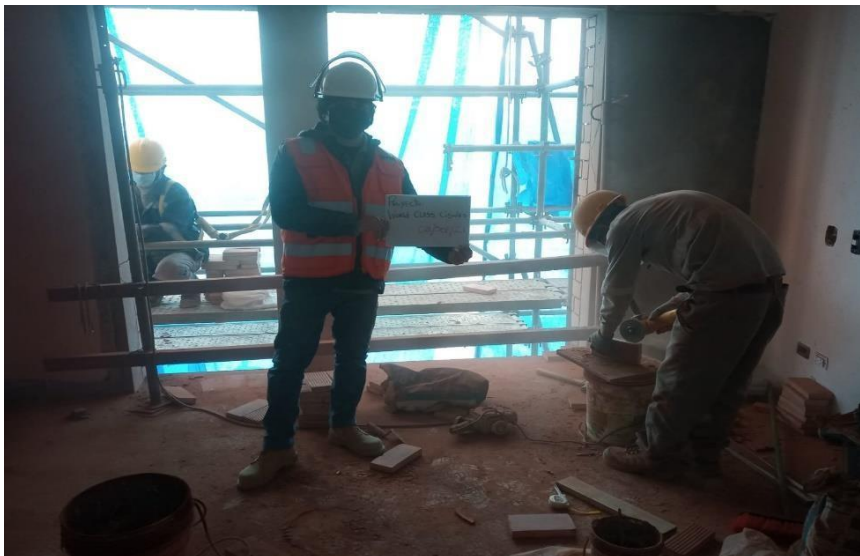
Figura 68: Trabajos en enchape de fachada
