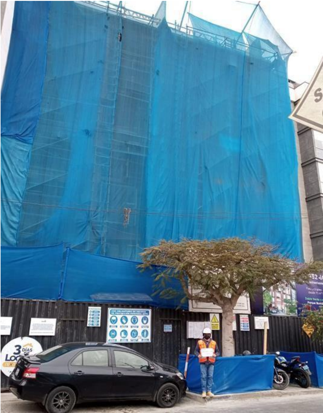
Figura 19. Fachada principal del proyecto en ejecución
