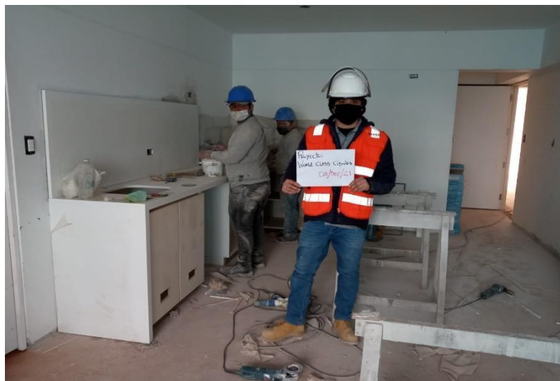
Figura 68: Trabajos de instalación de granitos en cocina
