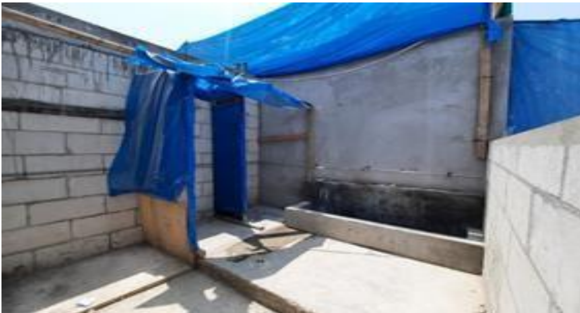
Figura 48: Servicios higiénicos en azotea
