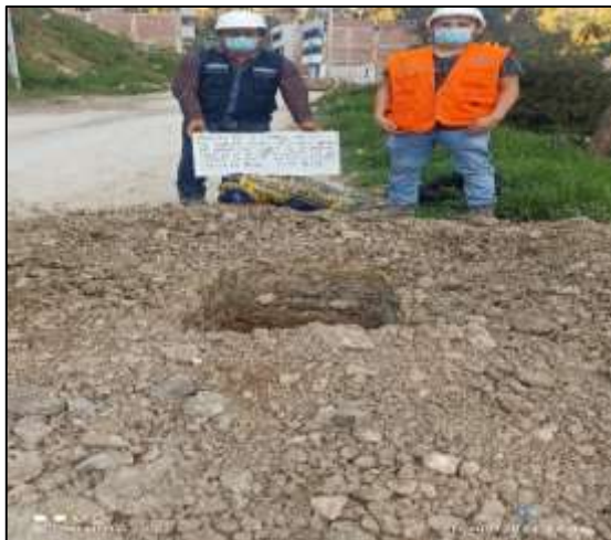
Extracción del material C - 02, progresiva 00+250 km, Av. Agricultura en la ciudad de Chota – región Cajamarca.
