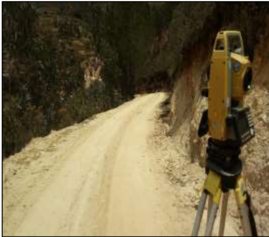
Levantamiento topográfico, progresiva 00+000 km, Av. Agricultura.
