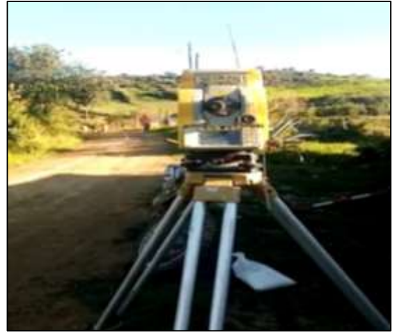
Levantamiento topográfico, progresiva 01+250 km, Av. Agricultura.
