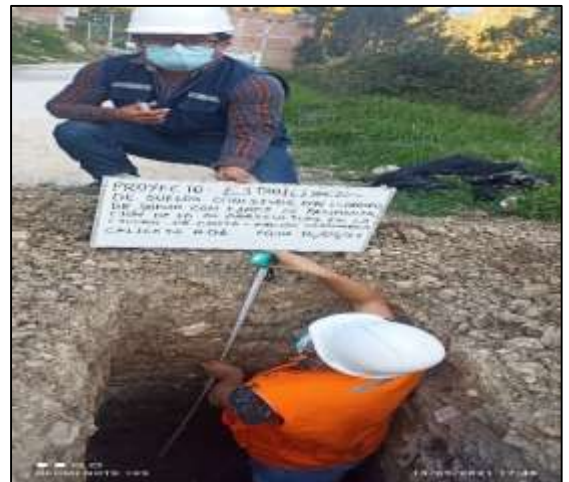
Verificación de la medida de 1.50m de profundidad C -03
