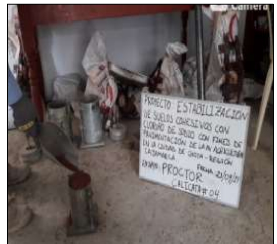
Colocación del material en el molde para la última capa de compactación en la C – 04.
