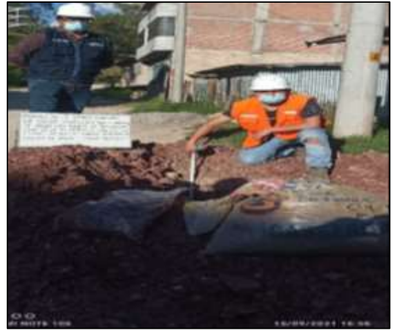
Verificación de la medida de 1.50m de profundidad C -04
