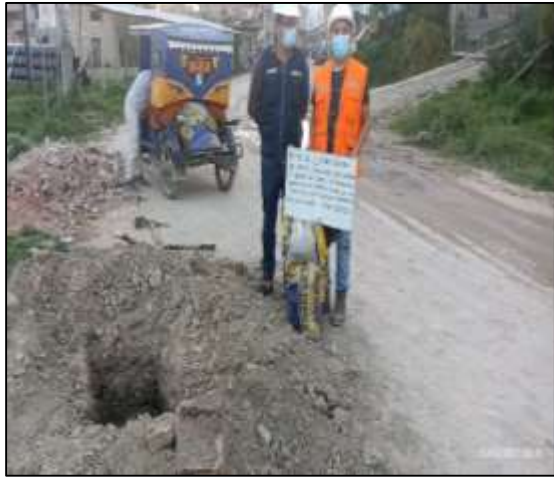
Extracción del material C - 05, progresiva 01+000 km, Av. Agricultura
