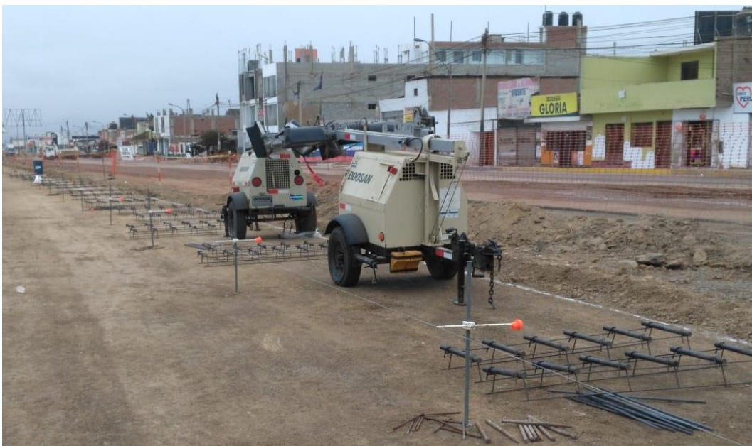
Fotografía 40. Colocación de Dowells – Torres de Luz – Prog. 2+400 margen derecho
