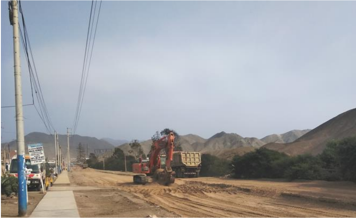
Fotografía 21. Excavación no clasificada para explanaciones – Prog. 11+600
