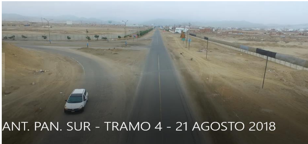
Figura 52. Pavimento flexible – Progresiva 11+400 – 12+300
