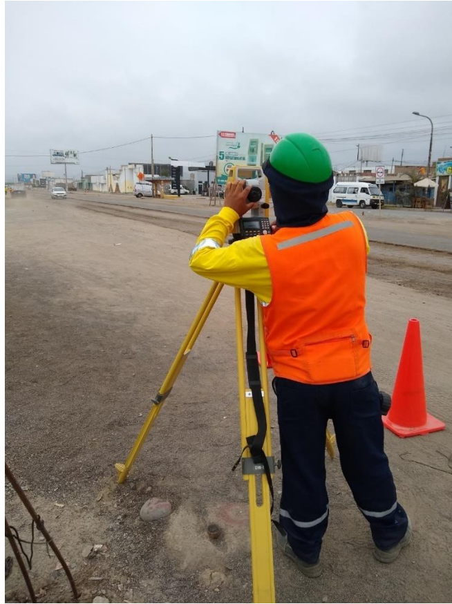
Fotografía 37. Trazo y replanteo – Colocación de Ejes de Vía – Prog. 1+800
