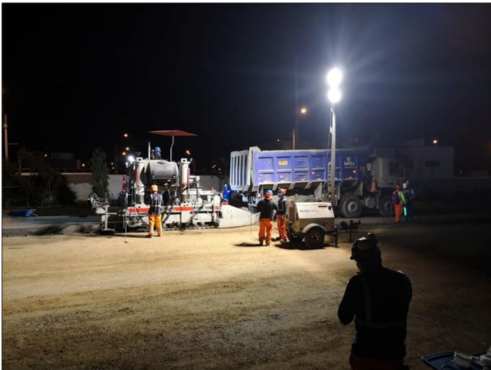
Fotografía 46 Colocación de Concreto con Pavimentadora de encofrado deslizable – Prog. 8+880
