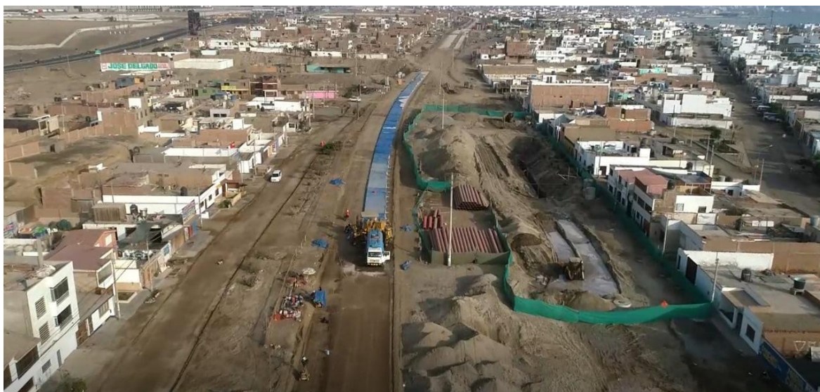
Figura 20. Vuelo dron – progresiva 9+600 – 9+900 – Tramo II
