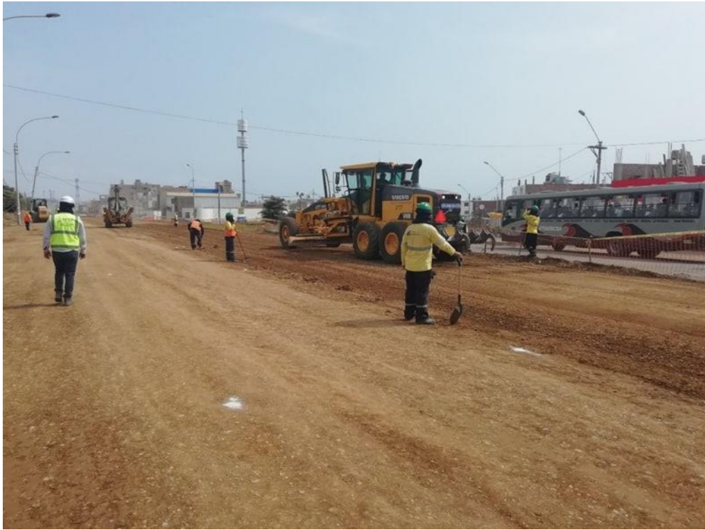
Fotografía 51 Conformación de Sub base Granular – Prog. 4+800
