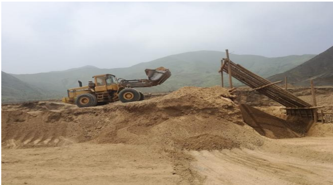
Fotografía 04. Preparación de Material Sub Base granular – Cantera Doris
