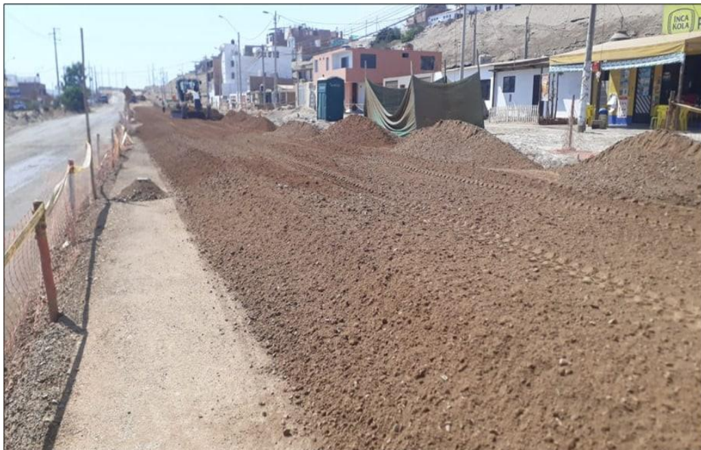
Fotografía 52 Colocación de Material Mejoramiento 7+000
