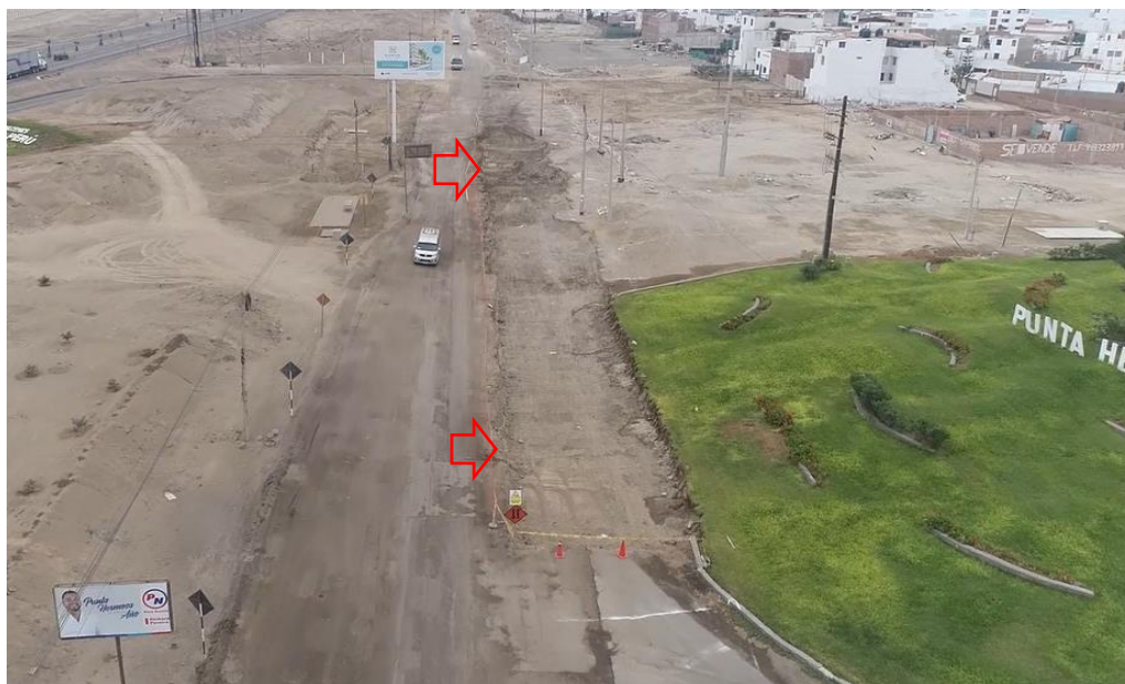
Figura 81. Ejecución de Excavación de Vía Prog. 5+220 – 5+350 MD
