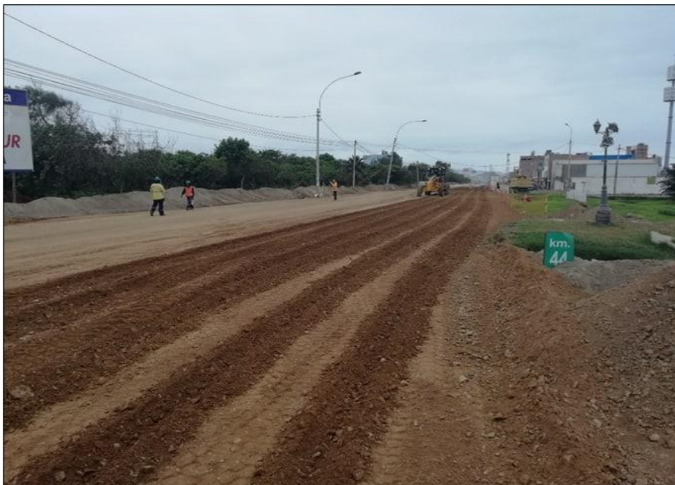
Fotografía 48 Tendido de Material Sub base – Prog. 4+700
