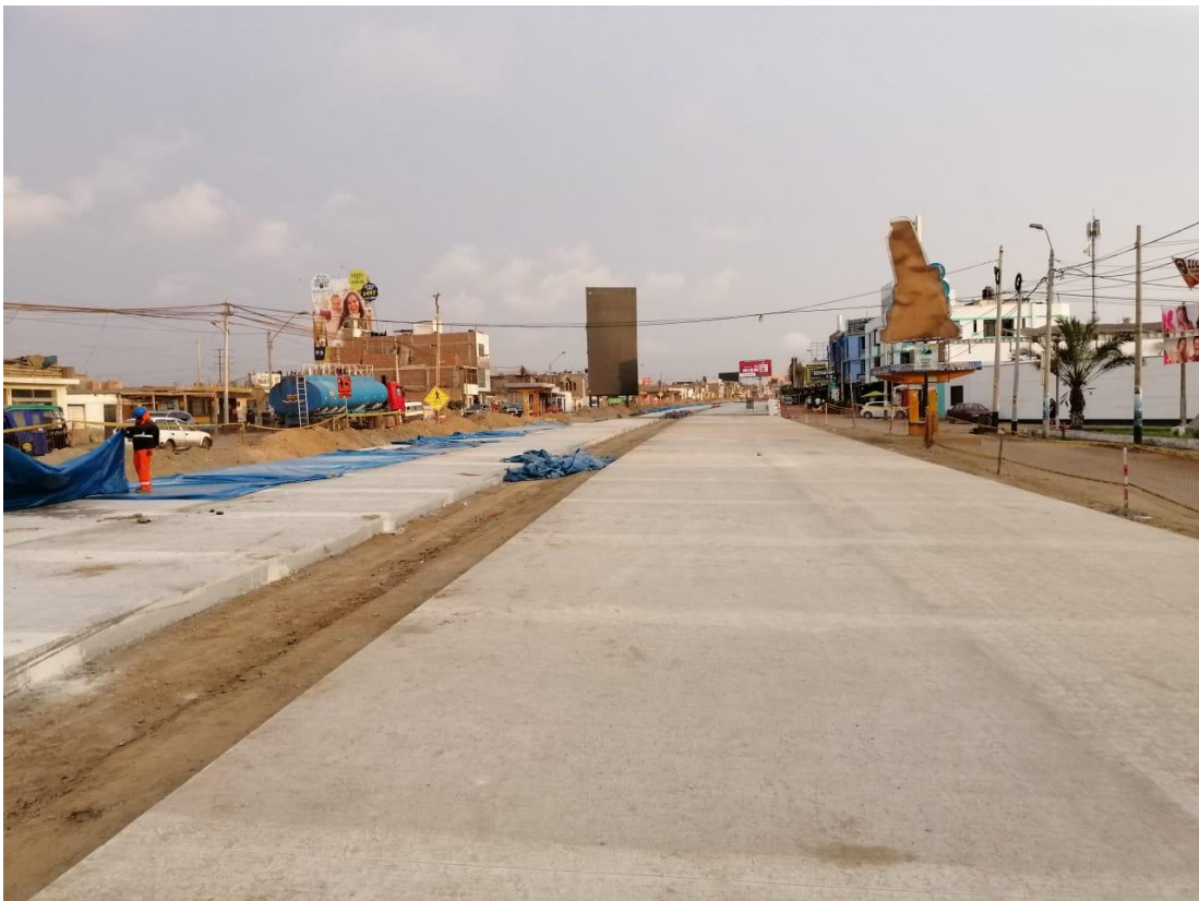
Fotografía 16. Pavimento Rígido ancho 7.20 m. – Prog. 2+400
