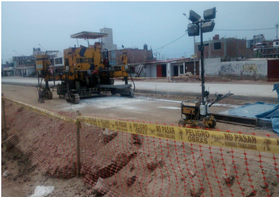
Fotografía 14. Movilización de Pavimentadora – Prog. 2+350 Margen Izquierdo
