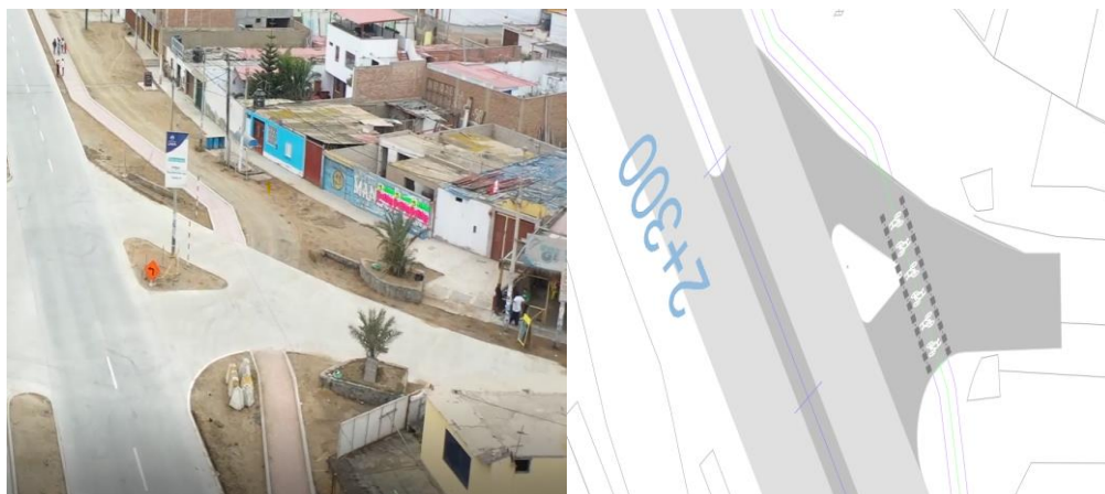
Figura 93. Gestión Visual - Tren de trabajo Pav. Rígido Prog. 2+300
