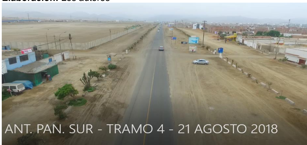
Figura 51. Pavimento flexible – Progresiva – 9+400 – 10+120
