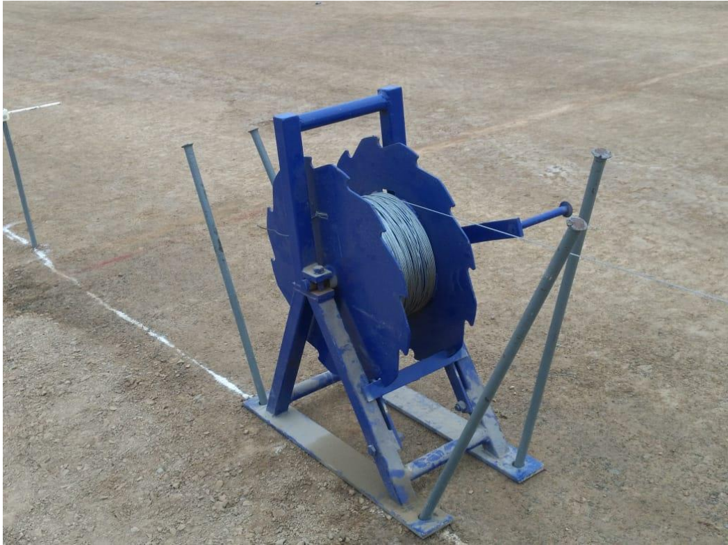
Fotografía 43. Colocación de Líneas guía para Pavimentadora
