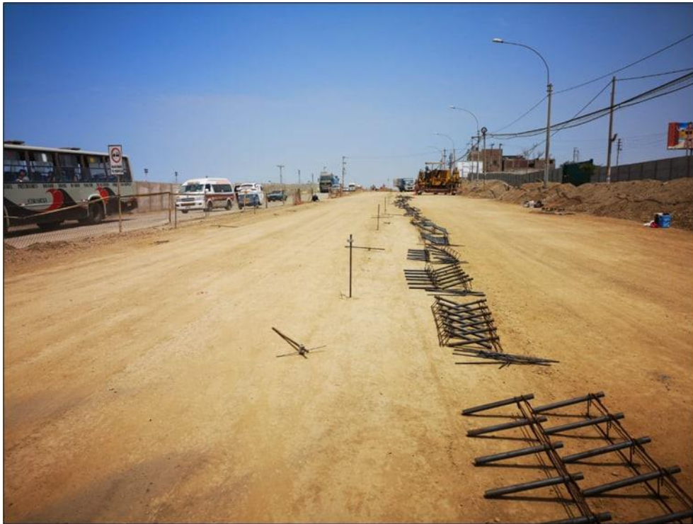
Fotografía 47 Balizado y colocación de Líneas Guía – Prog. 5+800
