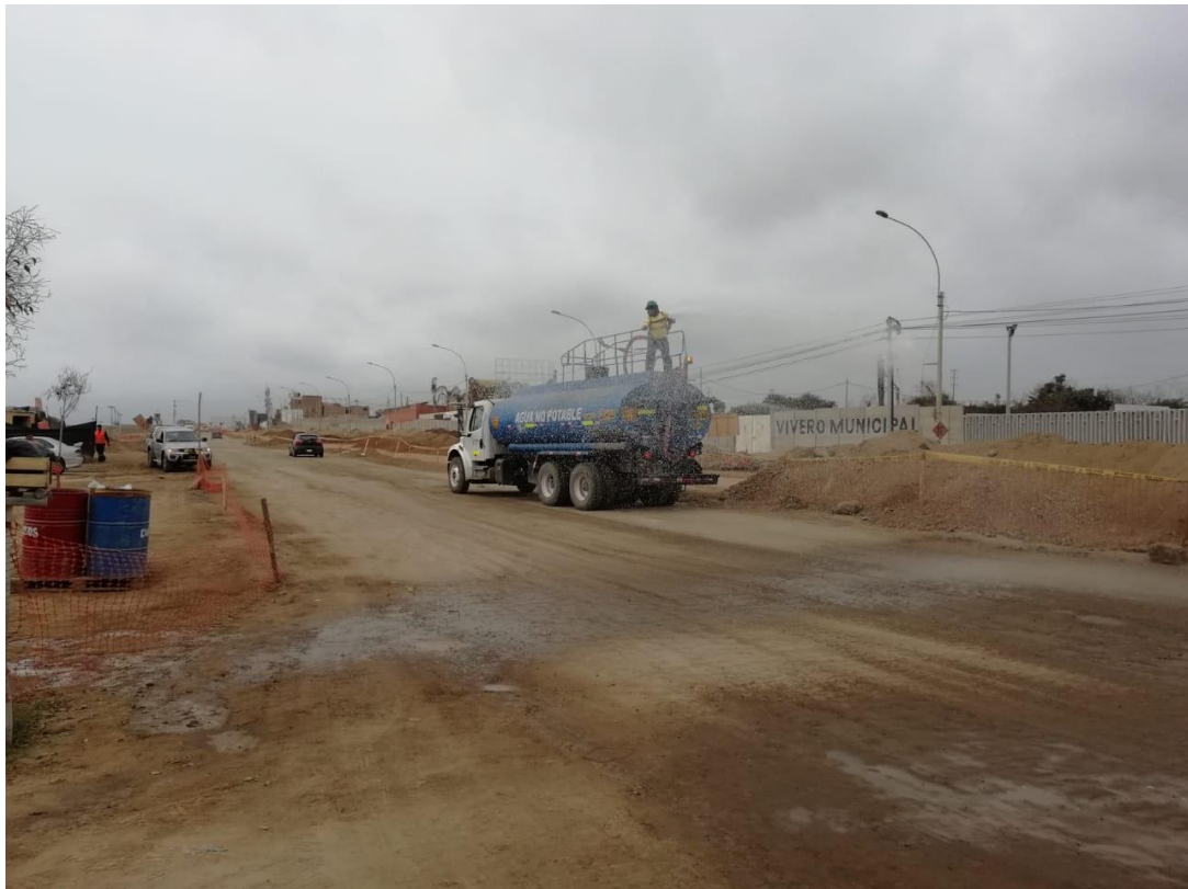
Fotografía 24. Hidratación de Plataforma Sub base – Prog. 7+800 marg. derecho
