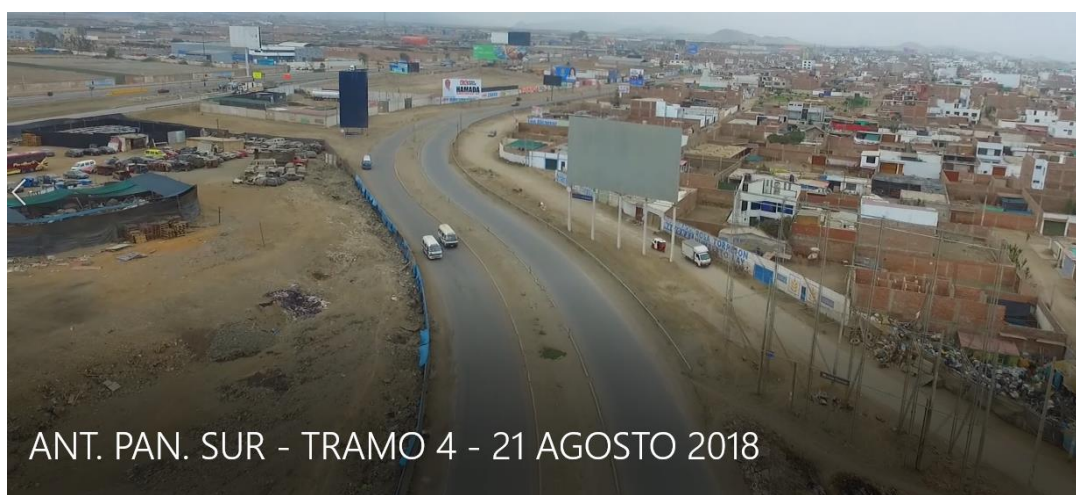
Figura 42. Pavimento flexible – Progresiva 0+820 – 1+200
