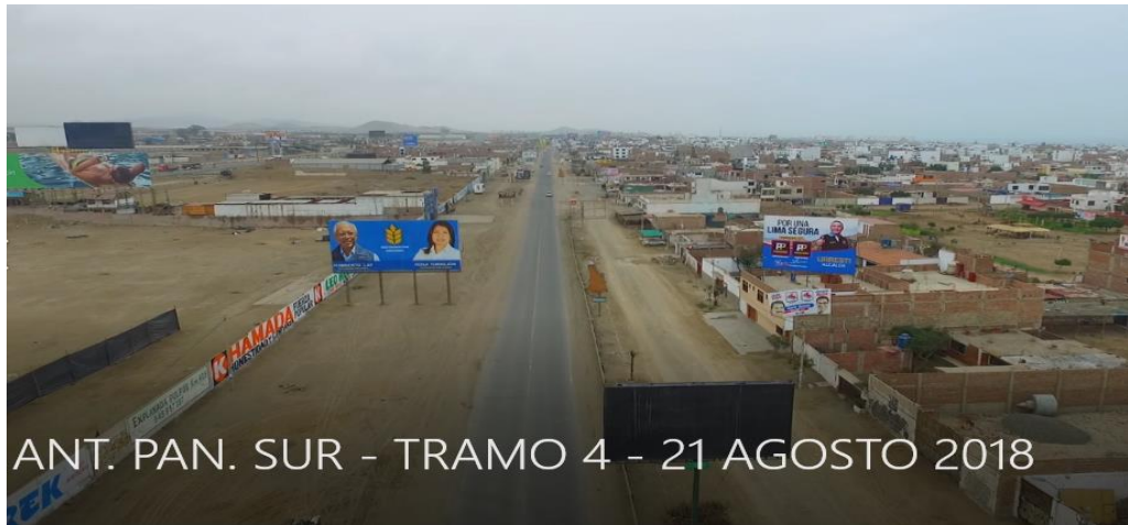
Figura 43. Pavimento flexible – Progresiva 1+300 – 1+600
