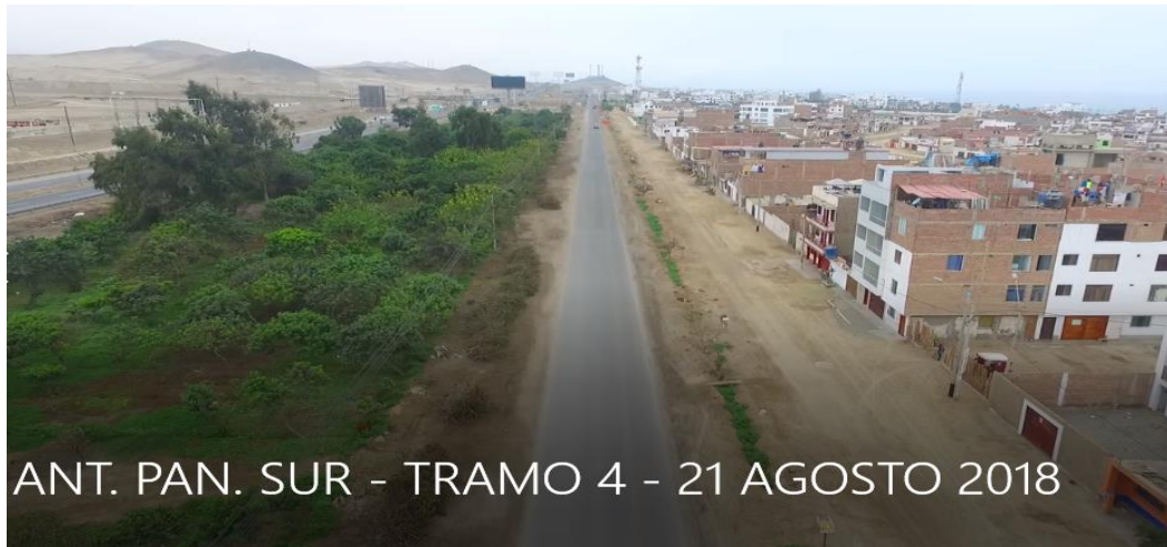
Figura 46. Pavimento flexible – Progresiva 4+400 – 4+900
