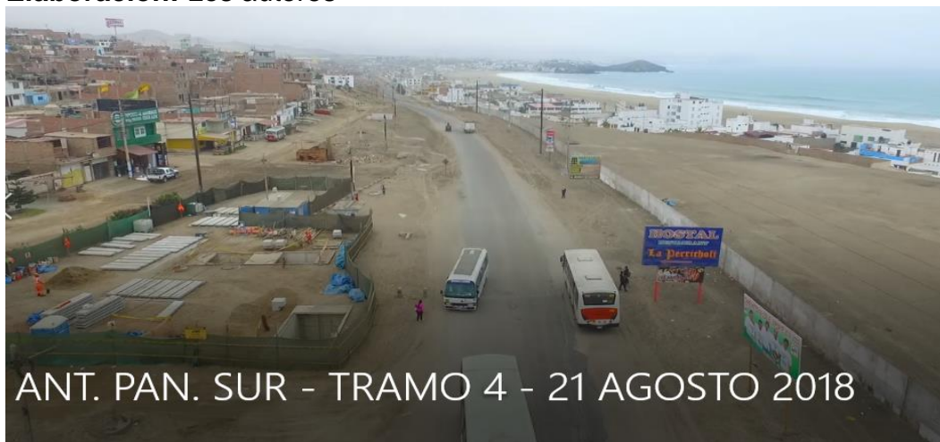
Figura 50. Pavimento flexible – Progresiva – 7+100 – 7+820
