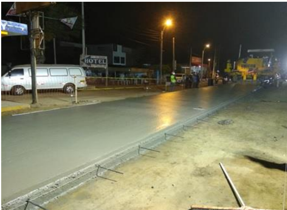
Fotografía 18. Pavimentadora de Encofrado Deslizante Wirtgen – Prog. 3+300
