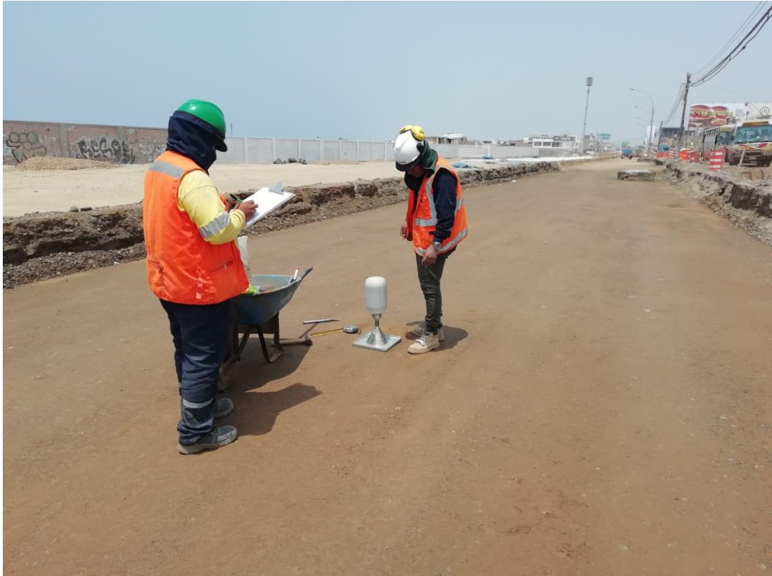
Fotografía 23. Ensayo Densidad de campo 1era Capa Mejoramiento Prog. 4+100
