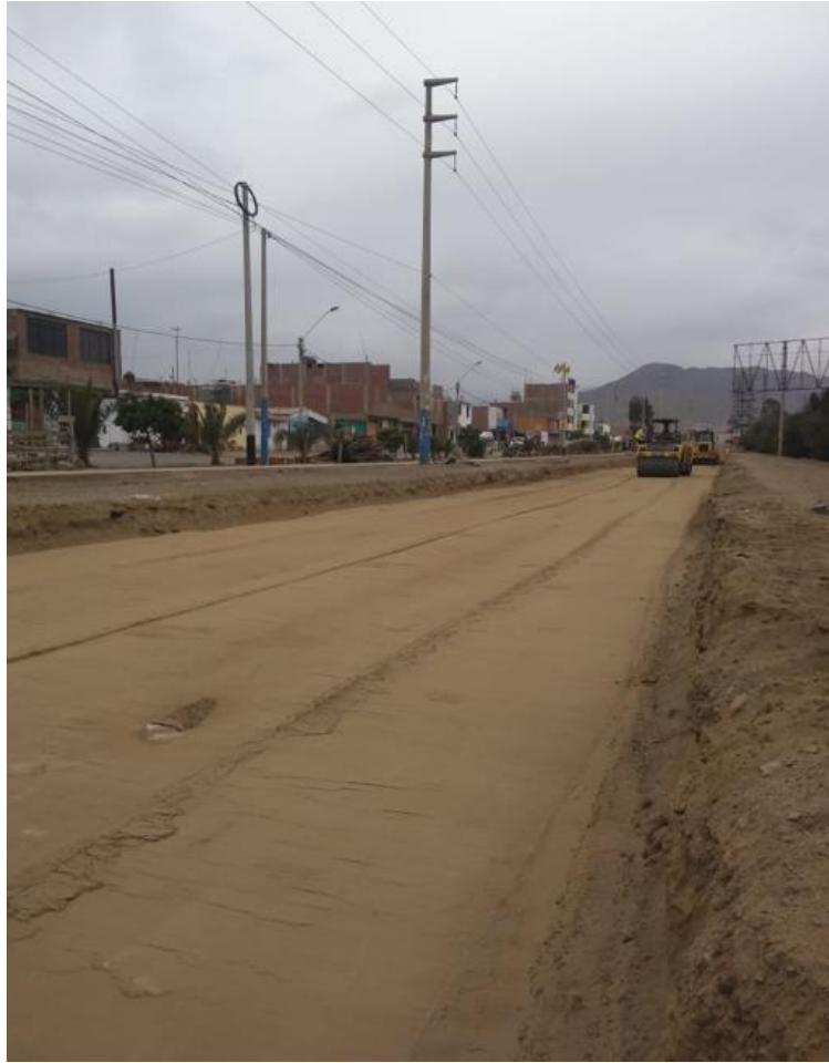
Fotografía 25. Compactación de Subrasante – Prog. 12+350
