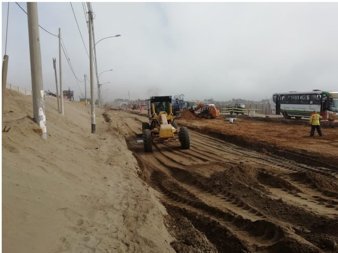
Fotografía 22. Conformación de Subrasante – Prog. 9+400 margen Izquierdo
