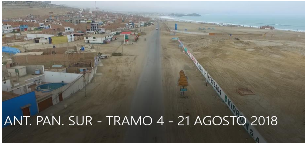
Figura 49. Pavimento flexible – Progresiva – 7+100 – 7+450
