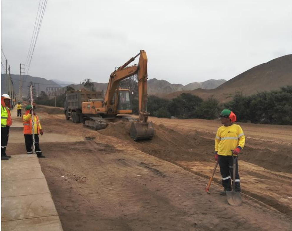
Fotografía 19. Excavación no clasificada para explanaciones – Excavadora tipo Oruga – Prog. 13+000
