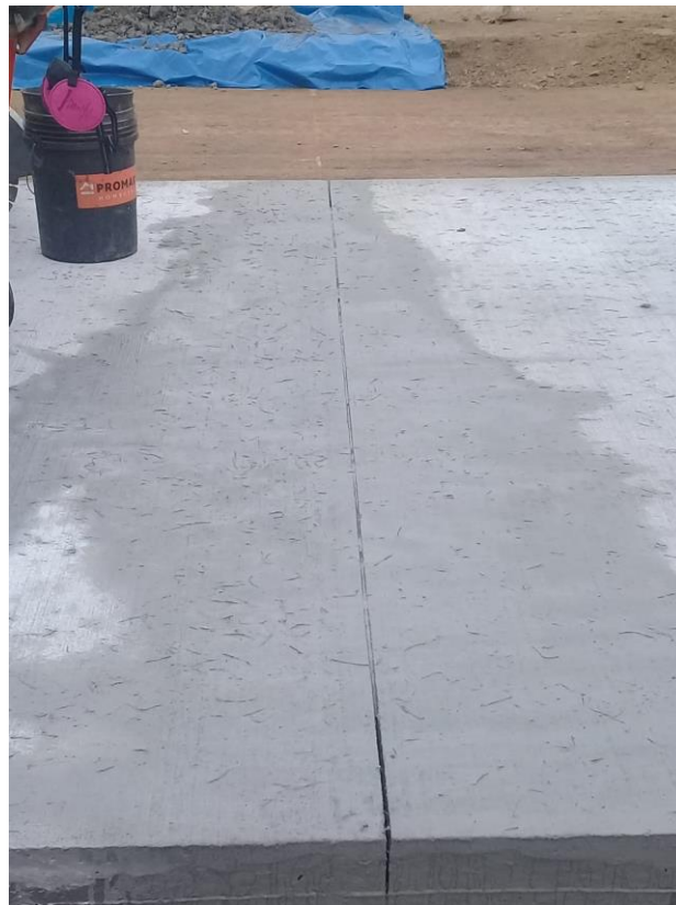
Fotografía 44 Corte de junta Transversal de 6mm. En Pavimento Rígido
