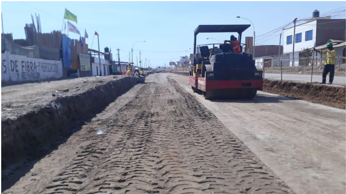
Fotografía 38. Compactación de Subrasante – Prog. 9+100 margen derecho
