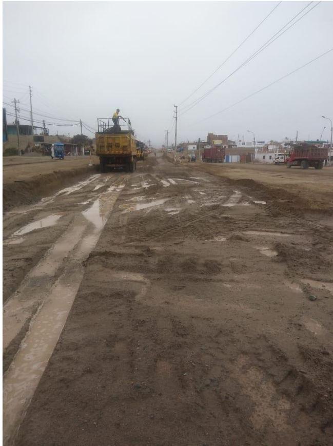
Fotografía 39. hidratacion con Cisterna capa Subrasante – Prog. 10+600
