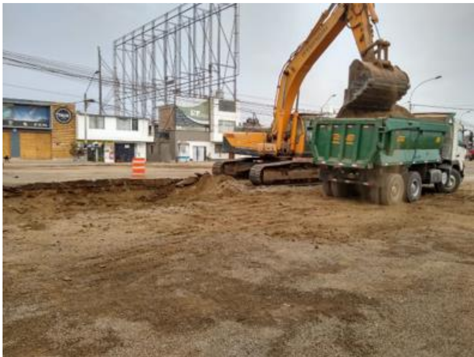
Fotografía 20. Excavación no clasificada para explanaciones – Excavadora tipo Oruga – Prog. 3+800
