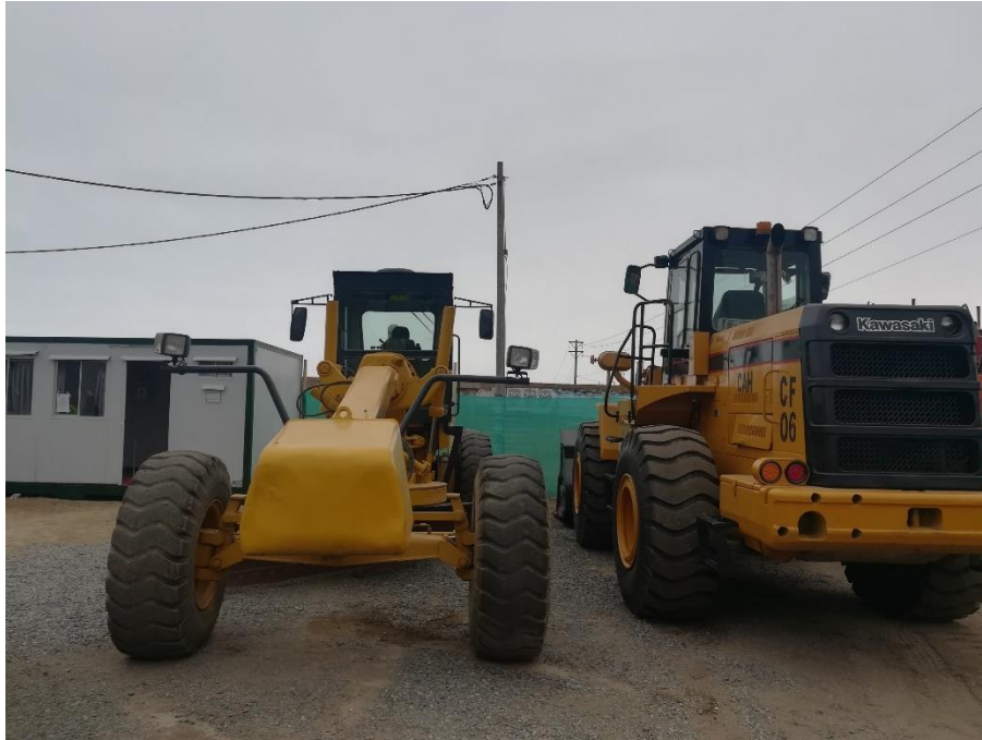
Fotografía 35. Equipo Movimiento de Tierras – Motoniveladora – Cargador Frontal
