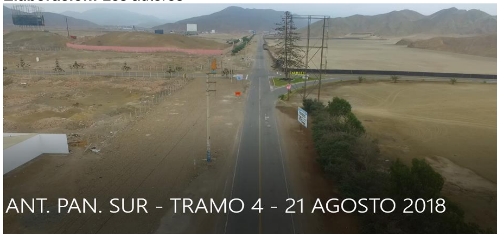
Figura 54. Pavimento flexible – Progresiva 14+200 – 14+600
