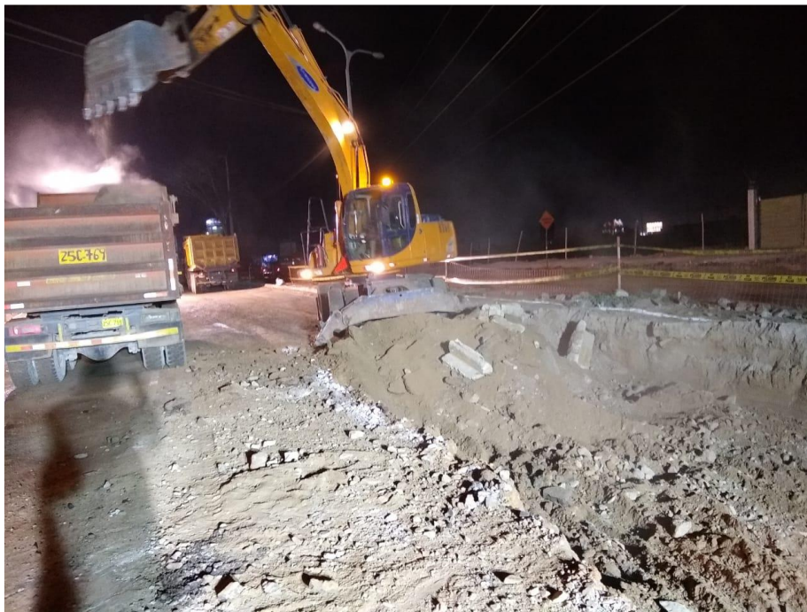
Fotografía 36. Excavación no clasificada para explanaciones – Turno noche – Prog. 0+300 Margen derecho
