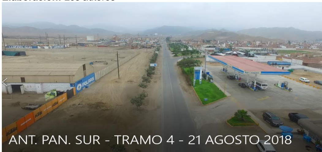
Figura 53. Pavimento flexible – Progresiva 12+300 – 12+800
