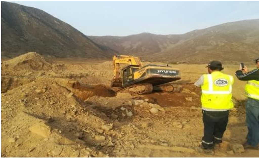
Fotografía 03. Preparación Material Mejoramiento de Subrasante – Cantera Doris
