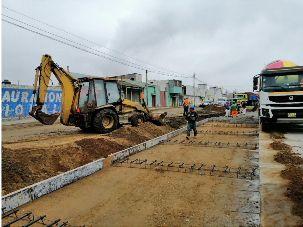
Fotografía 45 Dowells de Acero Liso 1 ¼" en paraderos – Prog. 1+400
