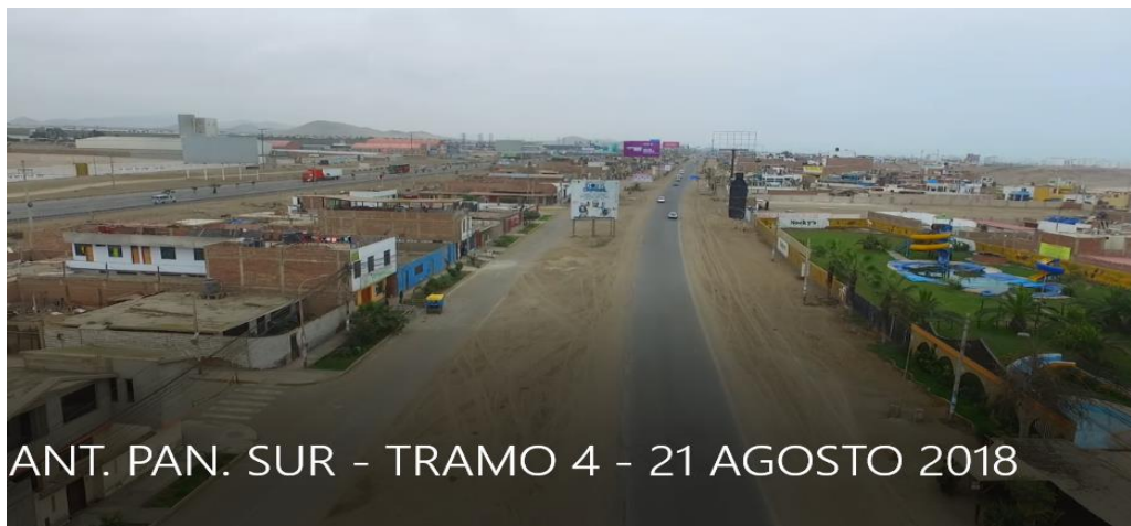
Figura 44. Pavimento flexible – Progresiva 2+000 – 2+400
