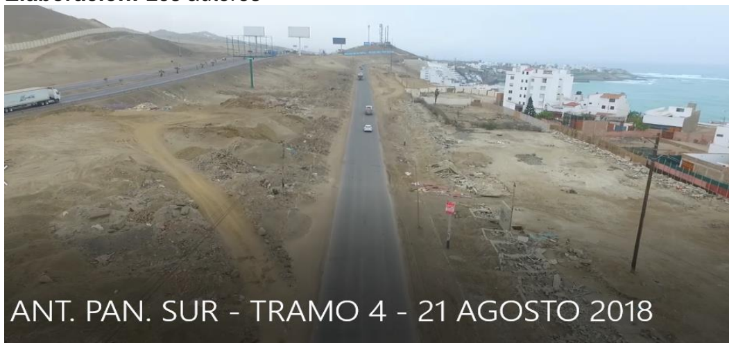
Figura 47. Pavimento flexible – Progresiva 5+250 – 5+900
