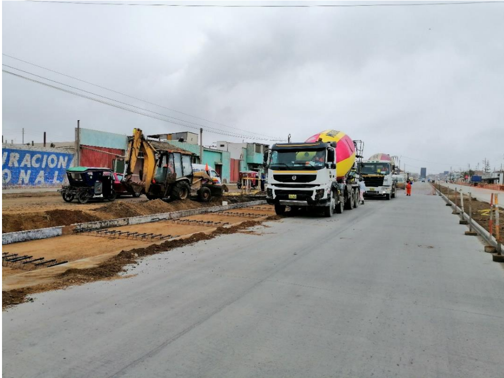
Fotografía 17. Colocación de Pavimento Rígido en Paraderos – Prog 1+400 Margen Izquierdo
