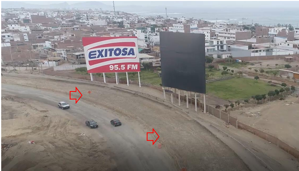
Figura 79. Ejecución de Excavación de Vía Prog. 0+500 – 1+000 MD
