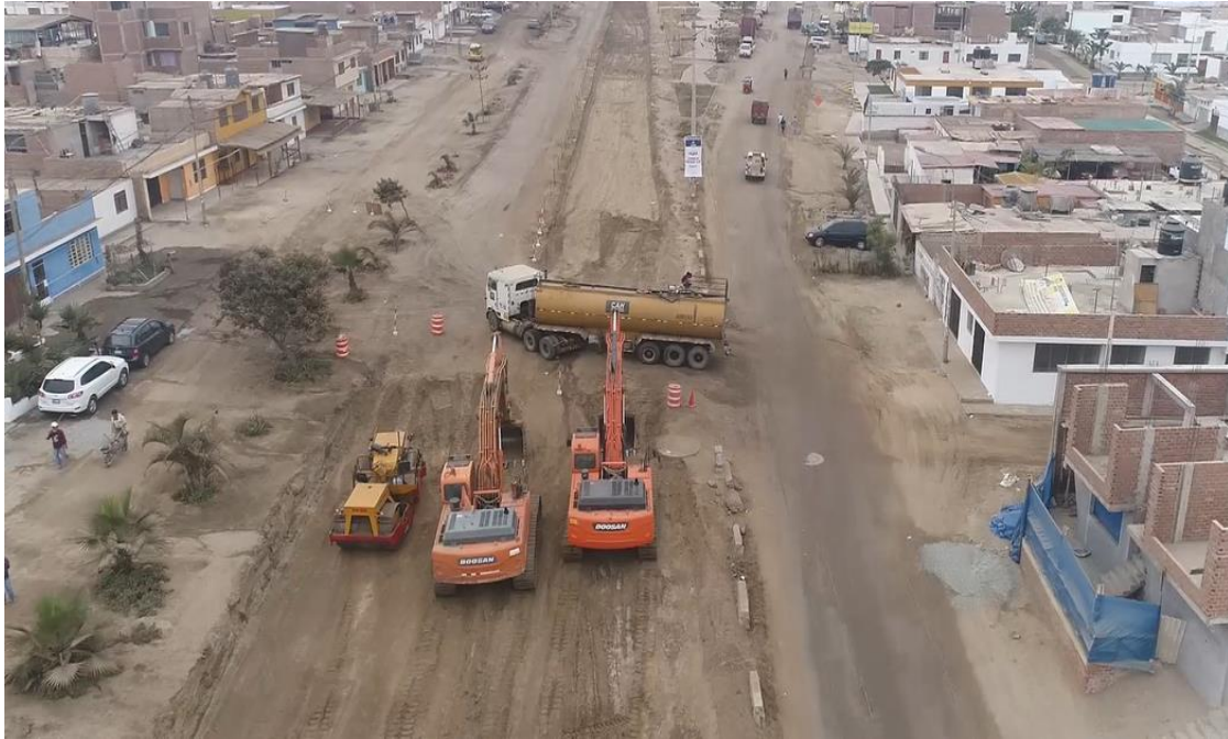
Figura 86. Equipos esperando frente de Trabajo Prog. 9+500
