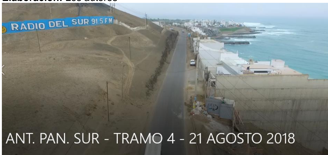
Figura 48. Pavimento flexible – Progresiva 6+100 – 6+250
