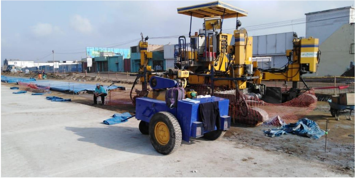
Fotografía 09. Ubicación de Pavimentadora 1+700
