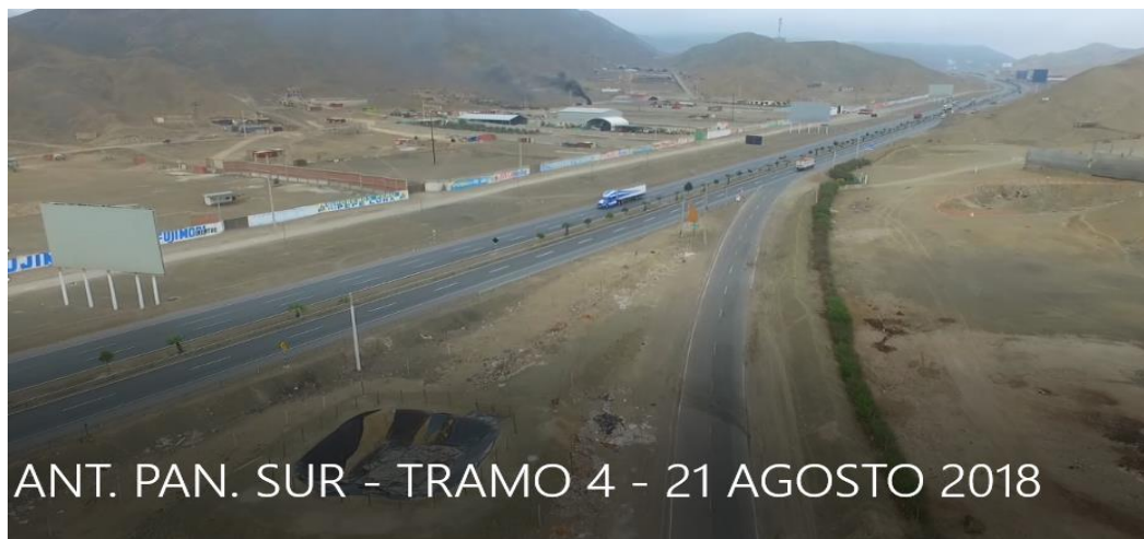
Figura 55. Pavimento flexible – Progresiva 15+300 – 15+601
