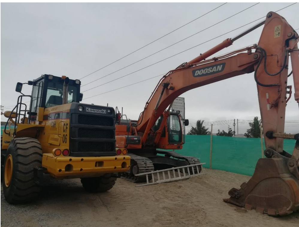
Fotografía 34. Equipo de Movimiento de Tierras – Cargador Frontal – Excavadora tipo Oruga
