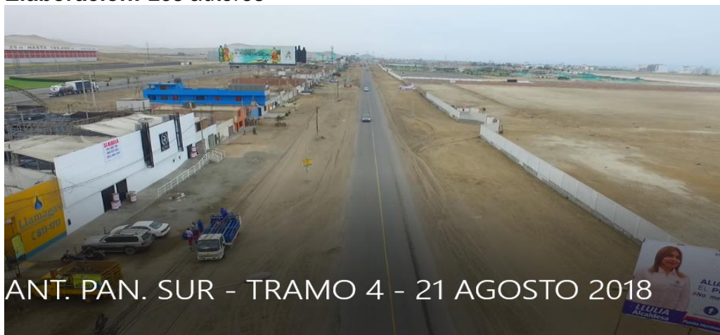
Figura 45. Pavimento flexible – Progresiva 3+300 – 4+000
