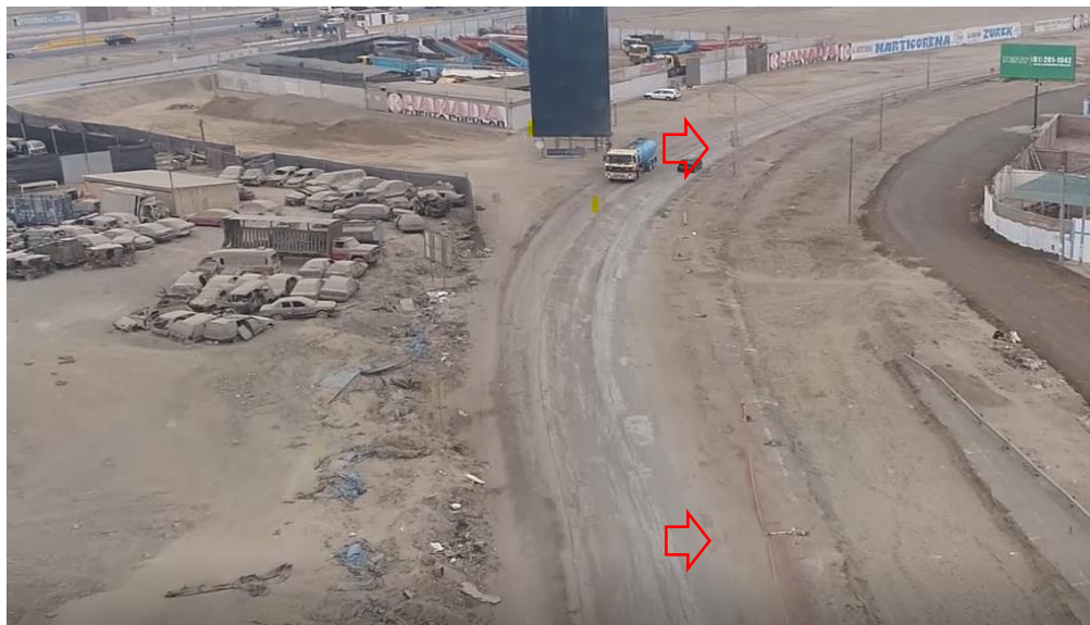
Figura 80. Ejecución de Excavación de Vía Prog. 0+900 – 1+150 MD
