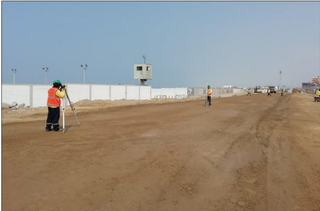
Fotografía 49 Liberación de Cotas Capa Sub base Prog. 4+300
