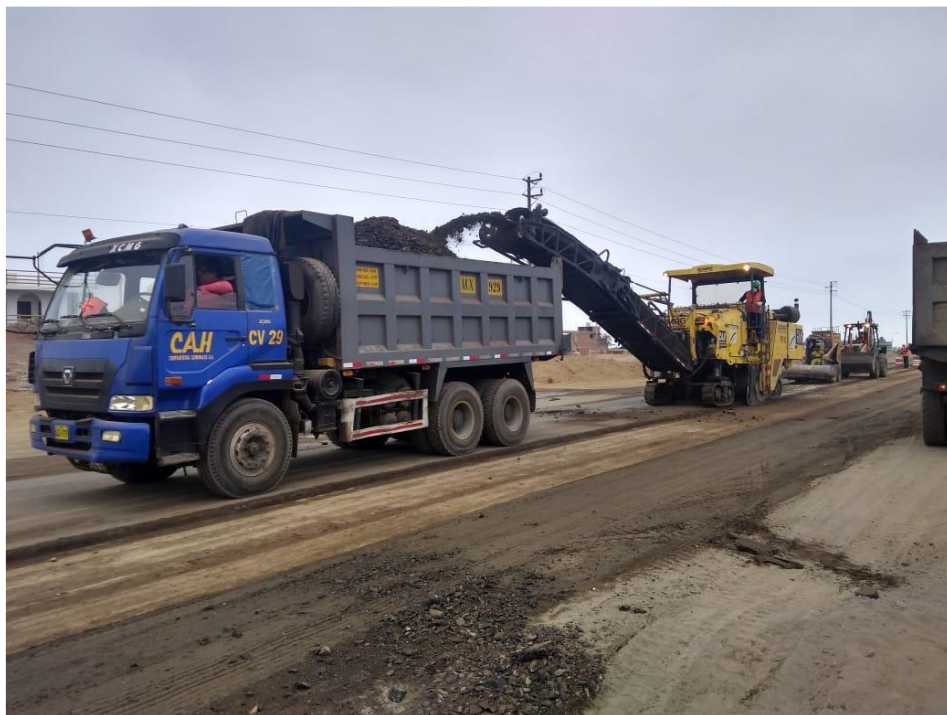
Fotografía 26. Fresado de Asfalto existente E = 2" – Prog. 8+500
