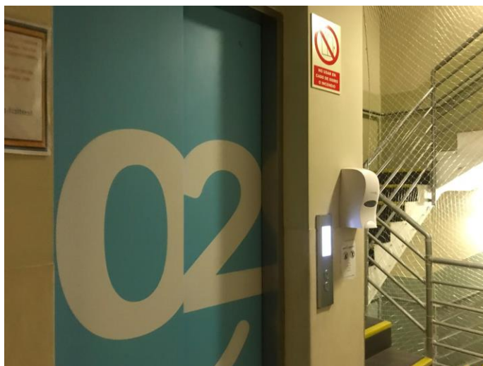
Figura 31: Elevador y Escaleras de Emergencia, Casa Magia
