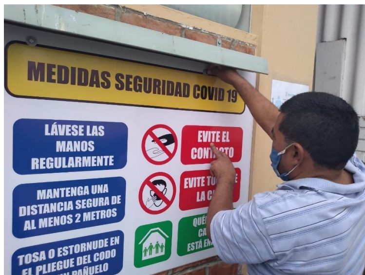
Colocación de señalética de seguridad
