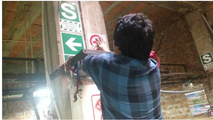
Figura QQQ 16. Colocación de señales de Seguridad
