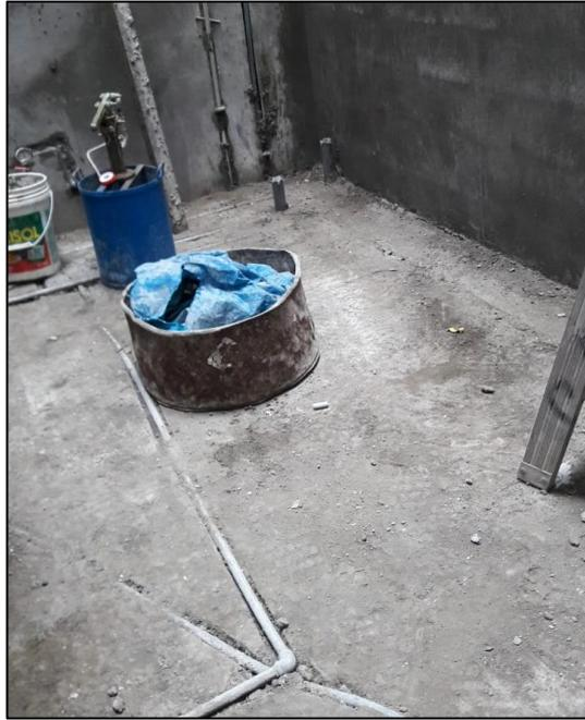
**Figura 108.** Error frecuente en Obra – Tuberías sanitarias expuestas en
