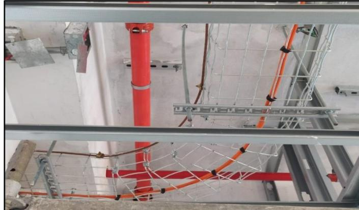
**Figura 10.** Deficiente montaje entre bandejas de comunicaciones y tuberías
