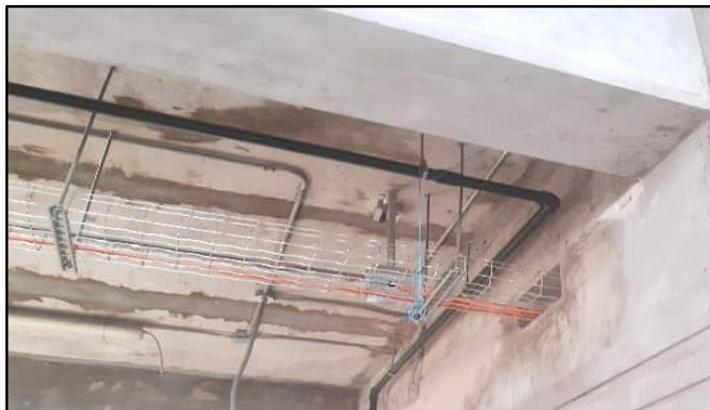
**Figura 9.** Deficiente montaje entre instalaciones de sanitarias y comunicaciones
