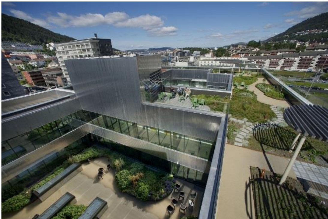
Figura N°35: Vista de techos del Kronstad Psychiatric Hospital.
