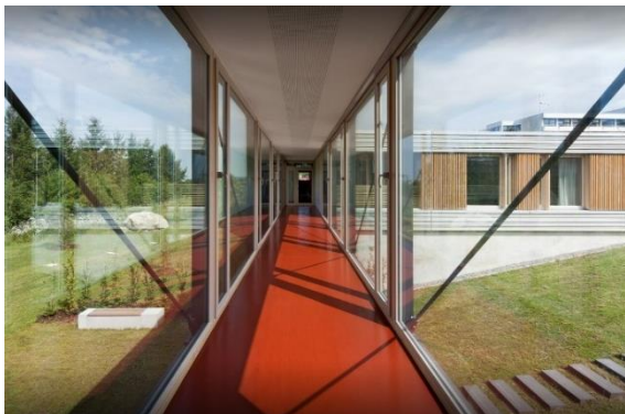
Figura N°45: Puente conector del hospital psiquiátrico Friedrichshafen.
