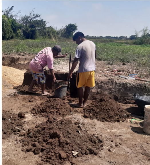
Figura 8: Extracción de tierras para elaboración de adobes
