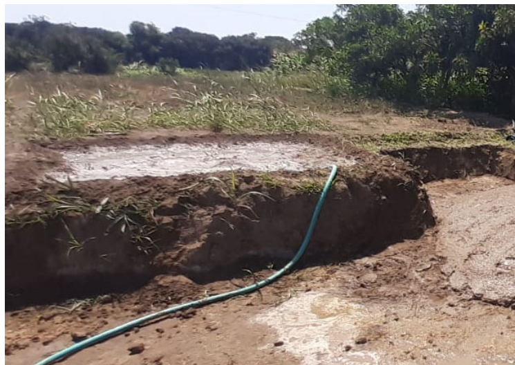
Figura 13: Humectación del suelo con agua de riego
