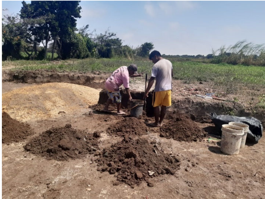
Figura 33: Extracción de tierra de cultivo para adobe
