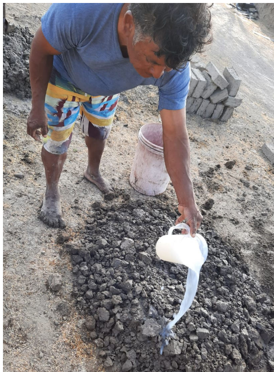
Figura 36: Incorporación de aditivo en la mezcla
