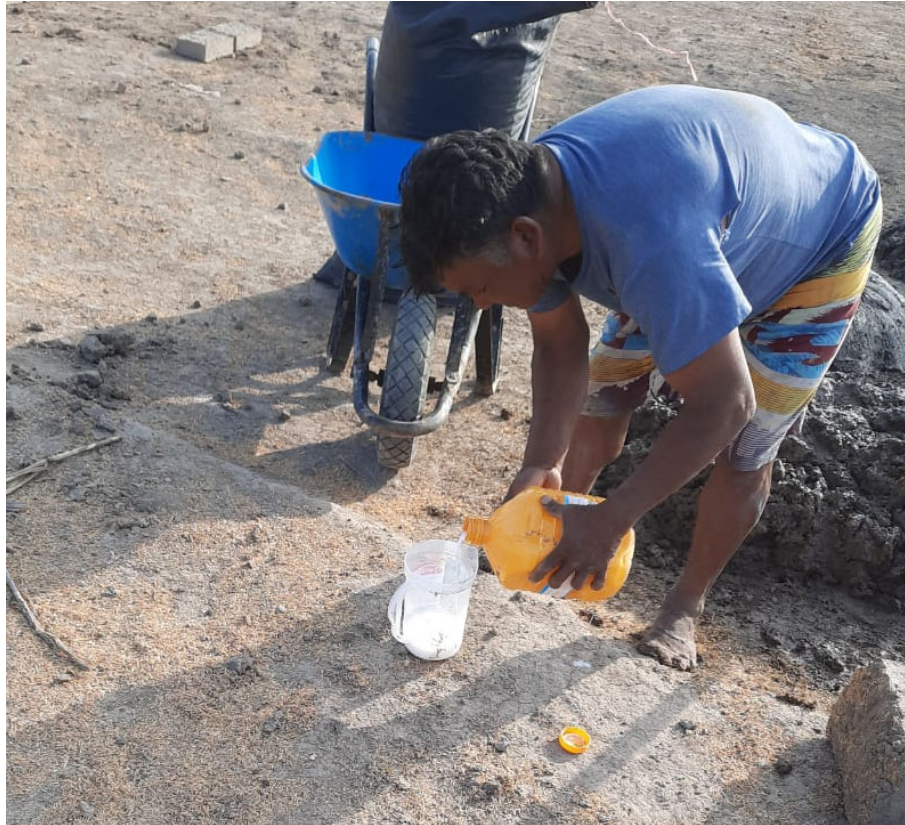
Figura 35: Colocado de cantidad de aditivo en jarra milimétrica
