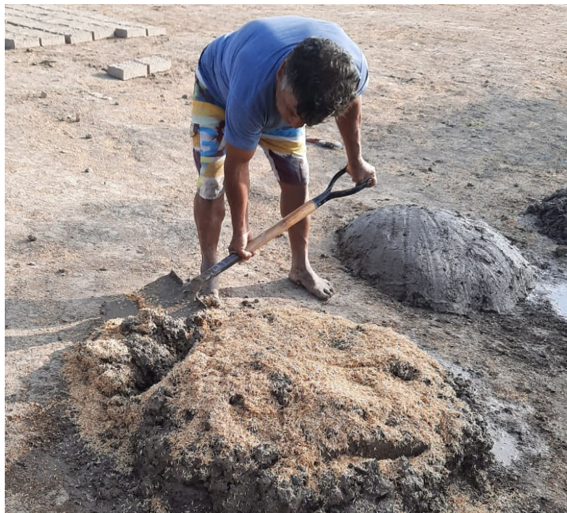
Figura 34: Mezclado de materiales para adobe
